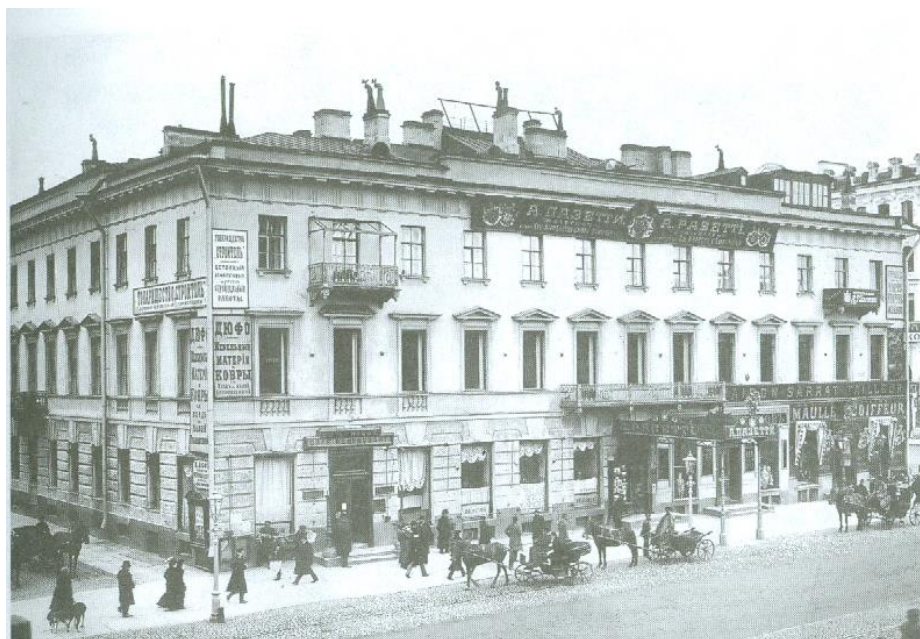
29. Фасад дома № 24 по Невскому проспекту. Фотография. До 1908 г. http://www.pastvu.com .
