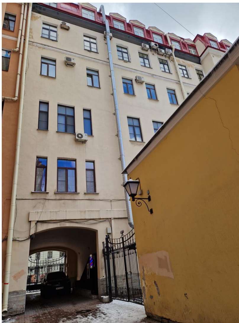
5. Выявленный объект культурного наследия «Дома немецкой лютеранской церкви св. Петра» (Невский пр., 22-24). Дом № 5 по Малой Конюшенной улице. Дворовый фасад. Фрагмент.
