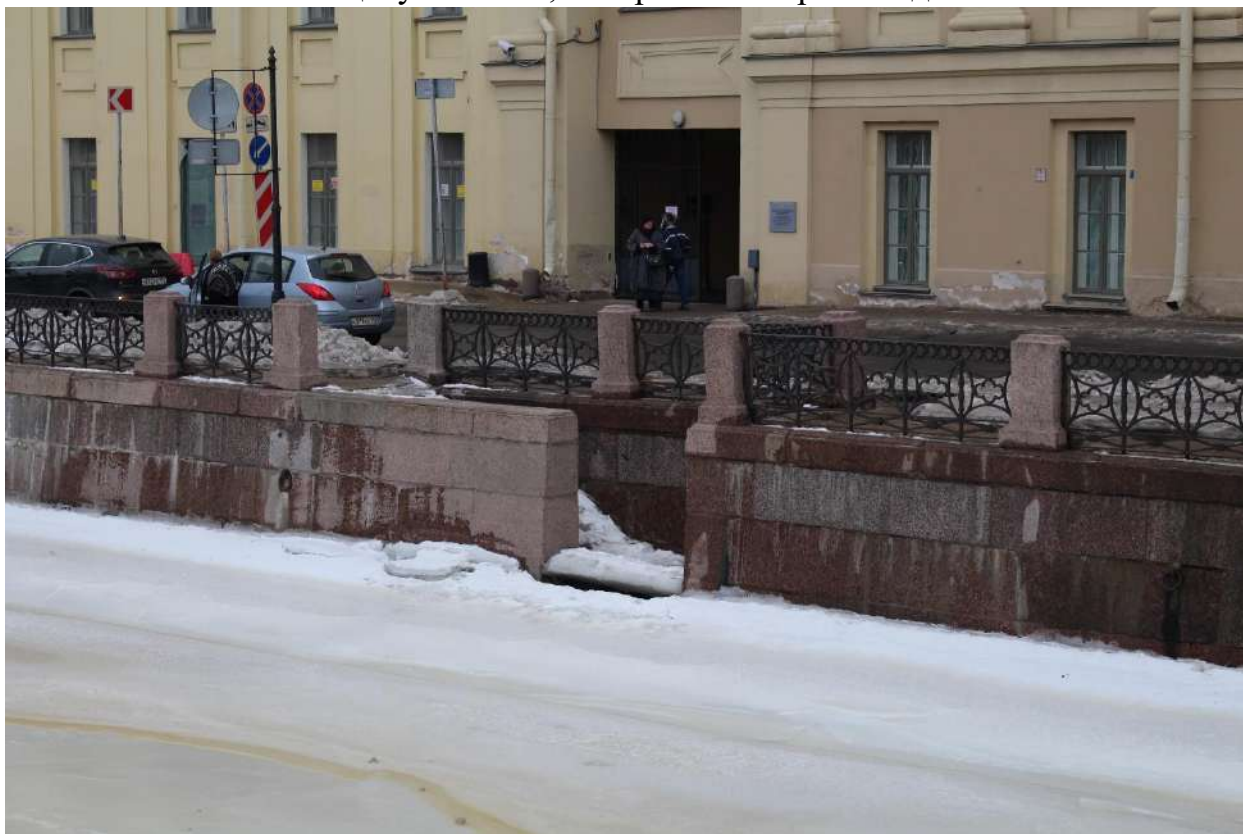
Фото 2. Вид на спуск № 18 объекта культурного наследия федерального значения «Набережные со спусками» на уч. наб. р. Мойки «Почтамтский мост - Поцелуев мост», литера Б с запада.
