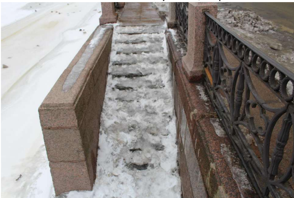
Фото 8. Вид на лестницу спуска № 18 объекта культурного наследия федерального значения «Набережные со спусками» на уч. наб. р. Мойки «Почтамтский мост - Поцелуев мост», литера Б.
