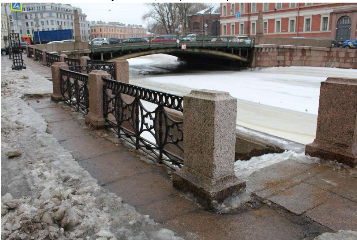
Фото 6. Вид на спуск № 18 объекта культурного наследия федерального значения «Набережные со спусками» на уч. наб. р. Мойки «Почтамтский мост - Поцелуев мост», литера Б с востока.
