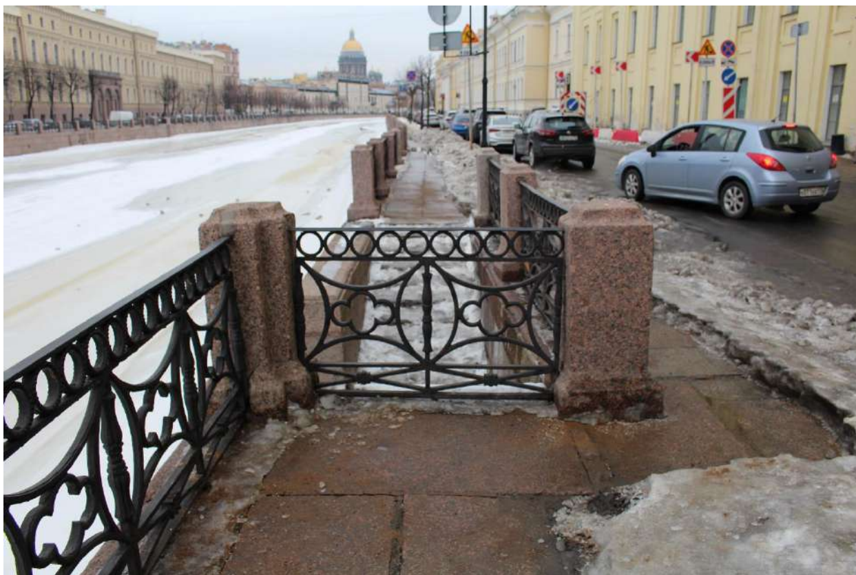
Фото 9. Вид на спуск № 18 объекта культурного наследия федерального значения «Набережные со спусками» на уч. наб. р. Мойки «Почтамтский мост - Поцелуев мост», литера Б с юго-запада.
