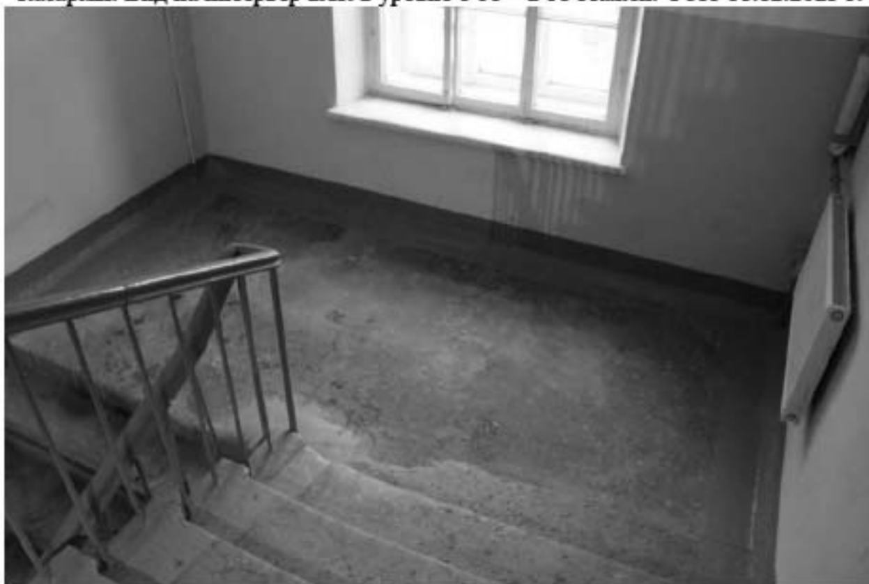
Фото 111. Выявленный объект культурного наследия «Казармы со службой». Казармы. Вид на интерьер 2ЛК в уровне 1-го – 2-го этажей. Фото 11.12.2023 г.
