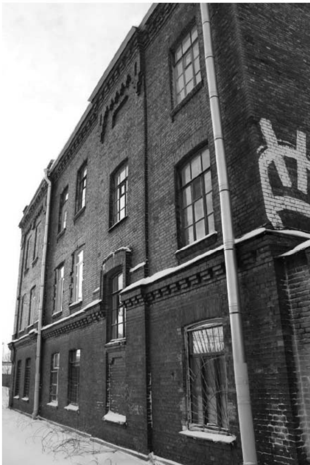
Фото 82. Выявленный объект культурного наследия «Казармы со службой». Вид на восточный лицевой фасад казармы. Фото 11.12.2023 г.
