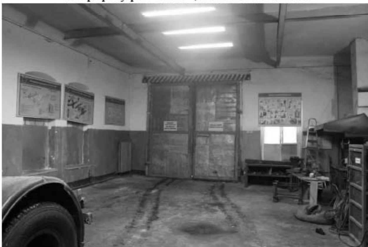
Фото 308. Выявленный объект культурного наследия «Конский» лазарет». Интерьер внутренних помещений. Фото 11.12.2023 г.
