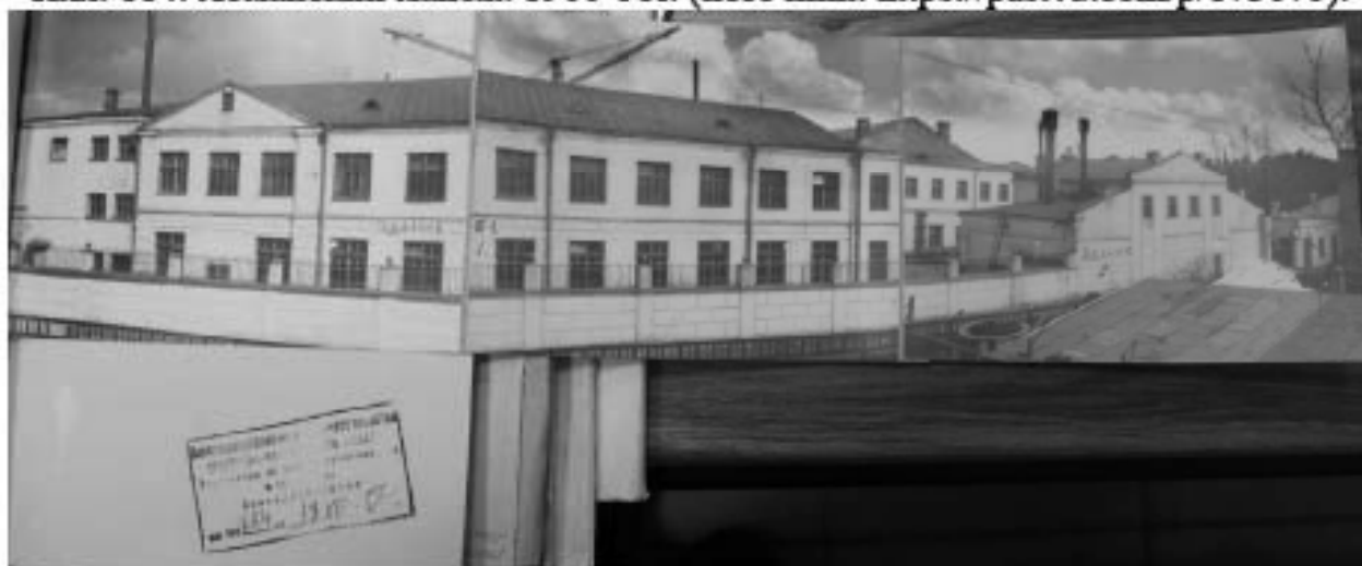
Илл. 115. Здание № 1 (северо-западная часть выявленного объекта культурного наследия «Манеж с конюшнями») до реконструкции 1958 года. 1957 г. (источник: предоставлено заказчиком).
