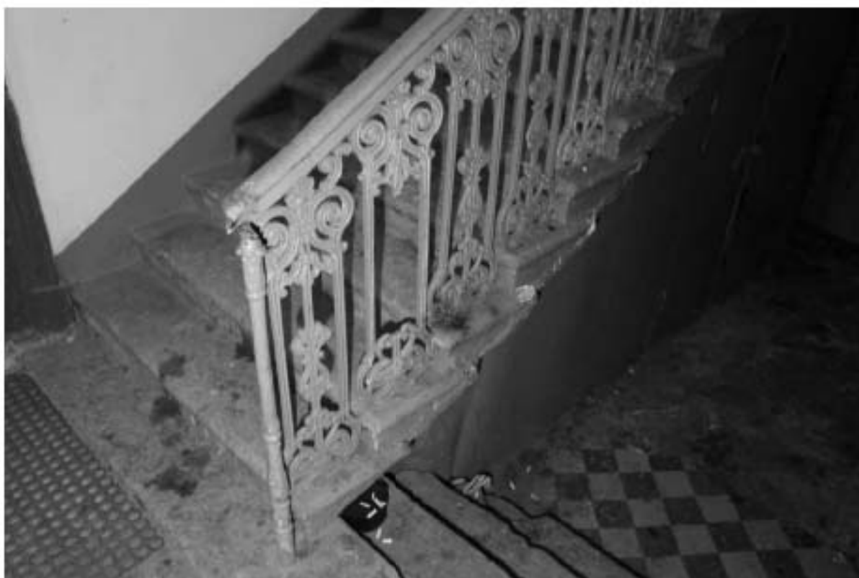
Фото 28. Выявленный объект культурного наследия «Жилой офицерский дом со службой и оградой». Жилой офицерский дом. Вид на интерьер 1ЛК в уровне 1-го этажа. Фото 11.12.2023 г.
