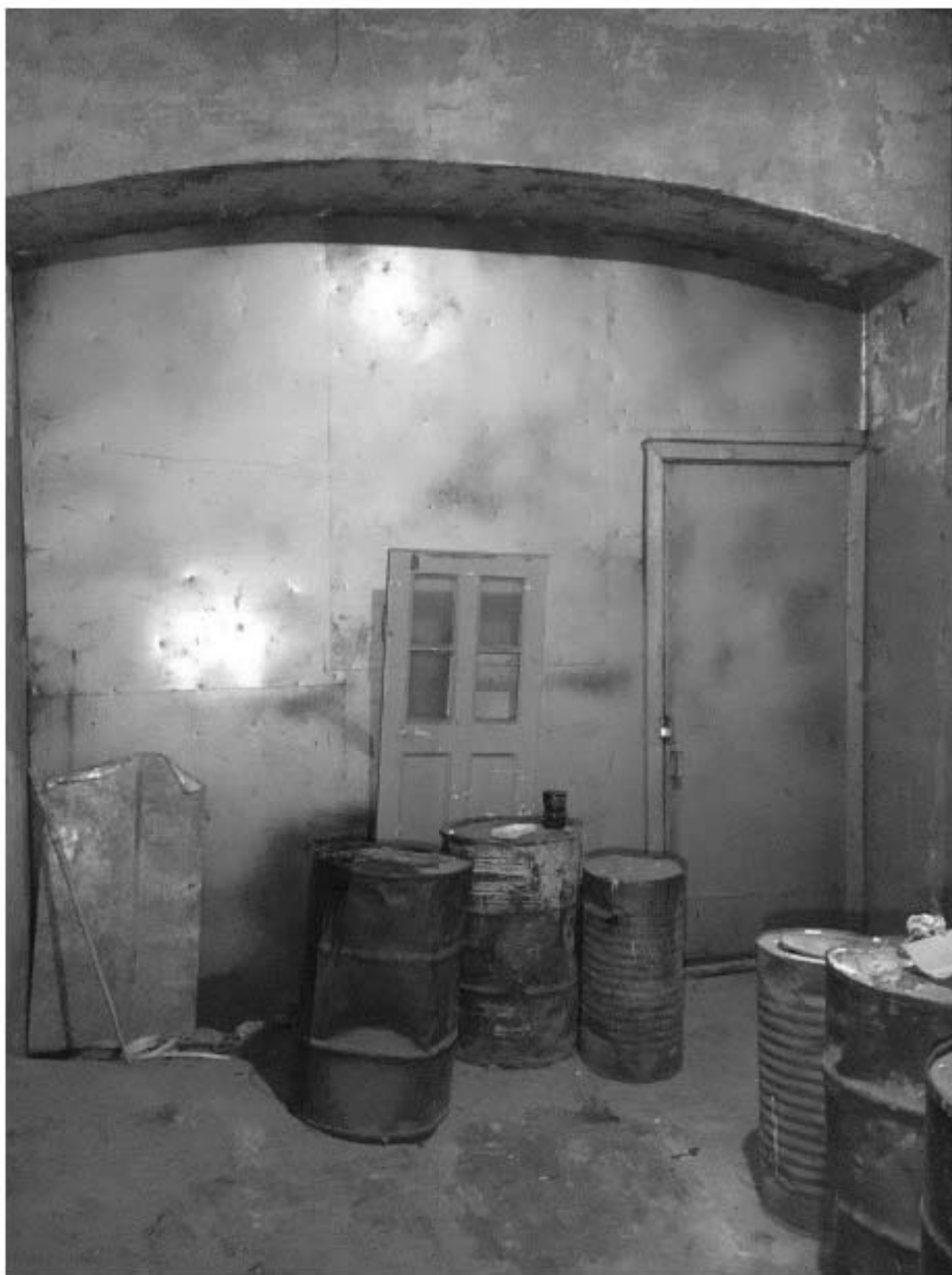
Фото 315. Выявленный объект культурного наследия «Фуражные саран». Интерьер внутренних помещений 1-го этажа. Фото 11.12.2023 г.
