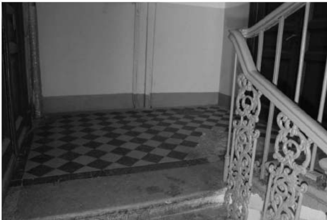
Фото 58. Выявленный объект культурного наследия «Жилой офицерский дом со службой и оградой». Жилой офицерский дом. Вид на интерьер 4ЛК в уровне 2-го этажа. Фото 11.12.2023 г.
