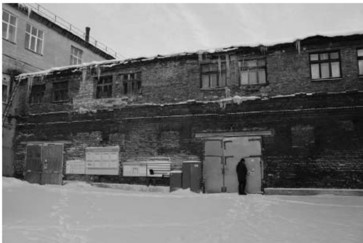
Фото 200. Выявленный объект культурного наследия «Манеж с конюшнями». Вид на южный фасад восточного Т-образного объема конюшен. Фото 11.12.2023 г.
