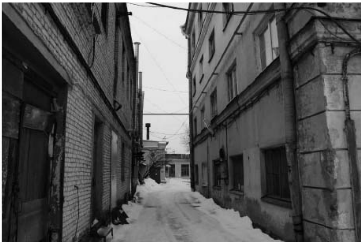
Фото 227. Выявленный объект культурного наследия «Манеж с конюшнями». Вид на северный фасад западного Т-образного объема конюшен. Фото 11.12.2023 г.
