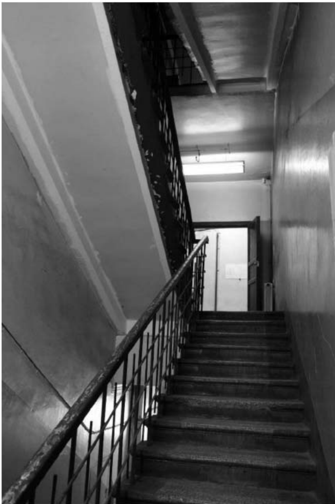
Фото 258. Выявленный объект культурного наследия «Манеж с конюшнями». Центральный и западный Т-образный объемы конюшен. Интерьер западной лестничной клетки в уровне 2-го – 3-го этажей. Фото 11.12.2023 г.
