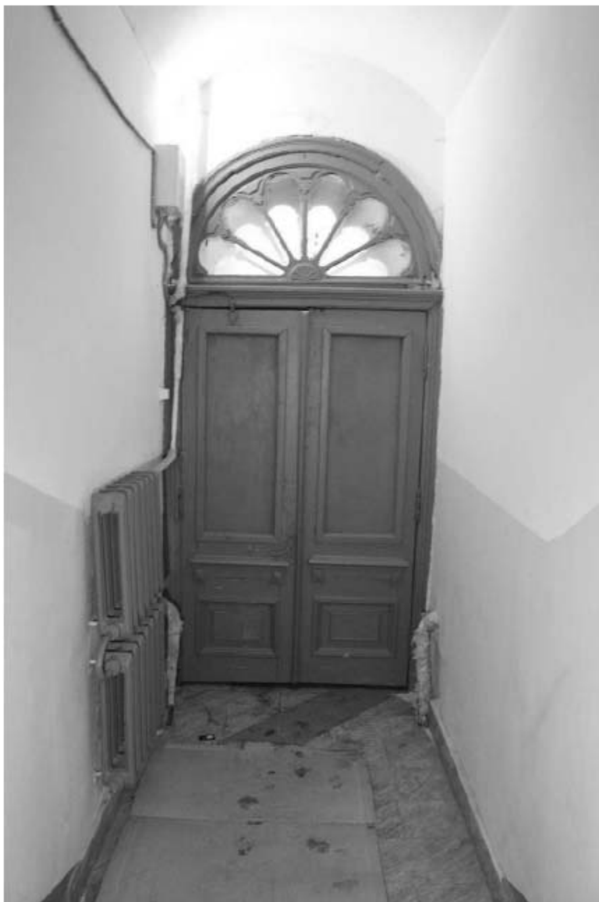
Фото 63. Выявленный объект культурного наследия «Жилой офицерский дом со службой и оградой». Жилой офицерский дом. Вид на интерьер 5ЛК в уровне 1-го этажа. Фото 11.12.2023 г.
