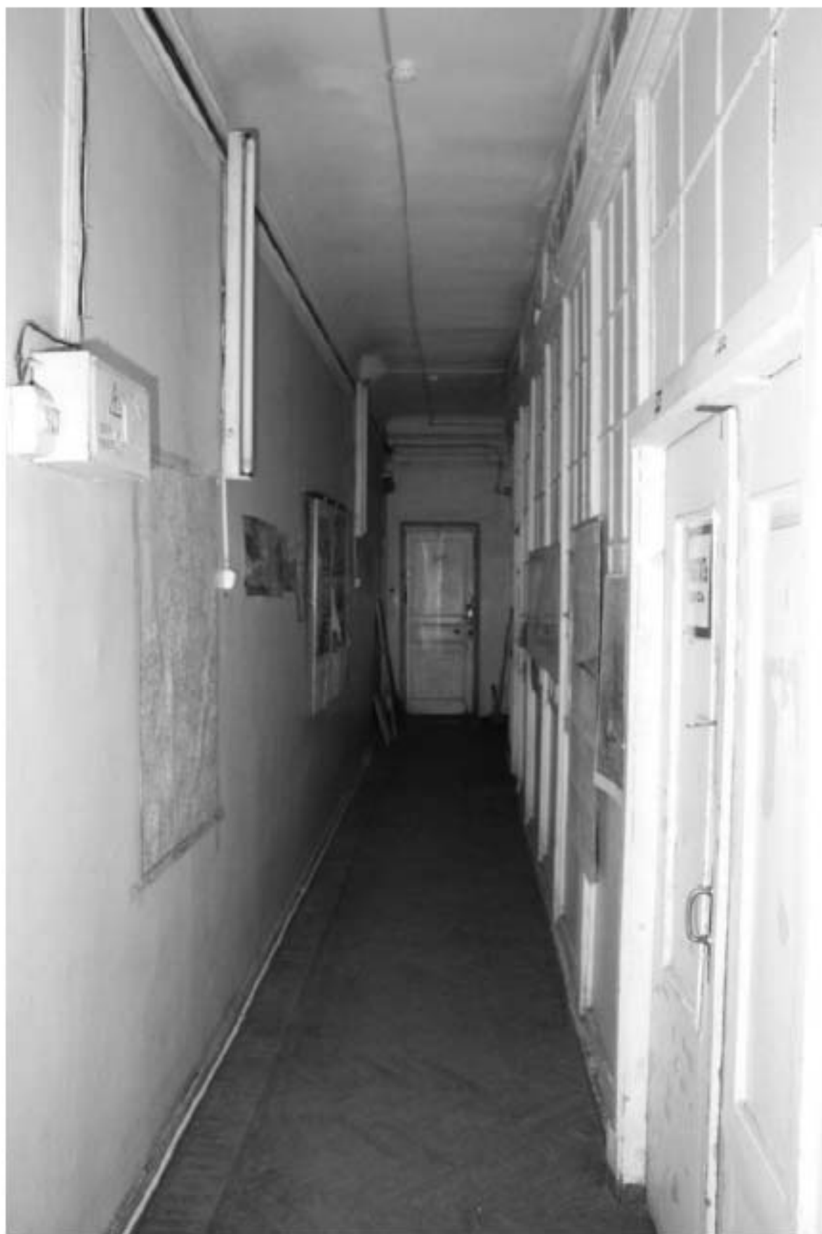
Фото 192. Выявленный объект культурного наследия «Манеж с конюшнями». Здание в границах манежа. Интерьер внутренних помещений в уровне 2-го этажа. Фото 11.12.2023 г.
