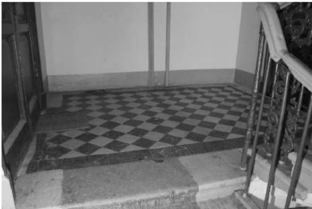
Фото 47. Выявленный объект культурного наследия «Жилой офицерский дом со службой и оградой». Жилой офицерский дом. Вид на интерьер 2ЛК в уровне 2-го этажа. Фото 11.12.2023 г.
