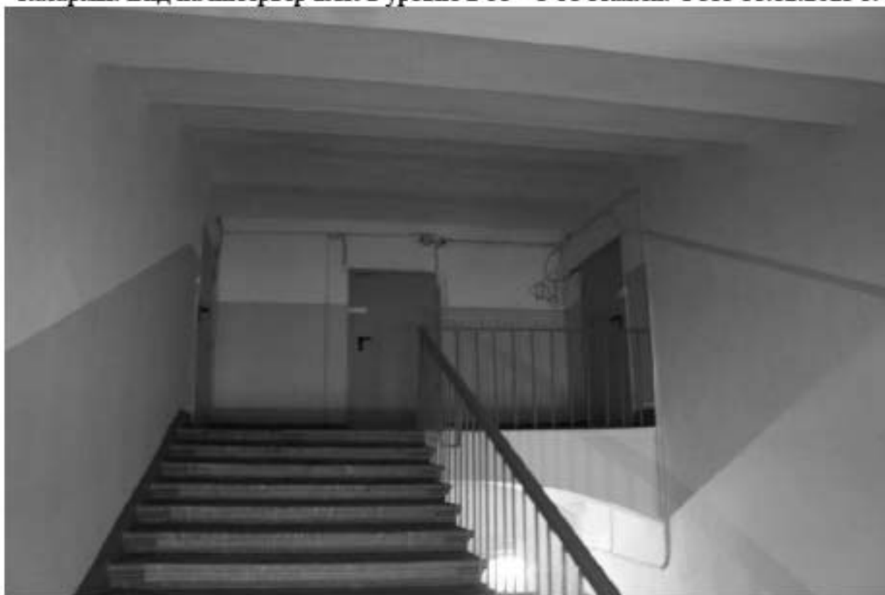
Фото 117. Выявленный объект культурного наследия «Казармы со службой». Казармы. Вид на интерьер 2ЛК в уровне чердачного этажа. Фото 11.12.2023 г.
