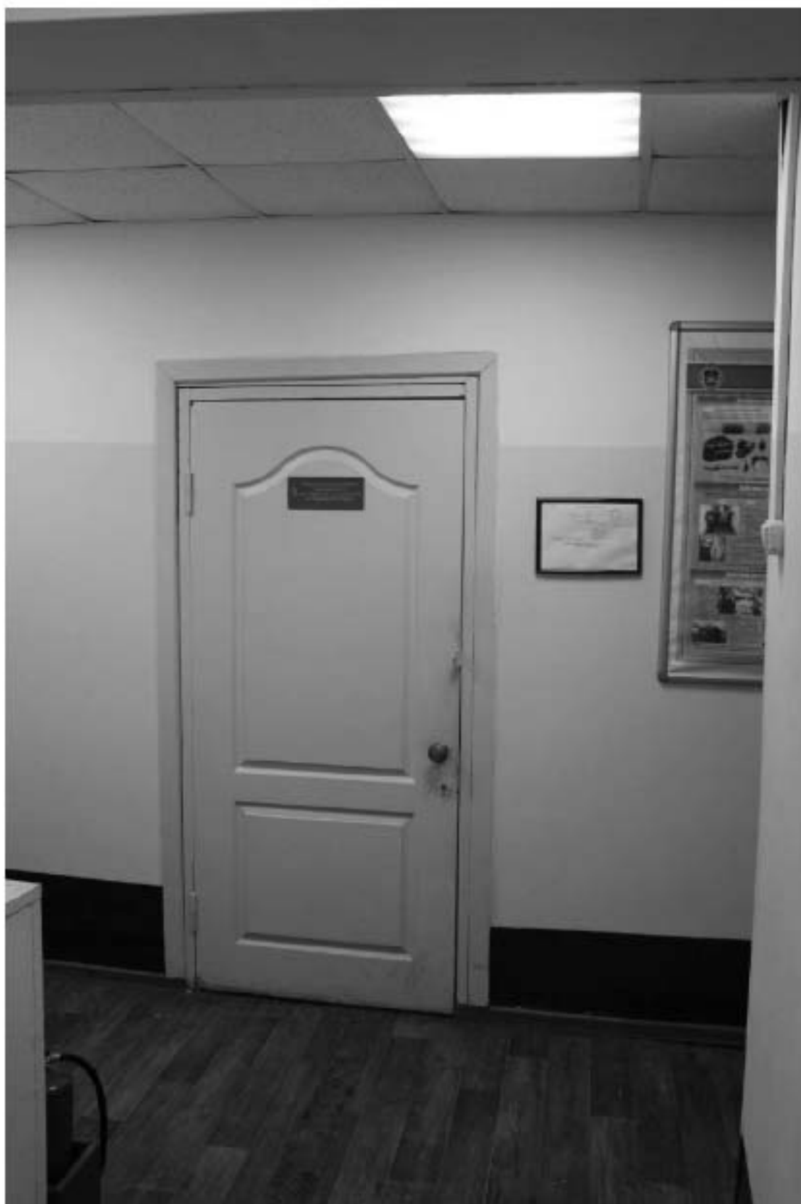
Фото 155. Выявленный объект культурного наследия «Караульня с оградой». Интерьер внутренних помещений караульни. Фото 11.12.2023 г.
