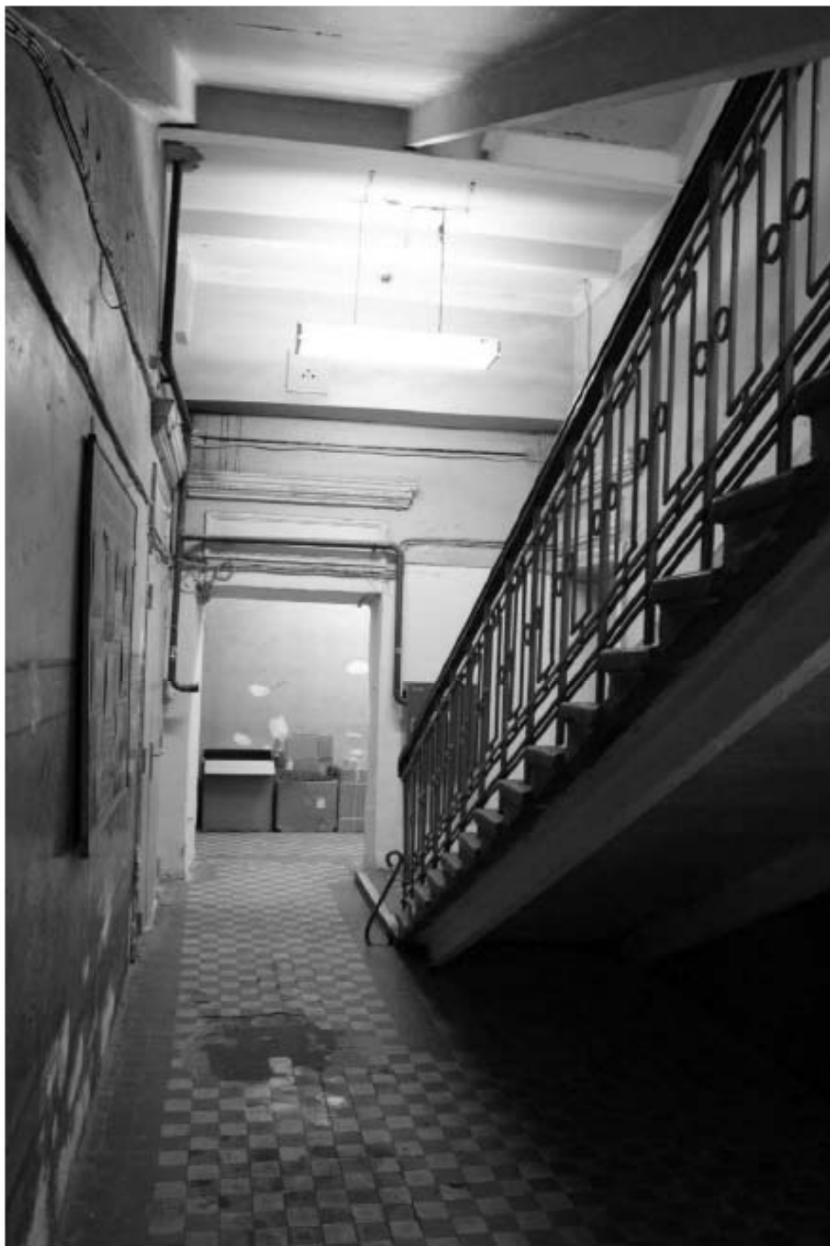
Фото 236. Выявленный объект культурного наследия «Манеж с конюшнями». Центральный и западный Т-образный объемы конюшен. Интерьер восточной лестничной клетки в уровне 1-го этажа. Фото 11.12.2023 г.
