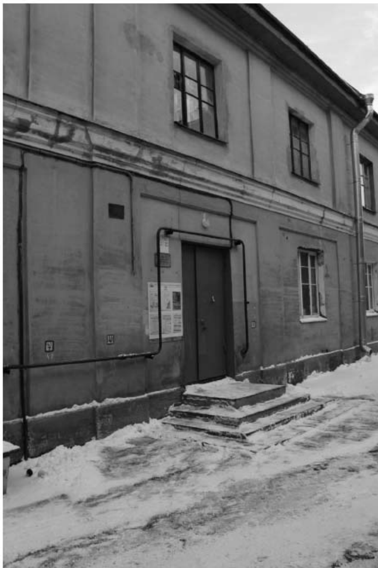
Фото 130. Выявленный объект культурного наследия «Казармы со службой». Вид на южный фасад службы. Вход в лестничную клетку. Фото 11.12.2023 г.
