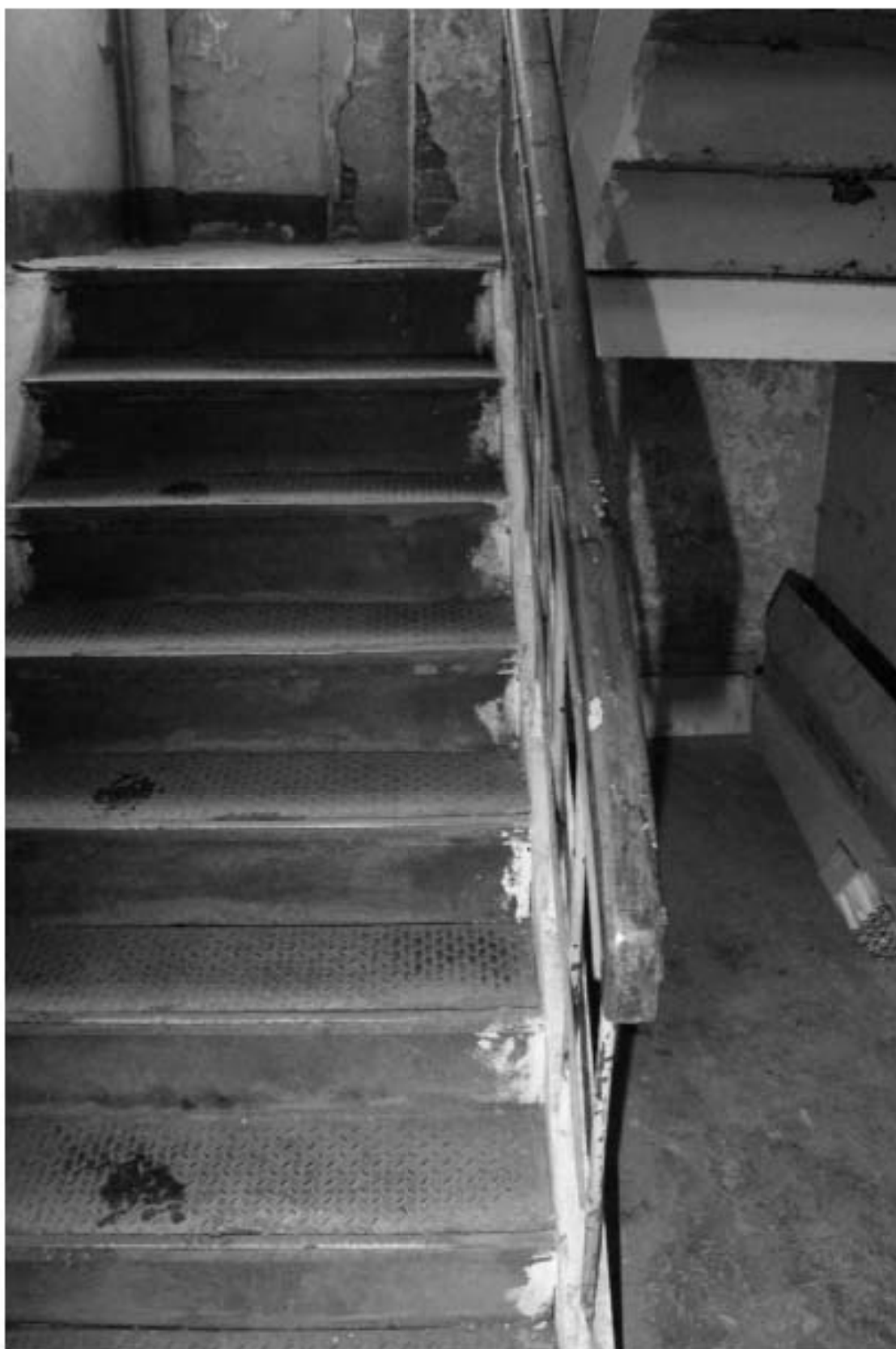
Фото 185. Выявленный объект культурного наследия «Манеж с конюшнями». Здание в границах манежа. Интерьер внутренних помещений в уровне 1-го этажа. Фото 11.12.2023 г.
