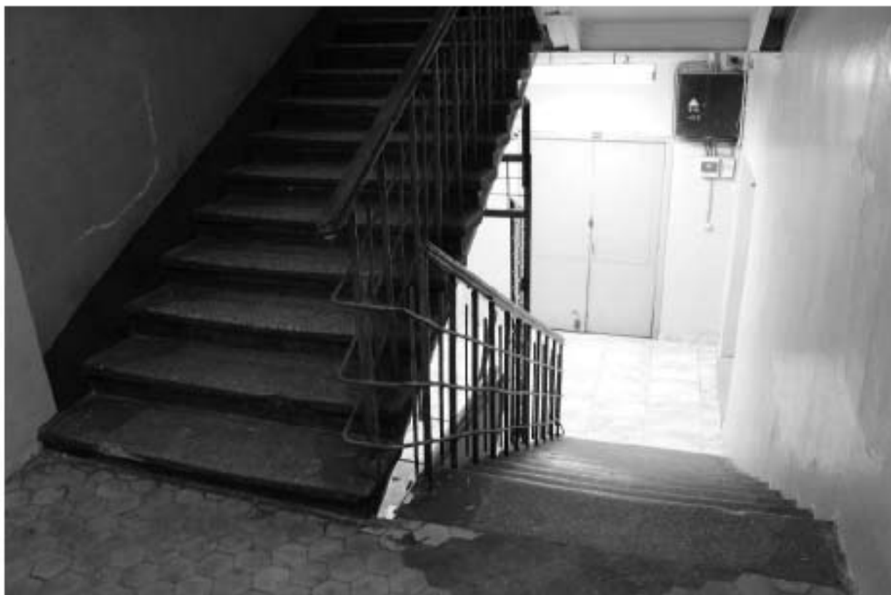
Фото 243. Выявленный объект культурного наследия «Манеж с конюшнями». Центральный и западный Т-образный объемы конюшен. Интерьер северной лестничной клетки в уровне 1-го – 2-го этажей. Фото 11.12.2023 г.
