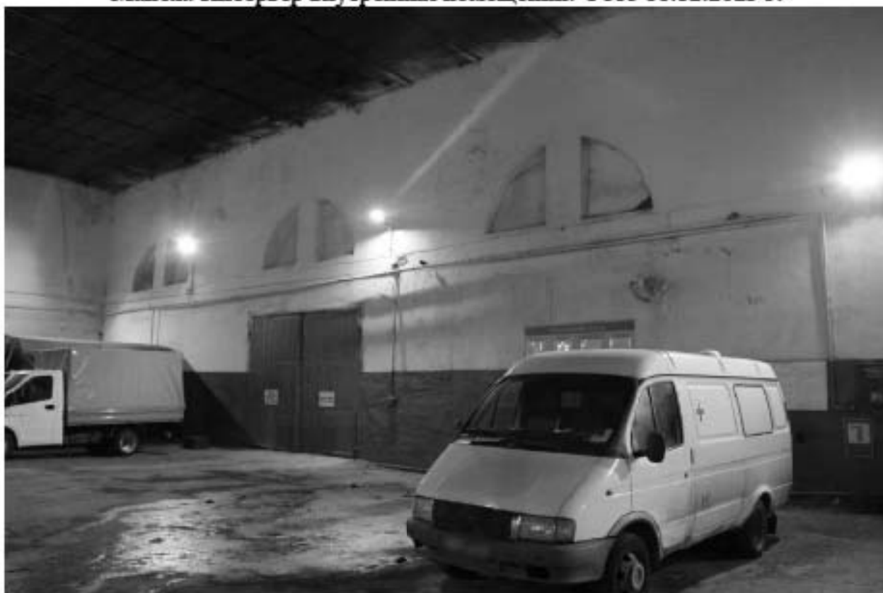
Фото 183. Выявленный объект культурного наследия «Манеж с конюшнями». Манеж. Интерьер внутренних помещений. Фото 11.12.2023 г.
