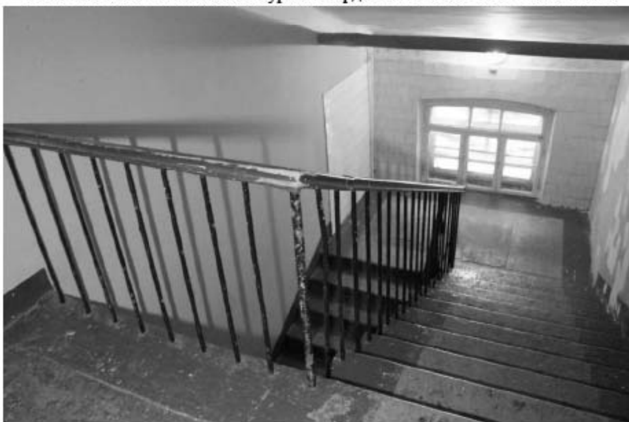
Фото 363. Выявленный объект культурного наследия «Саран для артиллерии». Восточная лестничная клетка в уровне чердачного этажа. Фото 25.01.2024 г.
