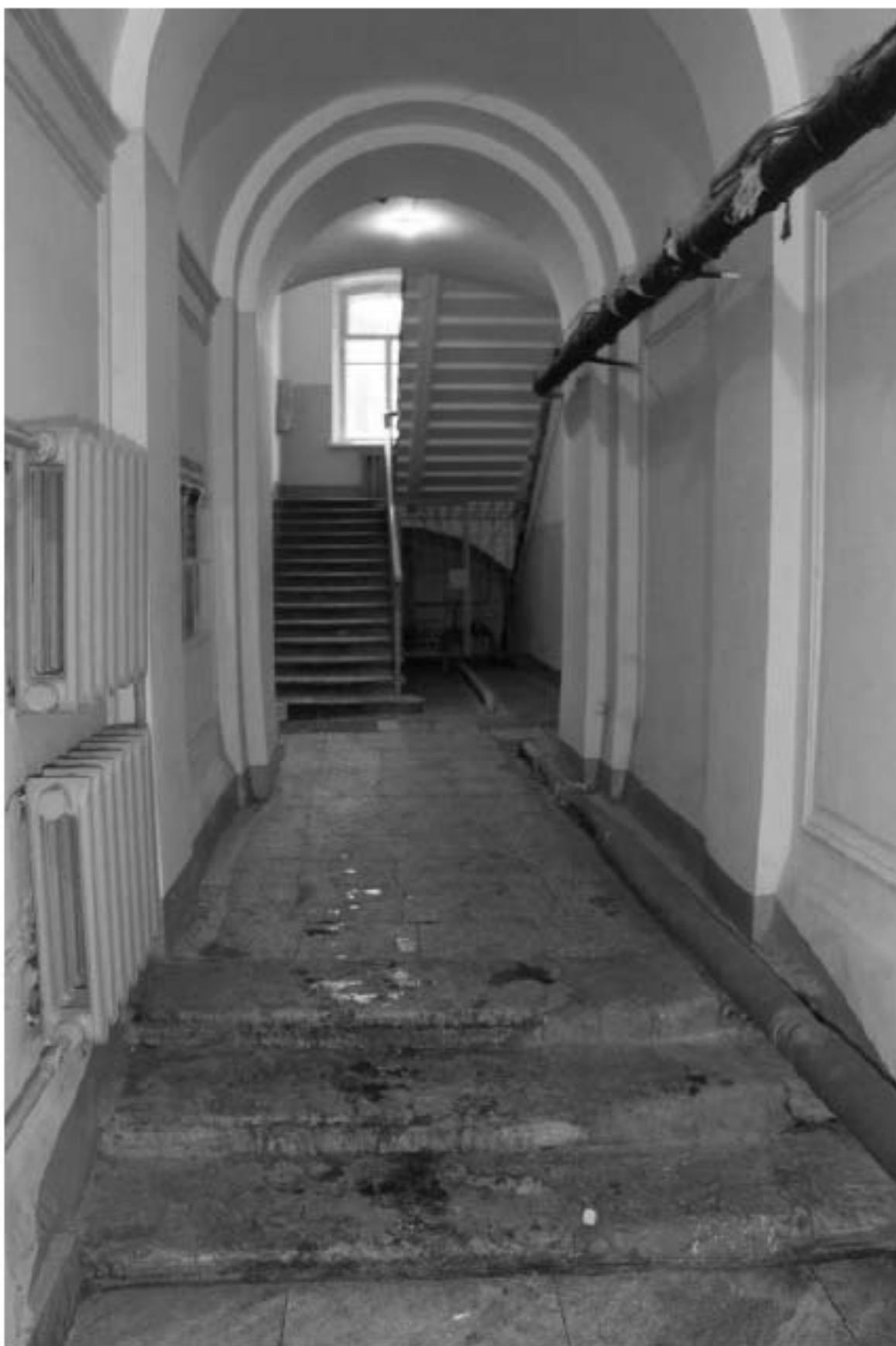
Фото 54. Выявленный объект культурного наследия «Жилой офицерский дом со службой и оградой». Жилой офицерский дом. Вид на интерьер 4ЛК в уровне 1-го этажа. Фото 11.12.2023 г.
