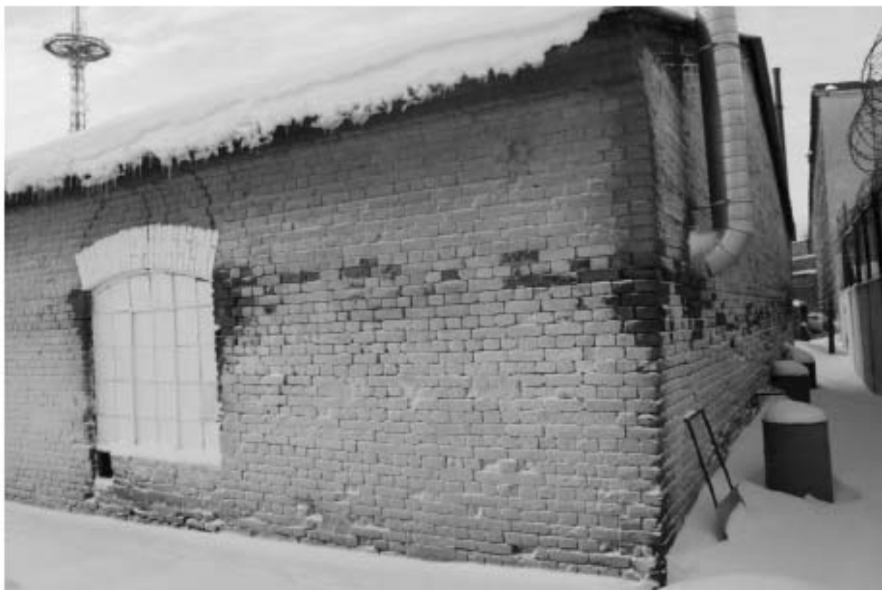
Фото 328. Выявленный объект культурного наследия «Кузница». Вид на северный фасад. Фото 11.12.2023 г.
