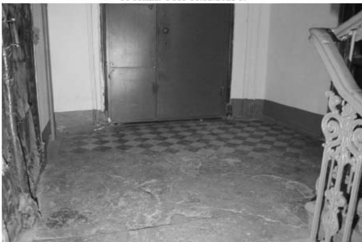
Фото 35. Выявленный объект культурного наследия «Жилой офицерский дом со службой и оградой». Жилой офицерский дом. Вид на интерьер 1ЛК в уровне 3-го этажа. Фото 11.12.2023 г.
