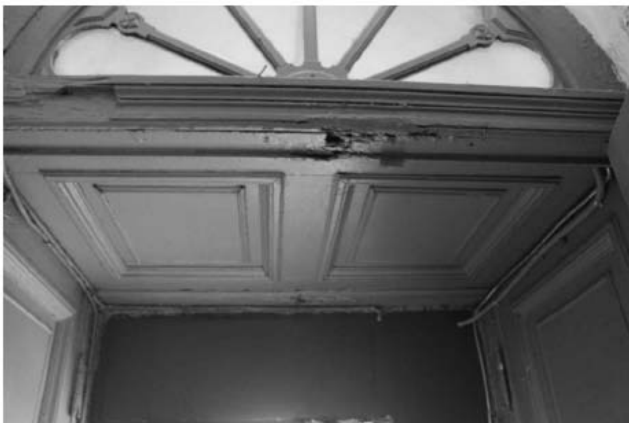
Фото 18. Выявленный объект культурного наследия «Жилой офицерский дом со службой и оградой». Жилой офицерский дом. Вид на интерьер 1ЛК в уровне 1-го этажа. Фото 11.12.2023 г.
