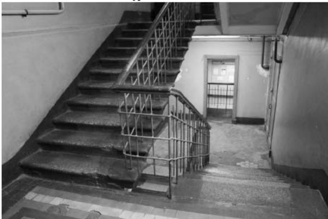
Фото 250. Выявленный объект культурного наследия «Манеж с конюшнями». Центральный и западный Т-образный объемы конюшен. Интерьер северной лестничной клетки в уровне 3-го – 4-го этажей. Фото 11.12.2023 г.
