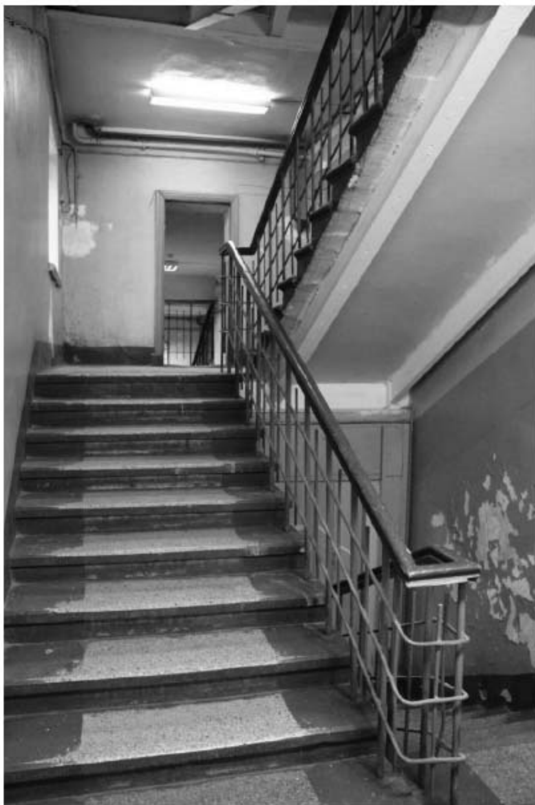
Фото 248. Выявленный объект культурного наследия «Манеж с конюшнями». Центральный и западный Т-образный объемы конюшен. Интерьер северной лестничной клетки в уровне 2-го – 3-го этажей. Фото 11.12.2023 г.
