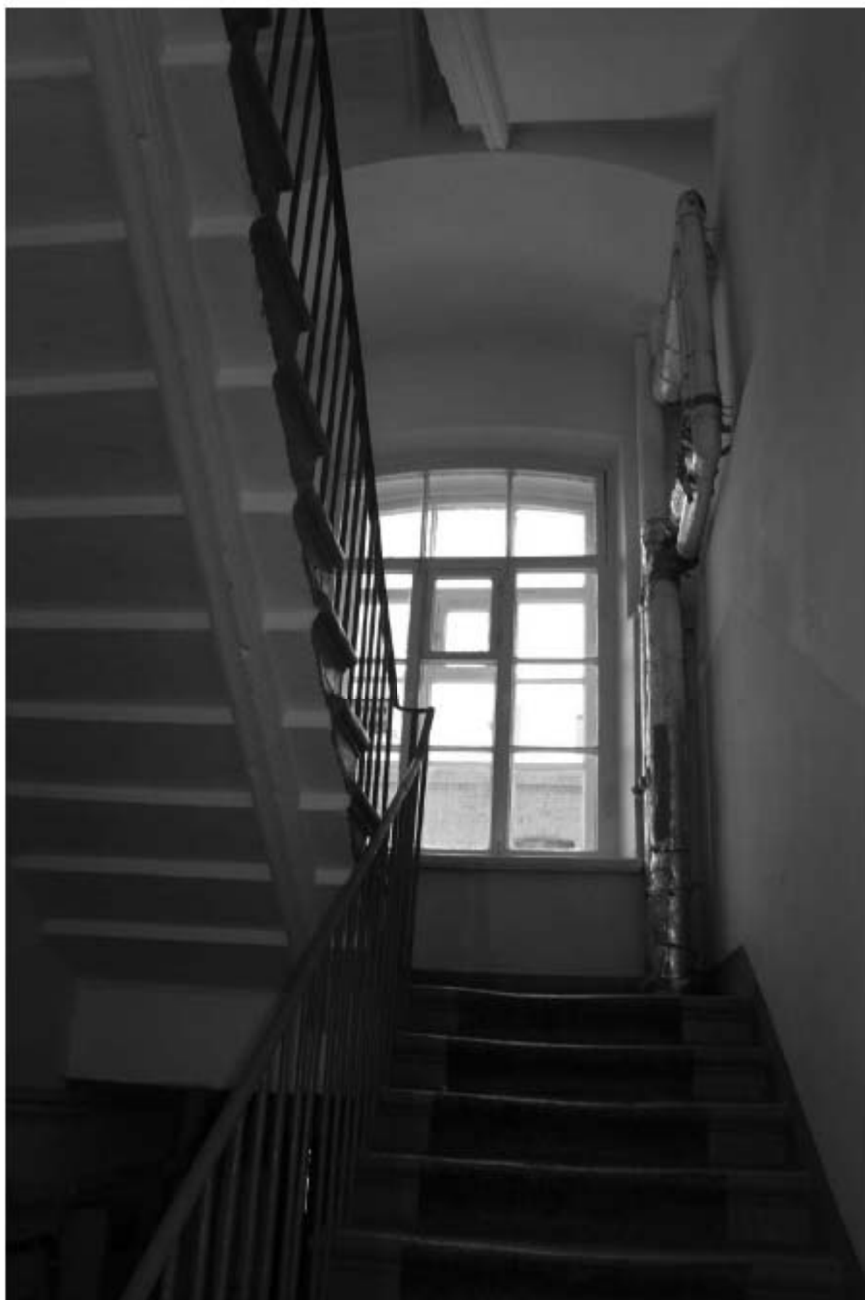
Фото 99. Выявленный объект культурного наследия «Казармы со службой». Казармы. Вид на интерьер 1ЛК в уровне 1-го – 2-го этажей. Фото 11.12.2023 г.
