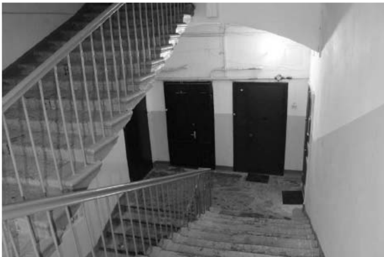
Фото 110. Выявленный объект культурного наследия «Казармы со службой». Казармы. Вид на интерьер 2ЛК в уровне 1-го – 2-го этажей. Фото 11.12.2023 г.
