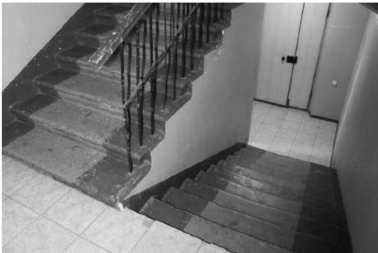
Фото 359. Выявленный объект культурного наследия «Саран для артиллерии». Восточная лестничная клетка в уровне 1-го – 2-го этажей. Фото 25.01.2024 г.
