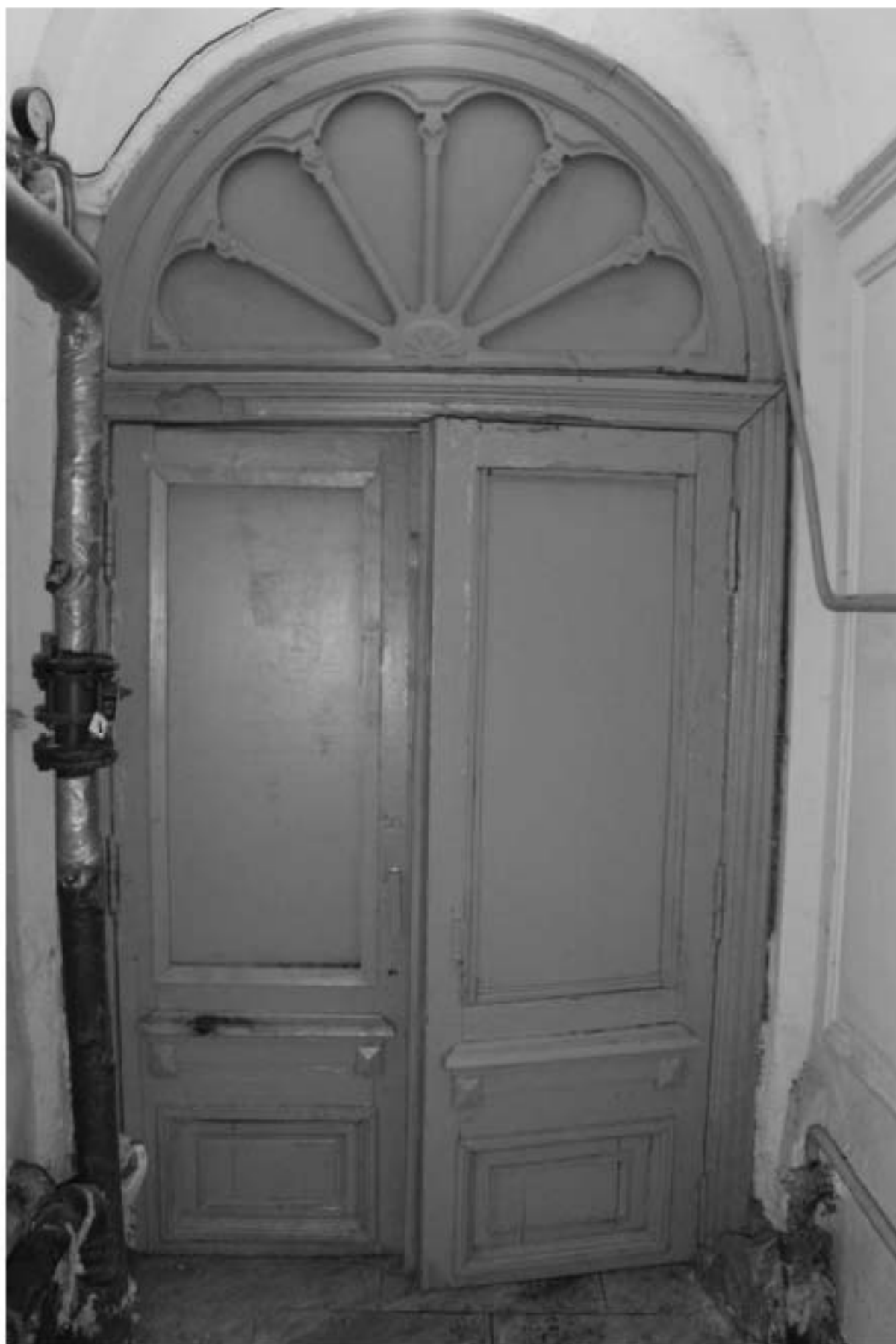
Фото 53. Выявленный объект культурного наследия «Жилой офицерский дом со службой и оградой». Жилой офицерский дом. Вид на интерьер 4ЛК в уровне 1-го этажа. Фото 11.12.2023 г.
