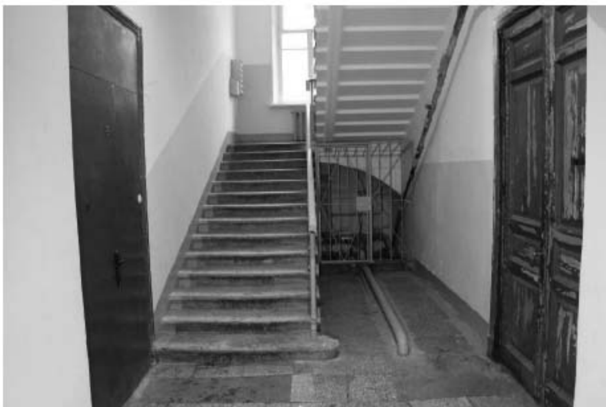
Фото 55. Выявленный объект культурного наследия «Жилой офицерский дом со службой и оградой». Жилой офицерский дом. Вид на интерьер 4ЛК в уровне 1-го этажа. Фото 11.12.2023 г.
