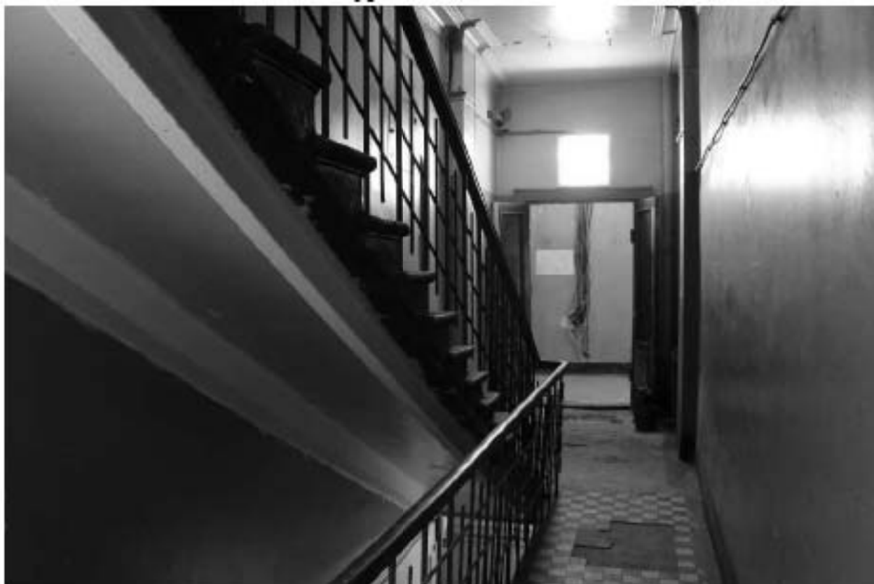
Фото 256. Выявленный объект культурного наследия «Манеж с конюшнями». Центральный и западный Т-образный объемы конюшен. Интерьер западной лестничной клетки в уровне 2-го этажа. Фото 11.12.2023 г.
