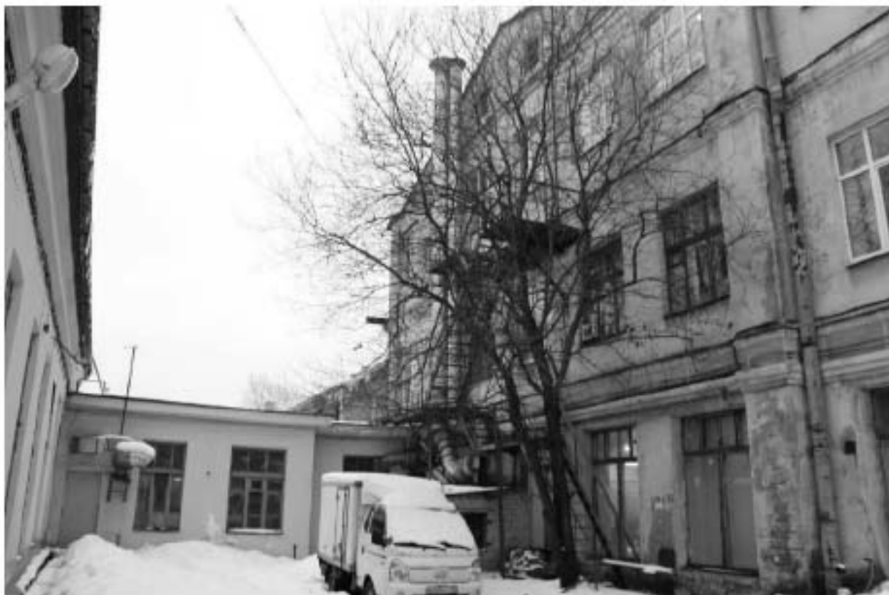
Фото 230. Выявленный объект культурного наследия «Манеж с конюшнями». Вид на северный фасад западного Т-образного объема конюшен. Фото 11.12.2023 г.
