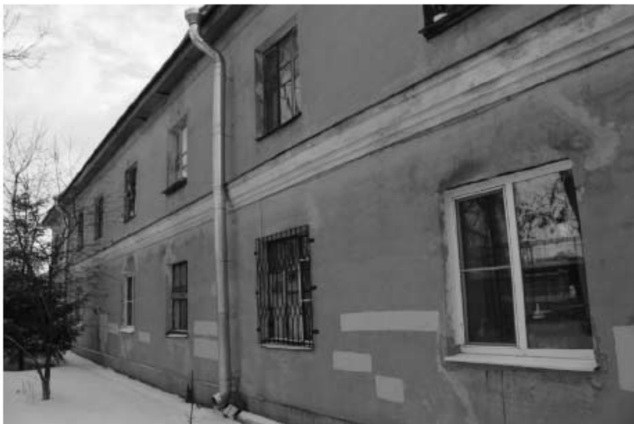
Фото 137. Выявленный объект культурного наследия «Казармы со службой». Вид на северный фасад службы. Фото 11.12.2023 г.
