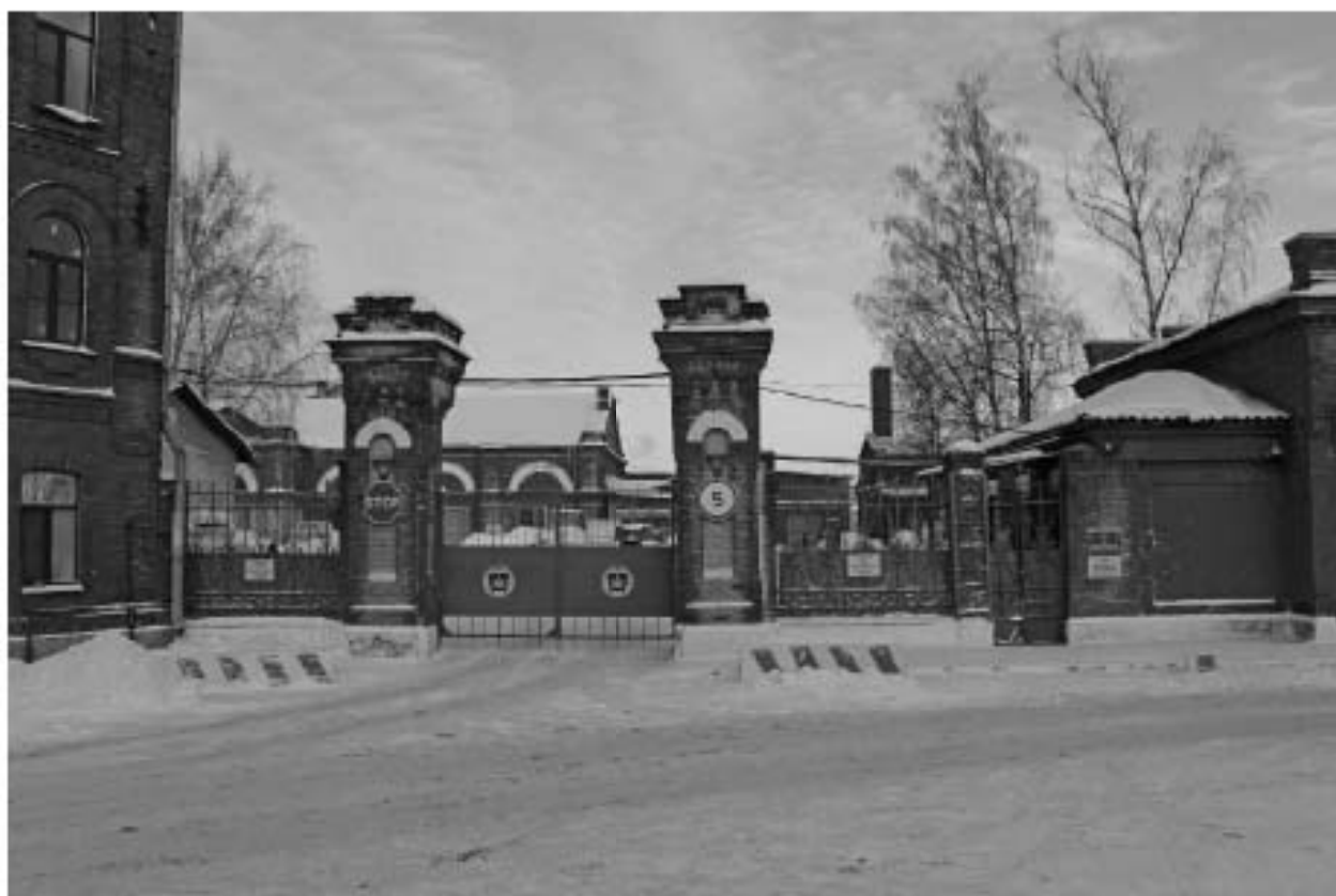
Фото 160. Выявленный объект культурного наследия «Караульня с оградой». Вид на западные ворота ограды с юга. Фото 11.12.2023 г.
