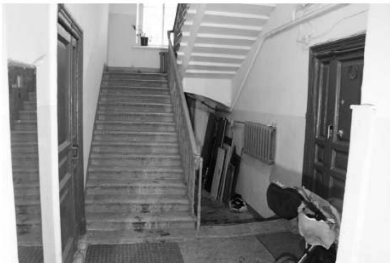
Фото 23. Выявленный объект культурного наследия «Жилой офицерский дом со службой и оградой». Жилой офицерский дом. Вид на интерьер 1ЛК в уровне 1-го этажа. Фото 11.12.2023 г.
