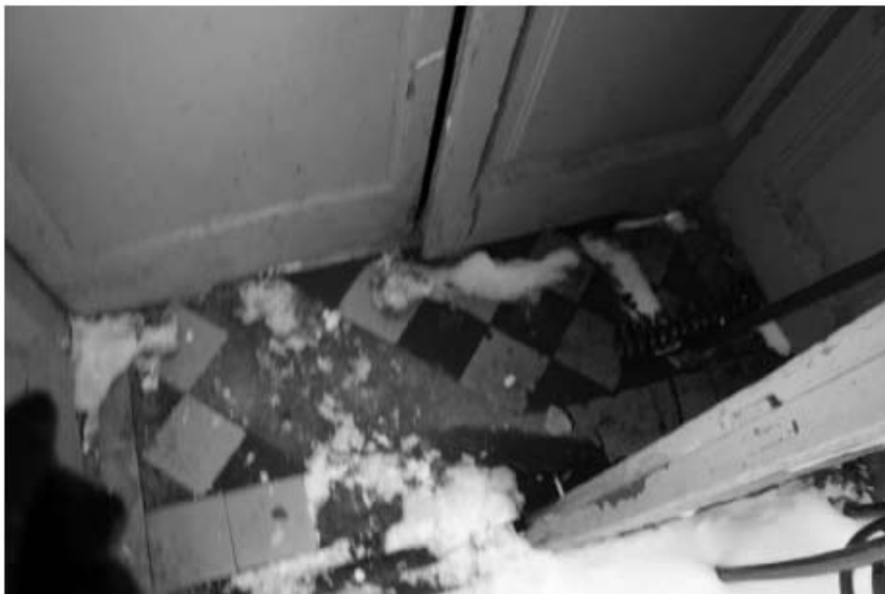
Фото 25. Выявленный объект культурного наследия «Жилой офицерский дом со службой и оградой». Жилой офицерский дом. Вид на интерьер 1ЛК в уровне 1-го этажа. Фото 11.12.2023 г.
