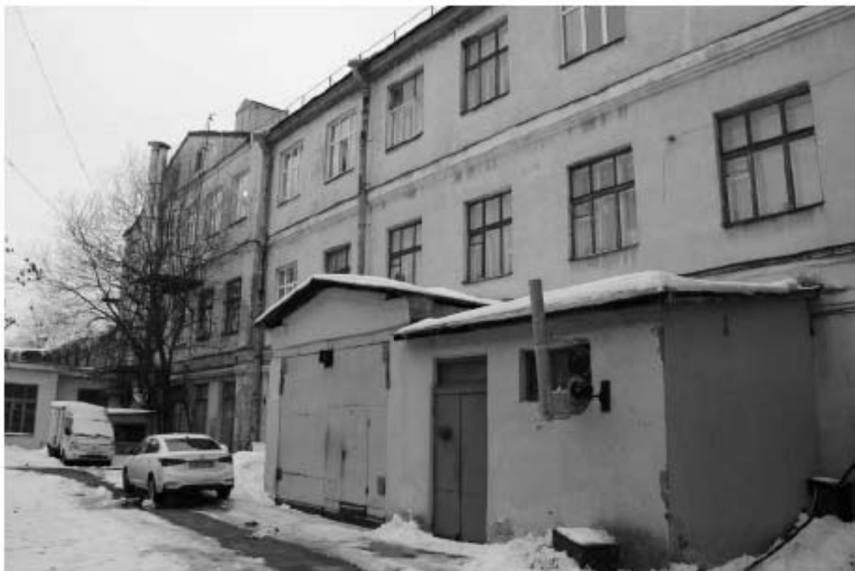
Фото 228. Выявленный объект культурного наследия «Манеж с конюшнями». Вид на северный фасад западного Т-образного объема конюшен. Фото 11.12.2023 г.
