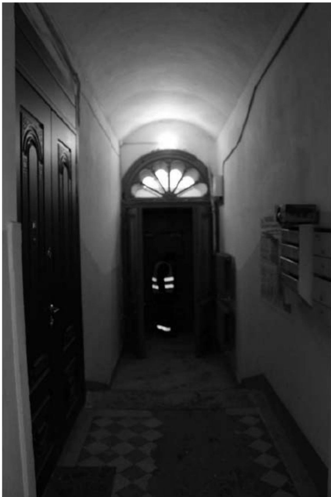
Фото 22. Выявленный объект культурного наследия «Жилой офицерский дом со службой и оградой». Жилой офицерский дом. Вид на интерьер 1ЛК в уровне 1-го этажа. Фото 11.12.2023 г.
