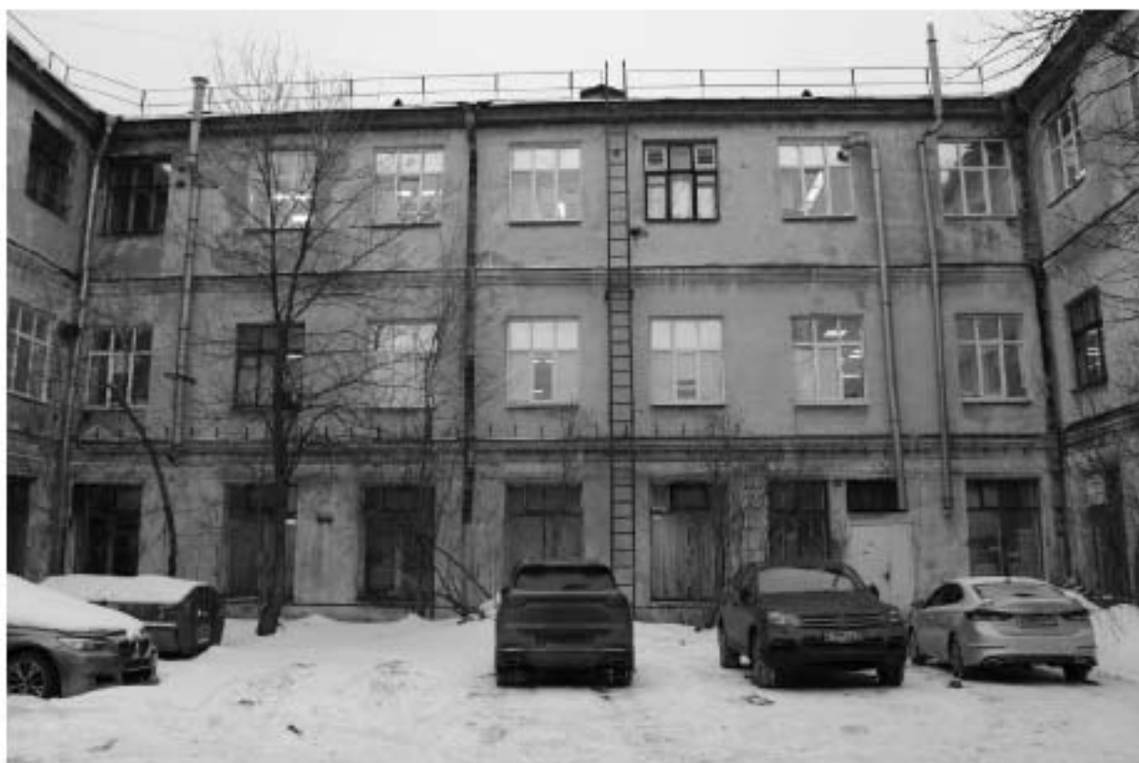
Фото 233. Выявленный объект культурного наследия «Манеж с конюшнями». Вид на южный фасад западного Т-образного объема конюшен. Фото 11.12.2023 г.
