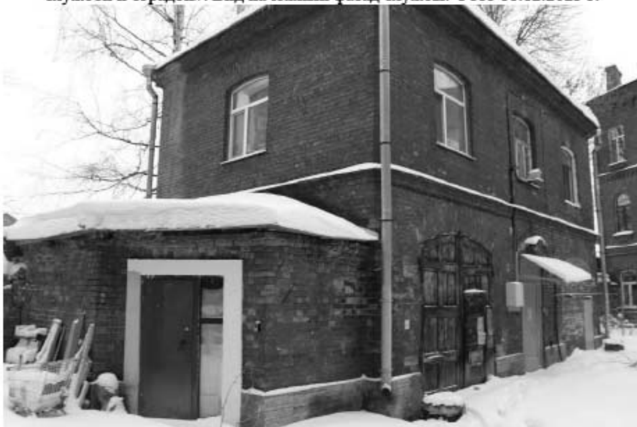
Фото 72. Выявленный объект культурного наследия «Жилой офицерский дом со службой и оградой». Вид на западный и южный фасады службы. Фото 11.12.2023 г.
