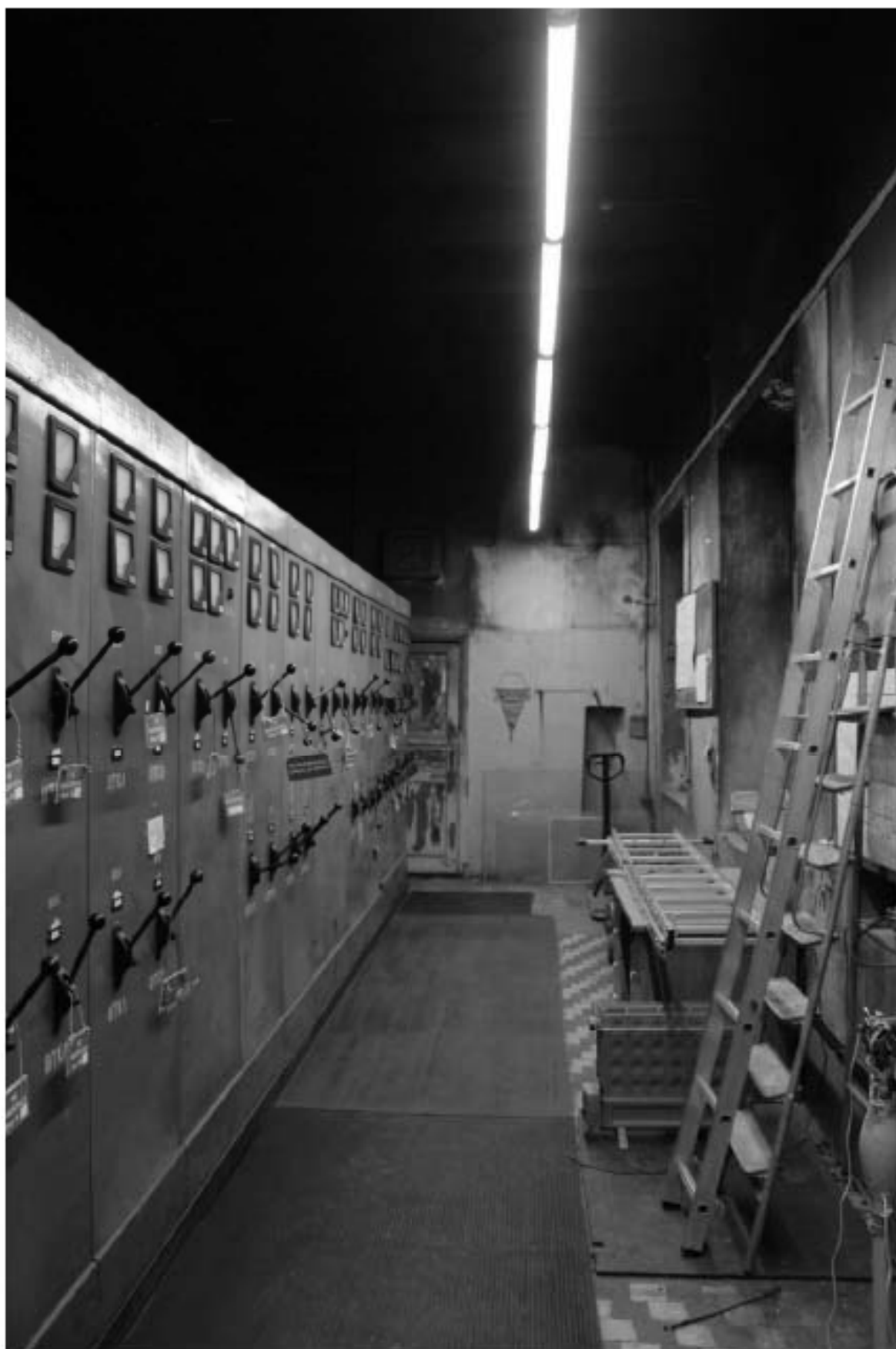
Фото 187. Выявленный объект культурного наследия «Манеж с конюшнями». Здание в границах манежа. Интерьер внутренних помещений в уровне 1-го этажа. Фото 11.12.2023 г.
