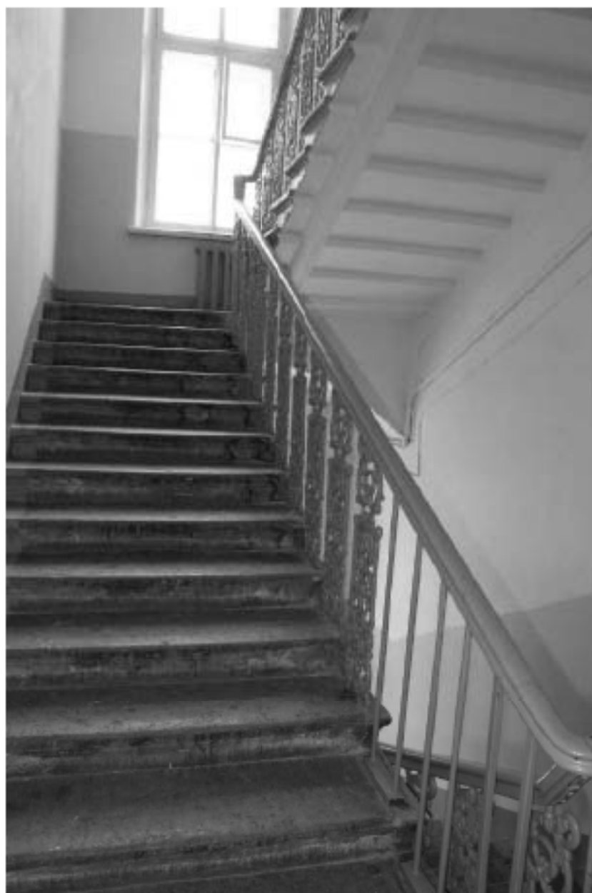
Фото 59. Выявленный объект культурного наследия «Жилой офицерский дом со службой и оградой». Жилой офицерский дом. Вид на интерьер 4ЛК в уровне 2-го этажа. Фото 11.12.2023 г.
