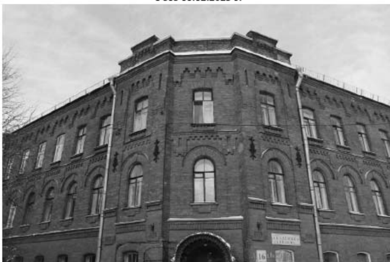
Фото 4. Выявленный объект культурного наследия «Жилой офицерский дом со службой и оградой». Вид на юго-восточный угол жилого офицерского дома. Фото 11.12.2023 г.
