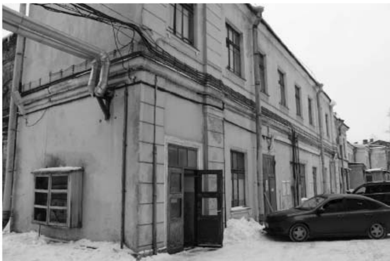
Фото 176. Выявленный объект культурного наследия «Манеж с конюшнями». Вид на здание в границах манежа. Фото 11.12.2023 г.
