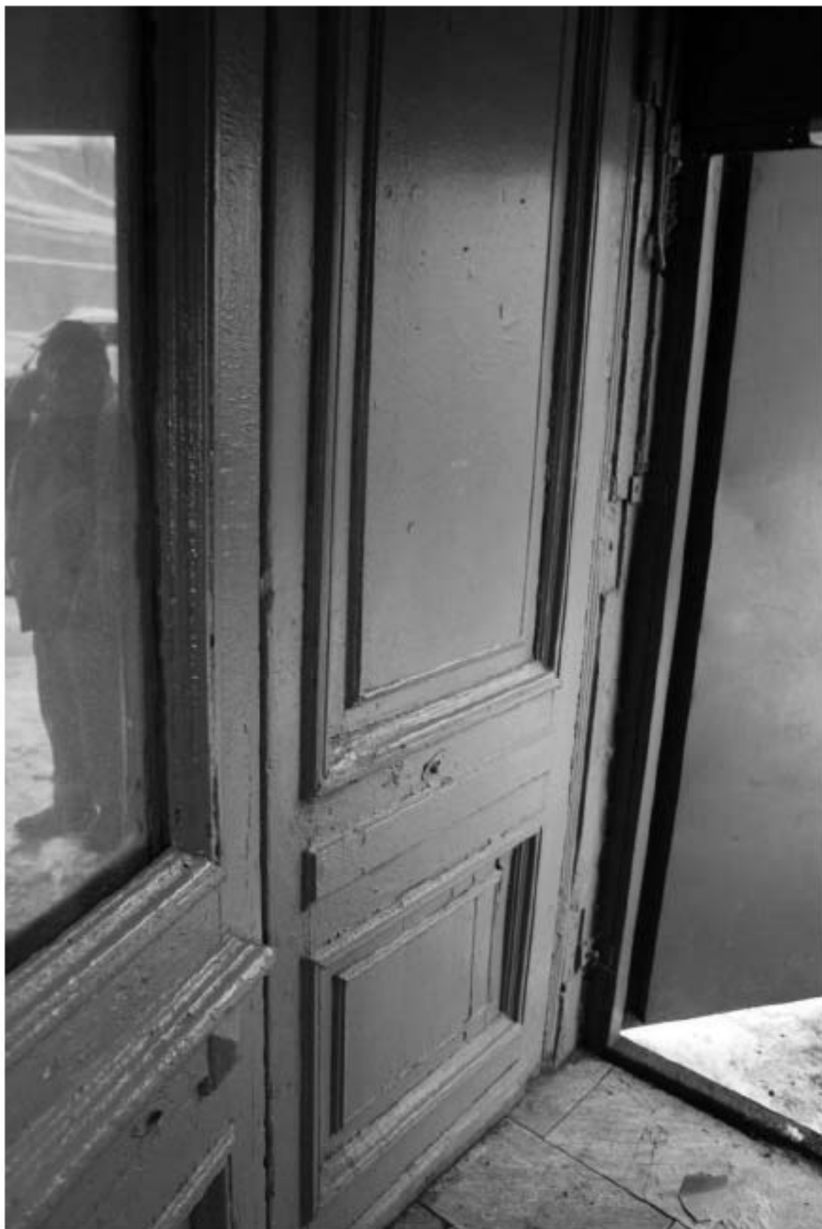
Фото 19. Выявленный объект культурного наследия «Жилой офицерский дом со службой и оградой». Жилой офицерский дом. Вид на интерьер 1ЛК в уровне 1-го этажа. Фото 11.12.2023 г.
