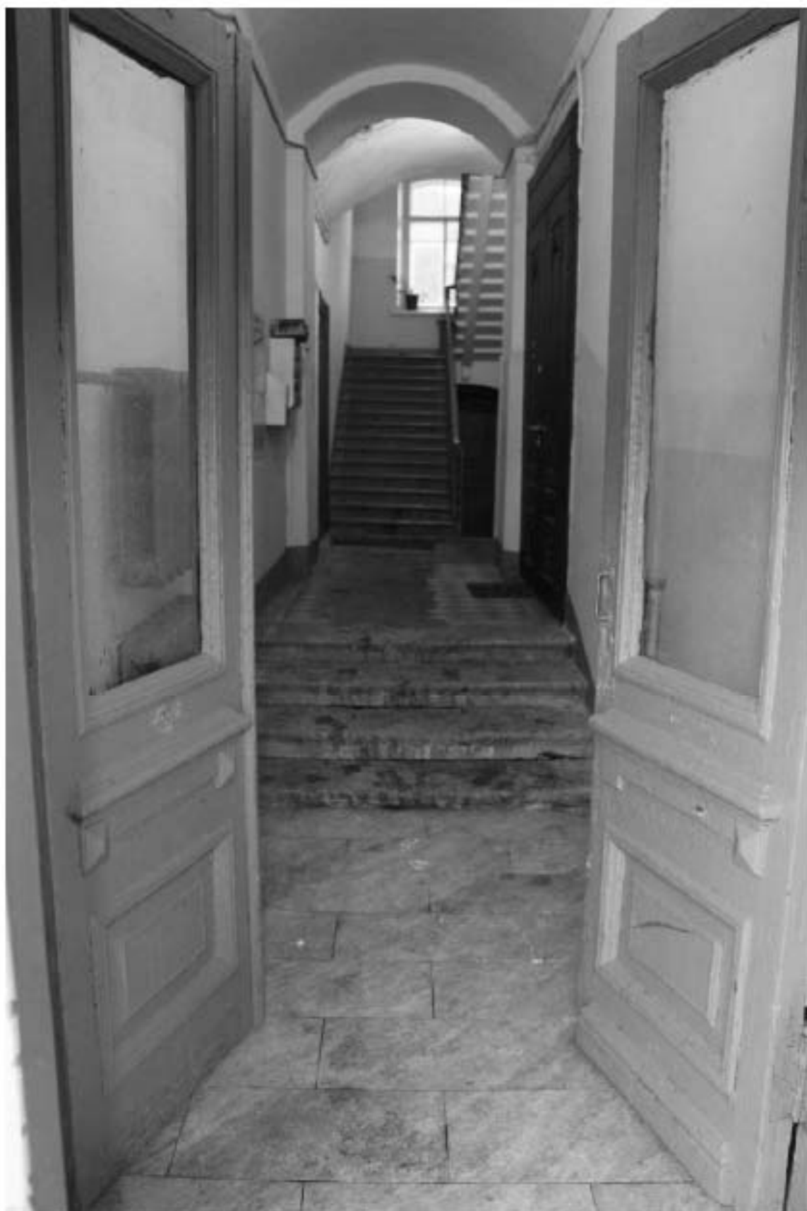
Фото 16. Выявленный объект культурного наследия «Жилой офицерский дом со службой и оградой». Жилой офицерский дом. Вид на интерьер 1ЛК в уровне 1-го этажа. Фото 11.12.2023 г.
