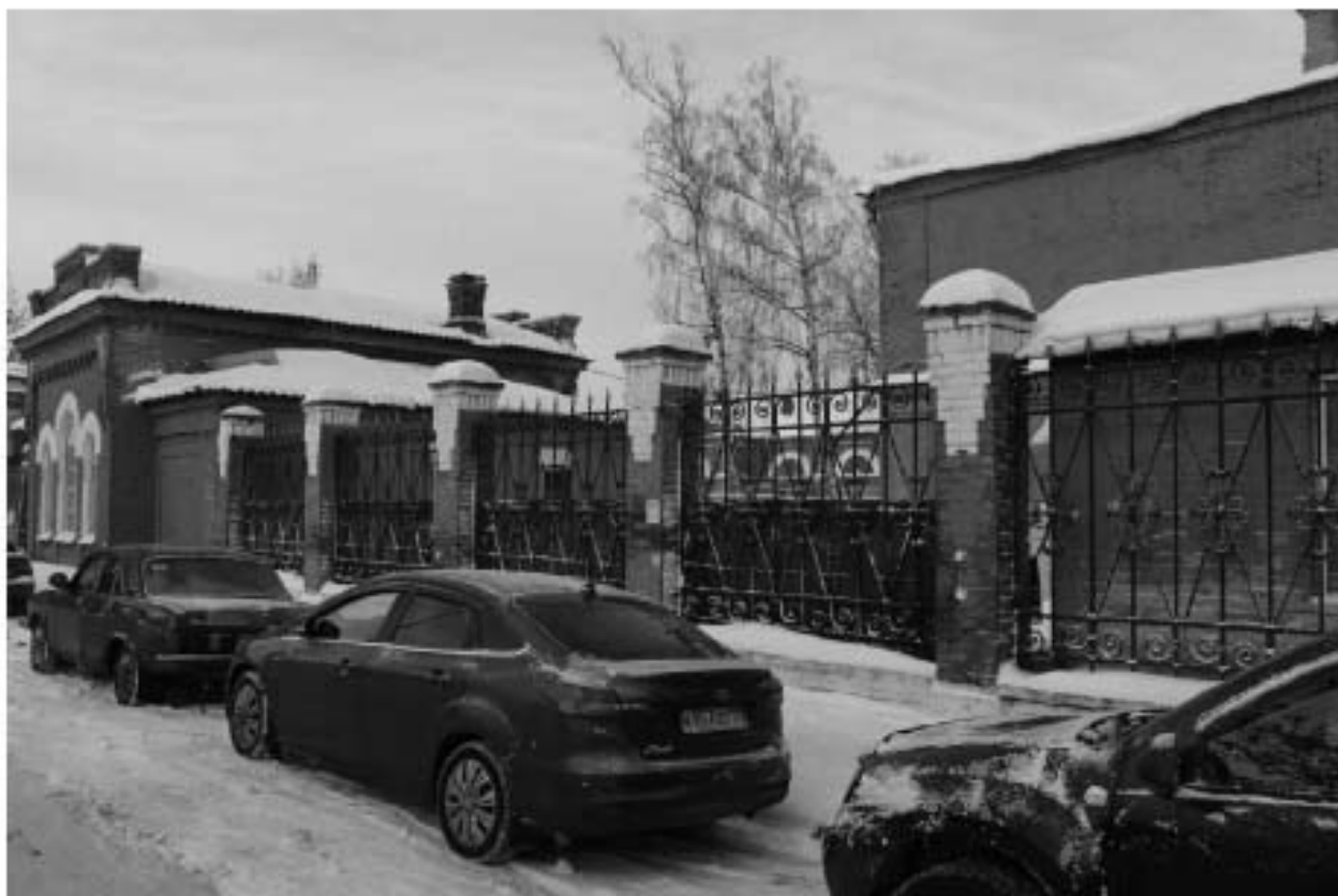
Фото 162. Выявленный объект культурного наследия «Караульня с оградой». Вид на восточную часть ограды. Фото 11.12.2023 г.
