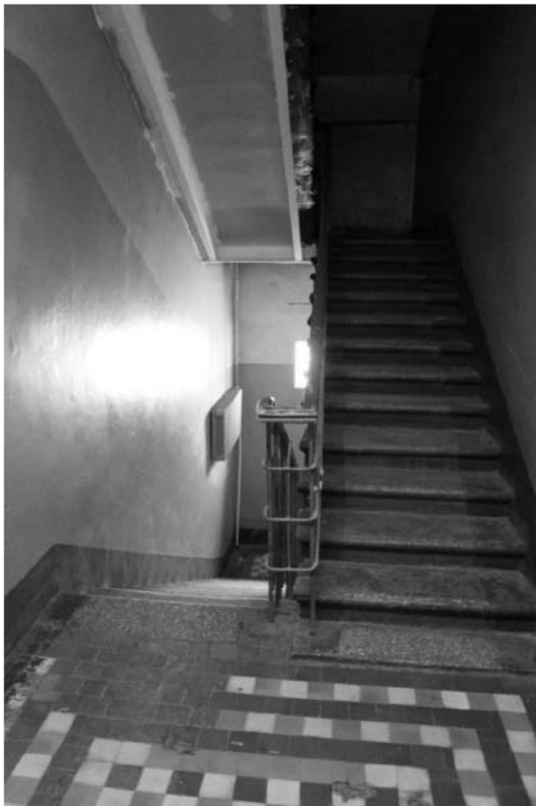
Фото 259. Выявленный объект культурного наследия «Манеж с конюшнями». Центральный и западный Т-образный объемы конюшен. Интерьер западной лестничной клетки в уровне 3-го этажа. Фото 11.12.2023 г.
