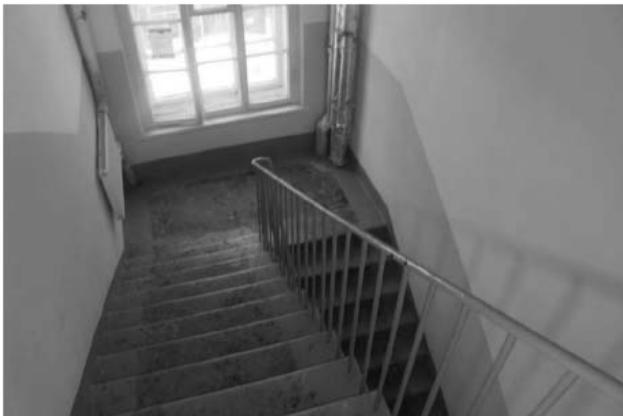
Фото 104. Выявленный объект культурного наследия «Казармы со службой». Казармы. Вид на интерьер 1ЛК в уровне 2-го – 3-го этажей. Фото 11.12.2023 г.
