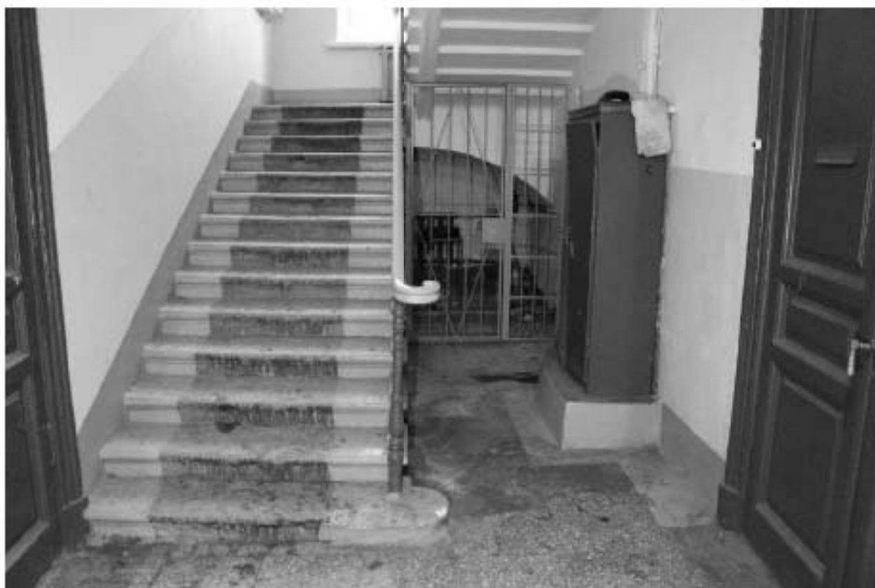
Фото 43. Выявленный объект культурного наследия «Жилой офицерский дом со службой и оградой». Жилой офицерский дом. Вид на интерьер 2ЛК в уровне 1-го этажа. Фото 11.12.2023 г.
