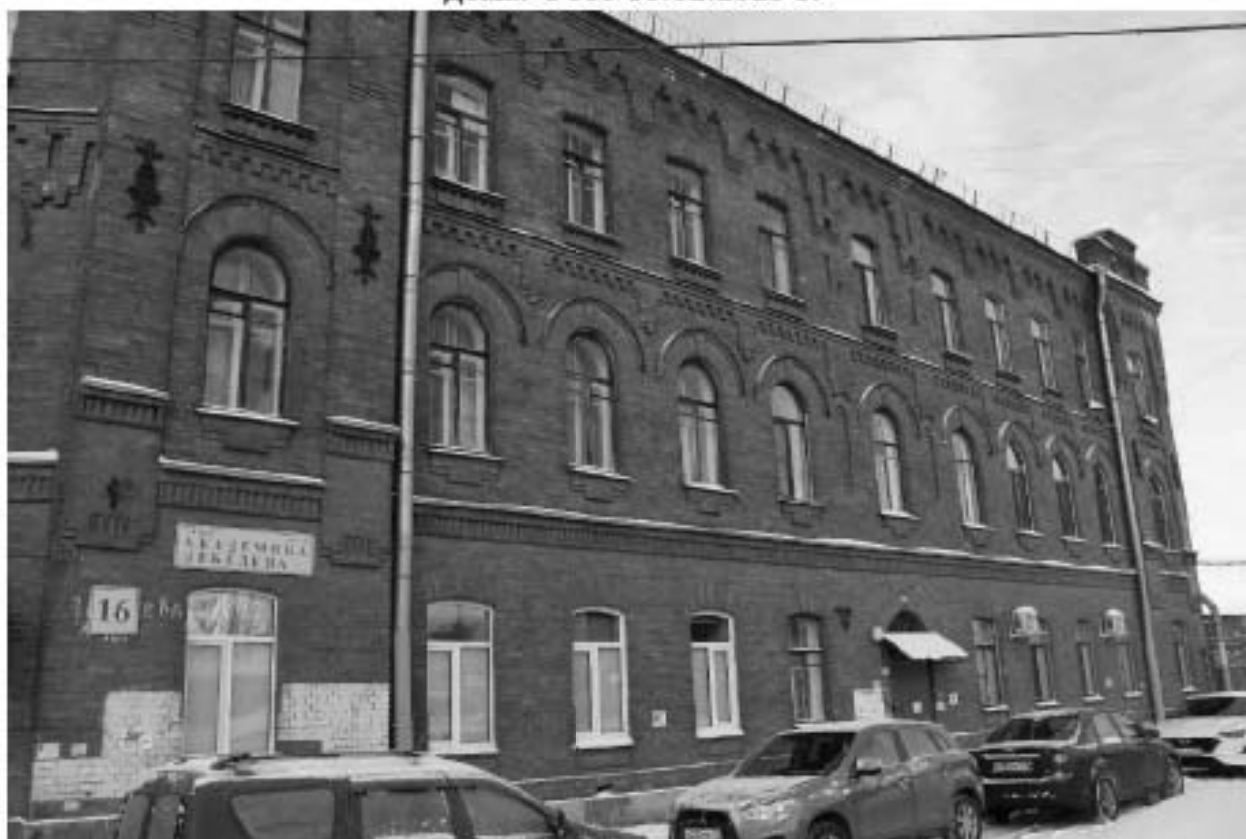
Фото 2. Выявленный объект культурного наследия «Жилой офицерский дом со службой и оградой». Вид на восточный лицевой фасад жилого офицерского дома. Фото 11.12.2023 г.
