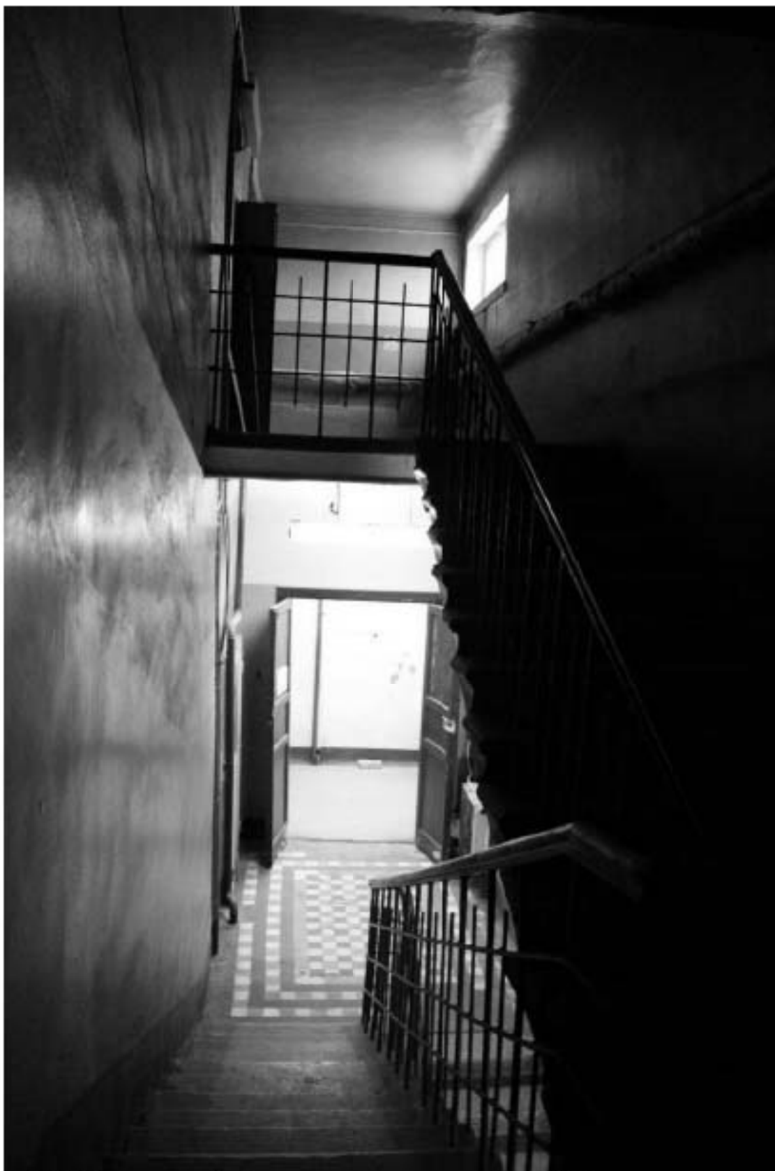
Фото 260. Выявленный объект культурного наследия «Манеж с конюшнями». Центральный и западный Т-образный объемы конюшен. Интерьер западной лестничной клетки в уровне 3-го – чердачного этажей. Фото 11.12.2023 г.
