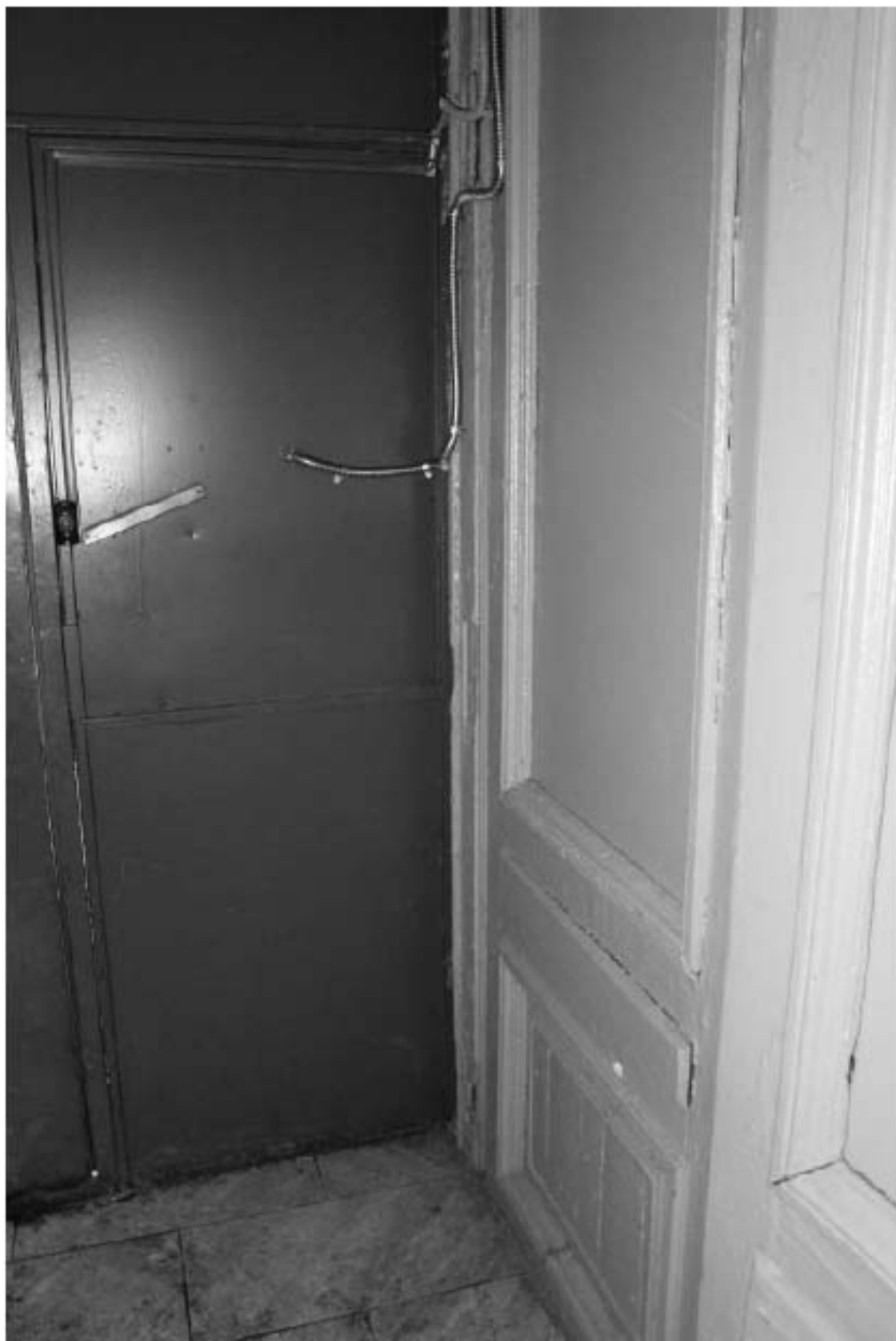
Фото 51. Выявленный объект культурного наследия «Жилой офицерский дом со службой и оградой». Жилой офицерский дом. Вид на интерьер 4ЛК в уровне 1-го этажа. Фото 11.12.2023 г.
