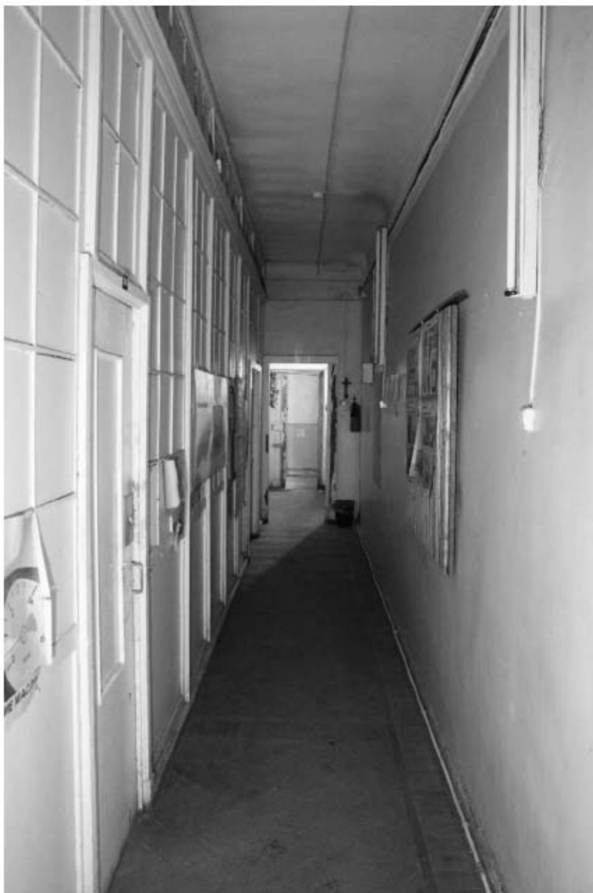
Фото 193. Выявленный объект культурного наследия «Манеж с конюшнями». Здание в границах манежа. Интерьер внутренних помещений в уровне 2-го этажа. Фото 11.12.2023 г.
