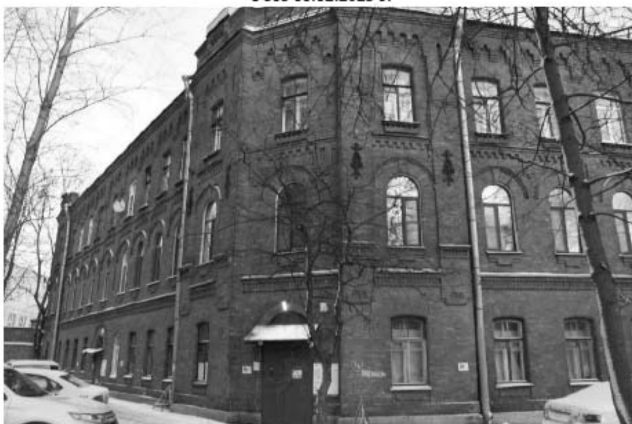
Фото 8. Выявленный объект культурного наследия «Жилой офицерский дом со службой и оградой». Вид на юго-западный угол жилого офицерского дома. Фото 11.12.2023 г.
