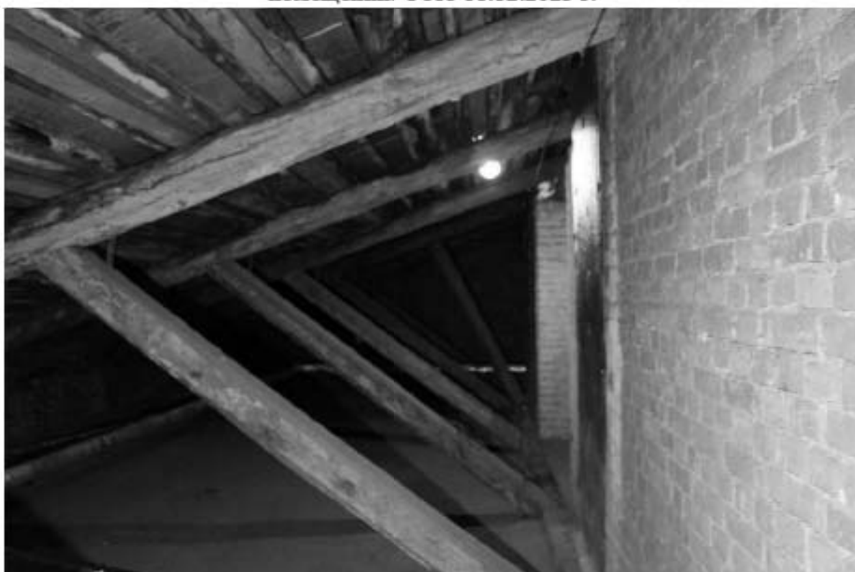
Фото 70. Выявленный объект культурного наследия «Жилой офицерский дом со службой и оградой». Жилой офицерский дом. Вид на интерьер чердачных помещений. Фото 11.12.2023 г.
