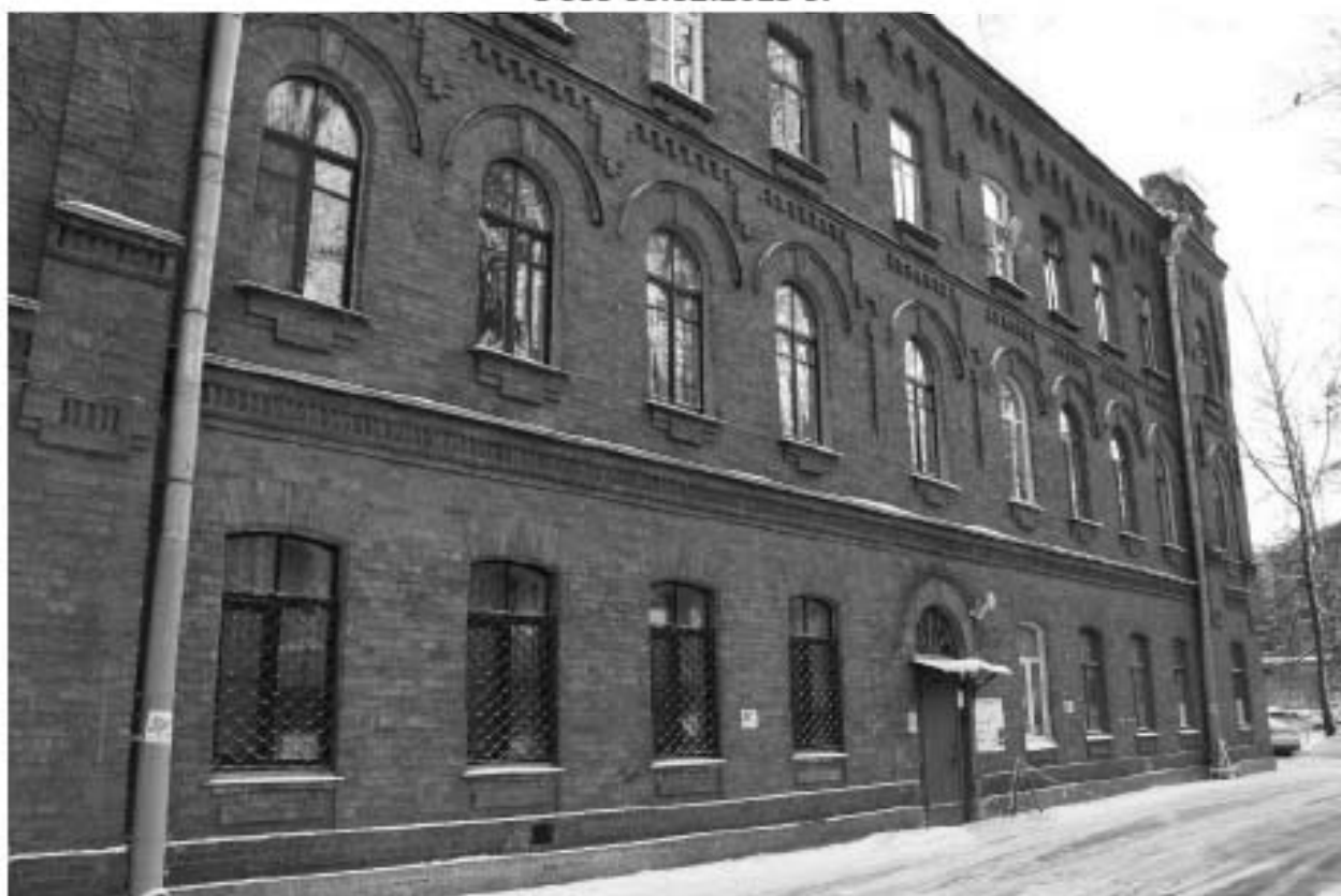
Фото 10. Выявленный объект культурного наследия «Жилой офицерский дом со службой и оградой». Вид на западный лицевой фасад жилого офицерского дома. Фото 11.12.2023 г.
