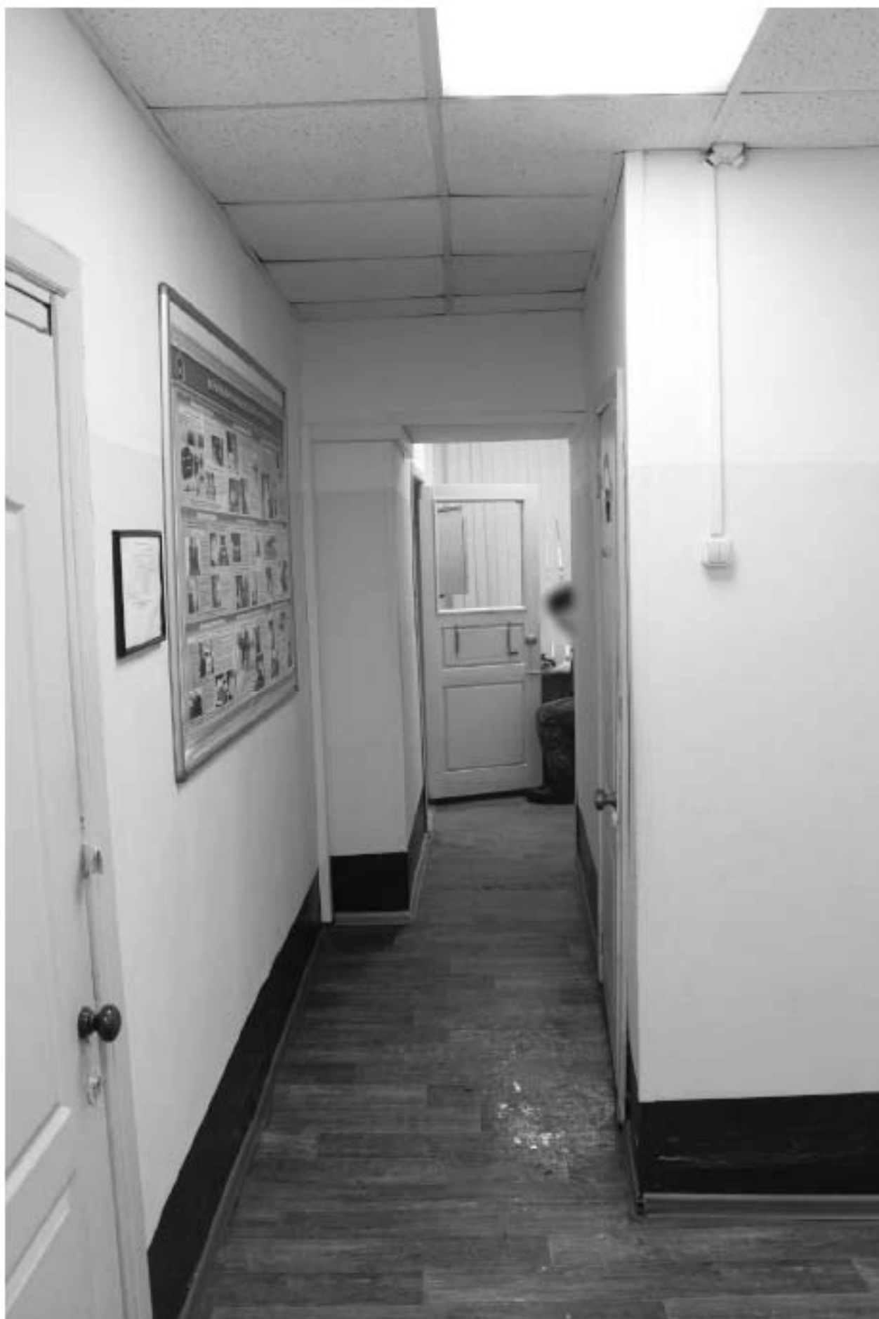
Фото 158. Выявленный объект культурного наследия «Караульня с оградой». Интерьер внутренних помещений караульни. Фото 11.12.2023 г.
