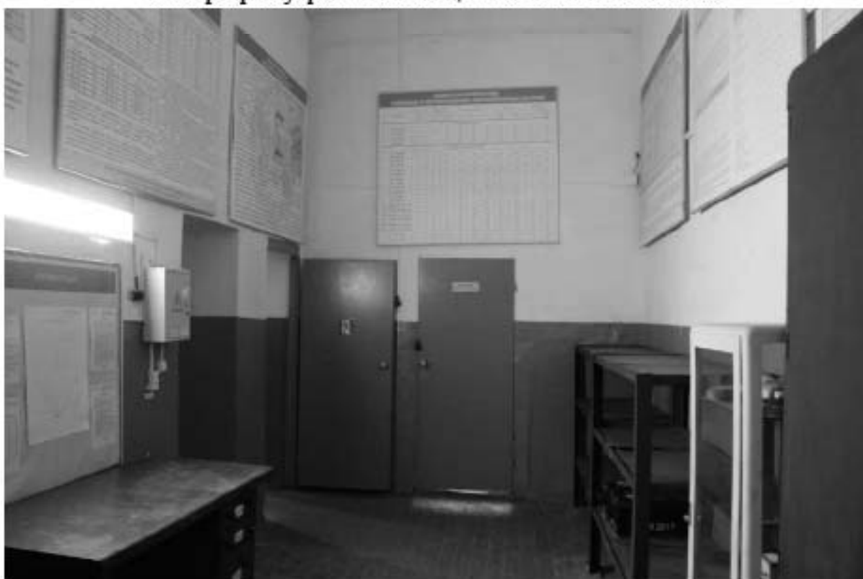
Фото 305. Выявленный объект культурного наследия «Конский» лазарет». Интерьер внутренних помещений. Фото 11.12.2023 г.
