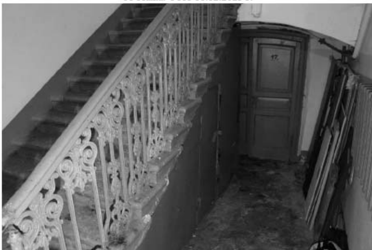
Фото 24. Выявленный объект культурного наследия «Жилой офицерский дом со службой и оградой». Жилой офицерский дом. Вид на интерьер 1ЛК в уровне 1-го этажа. Фото 11.12.2023 г.
