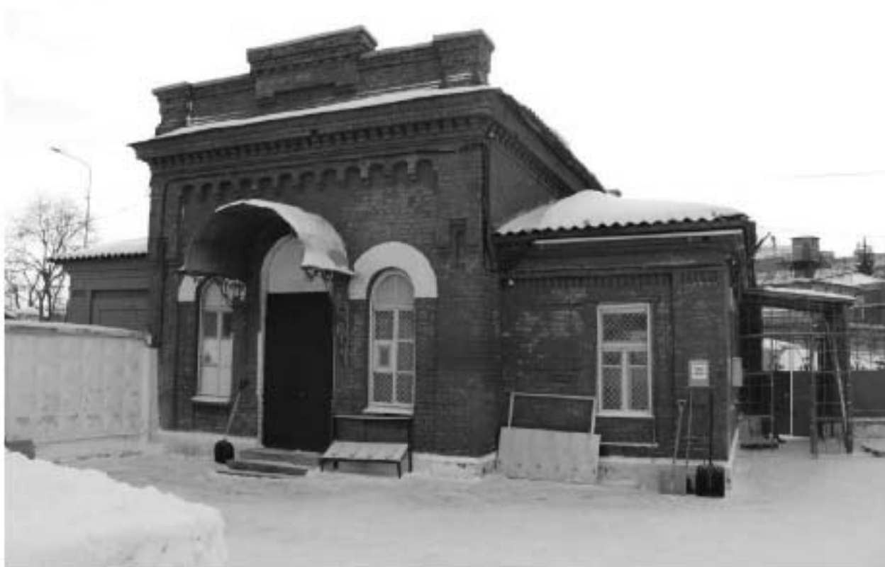
Фото 154. Выявленный объект культурного наследия «Караульня с оградой». Вид на северный фасад караульни. Фото 11.12.2023 г.
