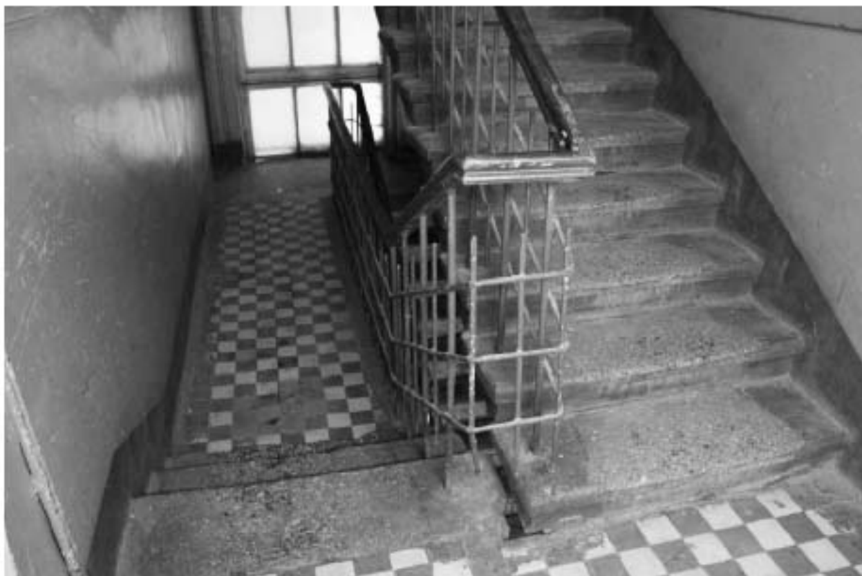
Фото 255. Выявленный объект культурного наследия «Манеж с конюшнями». Центральный и западный Т-образный объемы конюшен. Интерьер западной лестничной клетки в уровне 2-го этажа. Фото 11.12.2023 г.
