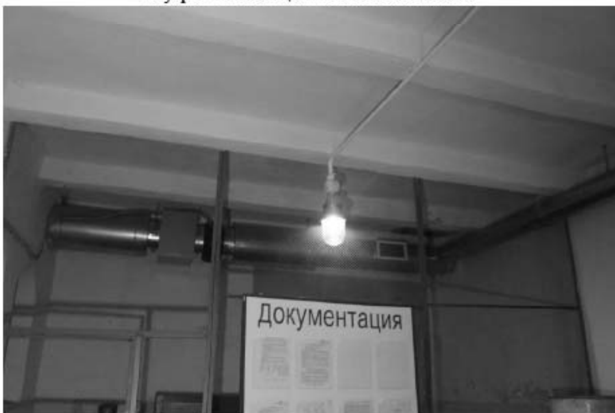
Фото 333. Выявленный объект культурного наследия «Кузница». Интерьер внутренних помещений. Фото 11.12.2023 г.
