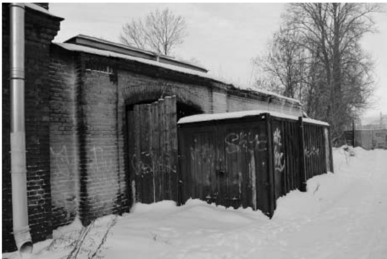
Фото 83. Выявленный объект культурного наследия «Казармы со службой». Вид на кирпичную ограду к северу от казарм. Фото 11.12.2023 г.
