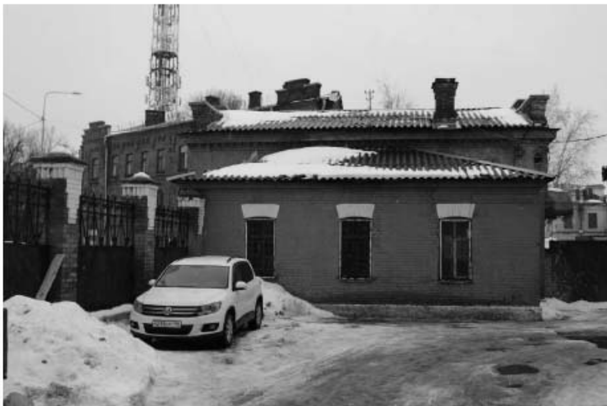
Фото 151. Выявленный объект культурного наследия «Караульня с оградой». Вид на восточный фасад караульни. Фото 25.01.2024 г.
