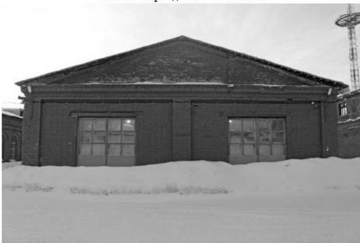
Фото 339. Выявленный объект культурного наследия «Обозные сараи». Вид на северный фасад. Фото 11.12.2023 г.
