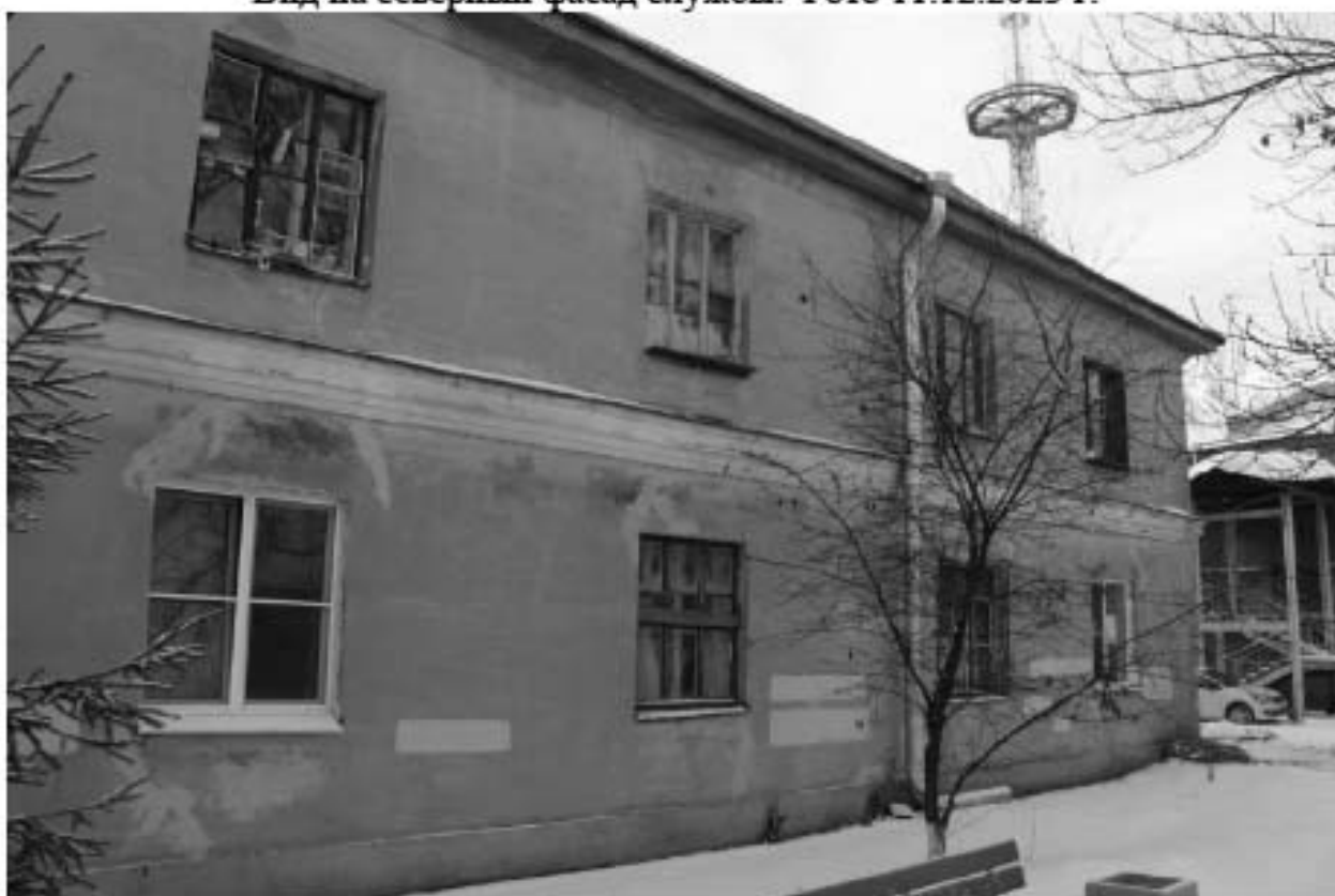
Фото 138. Выявленный объект культурного наследия «Казармы со службой». Вид на северный фасад службы. Фото 11.12.2023 г.
