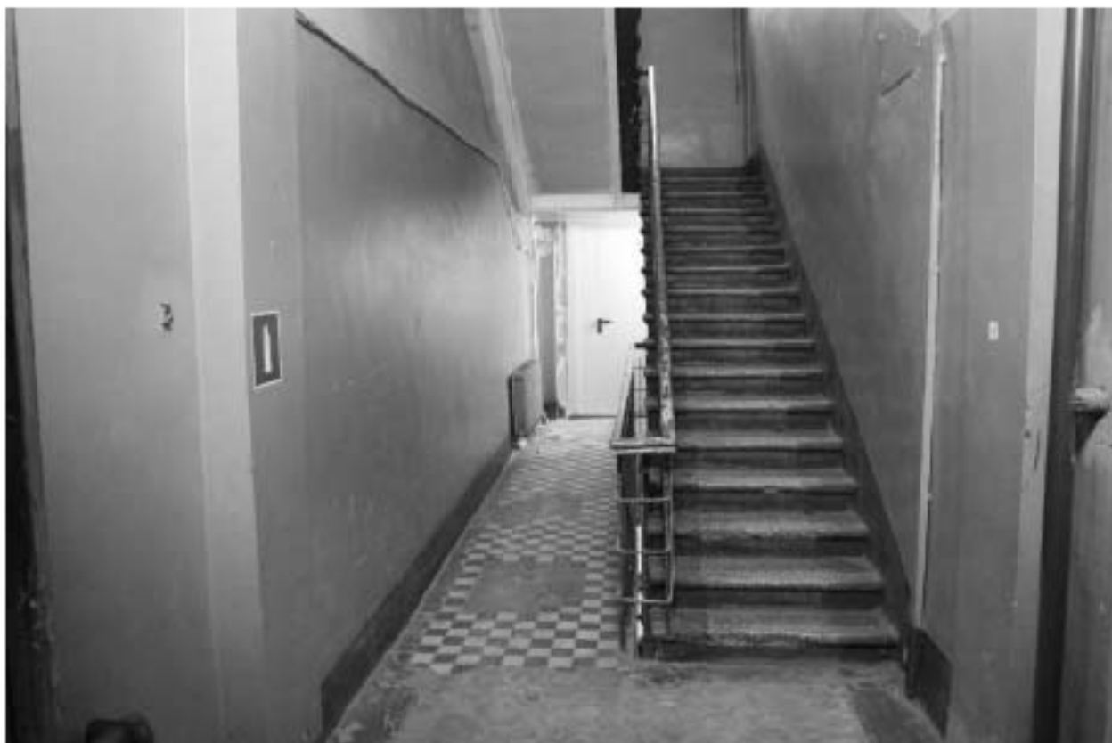
Фото 257. Выявленный объект культурного наследия «Манеж с конюшнями». Центральный и западный Т-образный объемы конюшен. Интерьер западной лестничной клетки в уровне 2-го этажа. Фото 11.12.2023 г.
