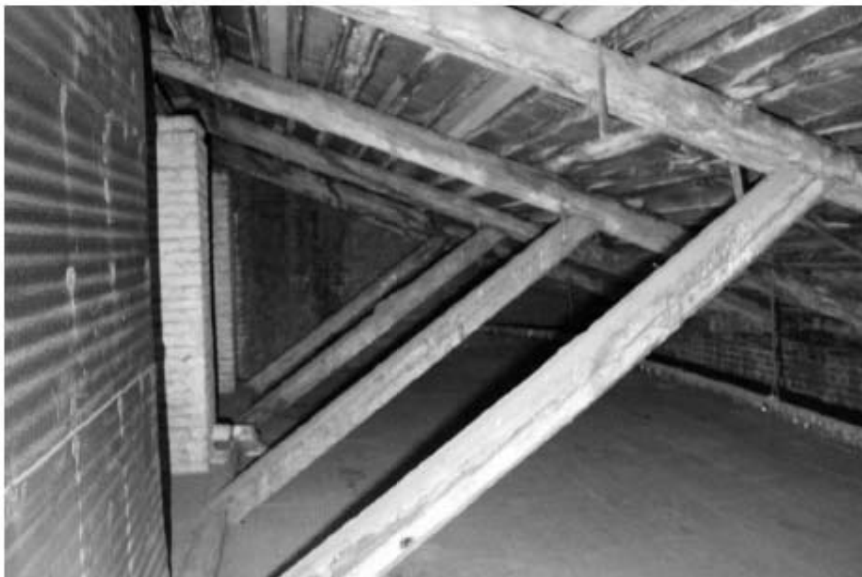
Фото 69. Выявленный объект культурного наследия «Жилой офицерский дом со службой и оградой». Жилой офицерский дом. Вид на интерьер чердачных помещений. Фото 11.12.2023 г.
