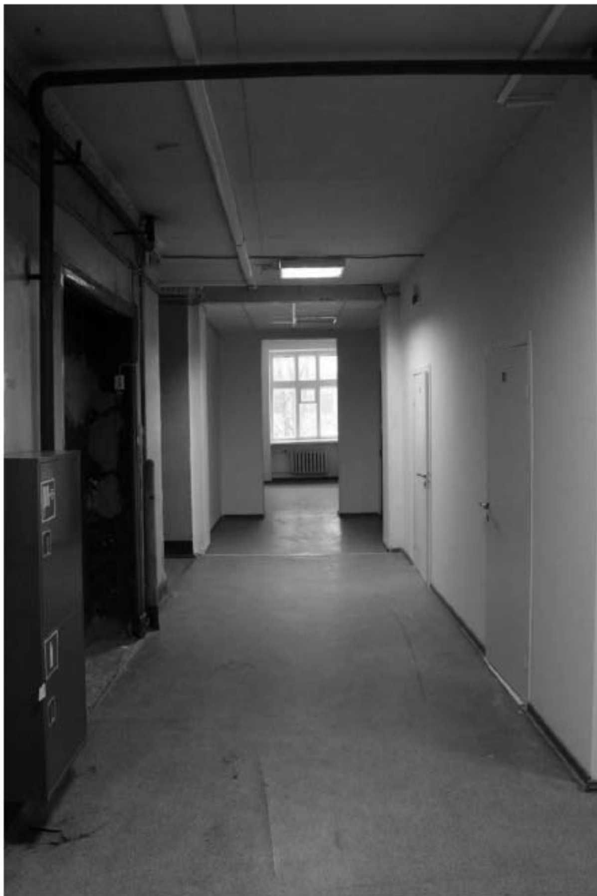
Фото 279. Выявленный объект культурного наследия «Манеж с конюшнями». Центральный и западный Т-образный объемы конюшен. Интерьер внутренних помещений 2-го этажа. Фото 11.12.2023 г.
