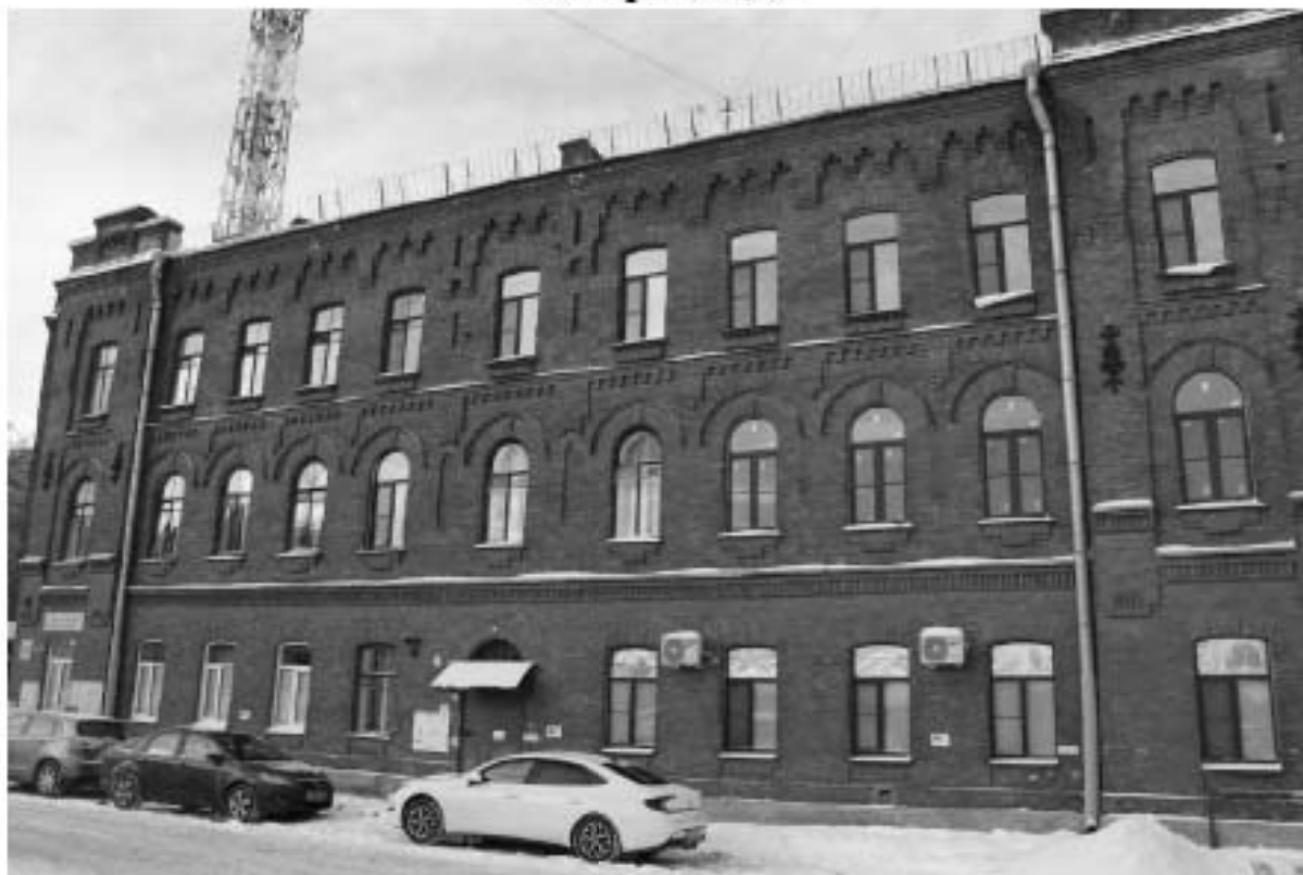
Фото 1. Выявленный объект культурного наследия «Жилой офицерский дом со службой и оградой». Вид на восточный лицевой фасад жилого офицерского дома. Фото 11.12.2023 г.
