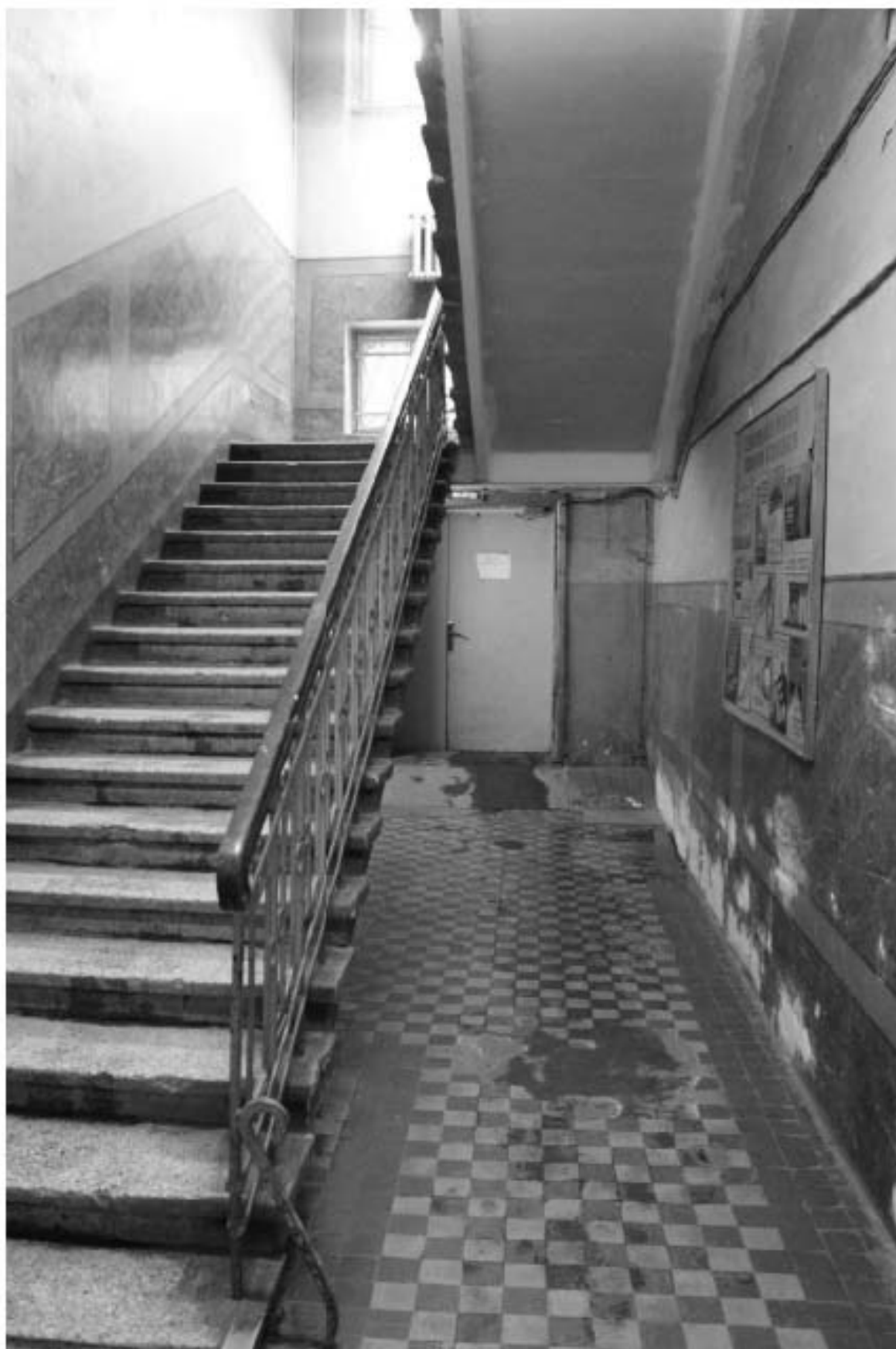
Фото 237. Выявленный объект культурного наследия «Манеж с конюшнями». Центральный и западный Т-образный объемы конюшен. Интерьер восточной лестничной клетки в уровне 1-го этажа. Фото 11.12.2023 г.
