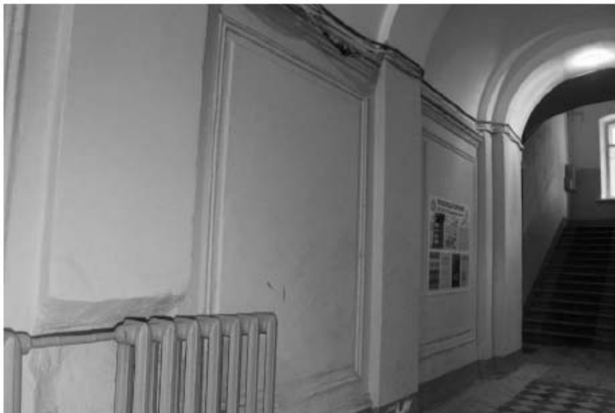
Фото 41. Выявленный объект культурного наследия «Жилой офицерский дом со службой и оградой». Жилой офицерский дом. Вид на интерьер 2ЛК в уровне 1-го этажа. Фото 11.12.2023 г.
