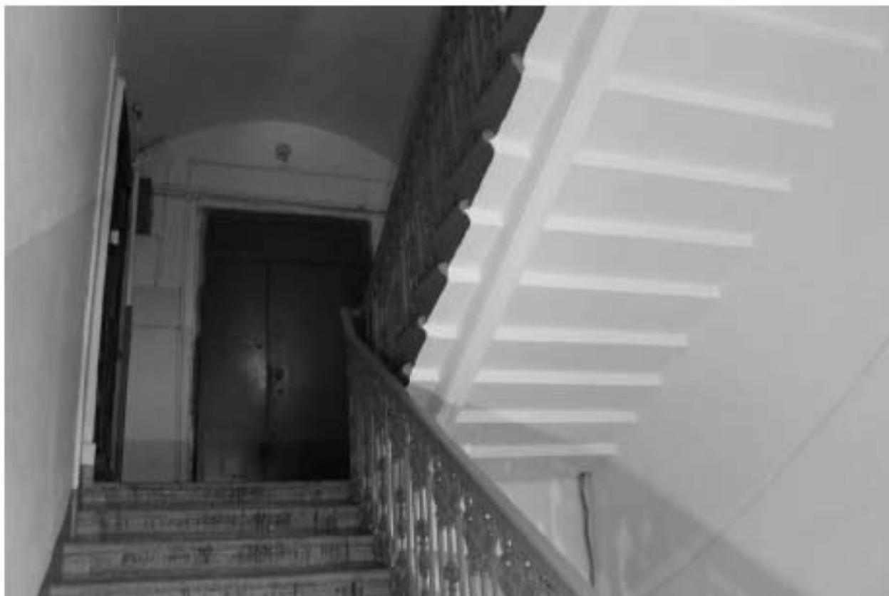
Фото 34. Выявленный объект культурного наследия «Жилой офицерский дом со службой и оградой». Жилой офицерский дом. Вид на интерьер 1ЛК в уровне 3-го этажа. Фото 11.12.2023 г.
