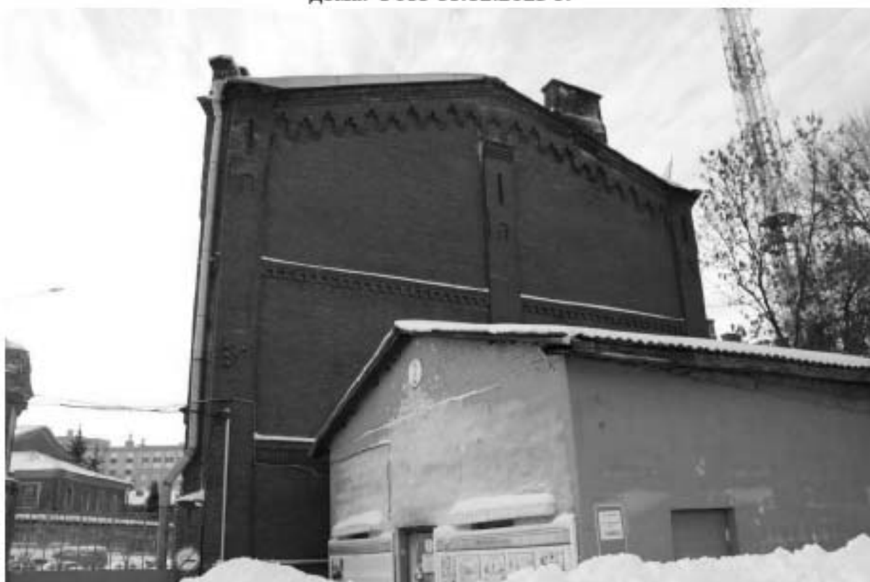
Фото 12. Выявленный объект культурного наследия «Жилой офицерский дом со службой и оградой». Вид на восточный торцевой фасад жилого офицерского дома. Фото 11.12.2023 г.
