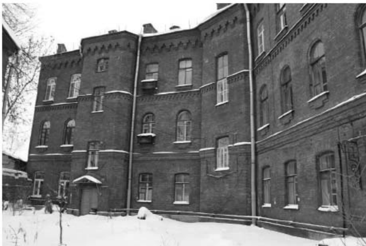
Фото 13. Выявленный объект культурного наследия «Жилой офицерский дом со службой и оградой». Вид на восточный дворовый фасад жилого офицерского дома. Фото 11.12.2023 г.
