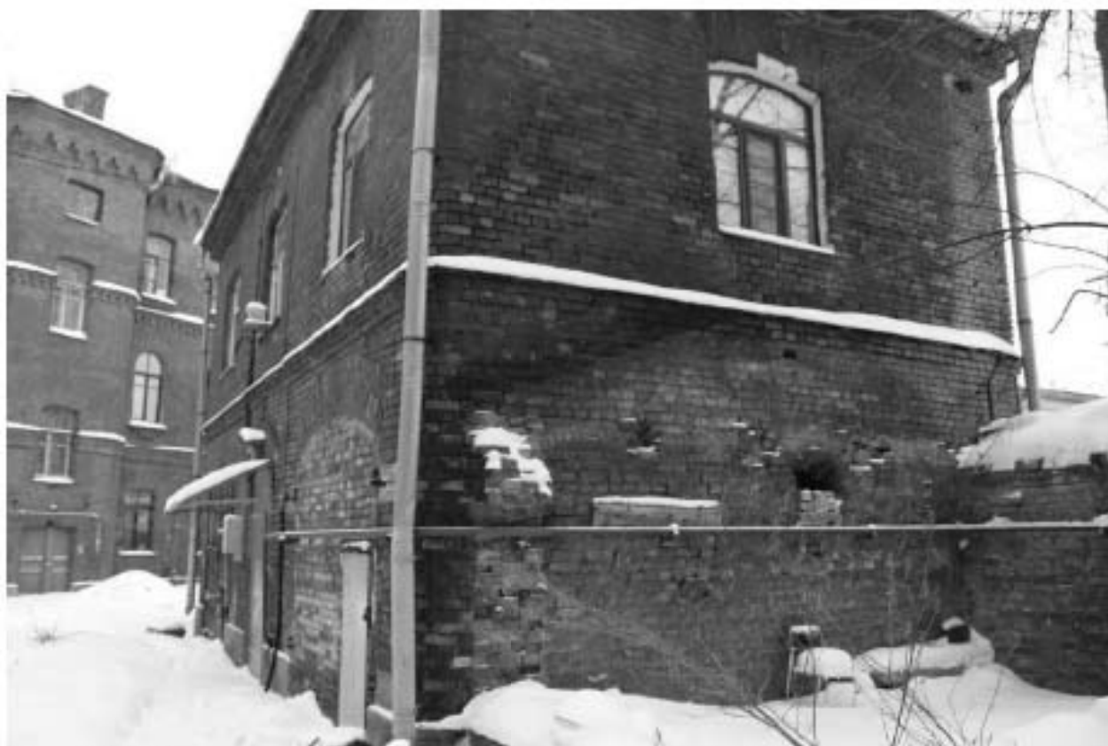
Фото 73. Выявленный объект культурного наследия «Жилой офицерский дом со службой и оградой». Вид на восточный фасад службы. Фото 11.12.2023 г.
