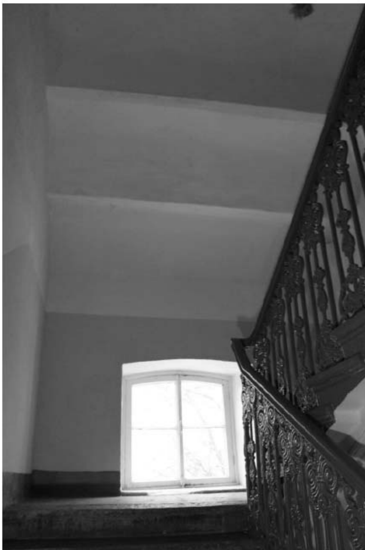
Фото 36. Выявленный объект культурного наследия «Жилой офицерский дом со службой и оградой». Жилой офицерский дом. Вид на интерьер 1ЛК в уровне чердачного этажа. Фото 11.12.2023 г.
