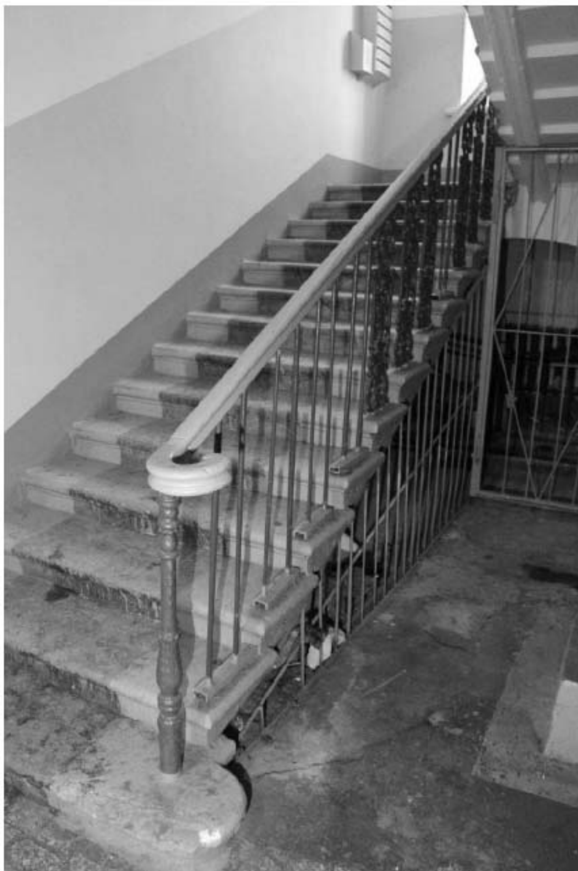
Фото 44. Выявленный объект культурного наследия «Жилой офицерский дом со службой и оградой». Жилой офицерский дом. Вид на интерьер 2ЛК в уровне 1-го этажа. Фото 11.12.2023 г.
