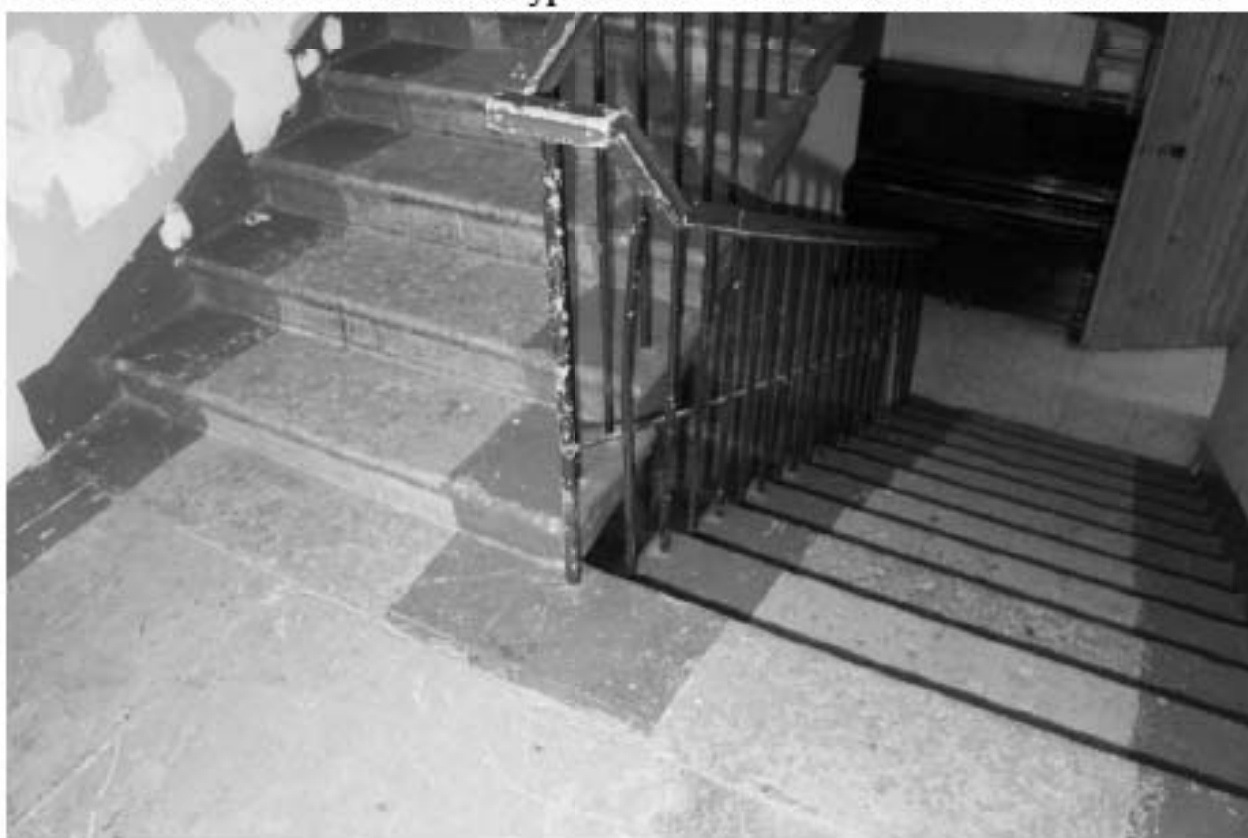
Фото 360. Выявленный объект культурного наследия «Саран для артиллерии». Восточная лестничная клетка в уровне 1-го – 2-го этажей. Фото 25.01.2024 г.
