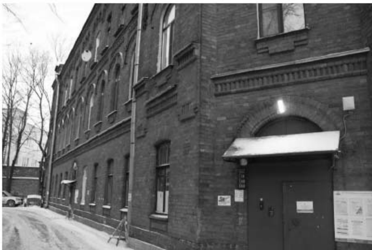
Фото 9. Выявленный объект культурного наследия «Жилой офицерский дом со службой и оградой». Вид на западный лицевой фасад жилого офицерского дома. Фото 11.12.2023 г.
