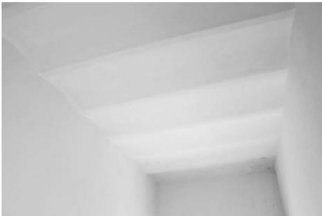
Фото 50. Выявленный объект культурного наследия «Жилой офицерский дом со службой и оградой». Жилой офицерский дом. Вид на интерьер 2ЛК в уровне 3-го этажа. Фото 11.12.2023 г.
