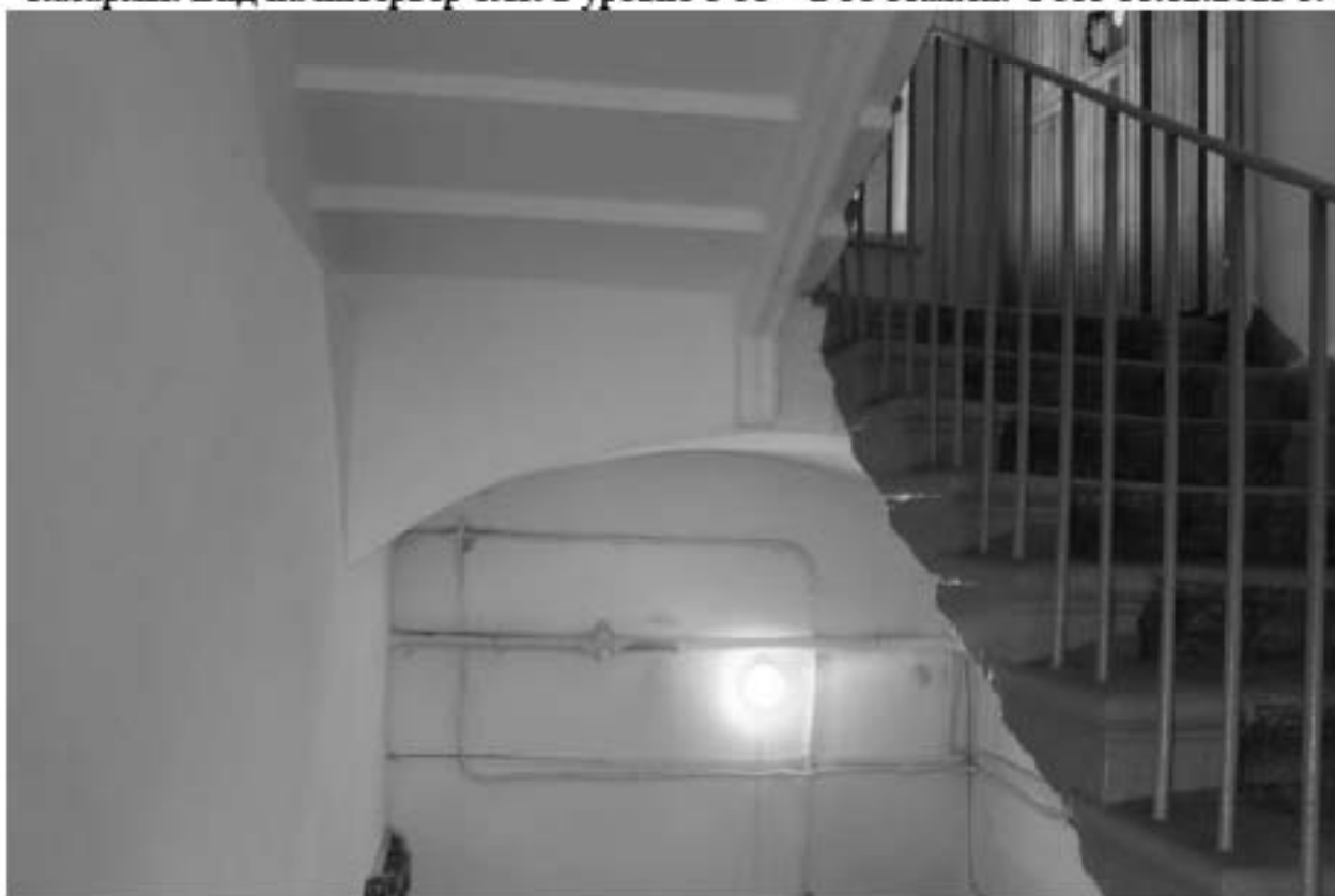
Фото 101. Выявленный объект культурного наследия «Казармы со службой». Казармы. Вид на интерьер 1ЛК в уровне 1-го – 2-го этажей. Фото 11.12.2023 г.
