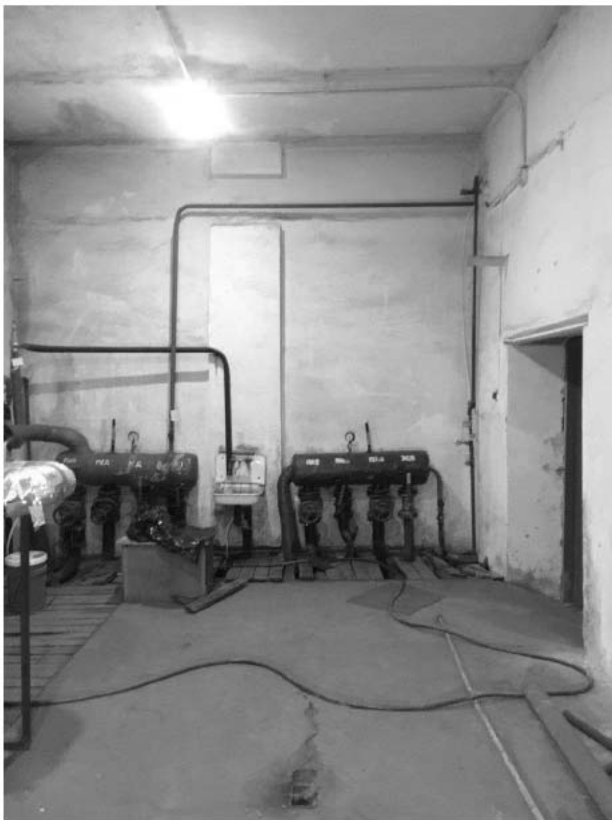
Фото 318. Выявленный объект культурного наследия «Фуражные саран». Интерьер внутренних помещений 1-го этажа. Фото 11.12.2023 г.
