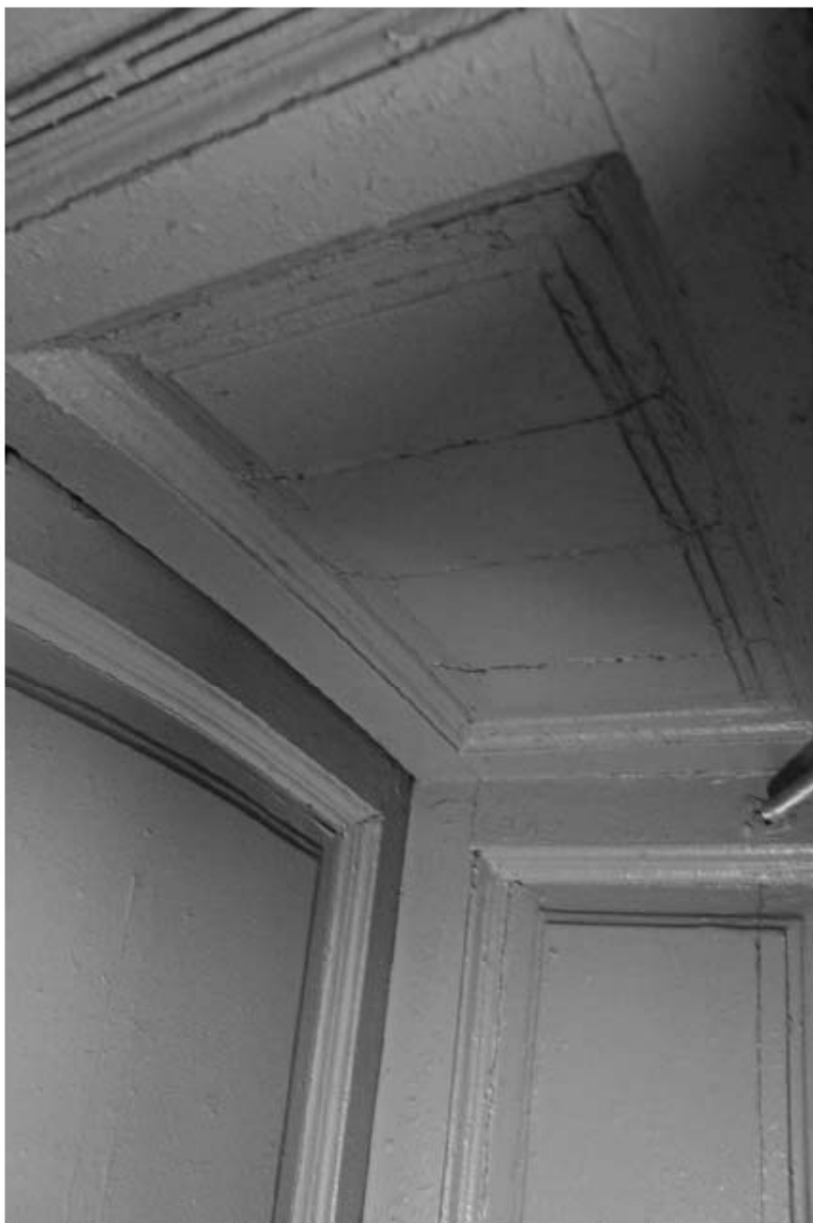
Фото 27. Выявленный объект культурного наследия «Жилой офицерский дом со службой и оградой». Жилой офицерский дом. Вид на интерьер 1ЛК в уровне 1-го этажа. Фото 11.12.2023 г.
