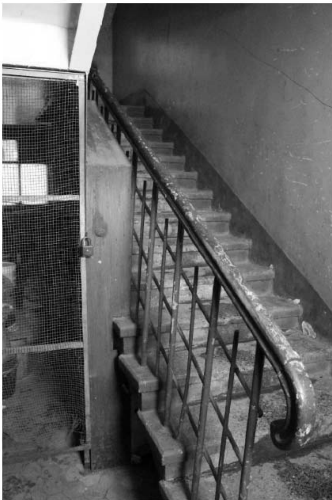
Фото 253. Выявленный объект культурного наследия «Манеж с конюшнями». Центральный и западный Т-образный объемы конюшен. Интерьер западной лестничной клетки в уровне 1-го этажа. Фото 11.12.2023 г.
