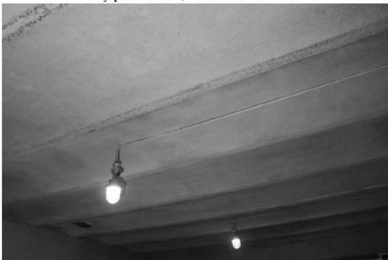
Фото 335. Выявленный объект культурного наследия «Кузница». Интерьер внутренних помещений. Фото 11.12.2023 г.
