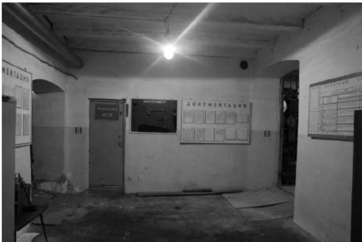
Фото 332. Выявленный объект культурного наследия «Кузница». Интерьер внутренних помещений. Фото 11.12.2023 г.
