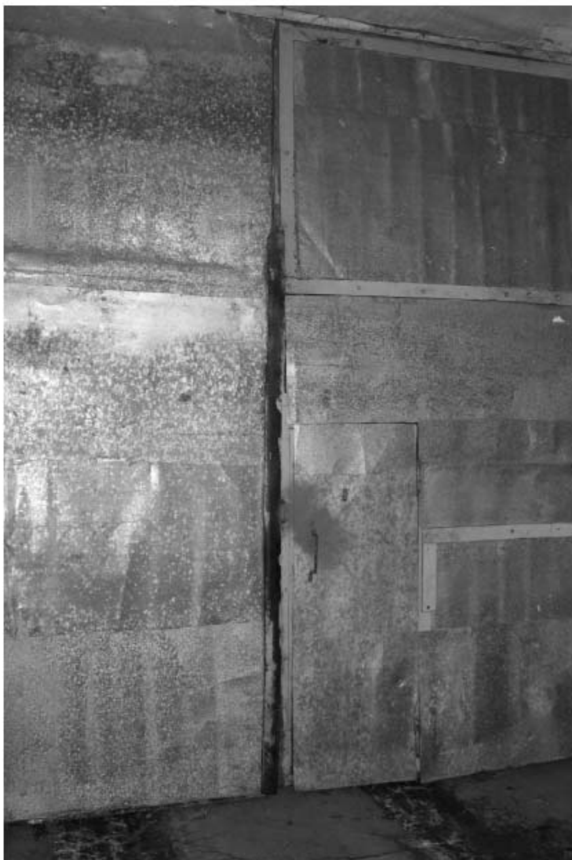
Фото 179. Выявленный объект культурного наследия «Манеж с конюшнями». Манеж. Интерьер внутренних помещений. Фото 11.12.2023 г.
