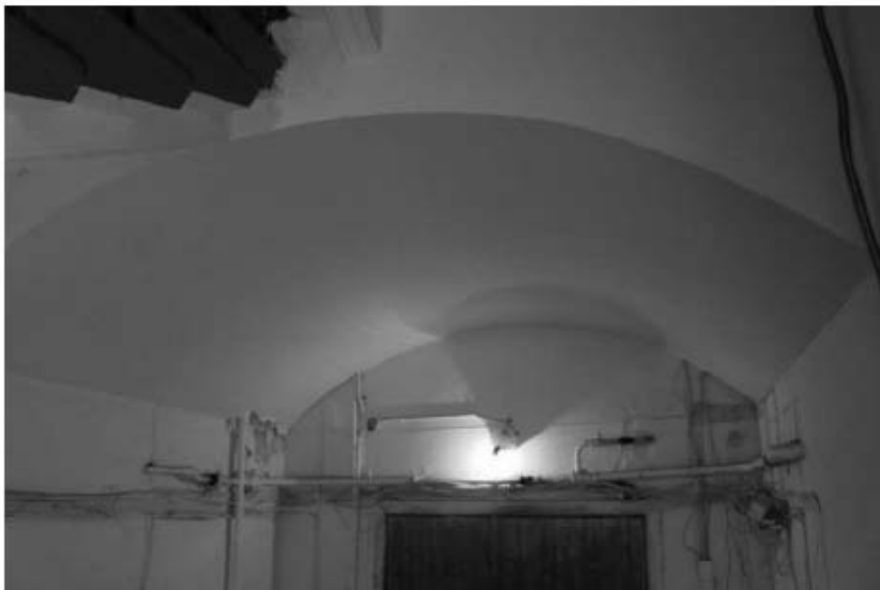
Фото 32. Выявленный объект культурного наследия «Жилой офицерский дом со службой и оградой». Жилой офицерский дом. Вид на интерьер 1ЛК в уровне 2-го этажа. Фото 11.12.2023 г.
