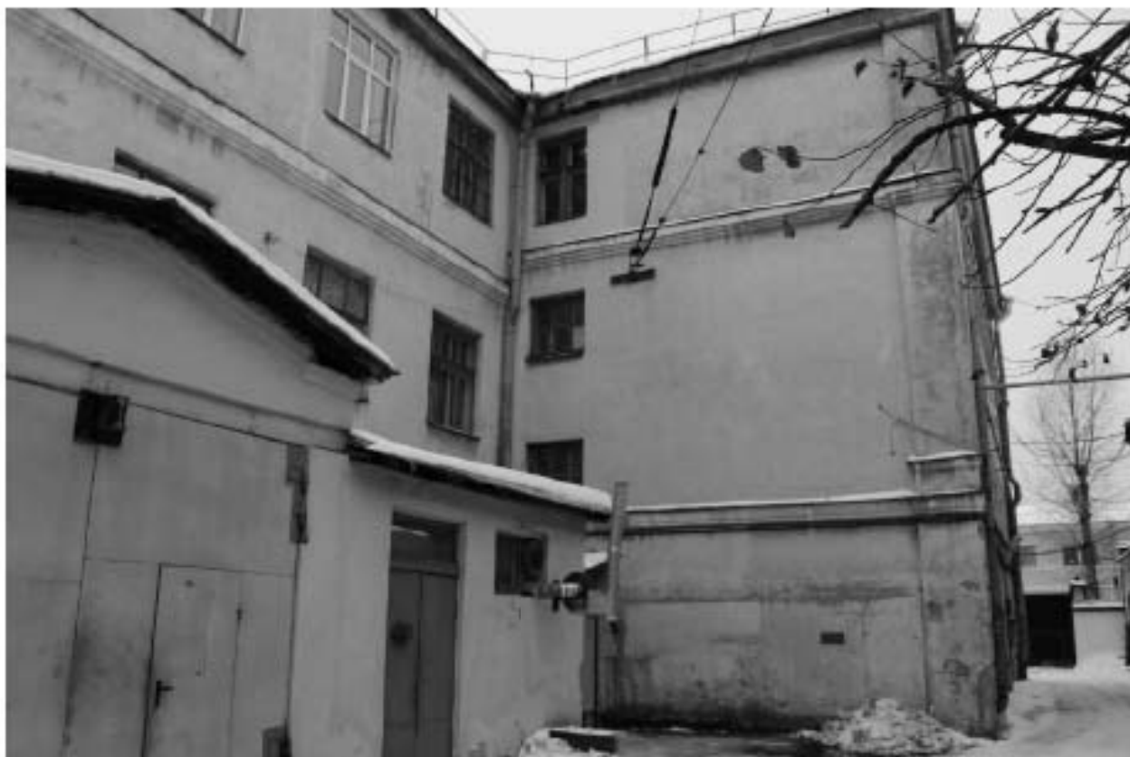
Фото 229. Выявленный объект культурного наследия «Манеж с конюшнями». Вид на северный фасад западного Т-образного объема конюшен. Фото 11.12.2023 г.
