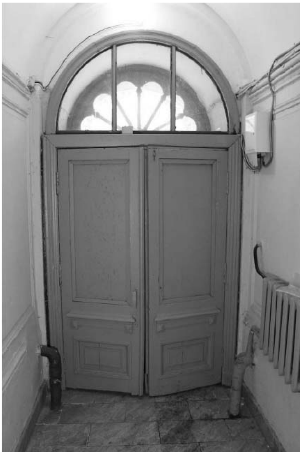
Фото 39. Выявленный объект культурного наследия «Жилой офицерский дом со службой и оградой». Жилой офицерский дом. Вид на интерьер 2ЛК в уровне 1-го этажа. Фото 11.12.2023 г.
