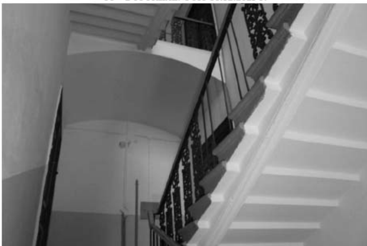
Фото 46. Выявленный объект культурного наследия «Жилой офицерский дом со службой и оградой». Жилой офицерский дом. Вид на интерьер 2ЛК в уровне 2-го этажа. Фото 11.12.2023 г.
