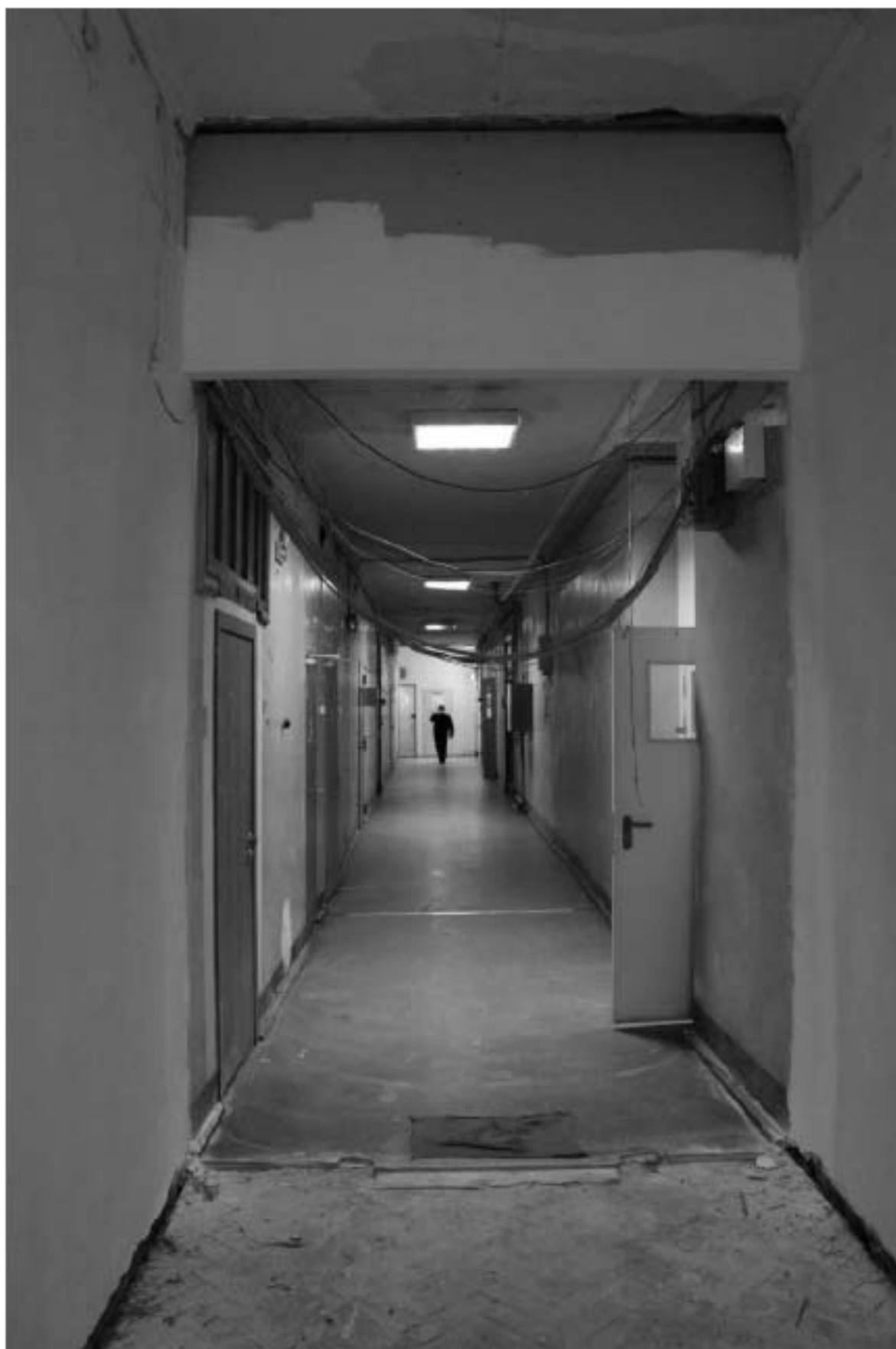
Фото 274. Выявленный объект культурного наследия «Манеж с конюшнями». Центральный и западный Т-образный объемы конюшен. Интерьер внутренних помещений 2-го этажа. Фото 11.12.2023 г.
