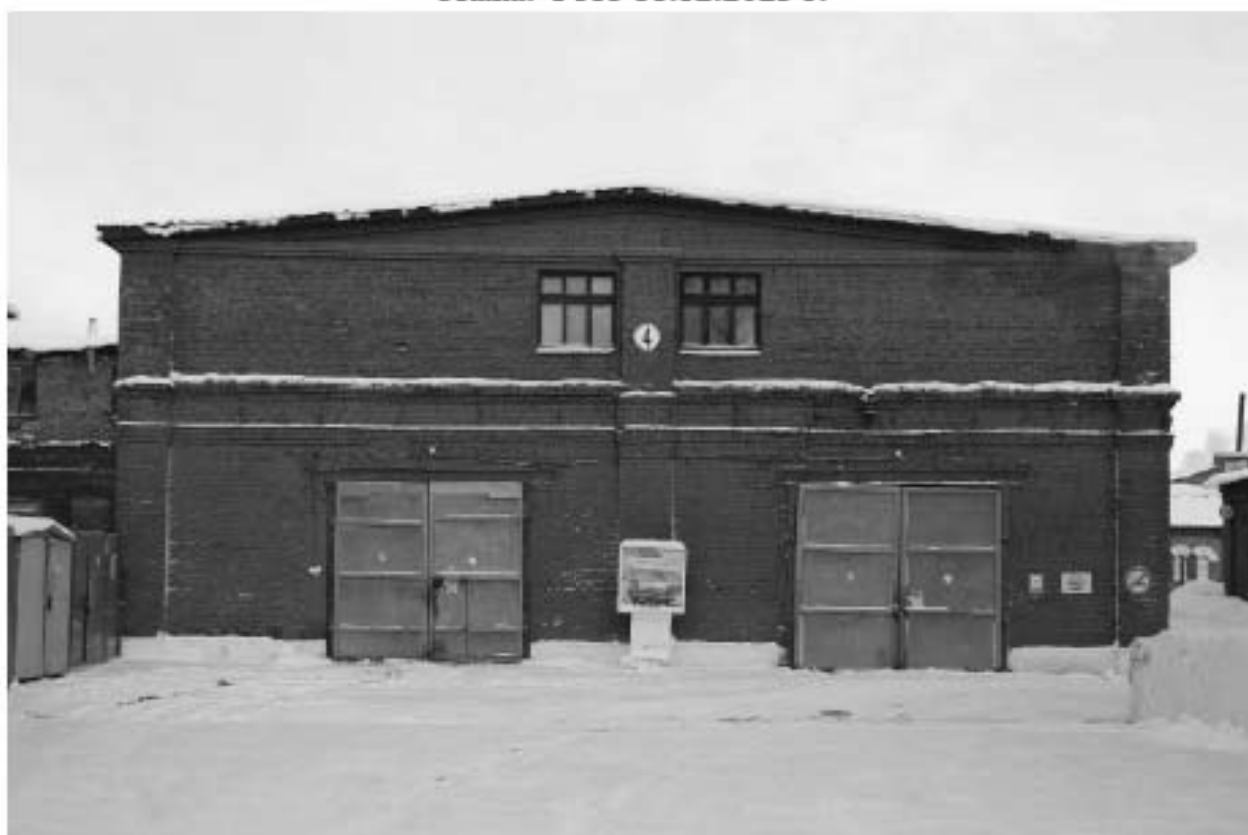
Фото 197. Выявленный объект культурного наследия «Манеж с конюшнями». Вид на южный фасад восточного Т-образного объема конюшен. Фото 11.12.2023 г.
