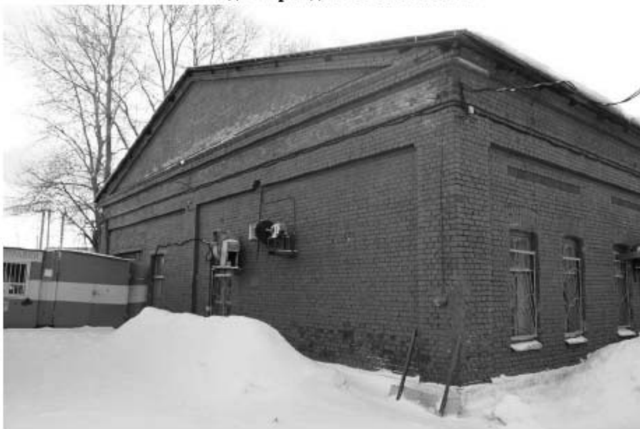
Фото 301. Выявленный объект культурного наследия «Конский» лазарет». Вид на северный фасад. Фото 11.12.2023 г.
