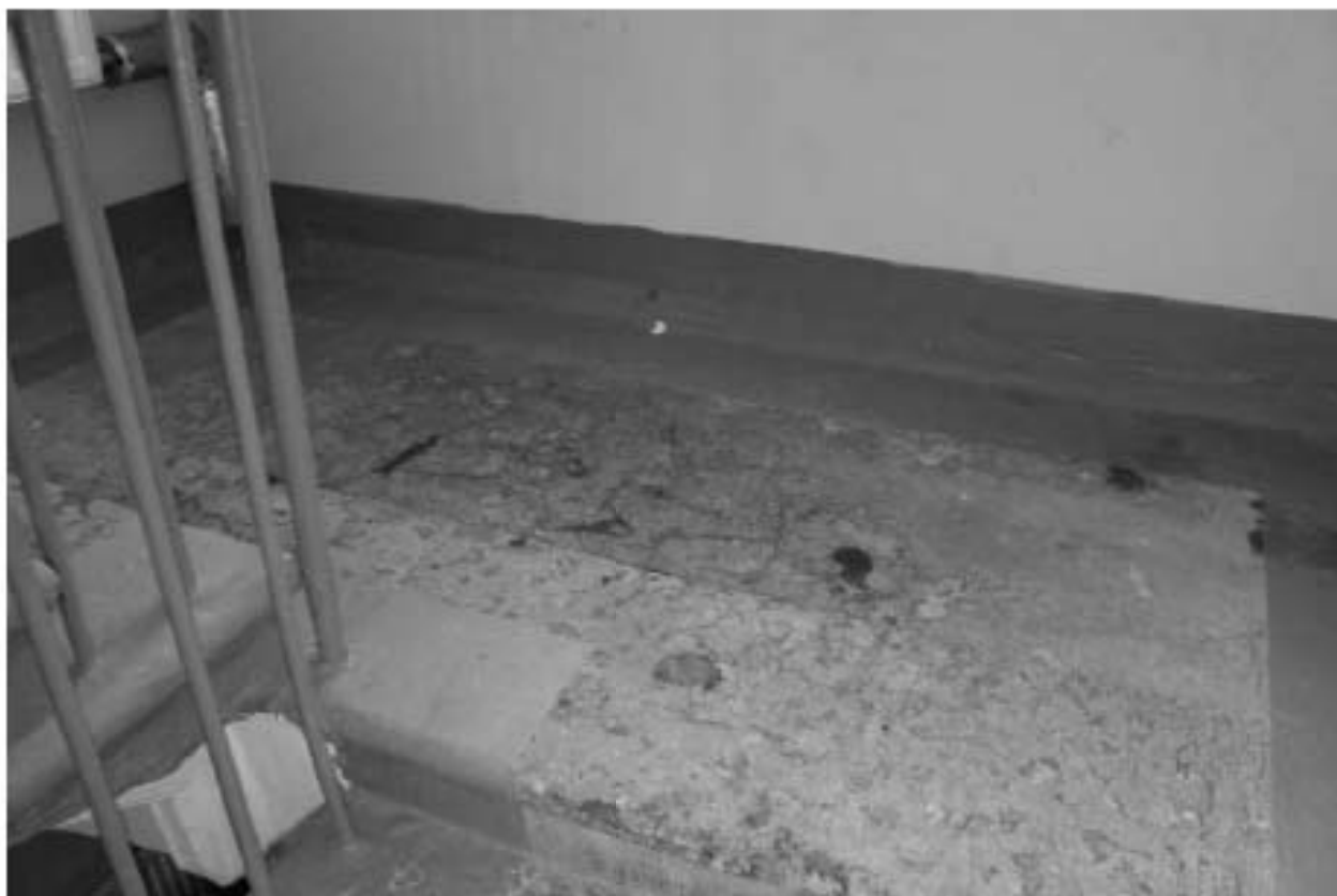
Фото 121. Выявленный объект культурного наследия «Казармы со службой». Казармы. Вид на интерьер 2ЛК в уровне 1-го – 2-го этажей. Фото 11.12.2023 г.
