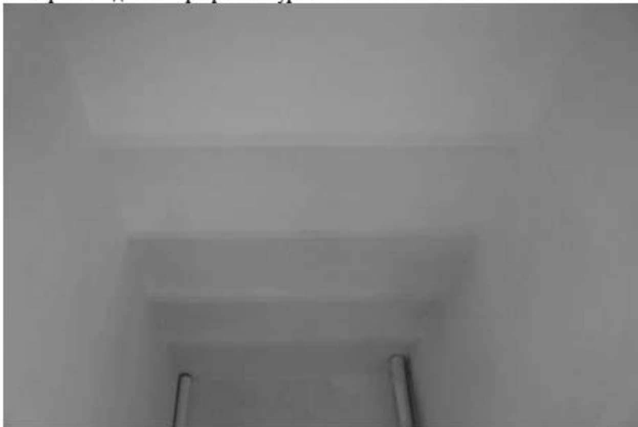
Фото 105. Выявленный объект культурного наследия «Казармы со службой». Казармы. Вид на интерьер 1ЛК в уровне 3-го этажа. Фото 11.12.2023 г.
