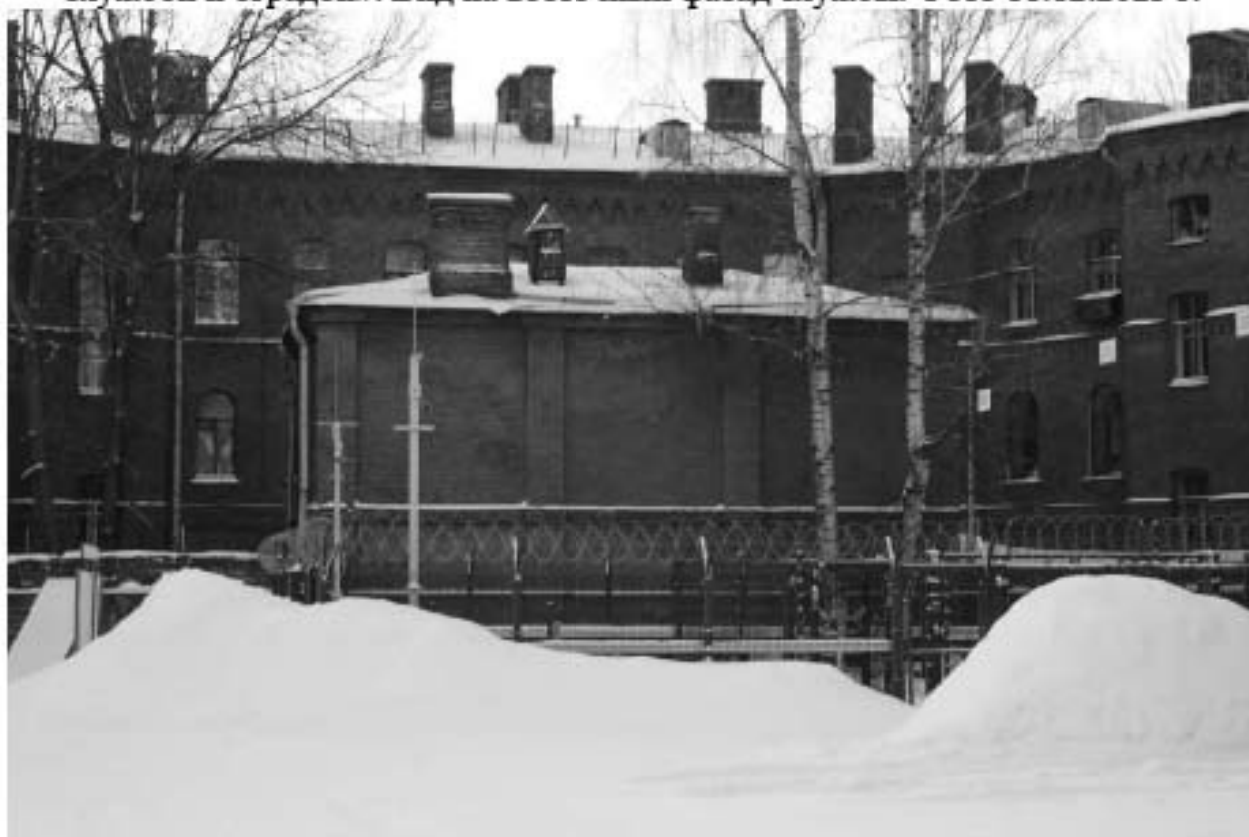
Фото 74. Выявленный объект культурного наследия «Жилой офицерский дом со службой и оградой». Вид на северный фасад службы. Фото 11.12.2023 г.
