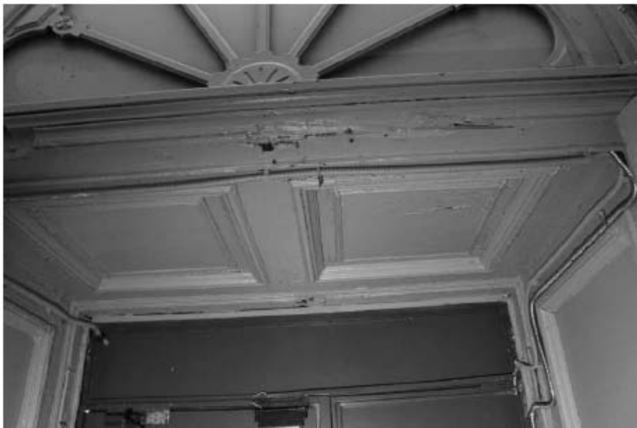
Фото 52. Выявленный объект культурного наследия «Жилой офицерский дом со службой и оградой». Жилой офицерский дом. Вид на интерьер 4ЛК в уровне 1-го этажа. Фото 11.12.2023 г.
