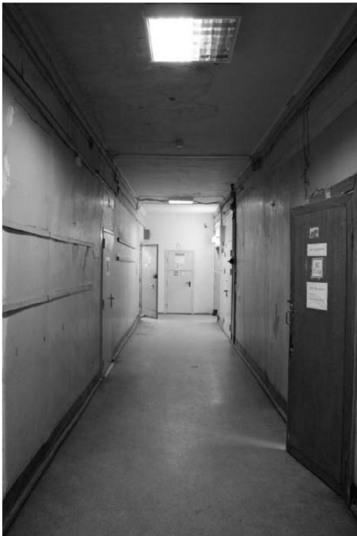
Фото 272. Выявленный объект культурного наследия «Манеж с конюшнями». Центральный и западный Т-образный объемы конюшен. Интерьер внутренних помещений 2-го этажа. Фото 11.12.2023 г.
