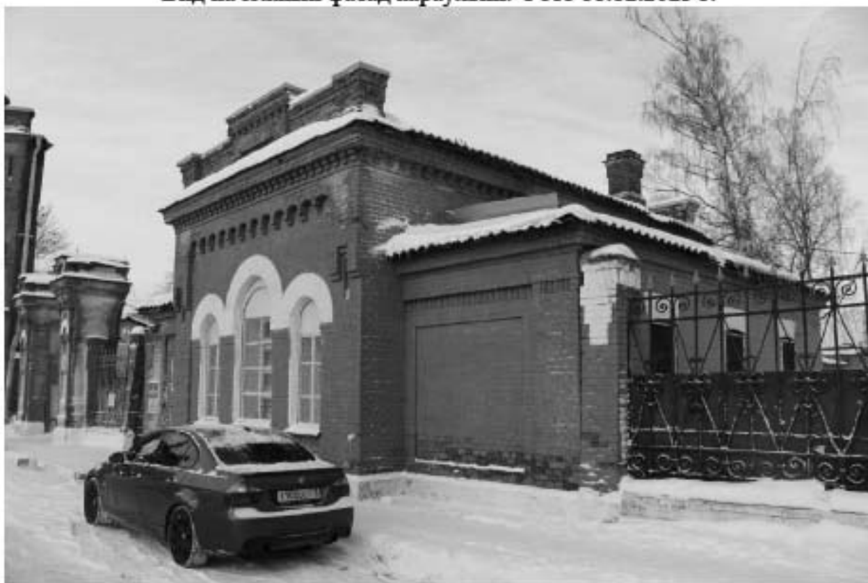
Фото 150. Выявленный объект культурного наследия «Караульня с оградой». Вид на южный фасад караульни. Фото 11.12.2023 г.
