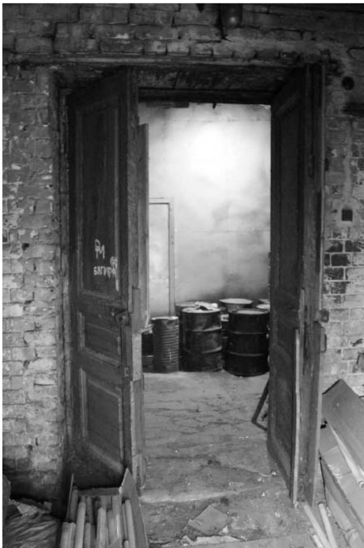
Фото 314. Выявленный объект культурного наследия «Фуражные саран». Интерьер внутренних помещений 1-го этажа. Фото 11.12.2023 г.
