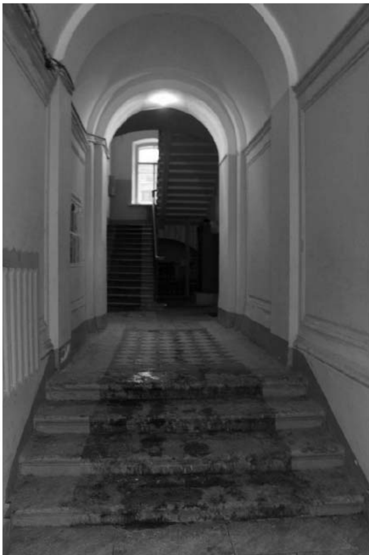
Фото 40. Выявленный объект культурного наследия «Жилой офицерский дом со службой и оградой». Жилой офицерский дом. Вид на интерьер 2ЛК в уровне 1-го этажа. Фото 11.12.2023 г.
