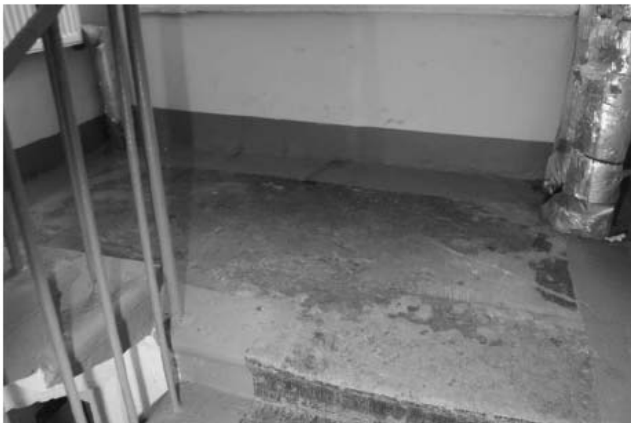
Фото 100. Выявленный объект культурного наследия «Казармы со службой». Казармы. Вид на интерьер 1ЛК в уровне 1-го – 2-го этажей. Фото 11.12.2023 г.
