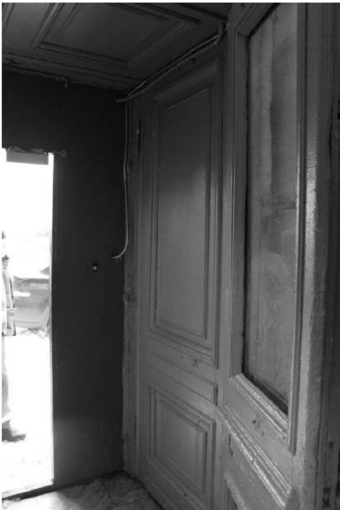
Фото 17. Выявленный объект культурного наследия «Жилой офицерский дом со службой и оградой». Жилой офицерский дом. Вид на интерьер 1ЛК в уровне 1-го этажа. Фото 11.12.2023 г.
