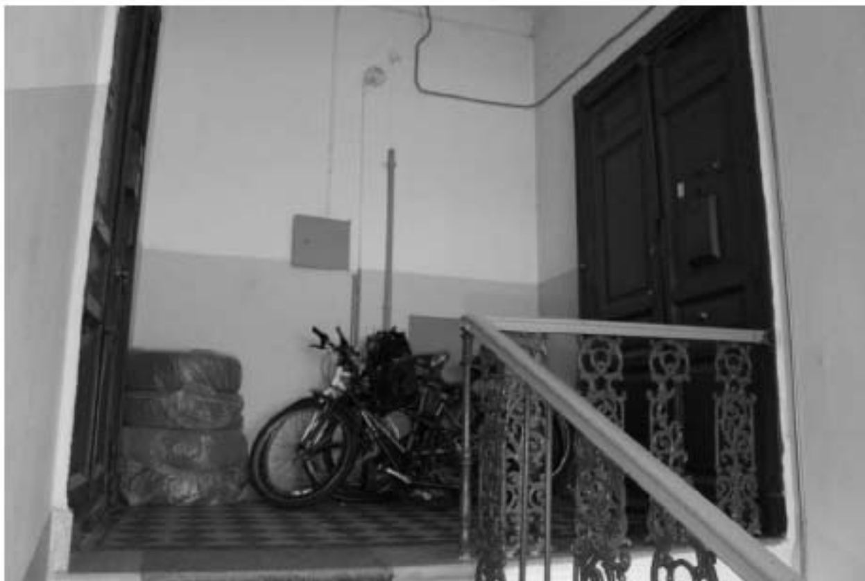
Фото 49. Выявленный объект культурного наследия «Жилой офицерский дом со службой и оградой». Жилой офицерский дом. Вид на интерьер 2ЛК в уровне 3-го этажа. Фото 11.12.2023 г.
