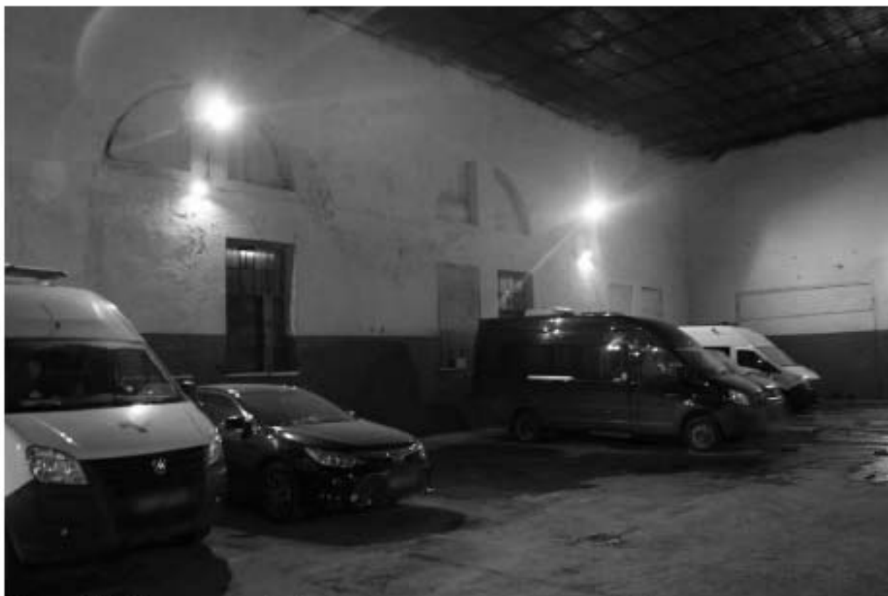
Фото 184. Выявленный объект культурного наследия «Манеж с конюшнями». Манеж. Интерьер внутренних помещений. Фото 11.12.2023 г.
