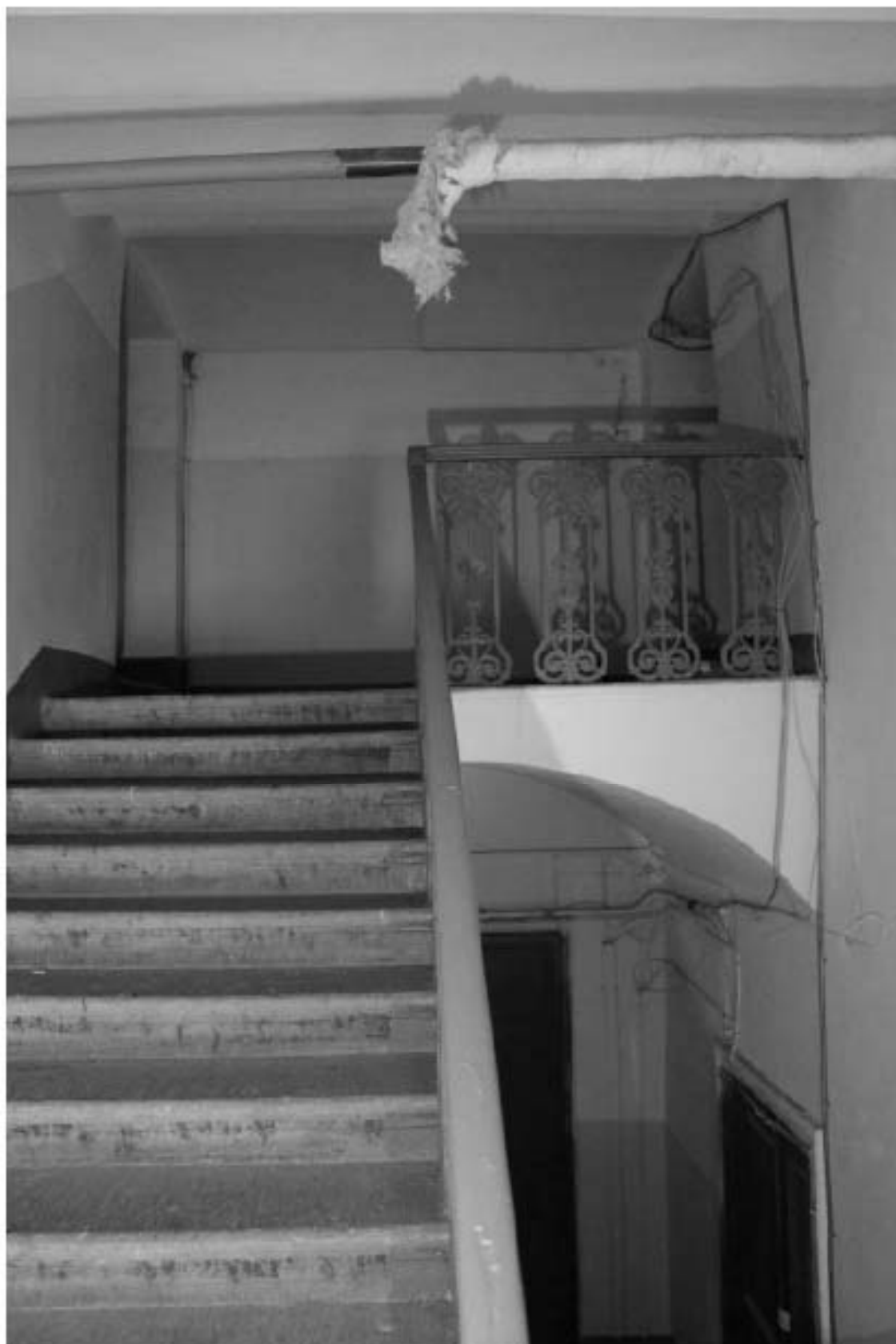
Фото 37. Выявленный объект культурного наследия «Жилой офицерский дом со службой и оградой». Жилой офицерский дом. Вид на интерьер 1ЛК в уровне чердачного этажа. Фото 11.12.2023 г.
