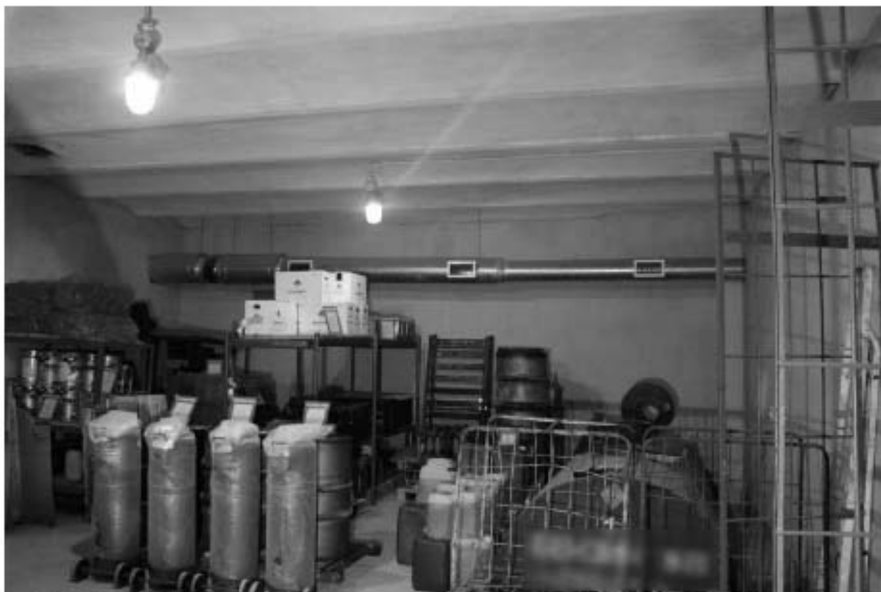
Фото 334. Выявленный объект культурного наследия «Кузница». Интерьер внутренних помещений. Фото 11.12.2023 г.
