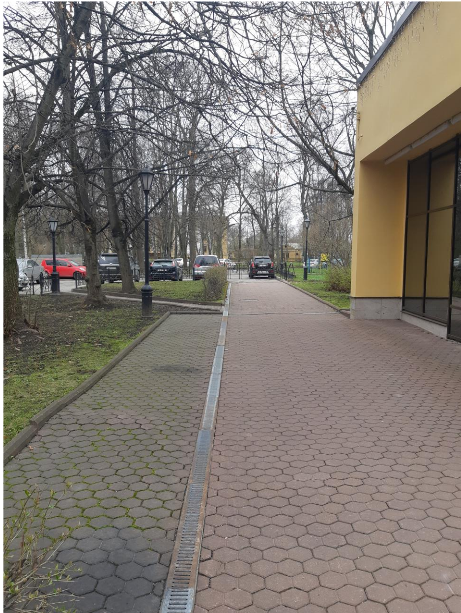
14. Фото. Фрагмент дворового фасада и тротуар и ливневая система Дата съемки: 03.04.2024 г.
