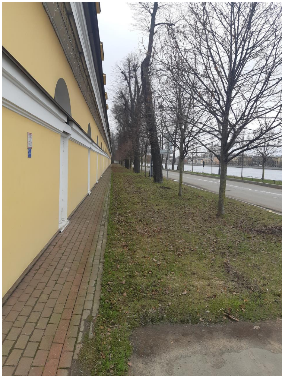
5. Фото. Лицевой фасад, отмостка и газон. Общий вид. Дата съемки: 03.04.2024 г.
