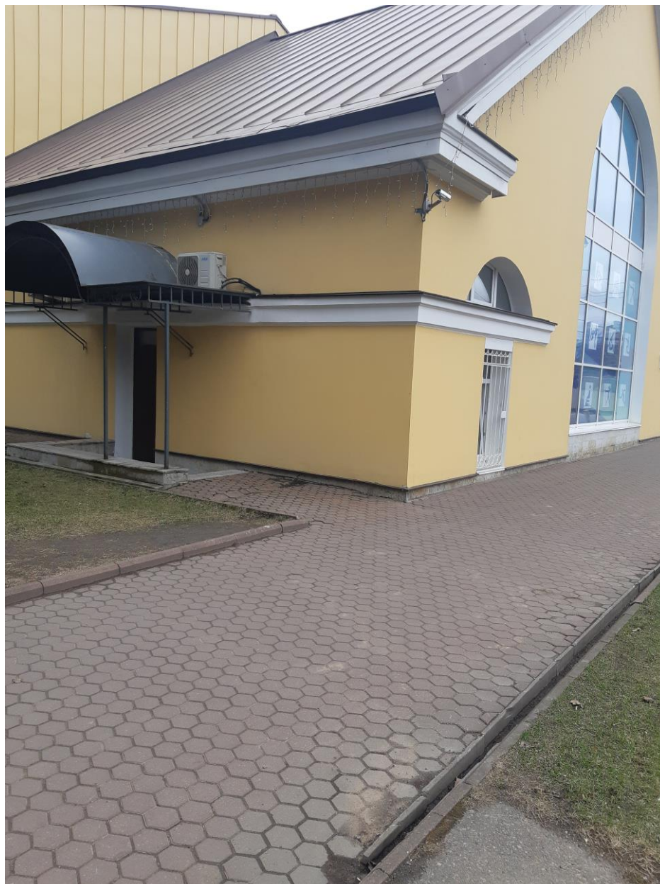
2. Фото. Фрагмент дворового и торцевого (юго-восточный) фасада и фрагмент тротуара. Дата съемки: 03.04.2024 г.
