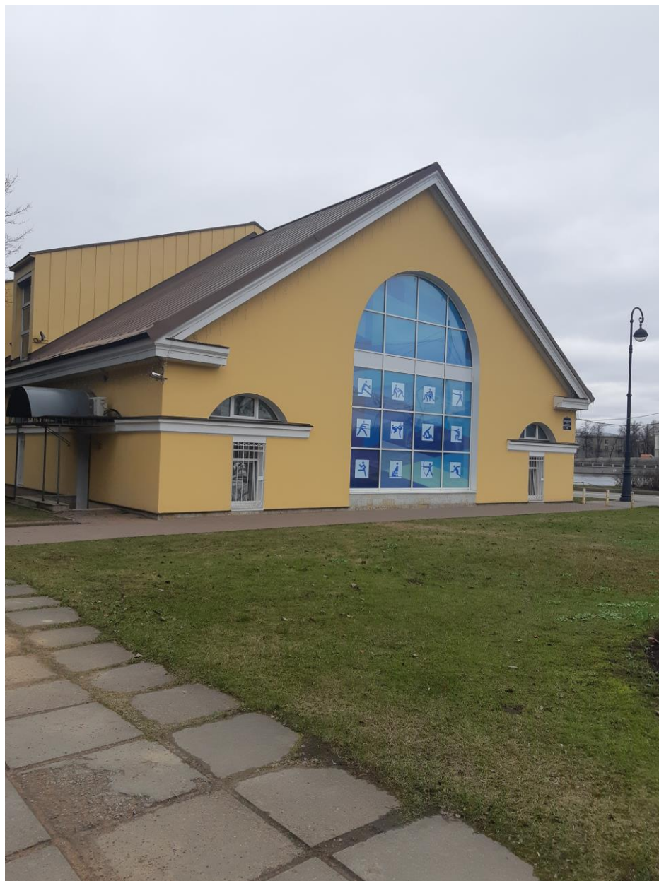
3. Фото. Торцевой (юго-восточный) фасад. Общий вид. Дата съемки: 03.04.2024 г.
