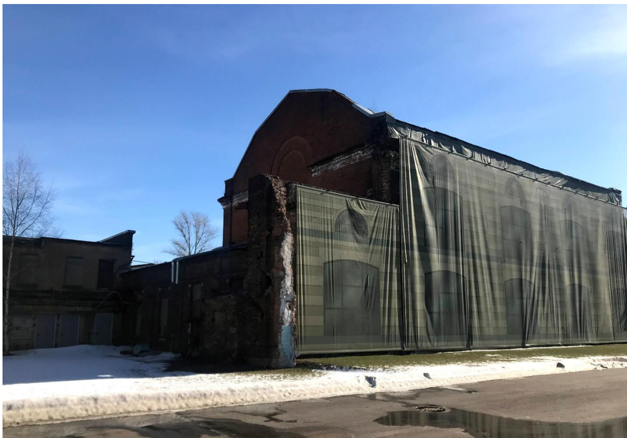
Фото 7. Вид на пристройки поздние с северо-запада.
