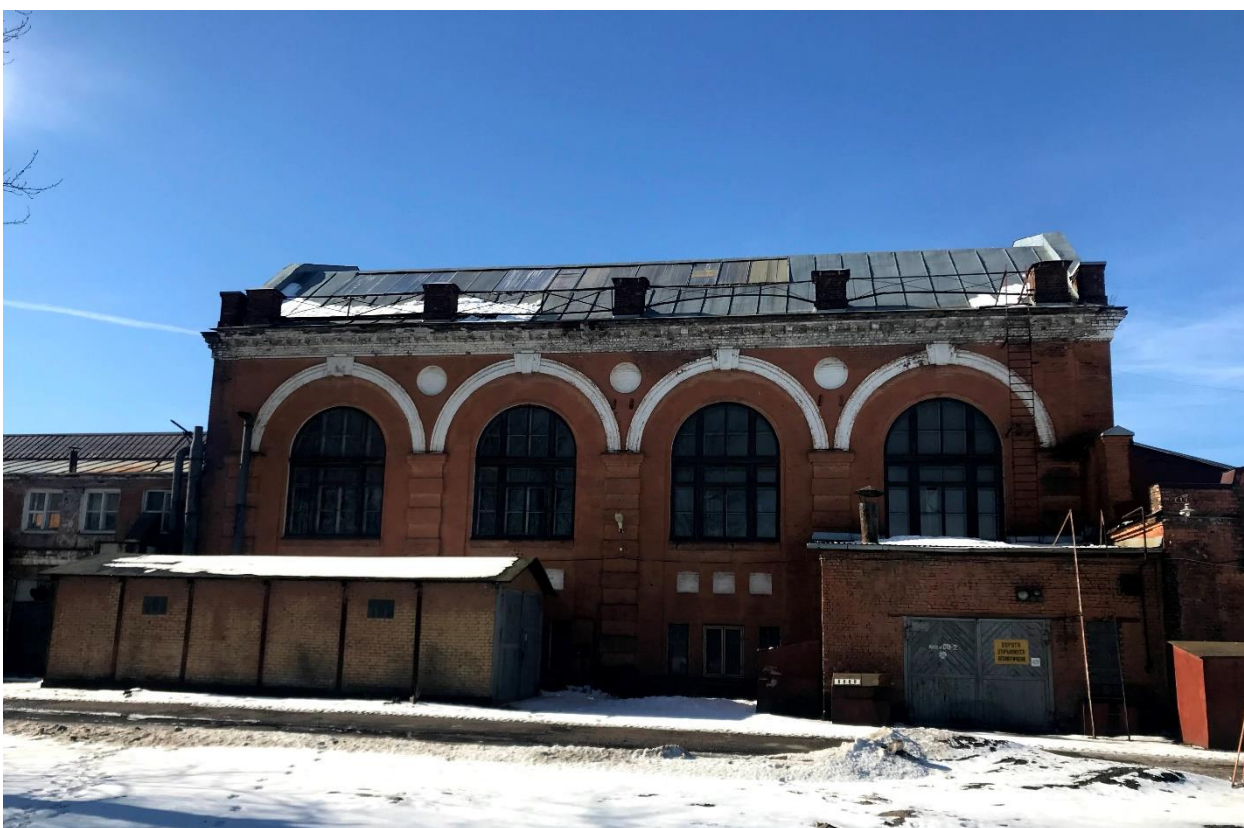
Фото 10. Северная часть здание по адресу: Санкт-Петербург, проспект Обуховской Обороны, дом 120, литера Щ
