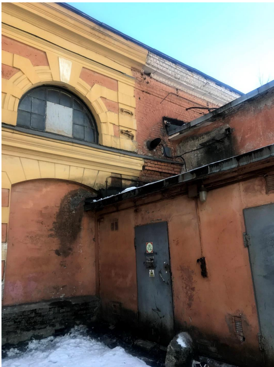
Фото 4. Место примыкания поздних пристроек к историческому объему здания – объекта культурного наследия регионального значения «Главная электрическая станция Обуховского сталелитейного завода»
