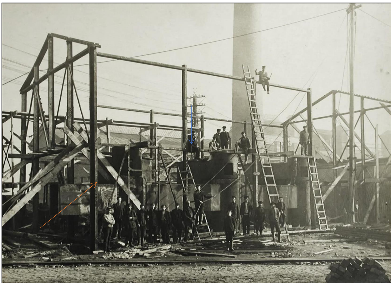
Илл. 7. Строительство легкого складского корпуса позади здания Главной электростанции Обуховского сталелитейного завода. Фото 1909-1913 гг.
