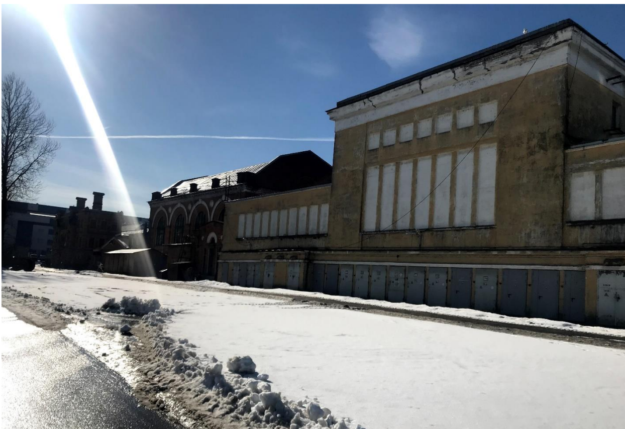
Фото 9. Северная часть здание по адресу: Санкт-Петербург, проспект Обуховской Обороны, дом 120, литера Щ
