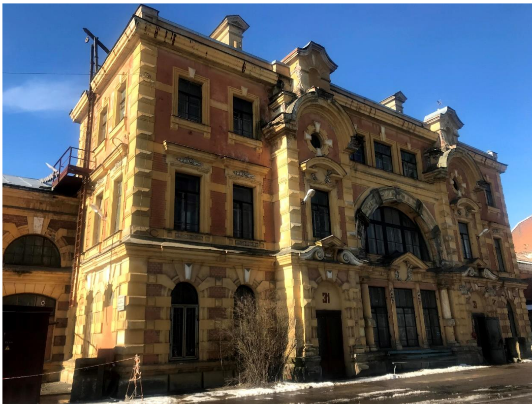
Фото 1. Лицевой фасад объекта культурного наследия регионального значения «Главная электрическая станция Обуховского сталелитейного завода»
