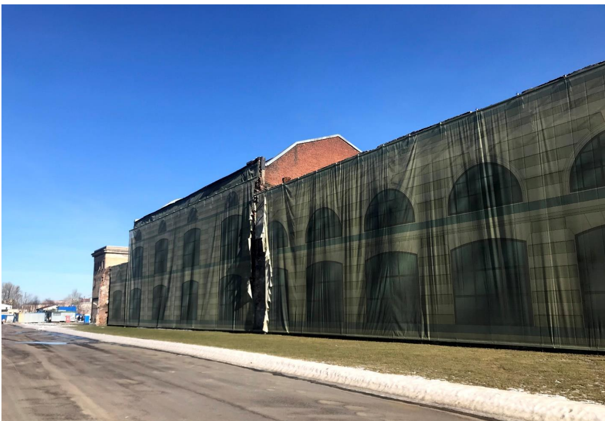
Фото 6. Западные фасады поздних пристроек.
