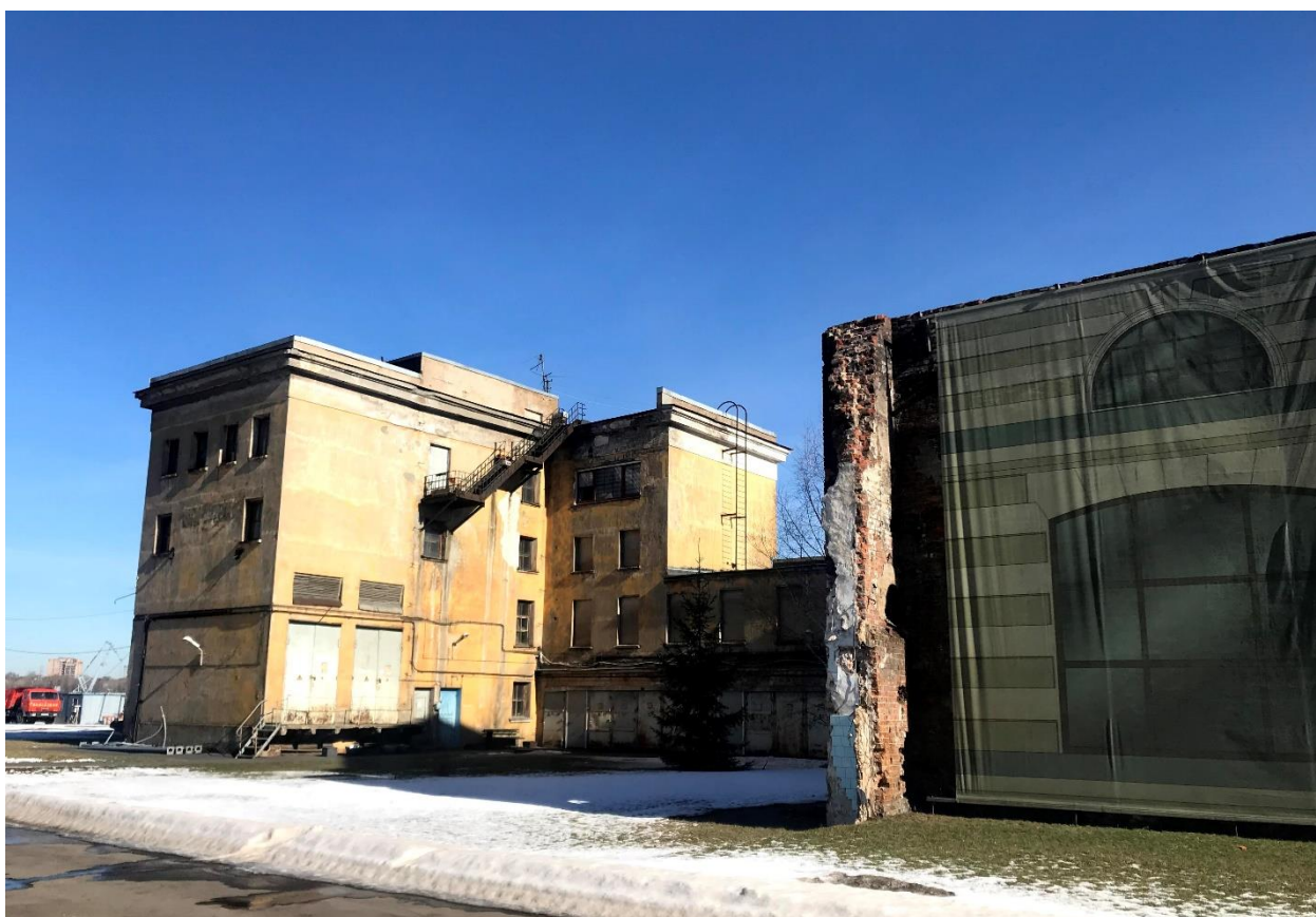
Фото 8. Северная часть здание по адресу: Санкт-Петербург, проспект Обуховской Обороны, дом 120, литера Щ
