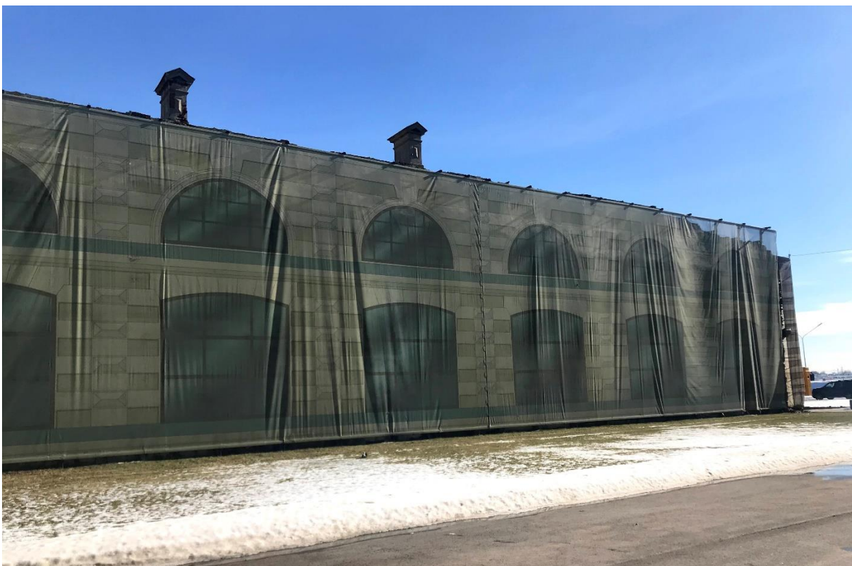
Фото 5. Западный фасад объекта культурного наследия регионального значения «Главная электрическая станция Обуховского сталелитейного завода»
