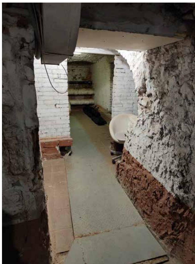
Фото 22 Интерьер помещения 3-Н объекта культурного наследия регионального значения «Дом С.П.Неклюдова»
