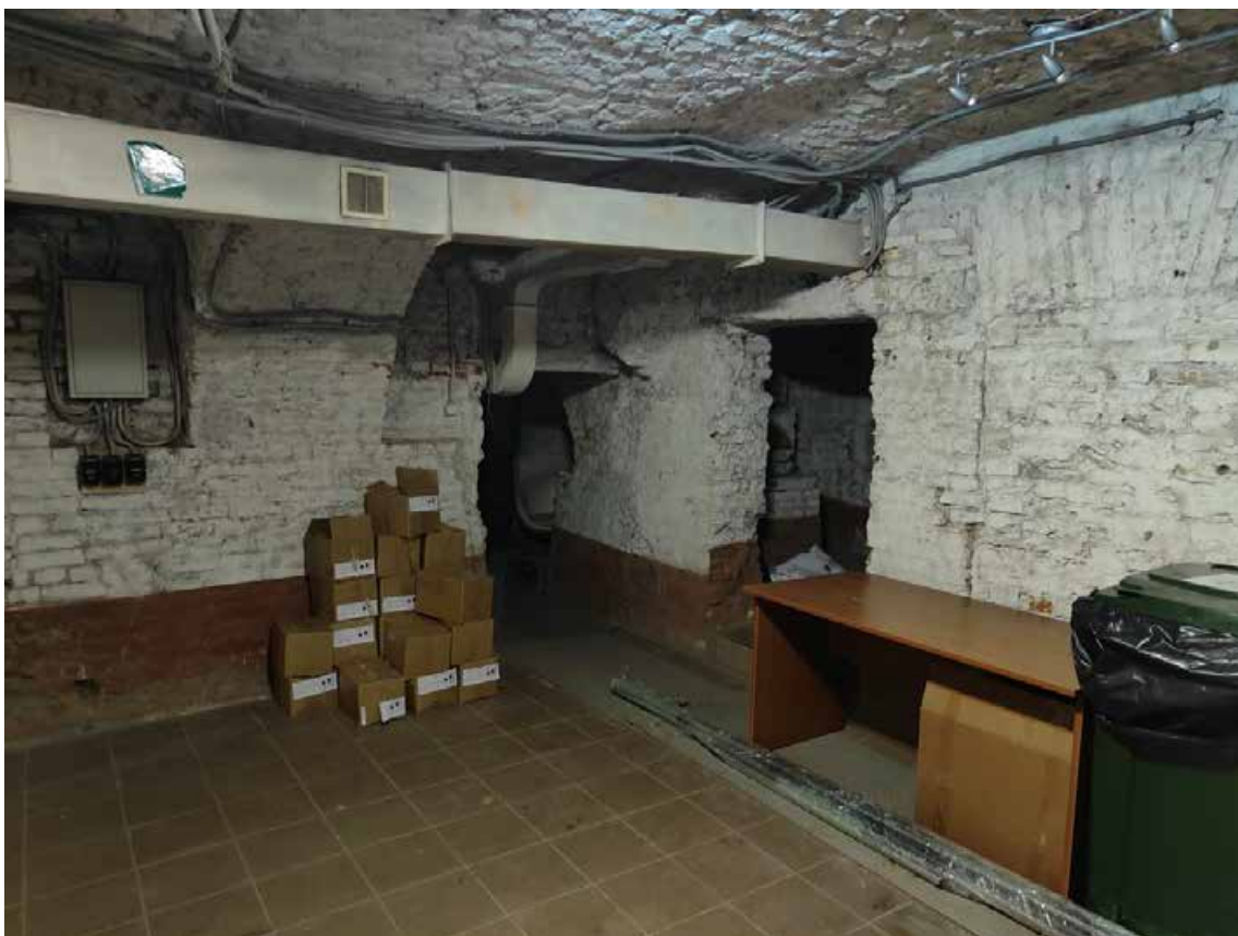
Фото 21 Интерьер помещения 3-Н объекта культурного наследия регионального значения «Дом С.П.Неклюдова»
