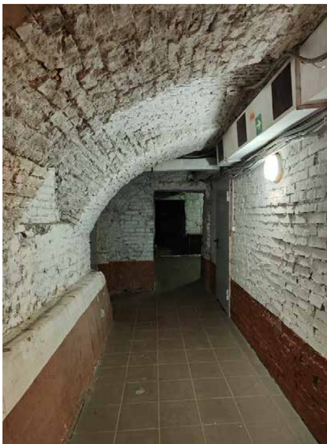
Фото 16 Интерьер помещения 3-Н объекта культурного наследия регионального значения «Дом С.П.Неклюдова»
