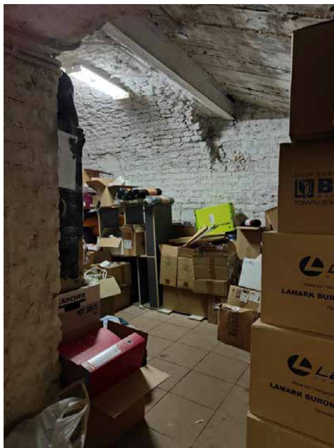
Фото 12 Интерьер помещения 3-Н объекта культурного наследия регионального значения «Дом С.П.Неклюдова»
