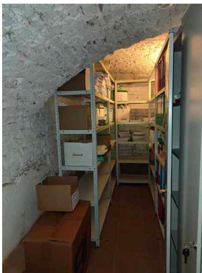
Фото 24 Интерьер помещения 3-Н объекта культурного наследия регионального значения «Дом С.П.Неклюдова»
