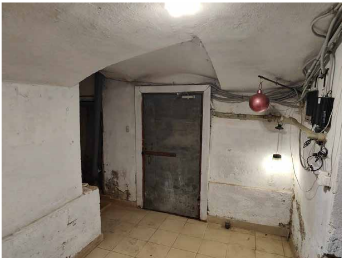
Фото 7 Интерьер помещения 3-Н объекта культурного наследия регионального значения «Дом С.П.Неклюдова»
