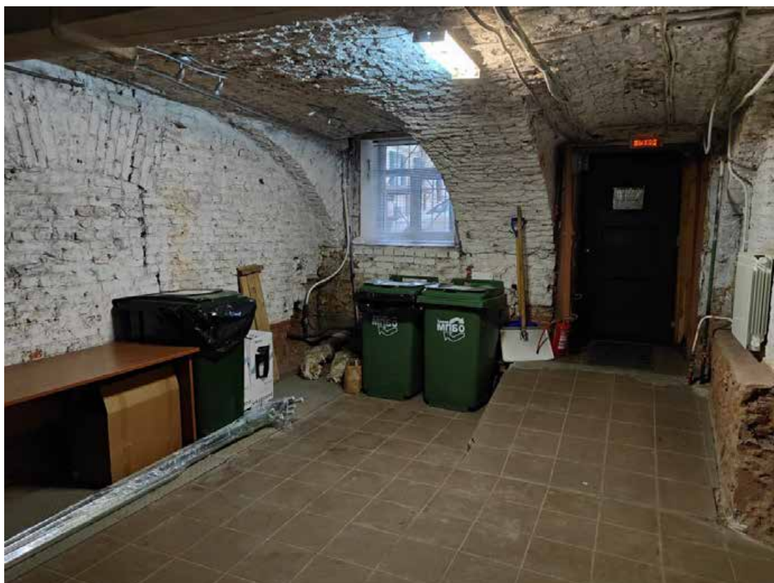
Фото 20 Интерьер помещения 3-Н объекта культурного наследия регионального значения «Дом С.П.Неклюдова»
