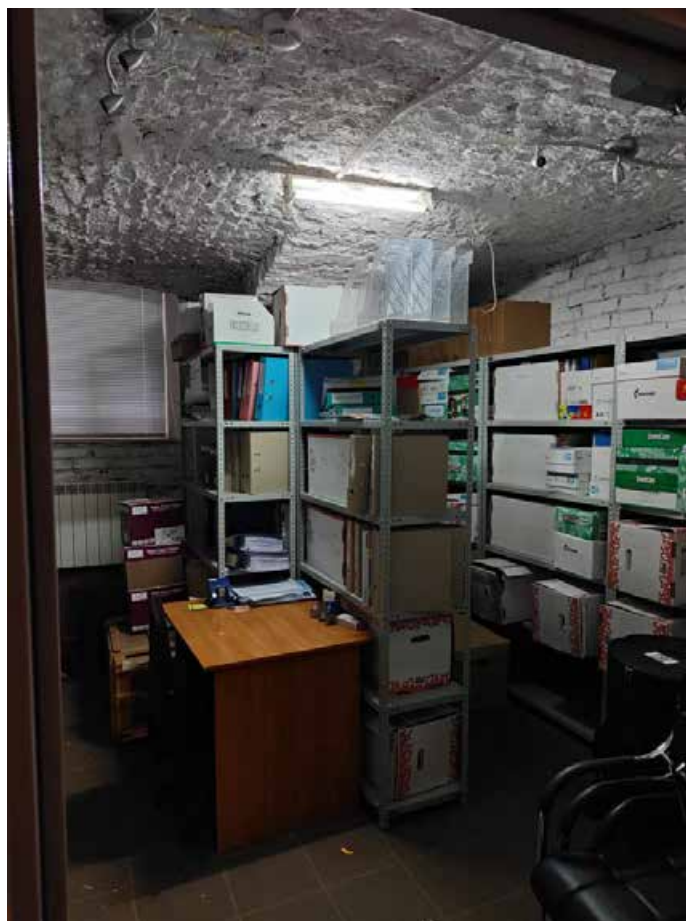
Фото 19 Интерьер помещения 3-Н объекта культурного наследия регионального значения «Дом С.П.Неклюдова»
