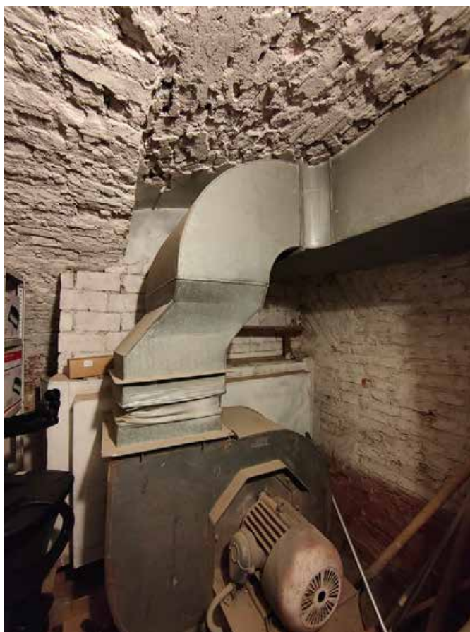
Фото 14 Интерьер помещения 3-Н объекта культурного наследия регионального значения «Дом С.П.Неклюдова»
