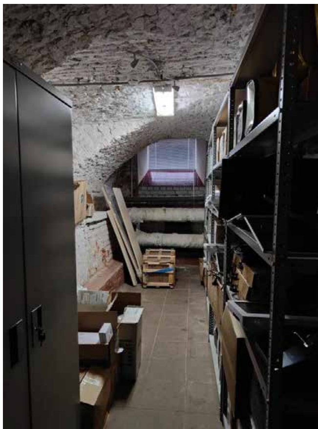
Фото 17 Интерьер помещения 3-Н объекта культурного наследия регионального значения «Дом С.П.Неклюдова»
