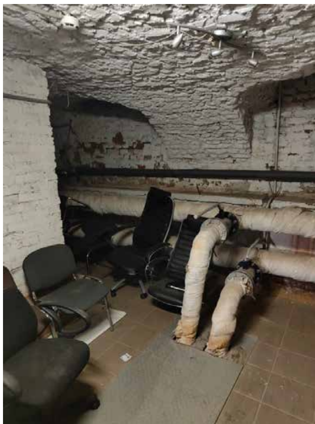
Фото 23 Интерьер помещения 3-Н объекта культурного наследия регионального значения «Дом С.П.Неклюдова»
