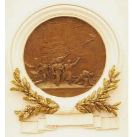
18 литых круглых шпιαтровых, тонированных под бронзу вентиляционных решеток, расположенных на пилонах, оформление – профилированная круглая рама с лентами в нижней части и бронзированными ветвями; решетка из двух окружностей – внутри меньше расположены радиально расходящиеся от пятиконечной звезды стержни-лучи, между меньшей и большей расположены пальметты;
