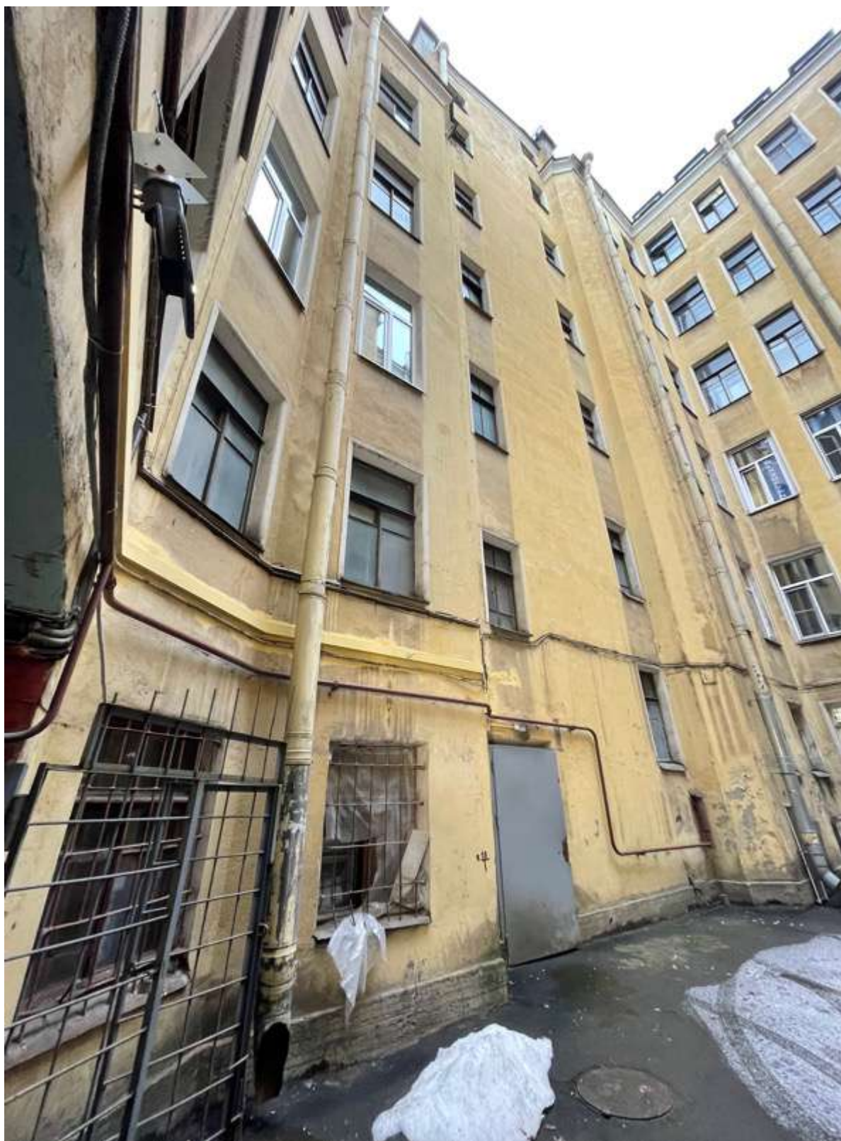
11. Фрагмент дворового фасада
