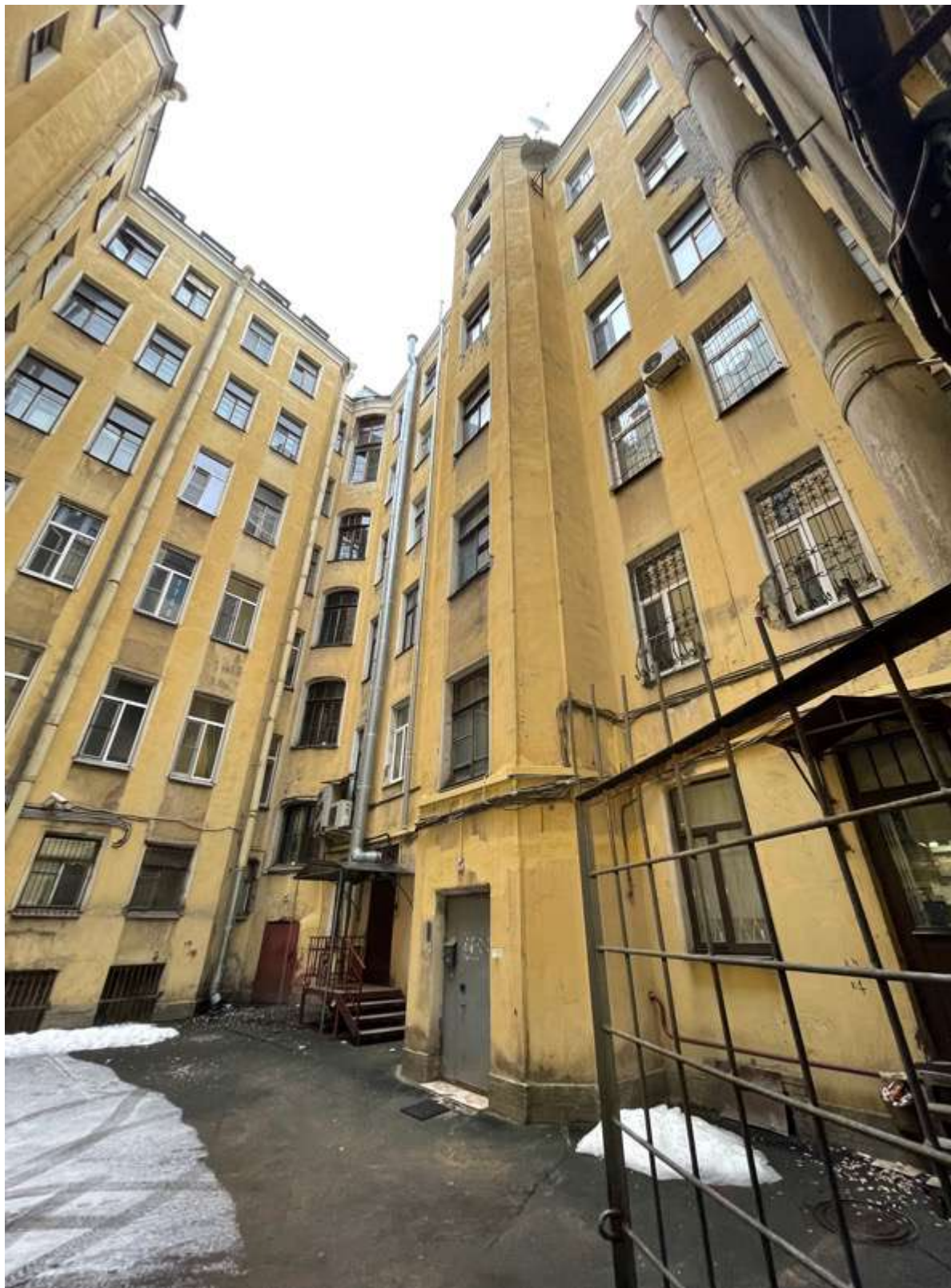
12. Фрагмент дворового фасада
