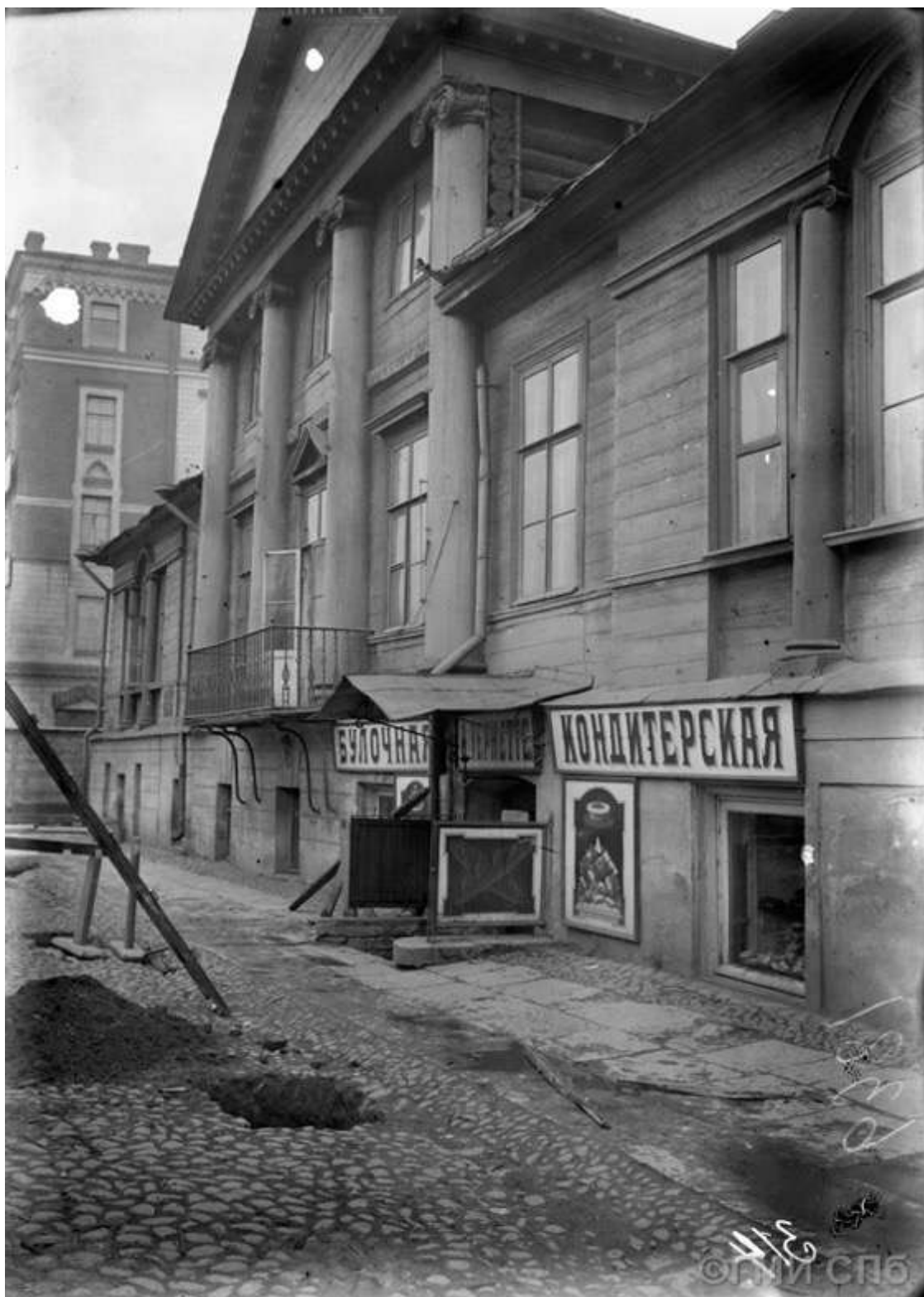
70. Дом на Загородном проспекте. Фрагмент фасада с вывесками "Булочная" и "Кондитерская". До 1907 г. Санкт-Петербургское государственное бюджетное учреждение культуры "Государственный музей истории Санкт-Петербурга". Номер в Госкаталоге: 12090021. Номер по КП (ГИК): ГМИ СПб 221038. Инвентарный номер: ГМИ СПб Инв.№-II-A110н
