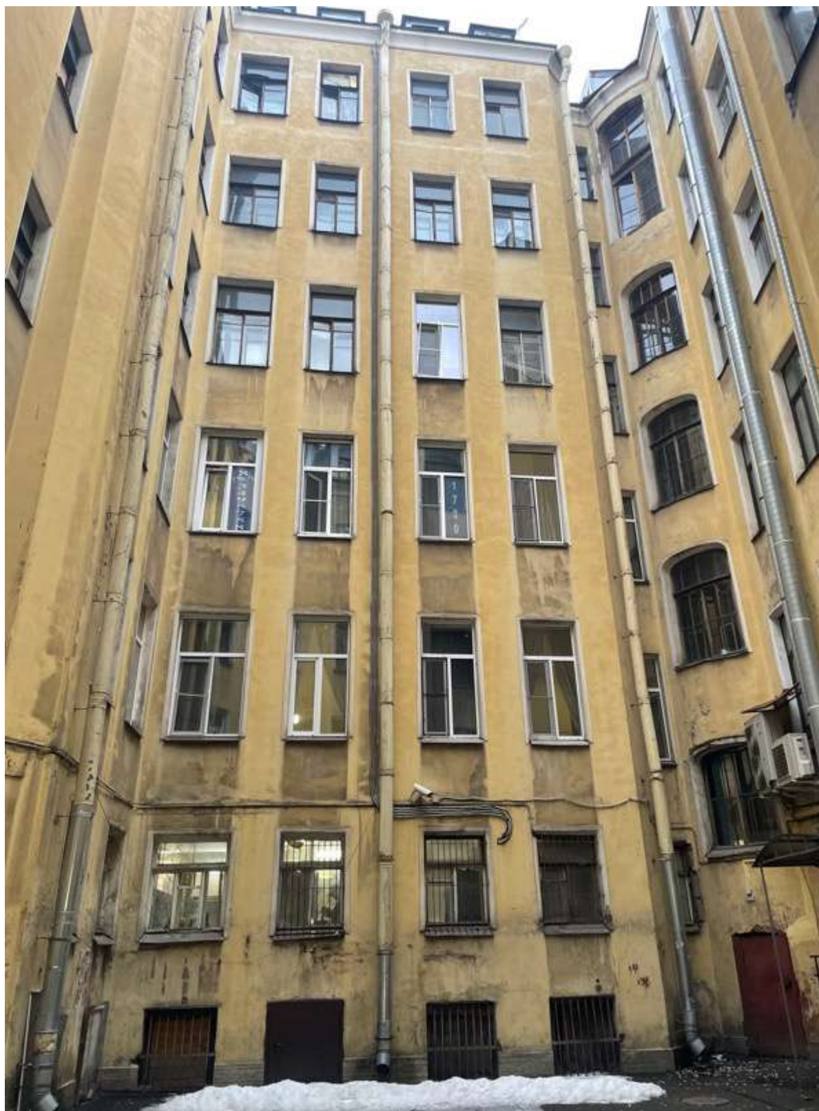
10. Фрагмент дворового фасада
