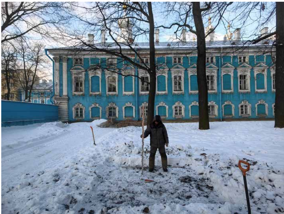
Рис. 108. СПб-2024. Смольный пр., д. 1. НВ. Местоположение шурфа 6, вид на запад.
