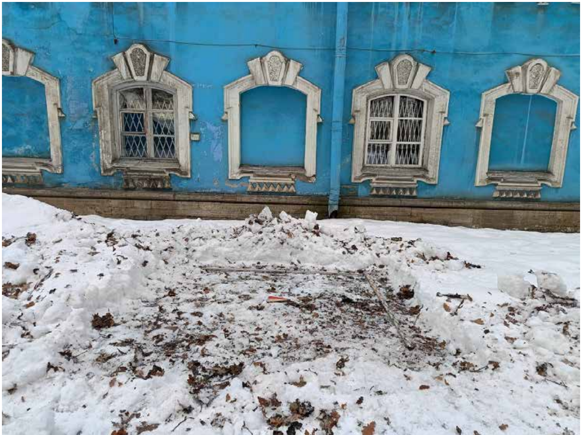
Рис. 91. СПб-2024. Смольный пр., д. 1. НВ. Местоположение шурфа 5, вид на запад.
