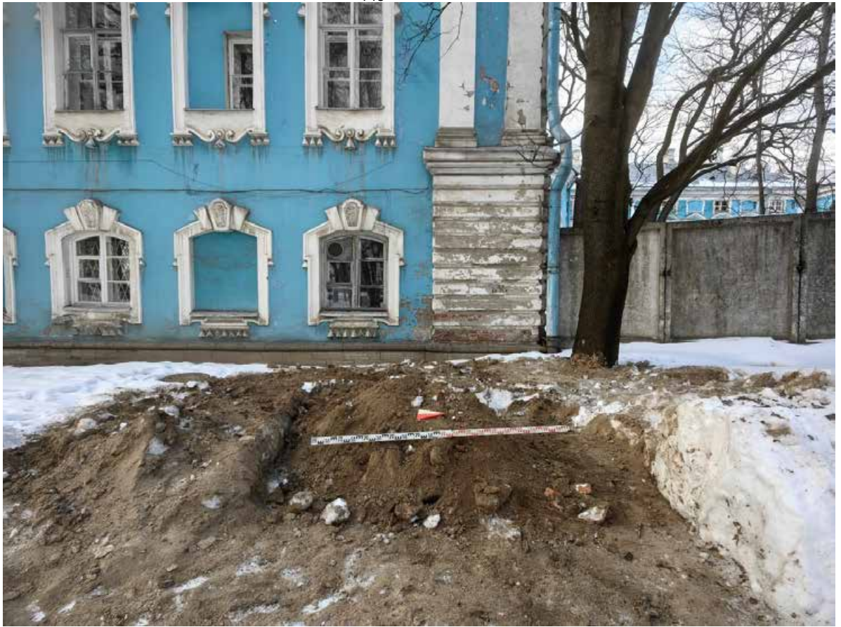
Рис. 90. СПб-2024. Смольный пр., д. 1. НВ. Шурф 4 после рекультивации, вид на запад.
