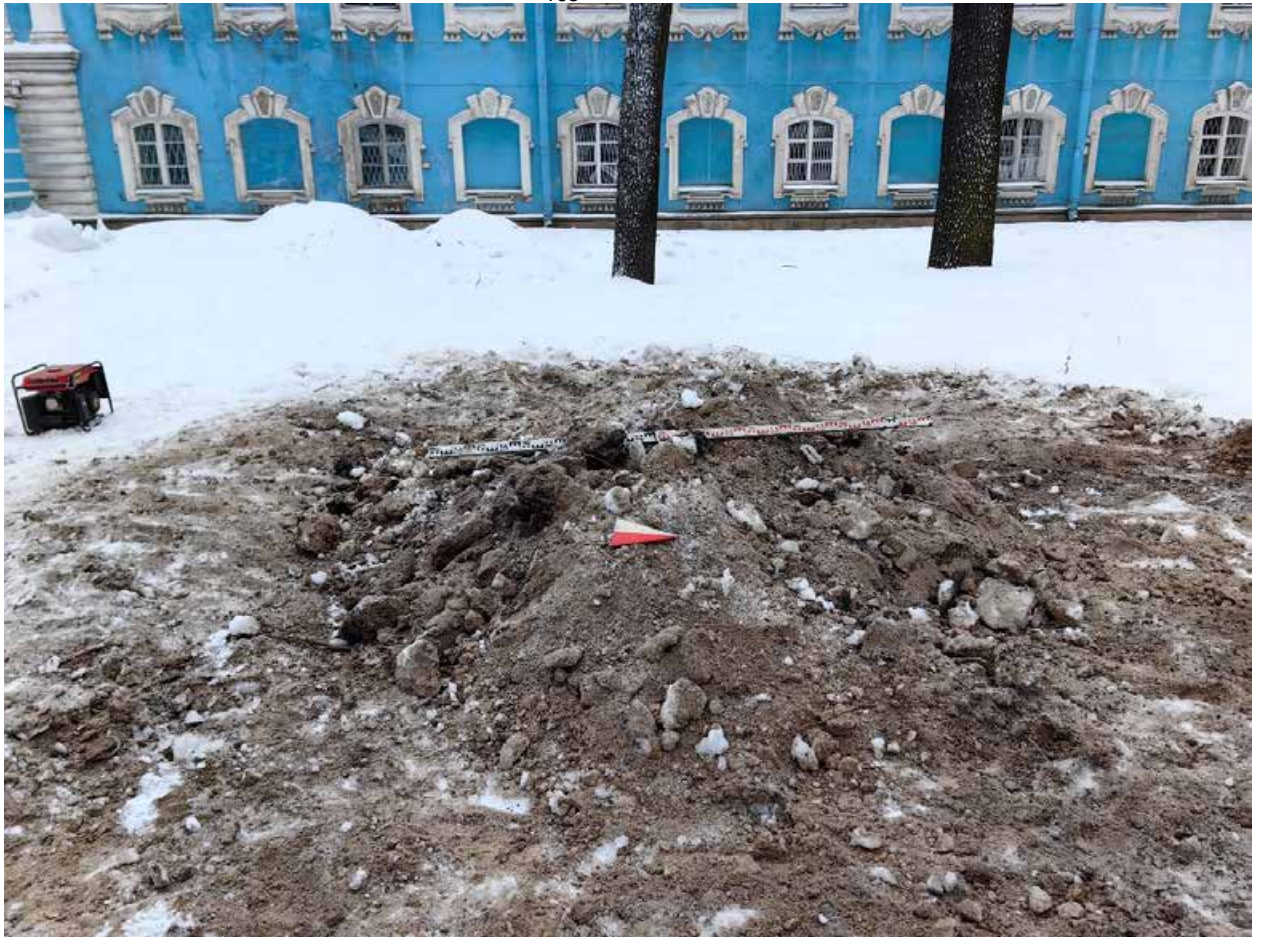
Рис. 118. СПб-2024. Смольный пр., д. 1. НВ. Шурф 6 после рекультивации, вид на запад.
