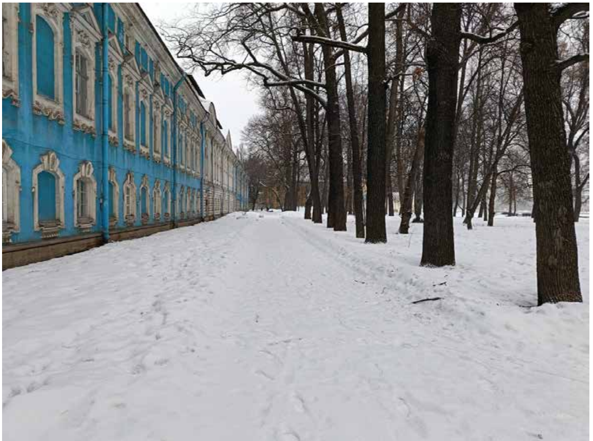
Рис. 30. СПб-2024. Смольный пр., д. 1. НВ. Точка фотофиксации 6, вид на север.
