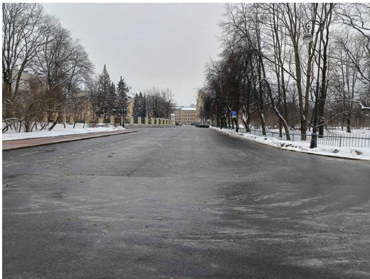
Рис. 34. СПб-2024. Смольный пр., д. 1. НВ. Точка фотофиксации 9, вид на юг.
