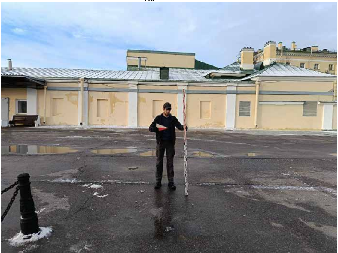
Рис. 15. СПб-2024. Смольный пр., д. 1. НВ. Точка фотофиксации 1, вид на запад.
