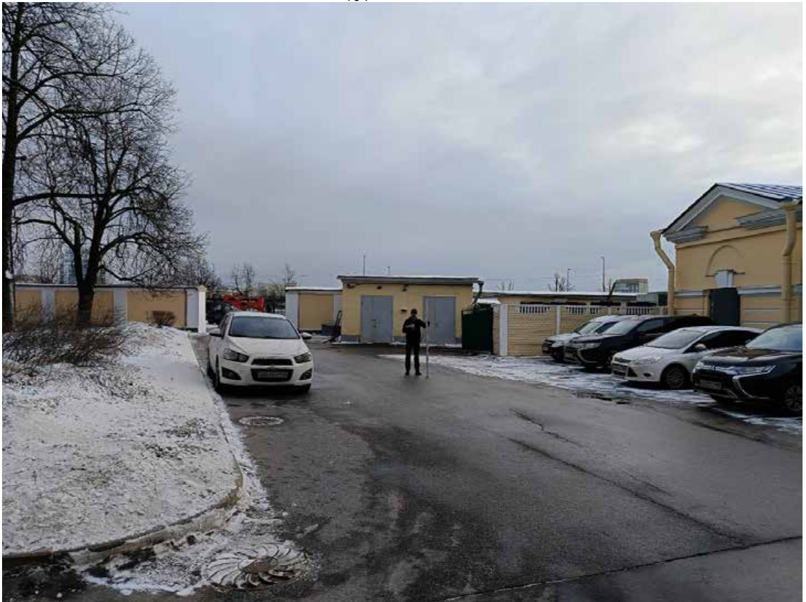
Рис. 13. СПб-2024. Смольный пр., д. 1. НВ. Точка фотофиксации 1, вид на восток.
