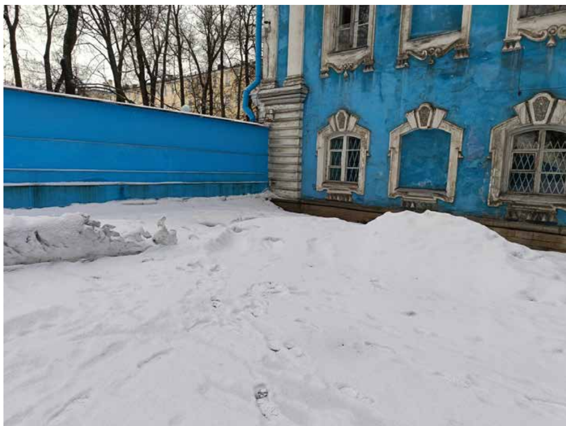
Рис. 28. СПб-2024. Смольный пр., д. 1. НВ. Точка фотофиксации 6, вид на юго-запад.
