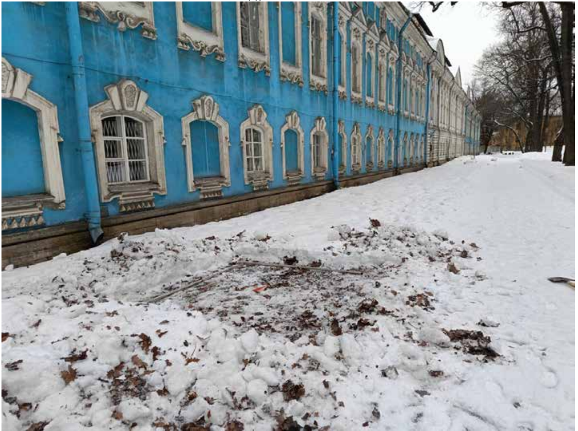
Рис. 92. СПб-2024. Смольный пр., д. 1. НВ. Местоположение шурфа 5, вид на северо-запад.
