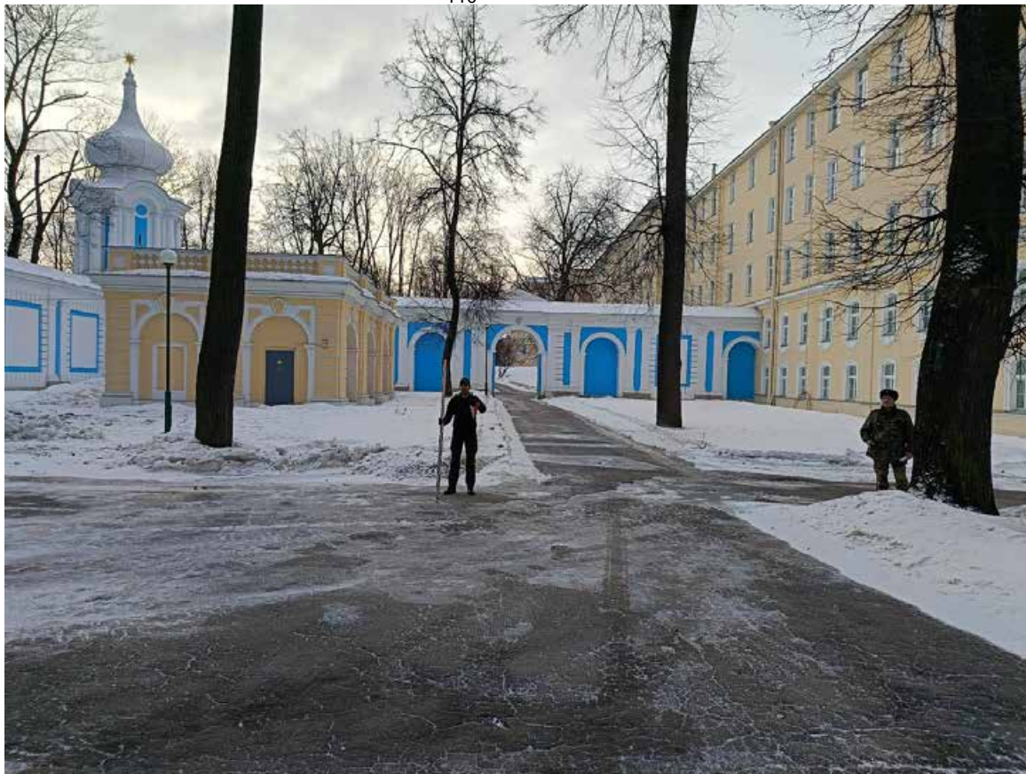
Рис. 25 СПб-2024. Смольный пр., д. 1. НВ. Точка фотофиксации 5, вид на юг.
