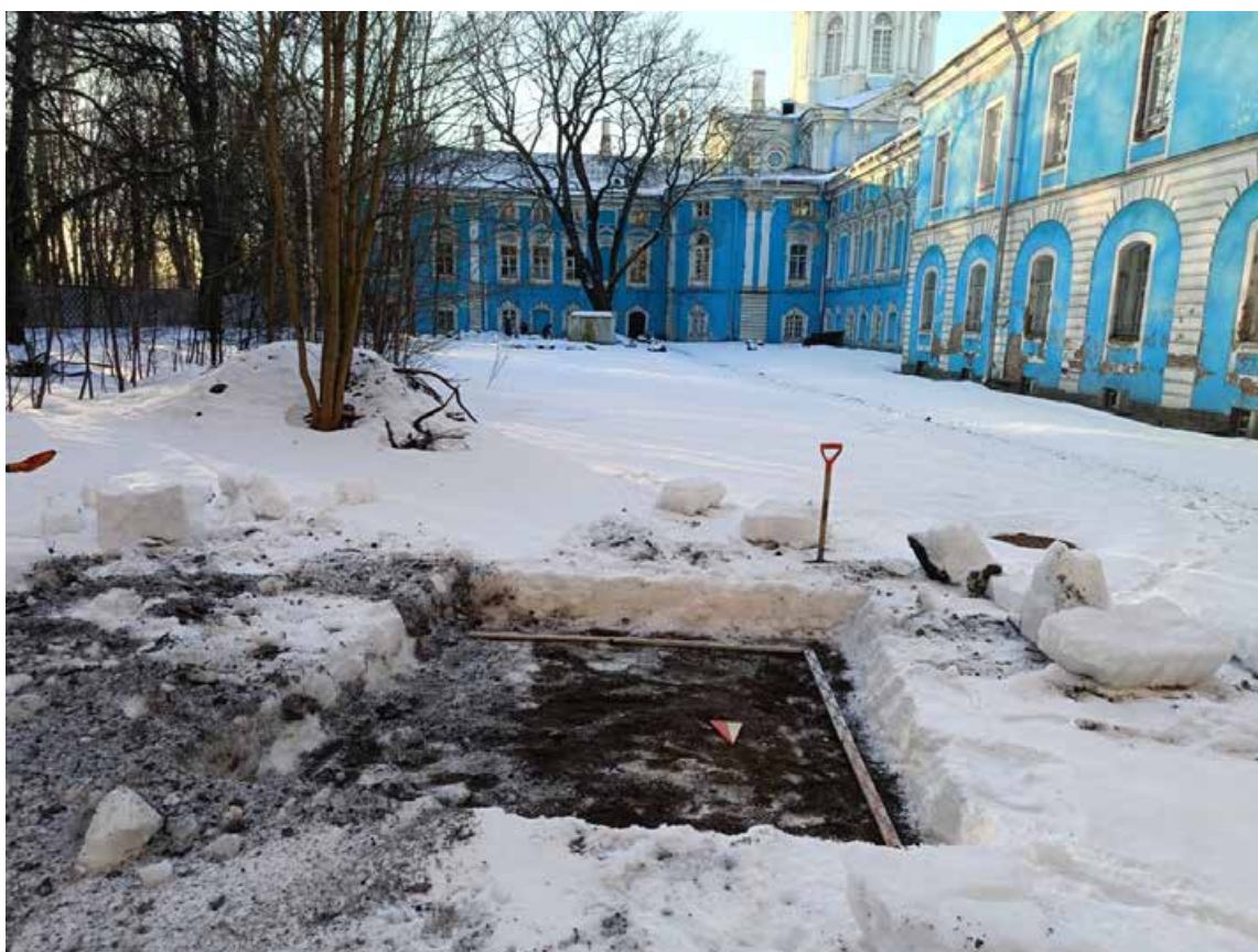
Рис. 38. СПб-2024. Смольный пр., д. 1. НВ. Местоположение шурфа 1, вид на юг.
