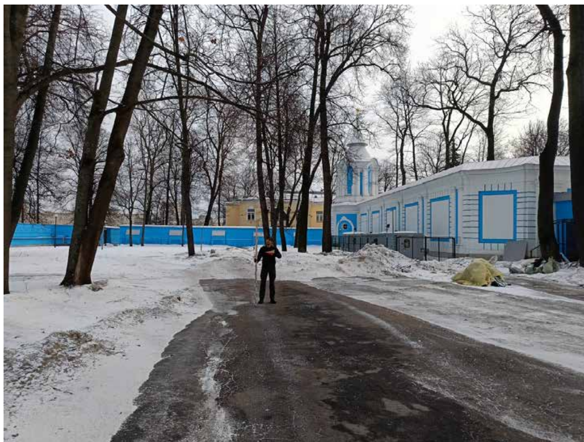
Рис. 26. СПб-2024. Смольный пр., д. 1. НВ. Точка фотофиксации 5, вид на восток.
