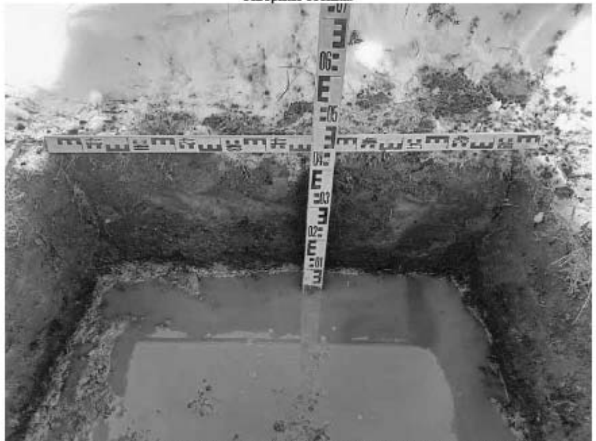
Рис. 546. СПб-2024. Стрельна, КН:78:40:0019185-2271; 2272; 110; 111; 2262; 2265. Шурф 54, северная стенка.
