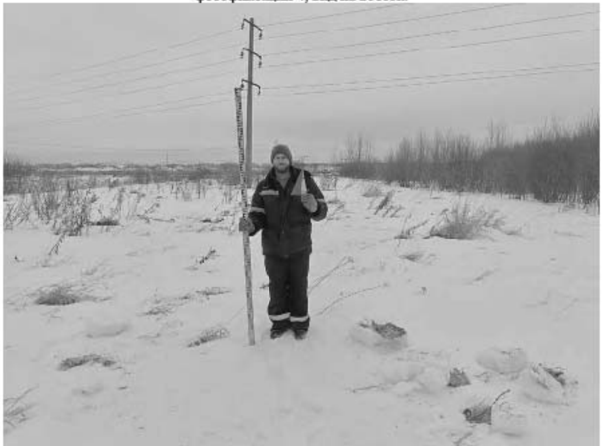
Рис. 27. СПб-2024. Стрельна, КН:78:40:0019185:2271; 2272; 110; 111; 2262; 2265. Точка фотофиксации 4, вид на север.
