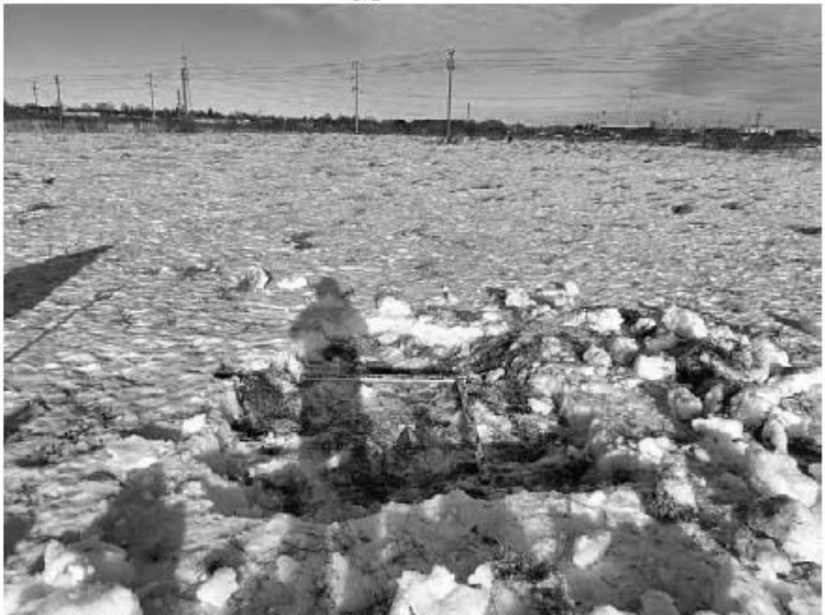
Рис. 451. СПб-2024. Стрельна, КН:78:40:0019185:2271; 2272; 110; 111; 2262; 2265. Местоположение шурфа 44, вид на север.
