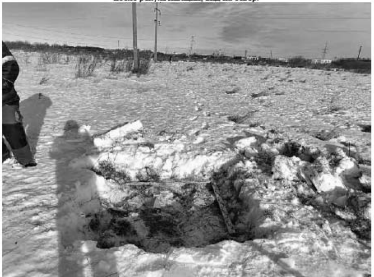
Рис. 442. СПб-2024. Стрельна, КН:78:40:0019185:2271; 2272; 110; 111; 2262; 2265. Местоположение шурфа 43, вид на север.
