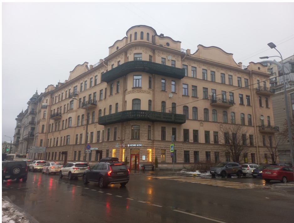
Фото 1. Лицевые фасады. Вид с перекрестка наб. Черной речки (нечетная сторона) и ул. Старобельская.
