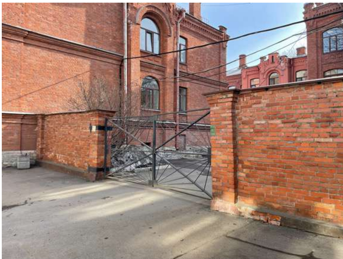
5. Фрагмент существующей ограды
