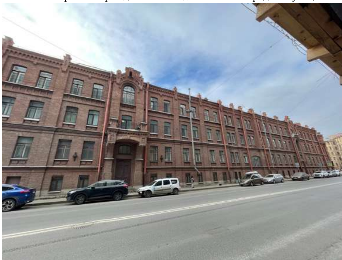
39. Фрагмент фасада главного здания по Новгородской улице
