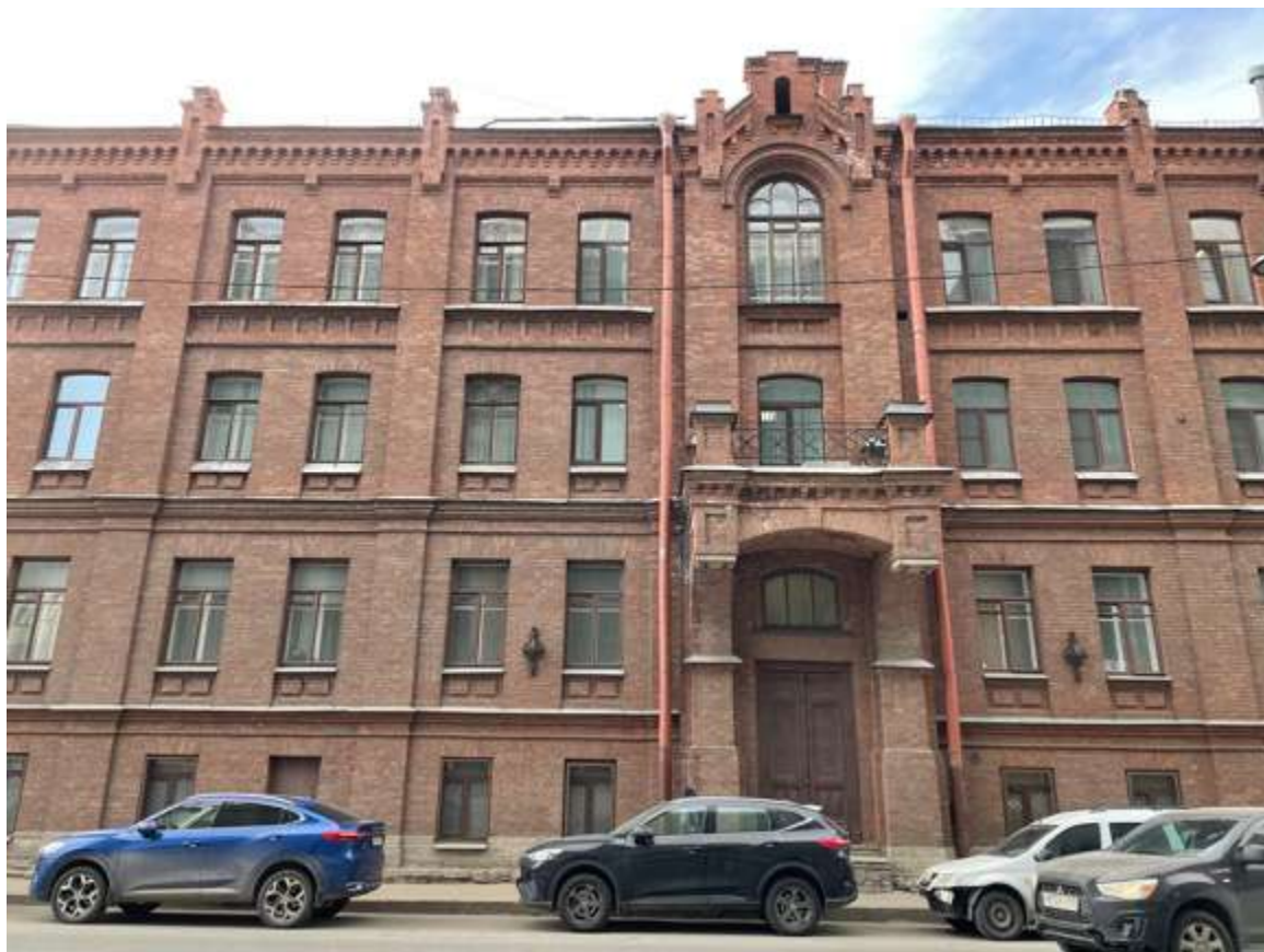
38. Фрагмент фасада главного здания по Новгородской улице
