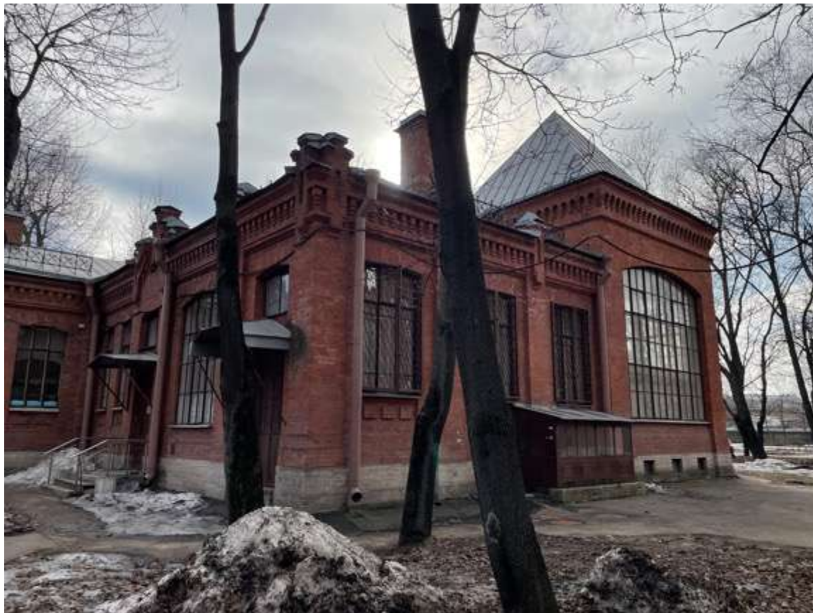
29. Фрагмент фасада хирургического павильона
