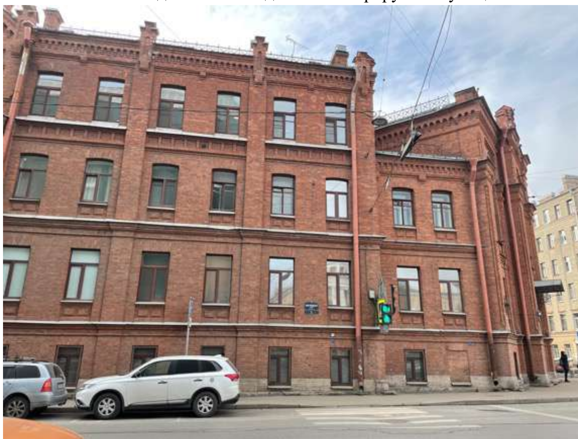
37. Фрагмент фасада главного здания по Новгородской улице
