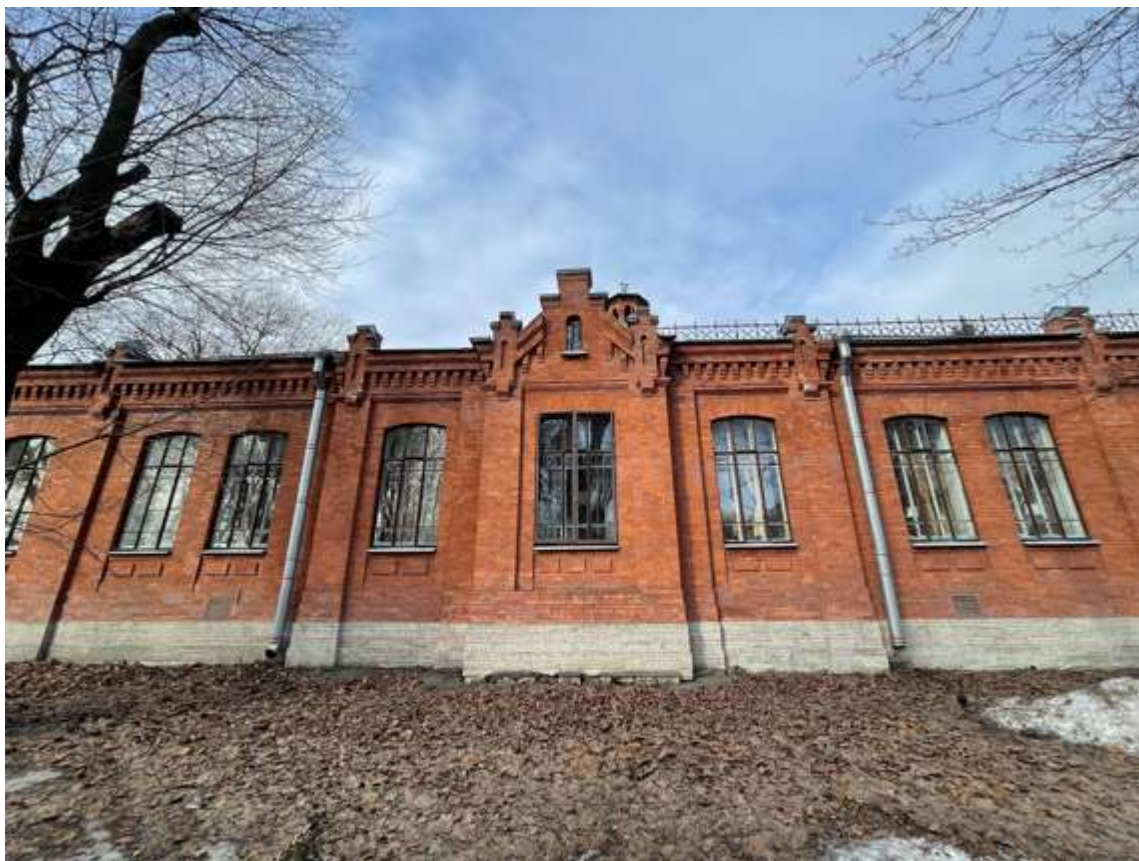
17. Фрагмент фасада хирургического павильона
