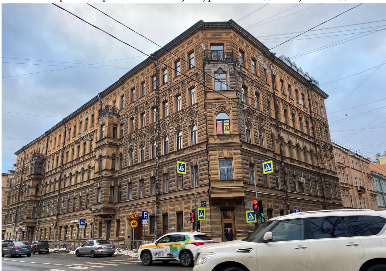
Фото 5. Общий вид объекта культурного наследия с перекрестка улицы Радищева и Виленского переулка.
