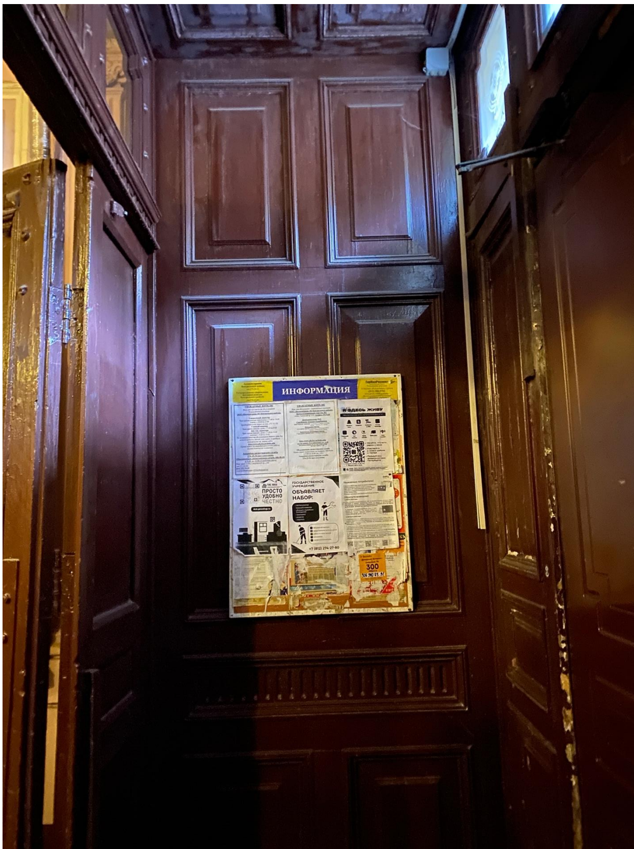
Фото 10. Дверные заполнения парадной объекта культурного наследия.
