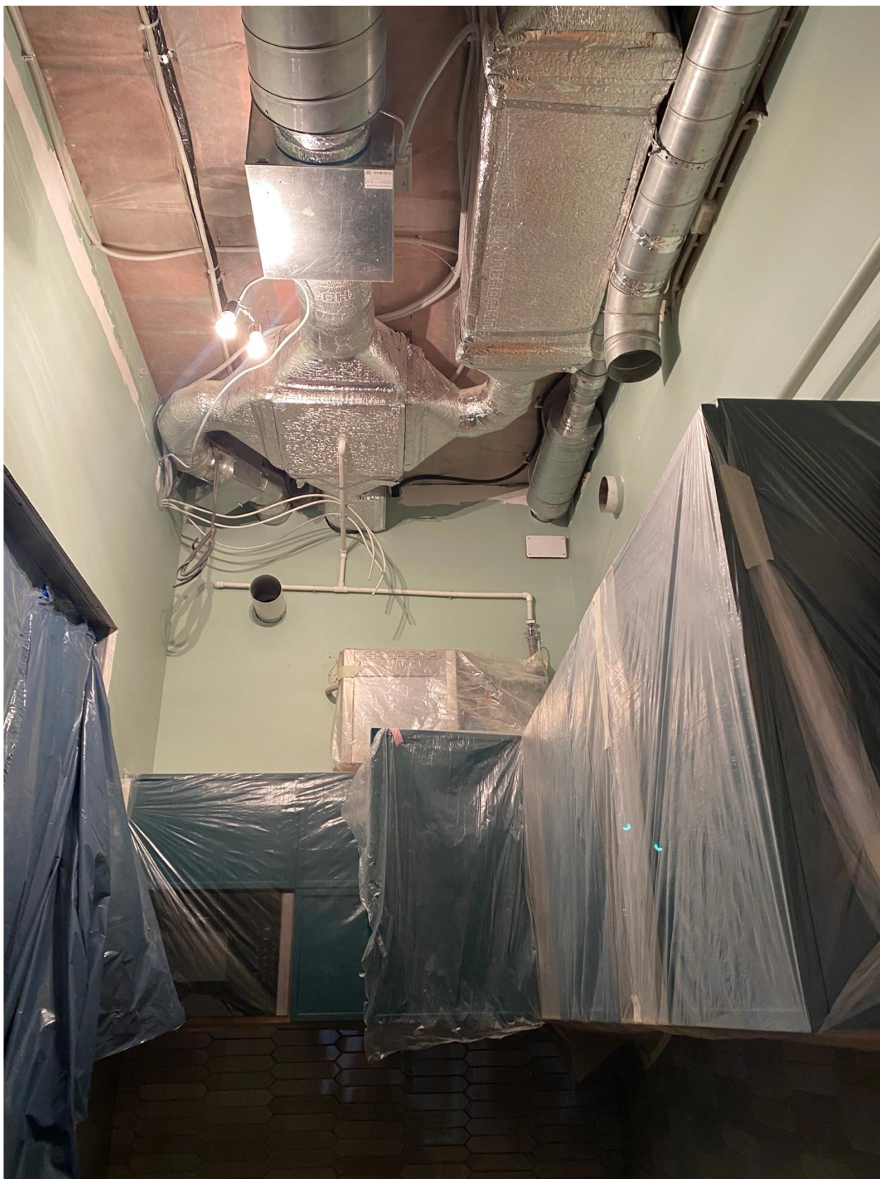
Фото 48. Вид на помещение квартиры № 45 объекта культурного наследия.
