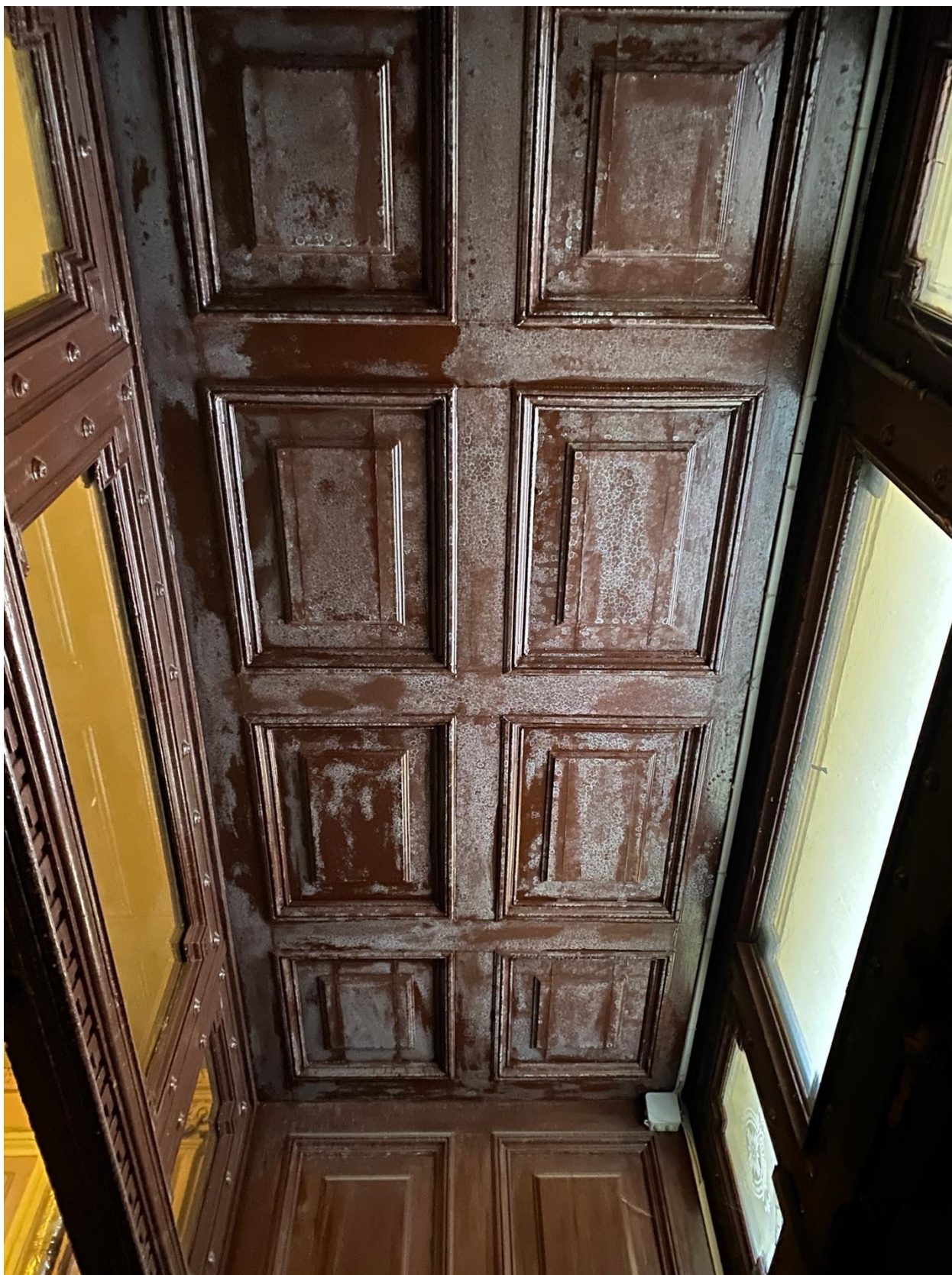
Фото 8. Потолок тамбура объекта культурного наследия.
