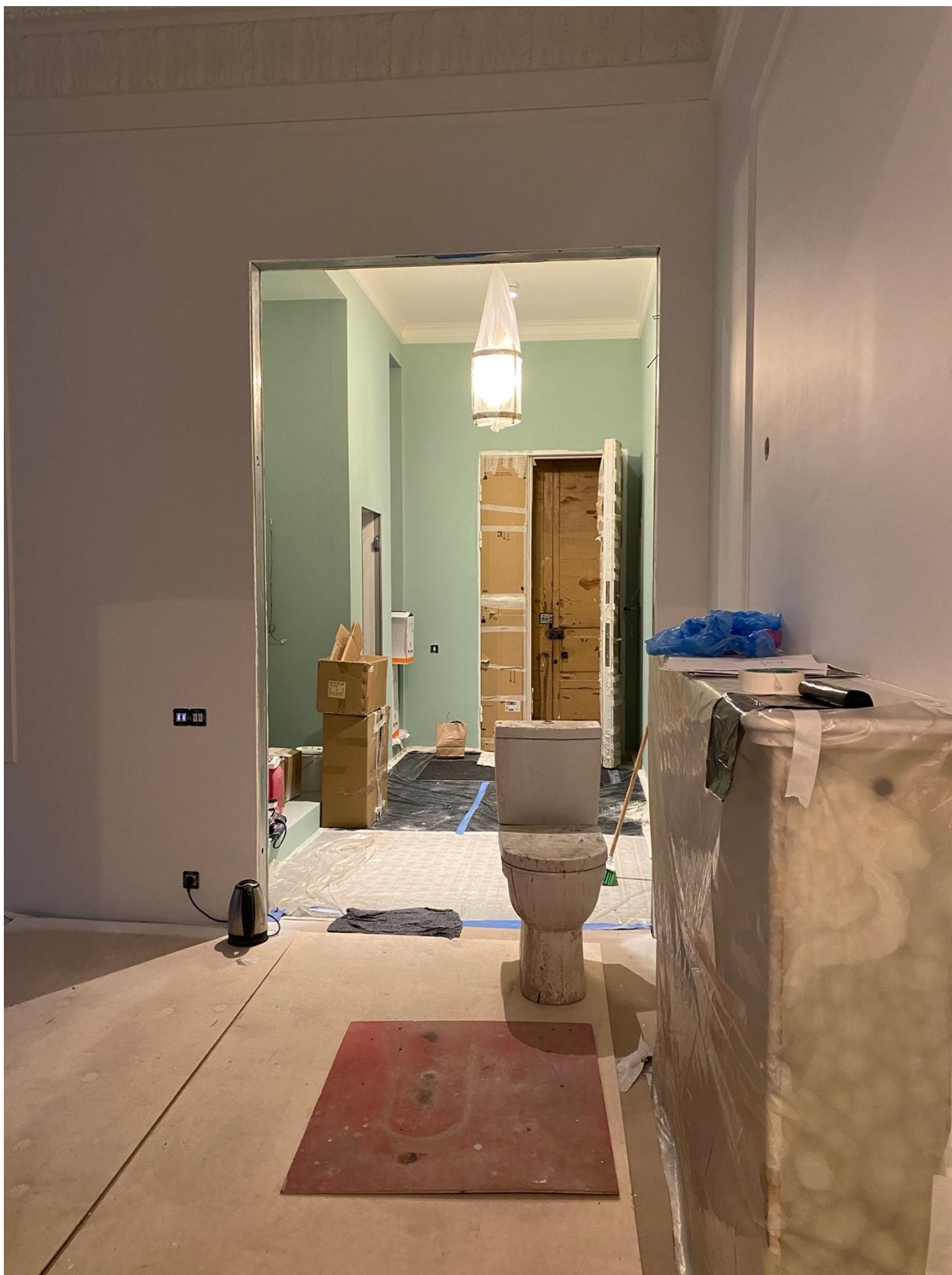
Фото 72. Вид на помещение квартиры № 45 объекта культурного наследия.
