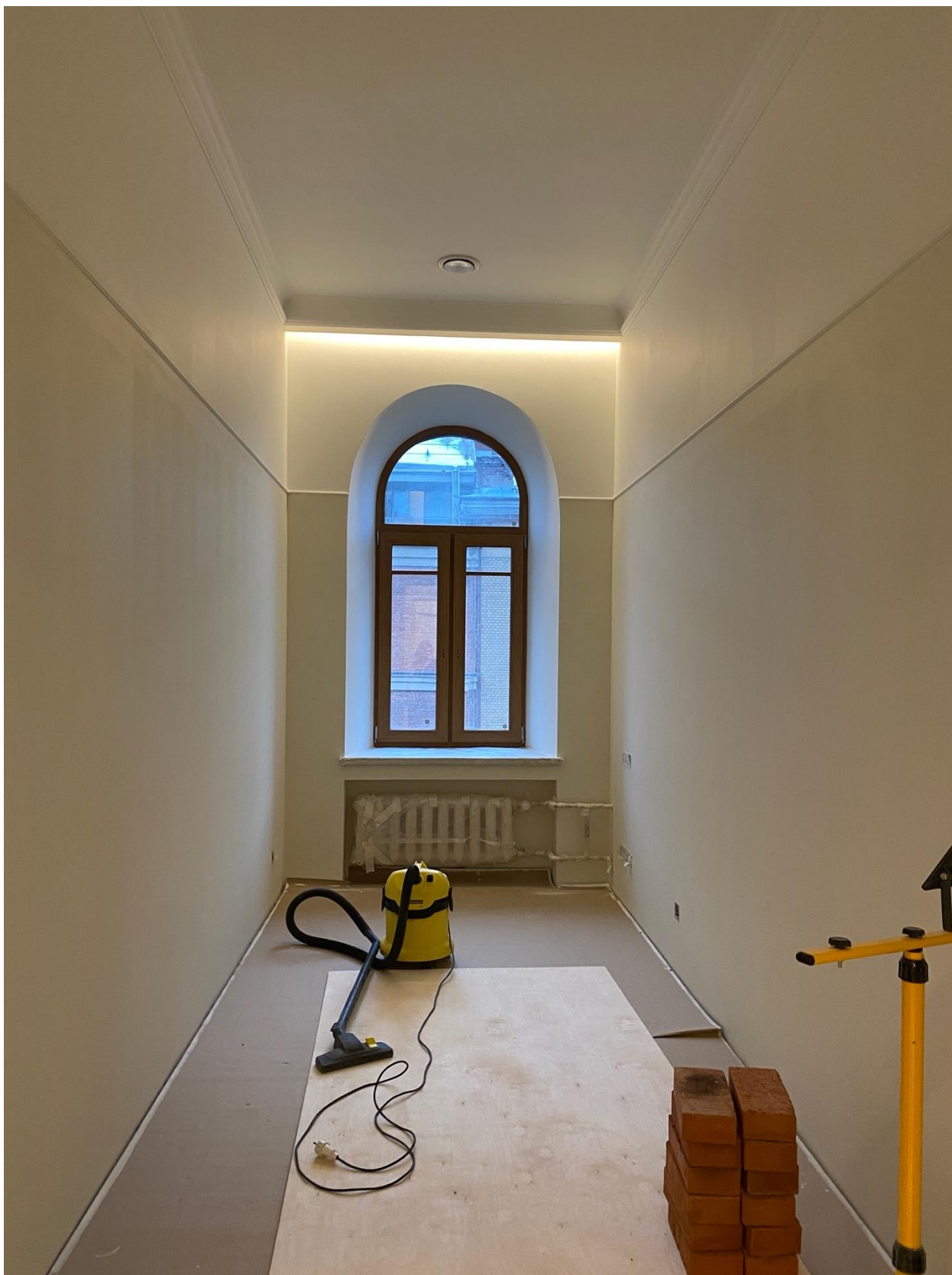
Фото 65. Вид на помещение квартиры № 45 объекта культурного наследия.
