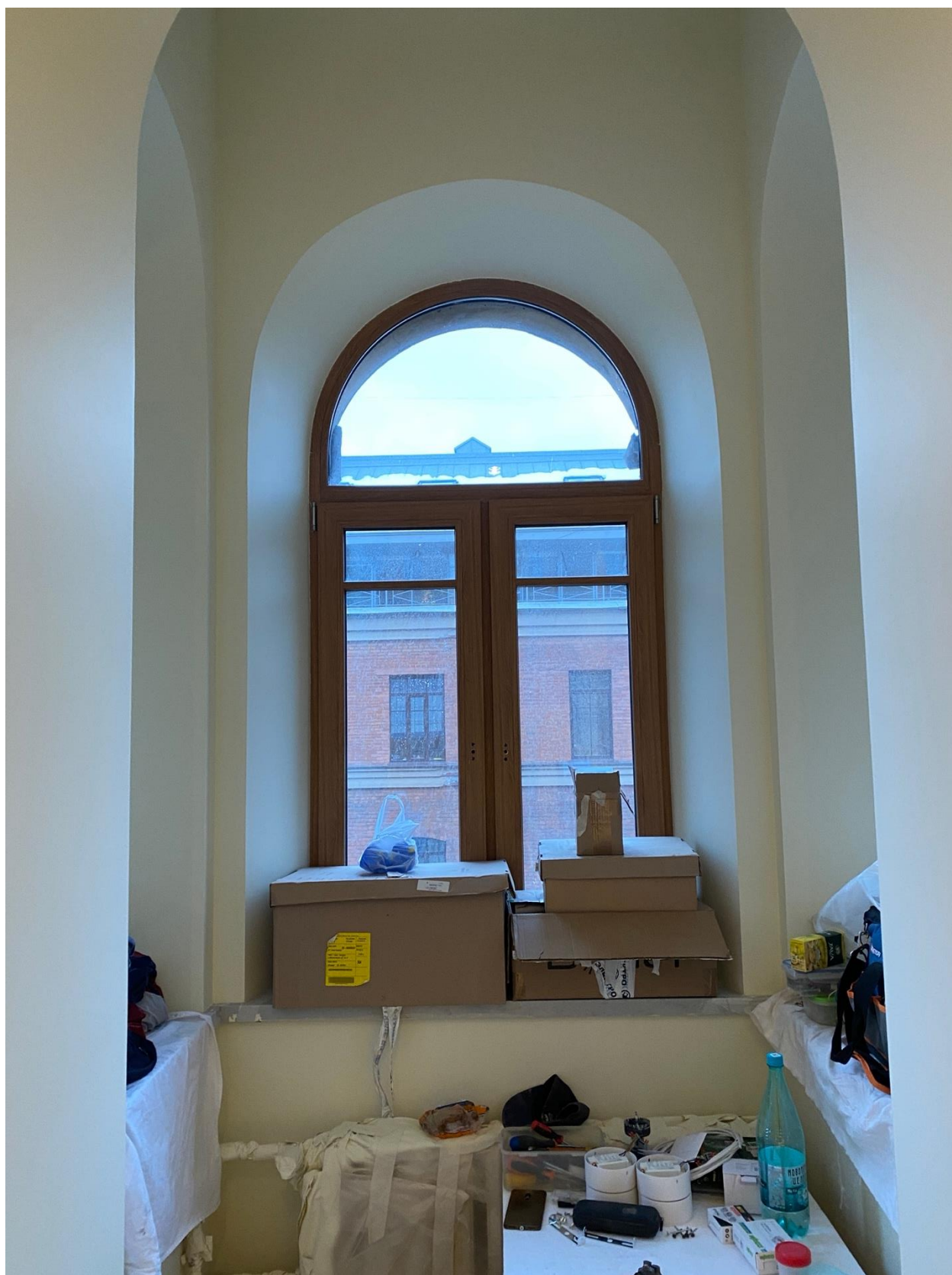
Фото 30. Вид на помещение квартиры № 45 объекта культурного наследия.
