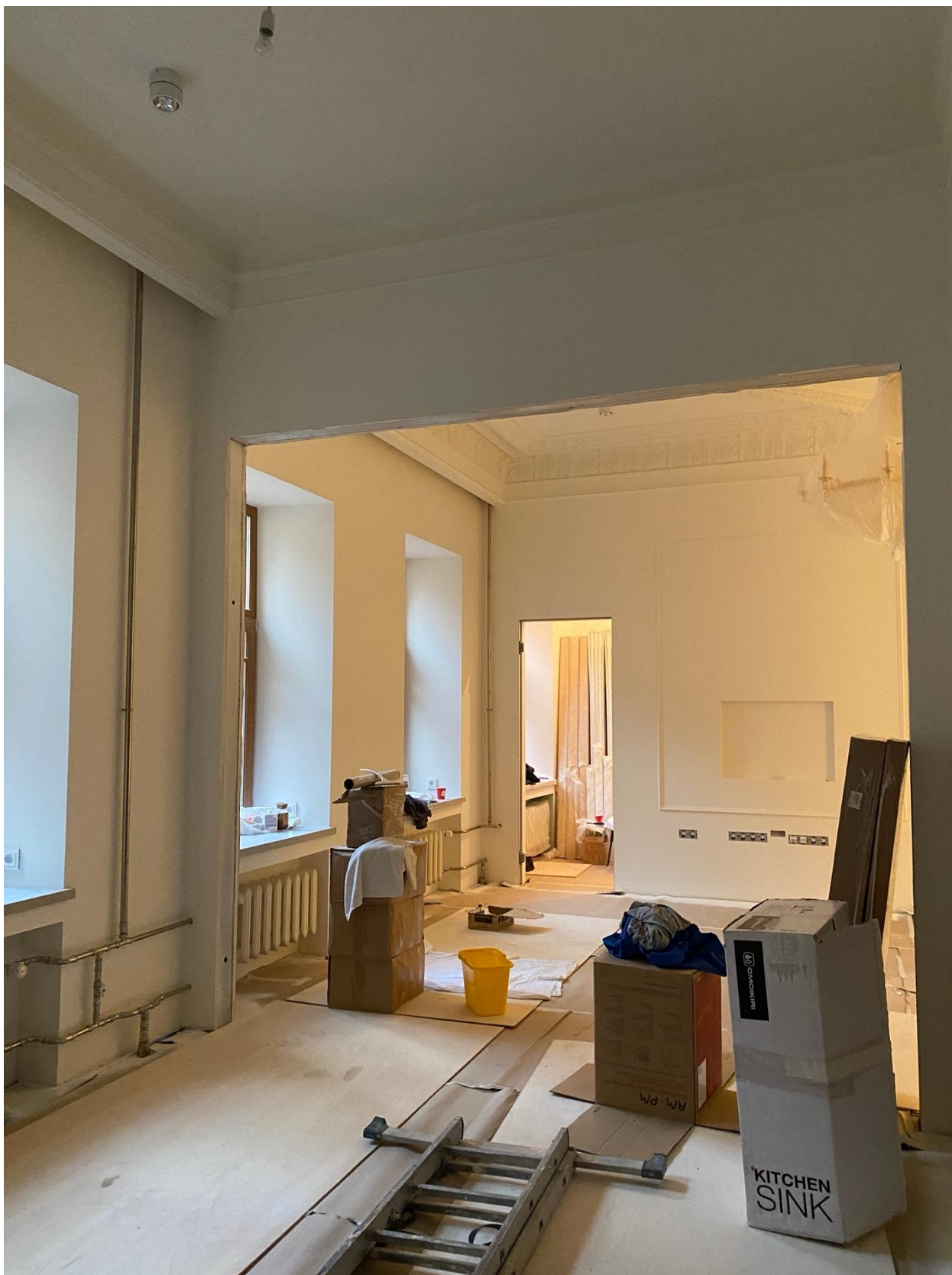
Фото 44. Вид на помещение квартиры № 45 объекта культурного наследия.
