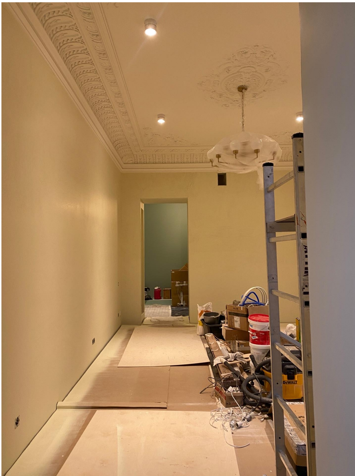
Фото 32. Вид на помещение квартиры № 45 объекта культурного наследия.
