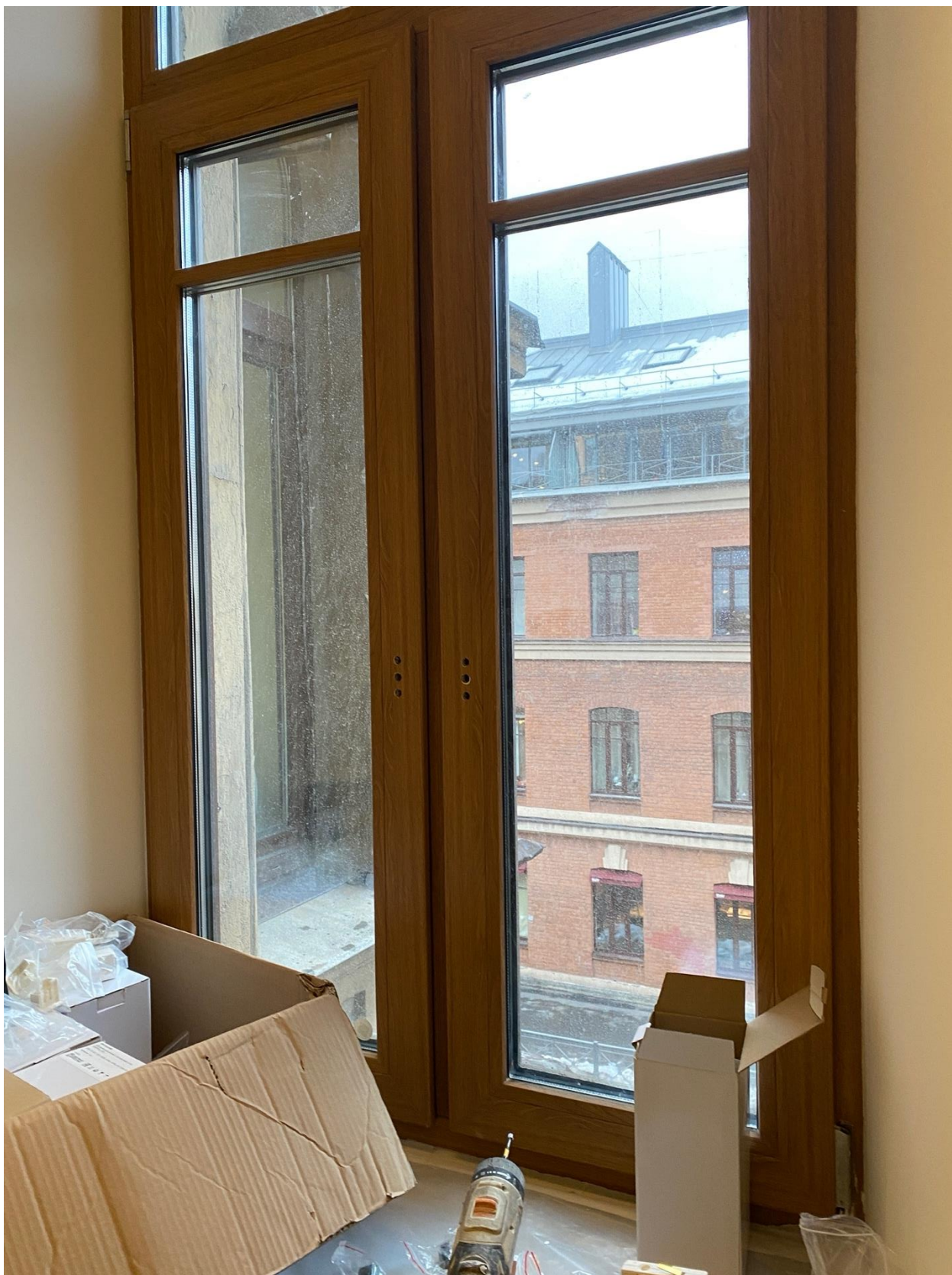
Фото 70. Вид на оконное заполнение квартиры № 45 объекта культурного наследия.
