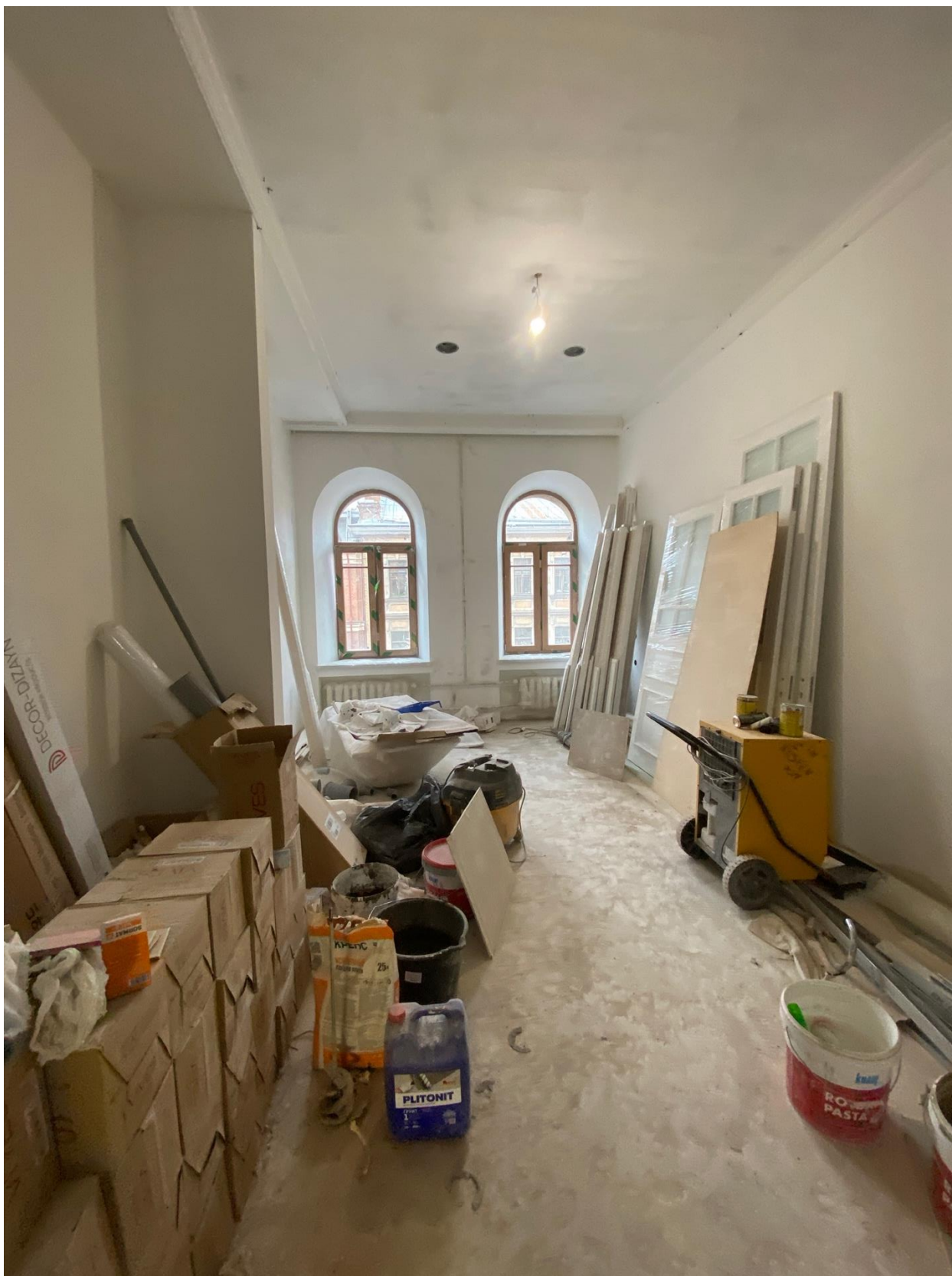
Фото 56. Вид на помещение квартиры № 45 объекта культурного наследия.
