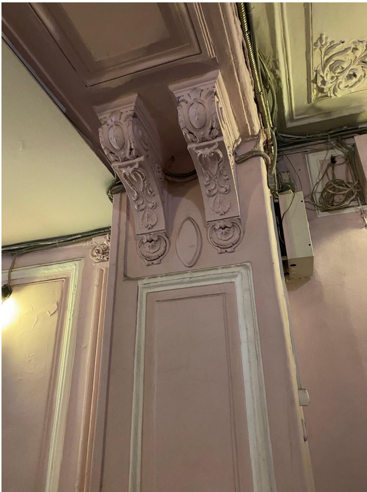
Фото 13. Интерьер парадной объекта культурного наследия.
