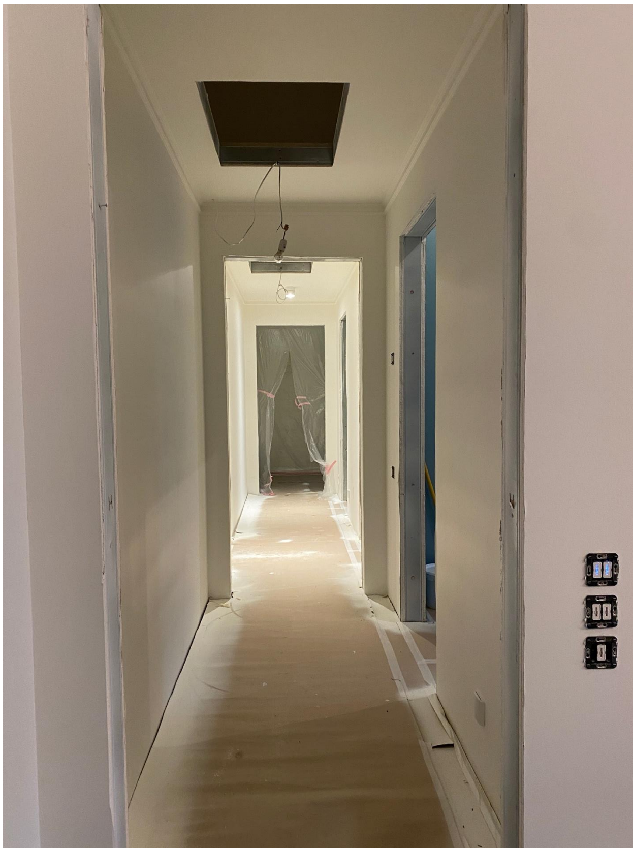
Фото 61. Вид на помещение квартиры № 45 объекта культурного наследия.
