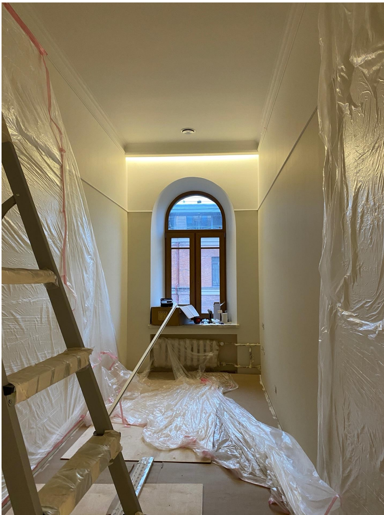
Фото 69. Вид на помещение квартиры № 45 объекта культурного наследия.
