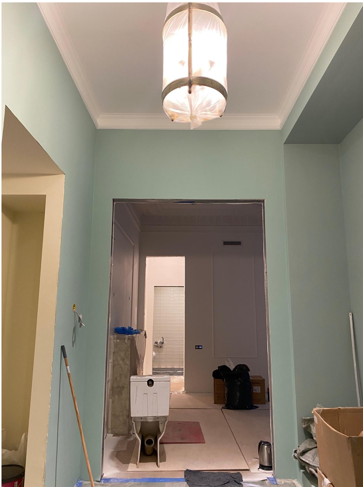
Фото 25. Вид на помещение квартиры № 45 объекта культурного наследия.
