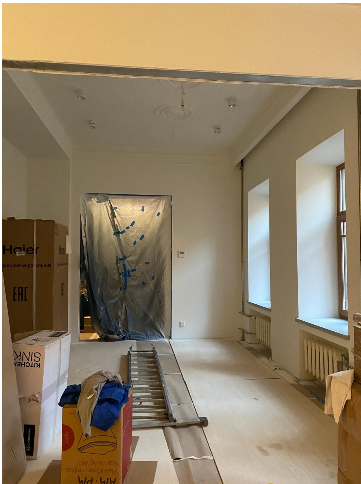
Фото 38. Вид на помещение квартиры № 45 объекта культурного наследия.
