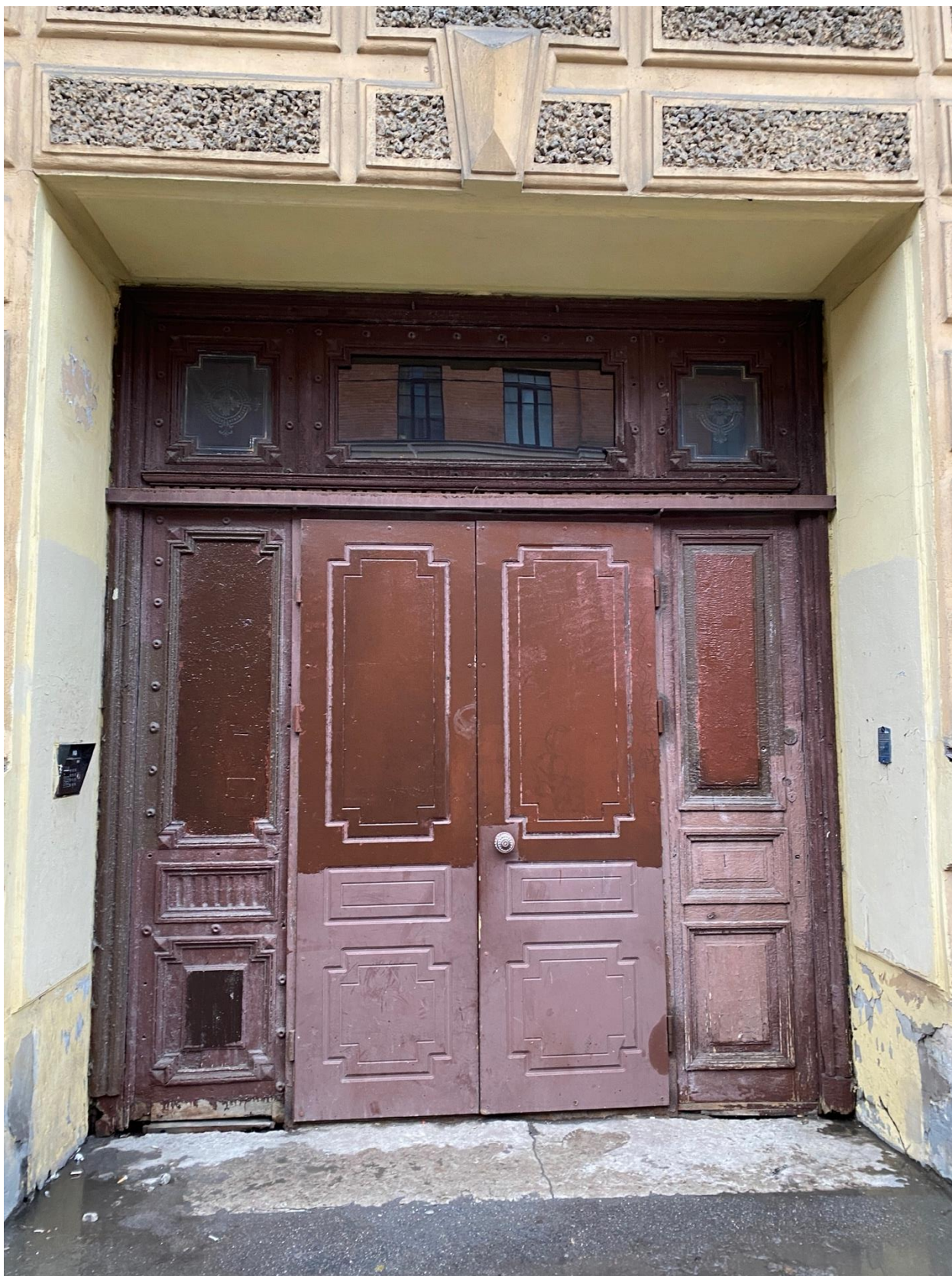
Фото 6. Вид на дверное заполнение парадной объекта культурного наследия по улице Радищева.
