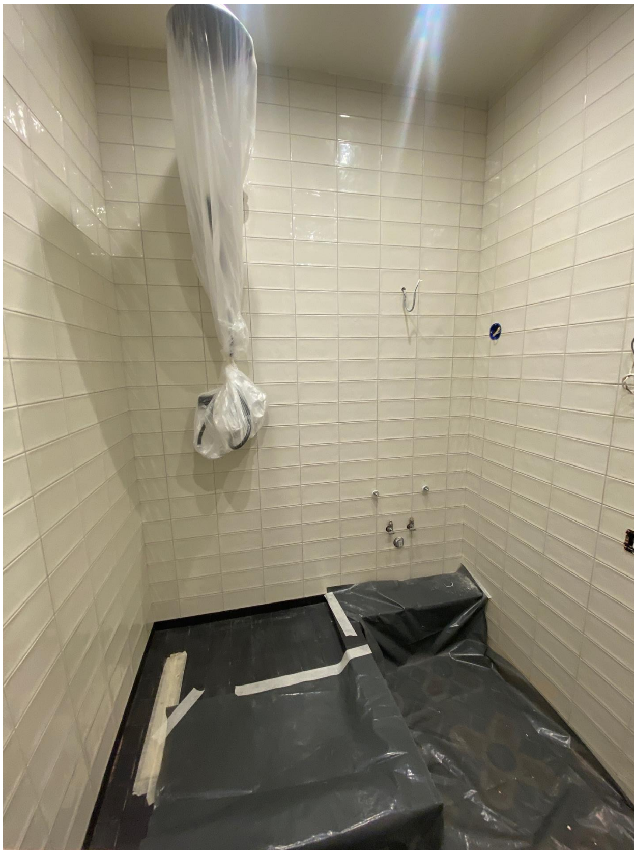
Фото 53. Вид на помещение квартиры № 45 объекта культурного наследия.
