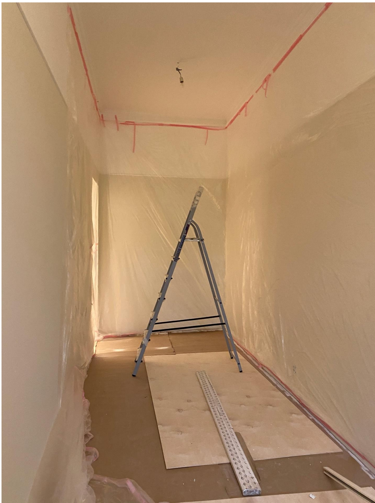
Фото 71. Вид на помещение квартиры № 45 объекта культурного наследия.
