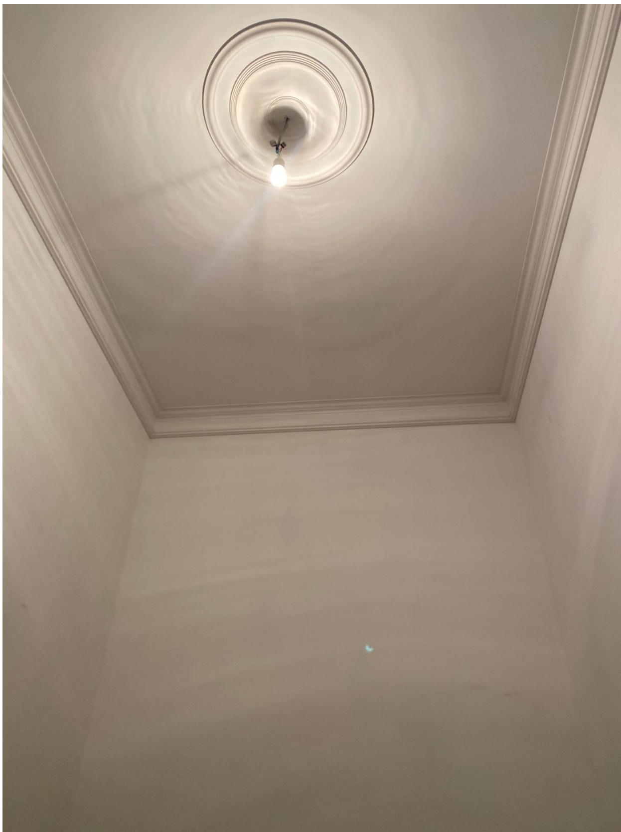
Фото 40. Вид на помещение квартиры № 45 объекта культурного наследия.
