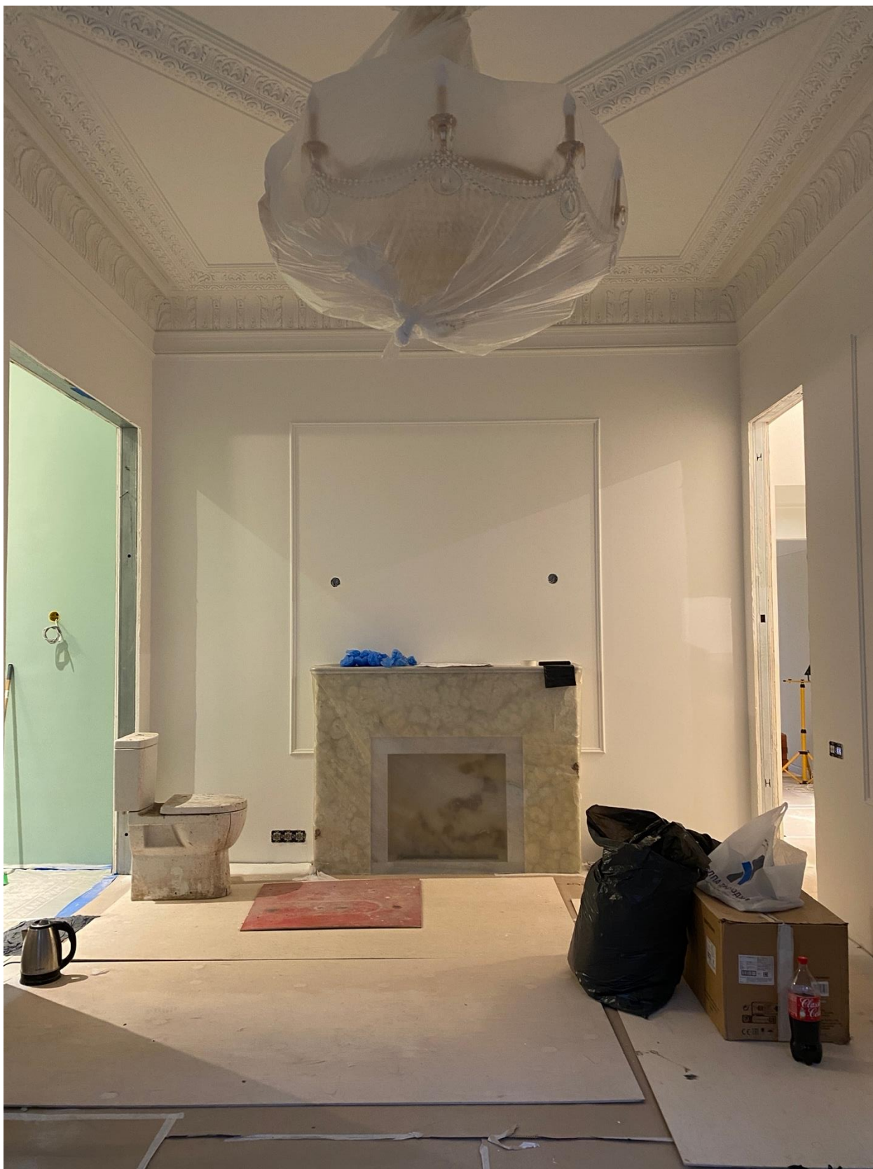
Фото 42. Вид на помещение квартиры № 45 объекта культурного наследия.
