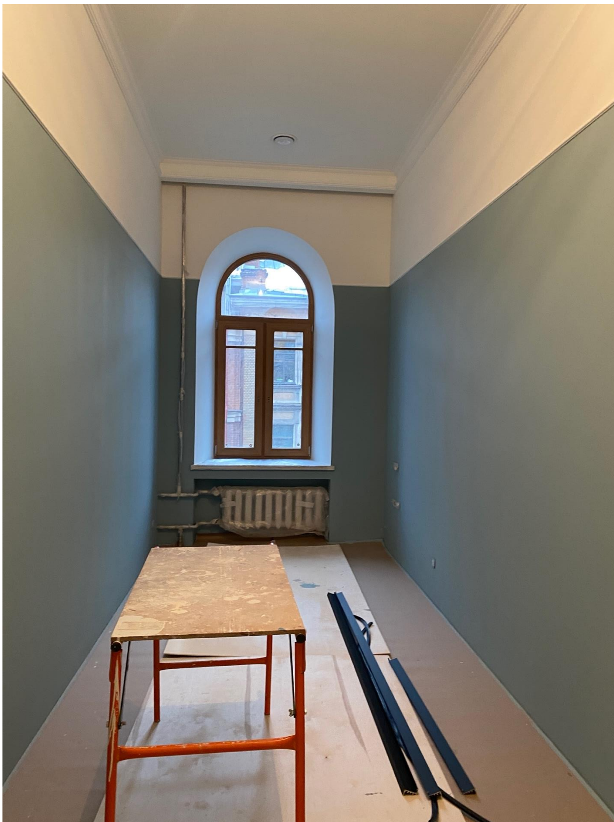
Фото 62. Вид на помещение квартиры № 45 объекта культурного наследия.
