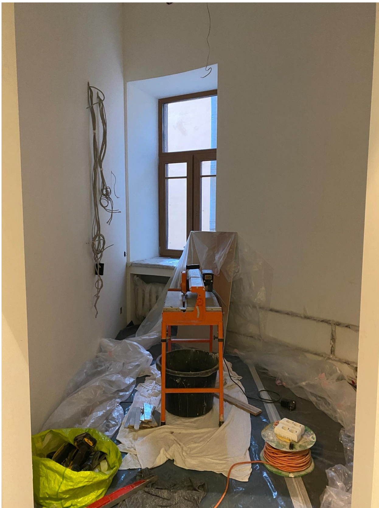
Фото 22. Вид на помещение квартиры № 45 объекта культурного наследия.
