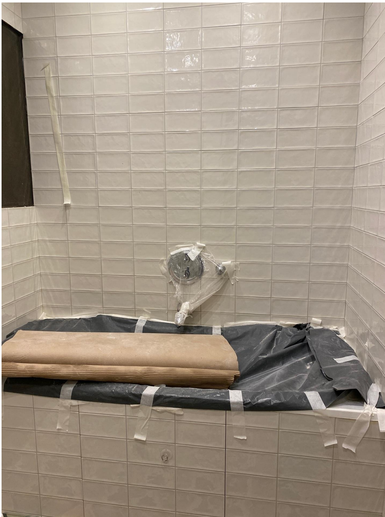
Фото 60. Вид на помещение квартиры № 45 объекта культурного наследия.
