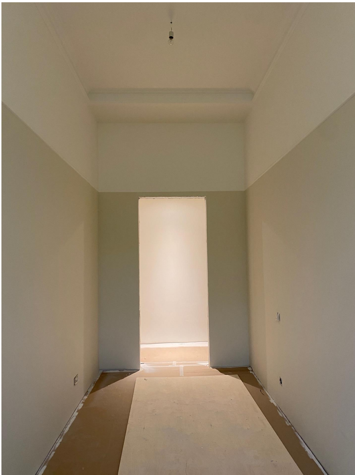
Фото 68. Вид на помещение квартиры № 45 объекта культурного наследия.
