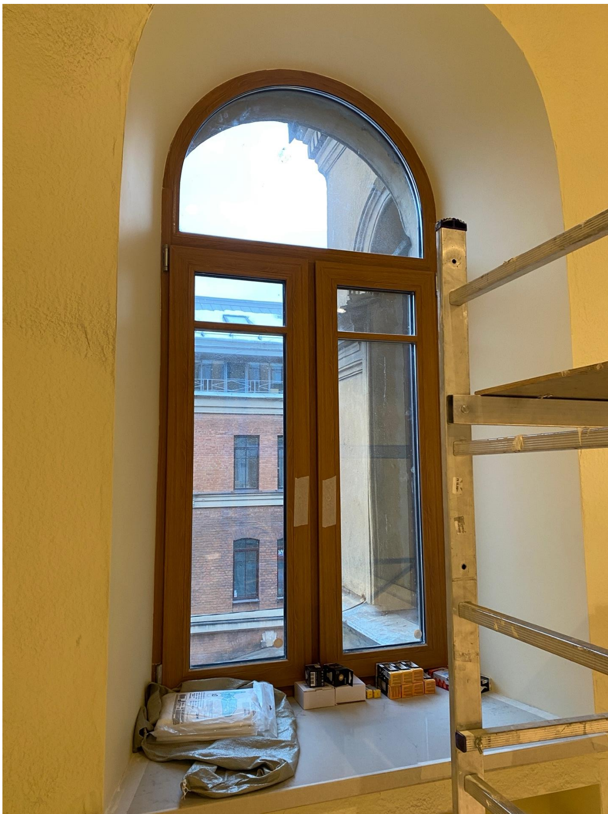
Фото 28. Оконное заполнение помещения квартиры № 45 объекта культурного наследия.
