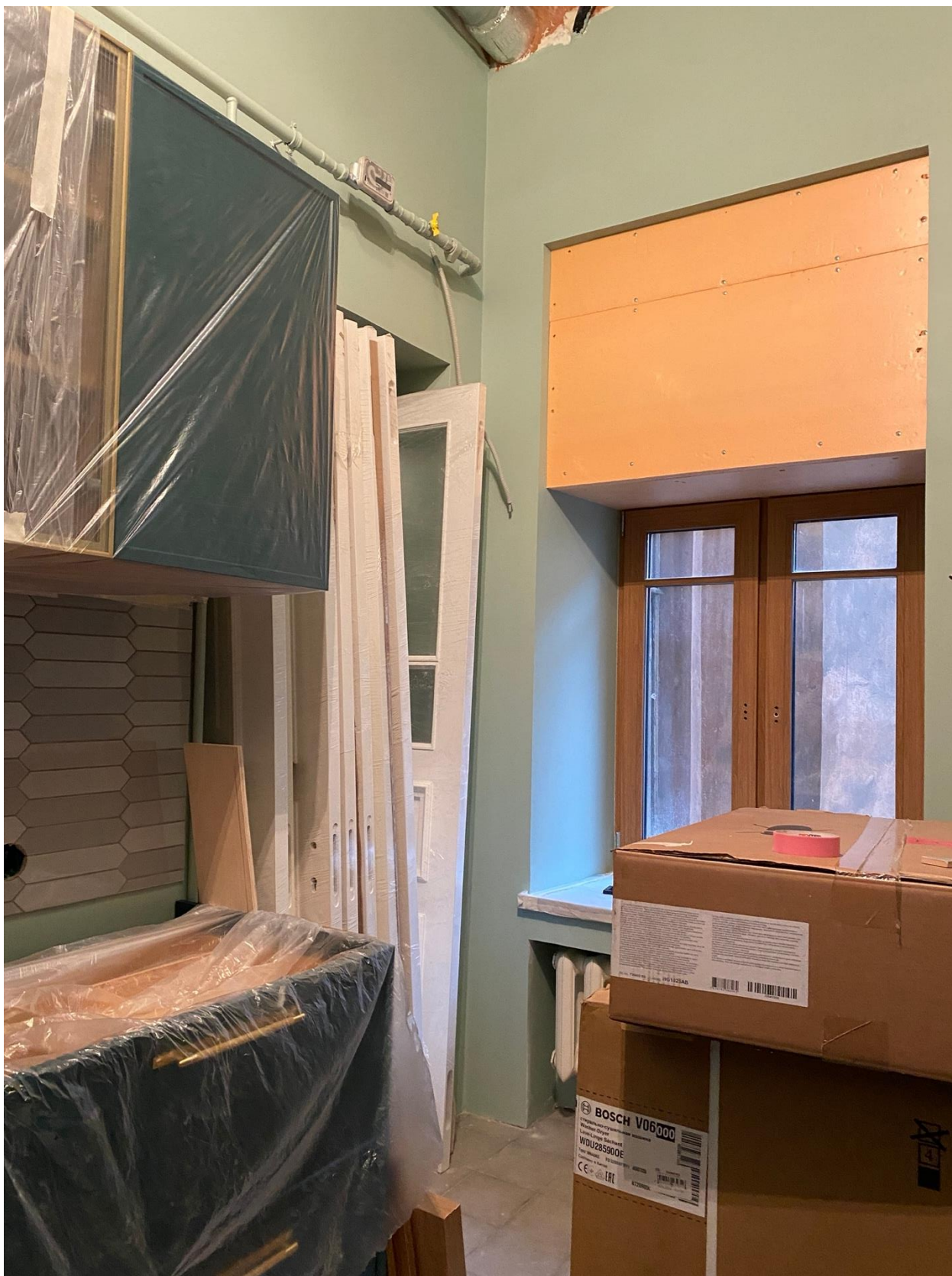
Фото 45. Вид на помещение квартиры № 45 объекта культурного наследия.
