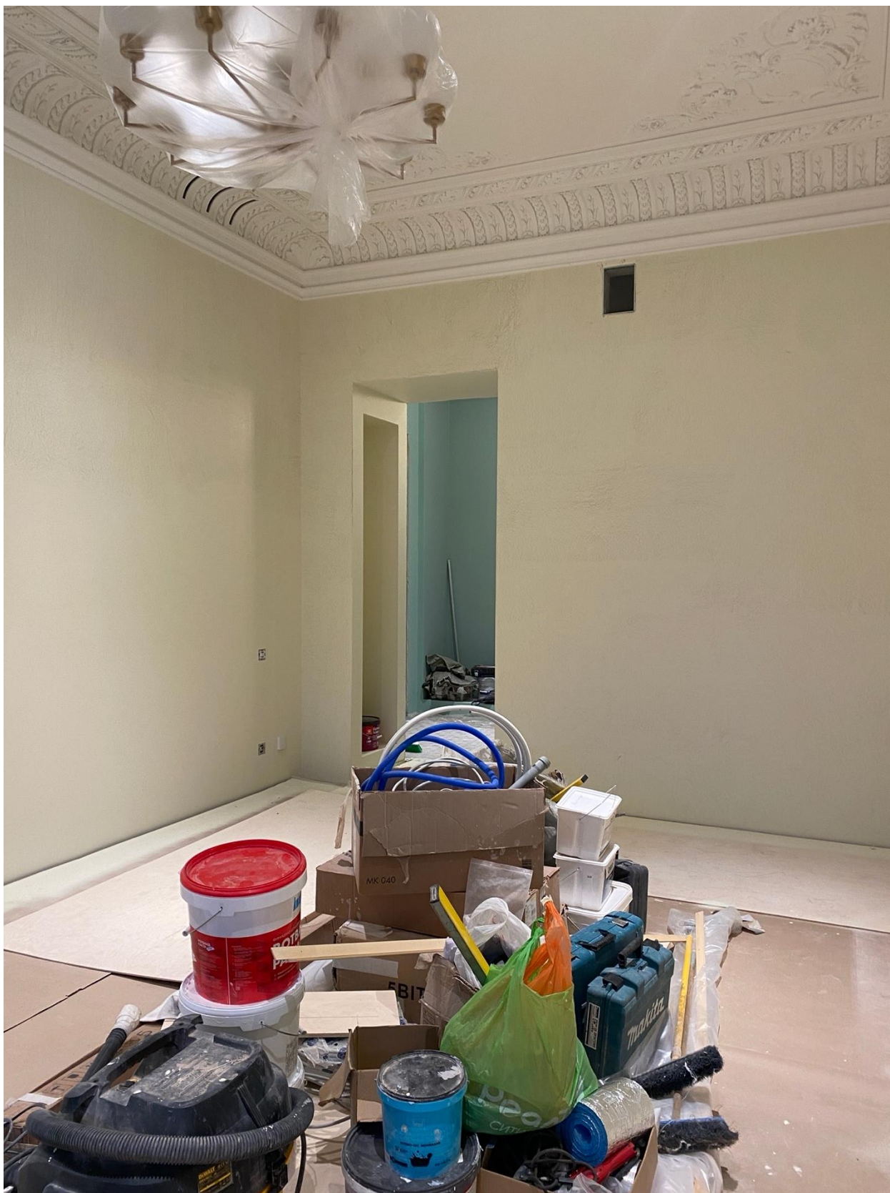
Фото 29. Вид на помещение квартиры № 45 объекта культурного наследия.
