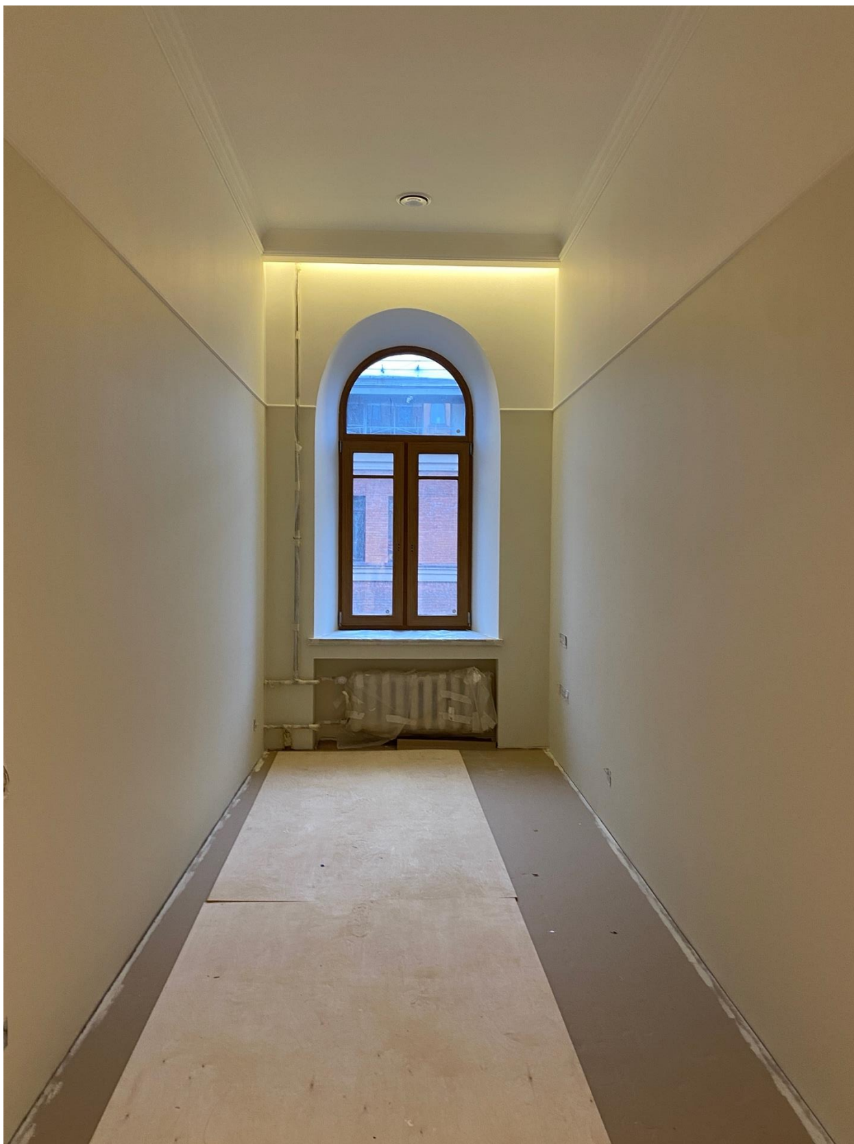
Фото 67. Вид на помещение квартиры № 45 объекта культурного наследия.
