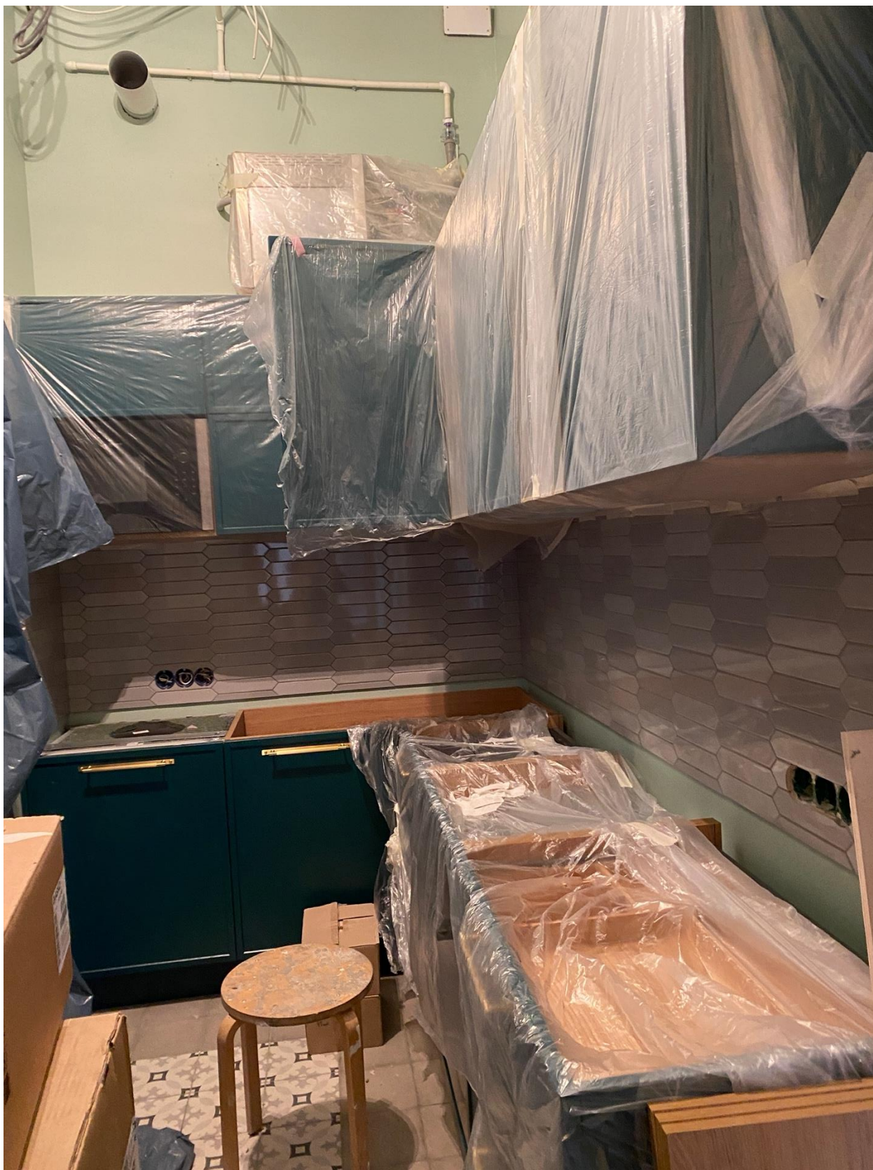
Фото 47. Вид на помещение квартиры № 45 объекта культурного наследия.
