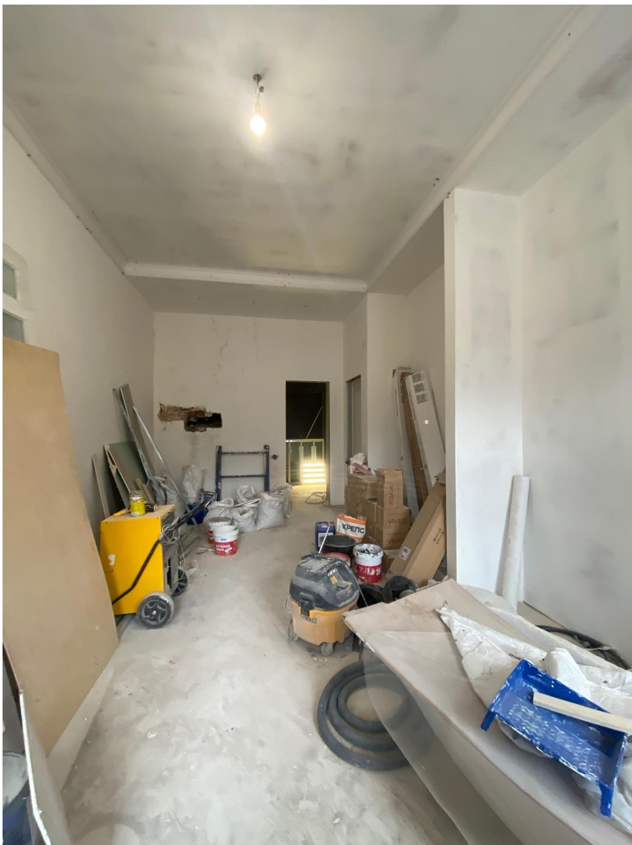
Фото 57. Вид на помещение квартиры № 45 объекта культурного наследия.
