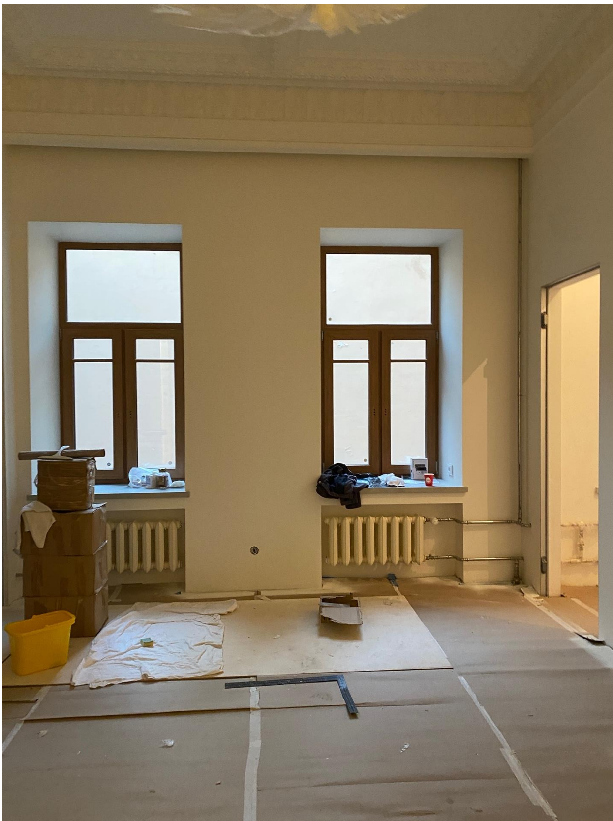
Фото 36. Вид на помещение квартиры № 45 объекта культурного наследия.
