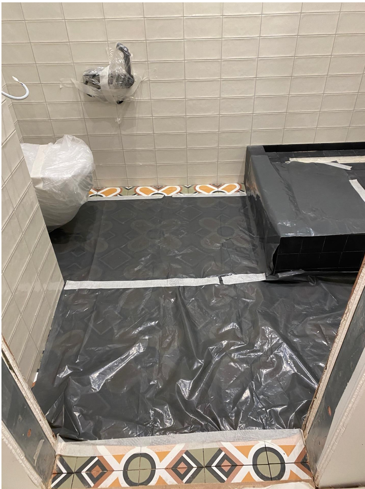
Фото 50. Вид на помещение квартиры № 45 объекта культурного наследия.
