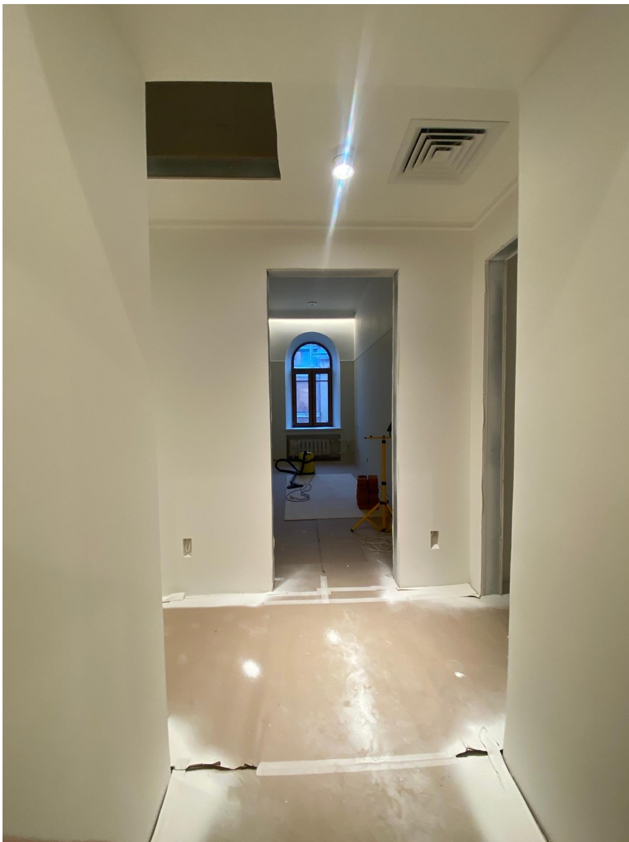
Фото 54. Вид на помещение квартиры № 45 объекта культурного наследия.
