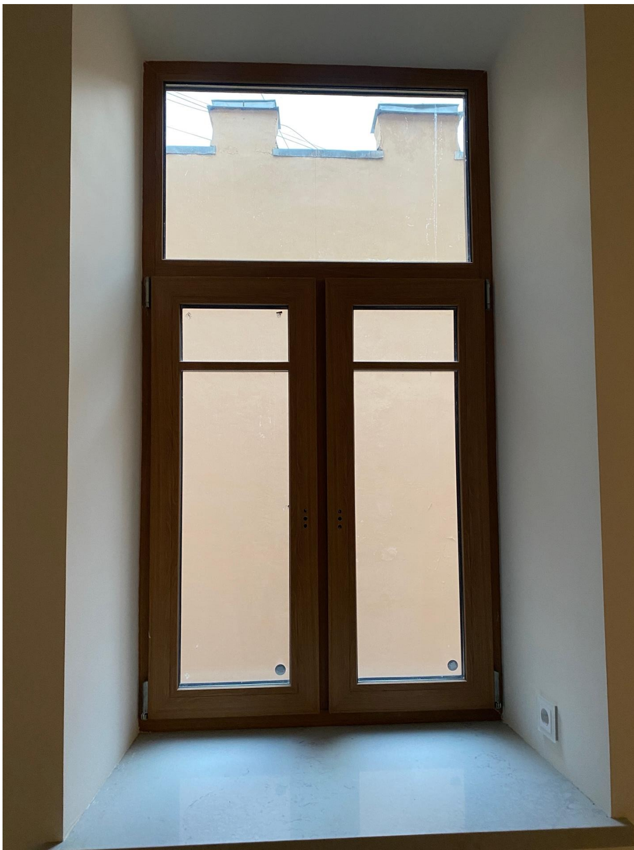
Фото 43. Вид на оконное заполнение помещения квартиры № 45 объекта культурного наследия.
