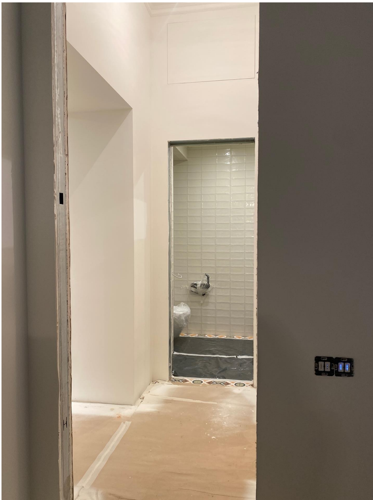
Фото 49. Вид на помещение квартиры № 45 объекта культурного наследия.
