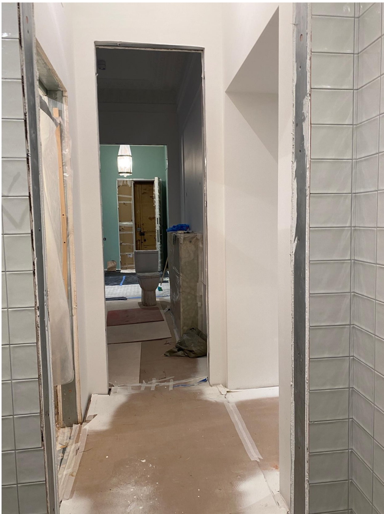
Фото 51. Вид на помещение квартиры № 45 объекта культурного наследия.
