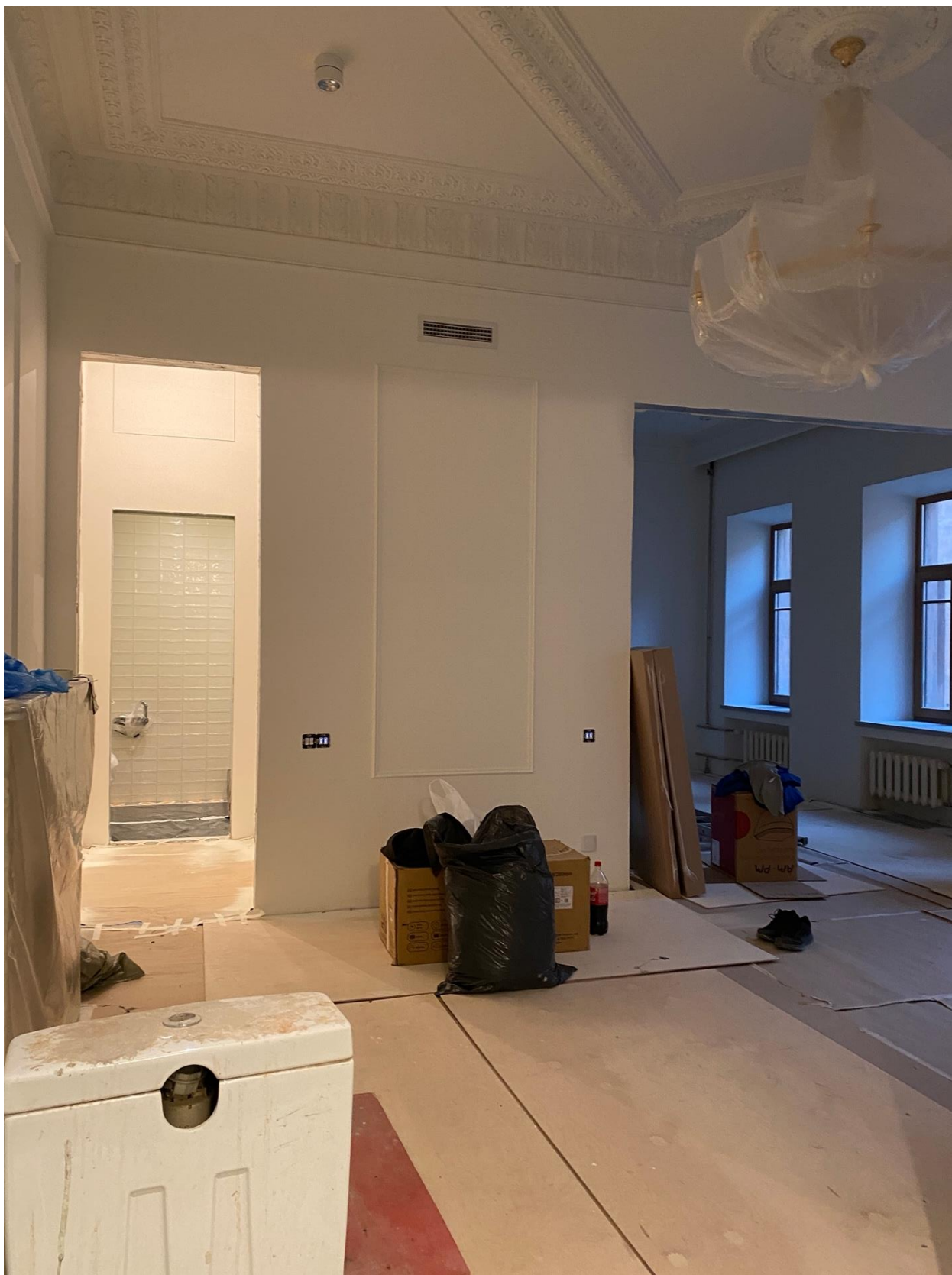
Фото 35. Вид на помещение квартиры № 45 объекта культурного наследия.
