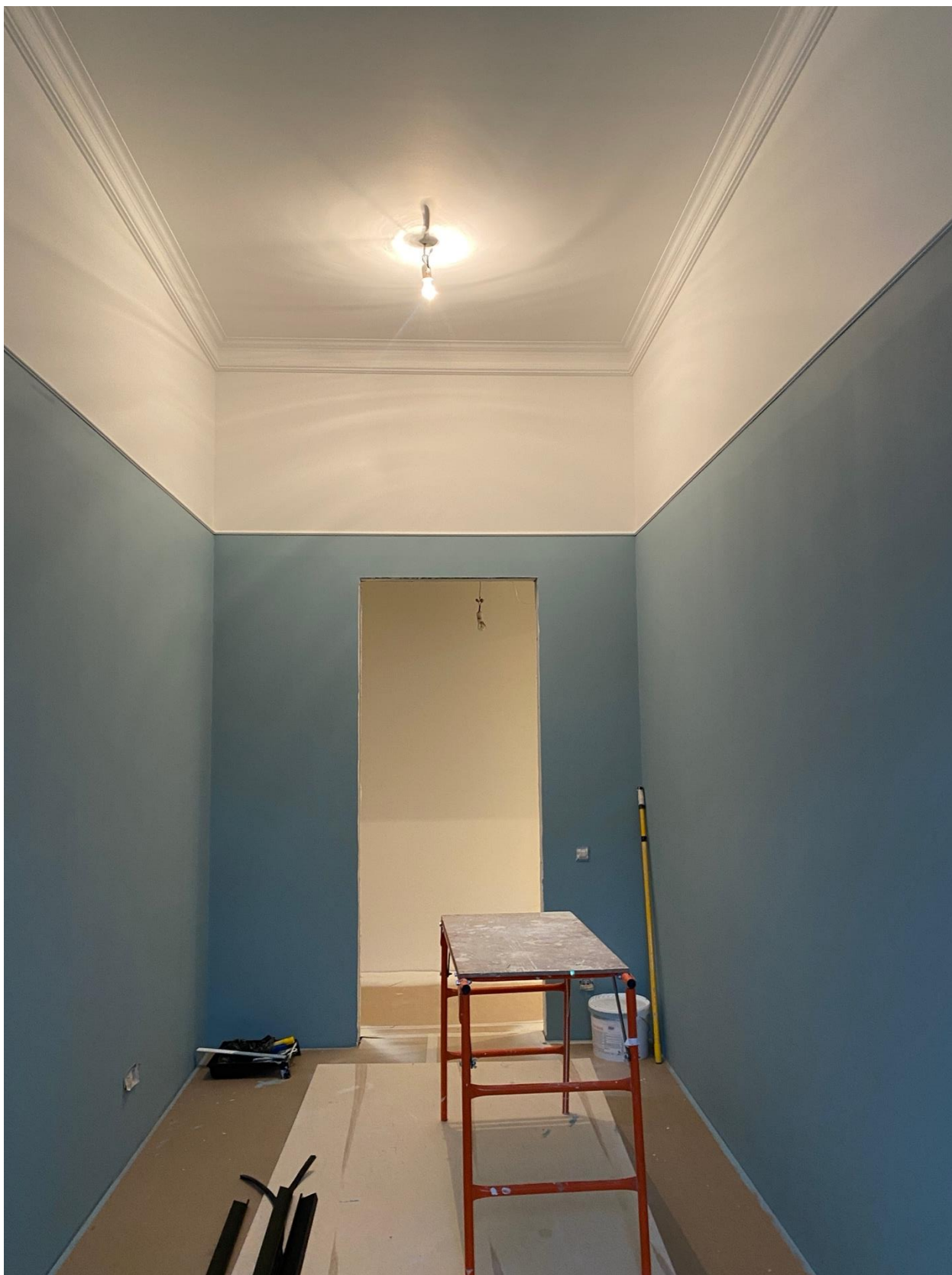
Фото 64. Вид на помещение квартиры № 45 объекта культурного наследия.
