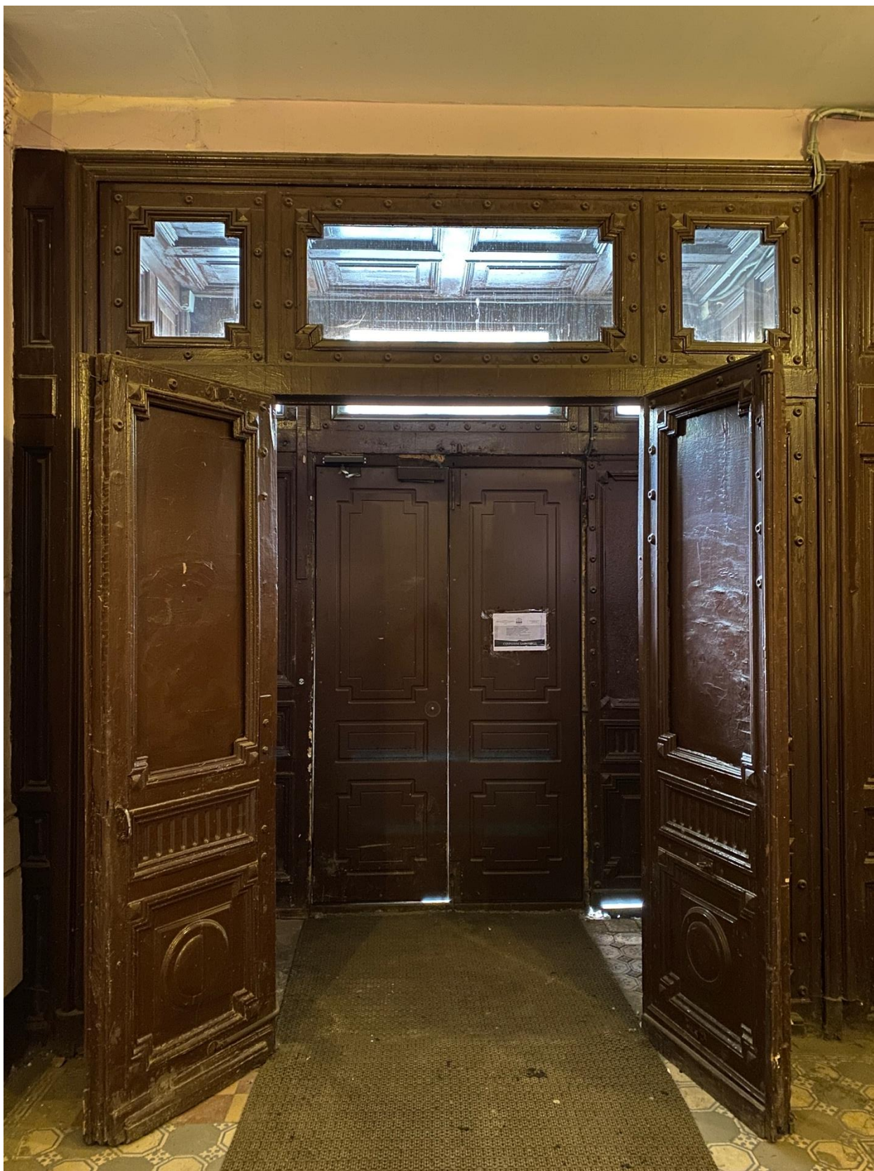
Фото 9. Дверные заполнения парадной объекта культурного наследия.
