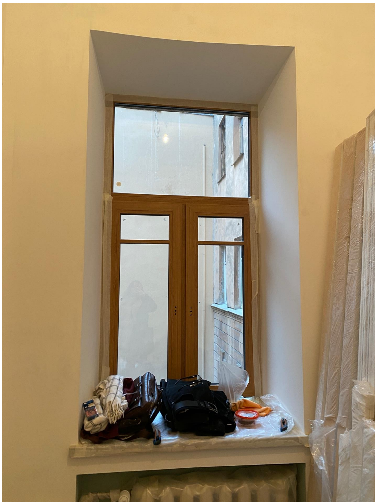
Фото 41. Вид на оконное заполнение помещения квартиры № 45 объекта культурного наследия.
