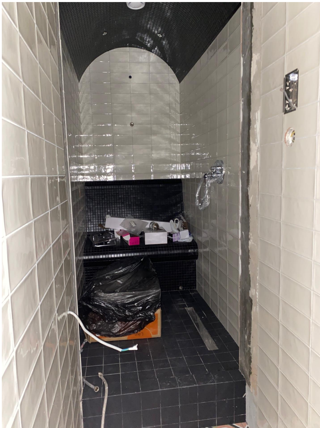
Фото 59. Вид на помещение квартиры № 45 объекта культурного наследия.
