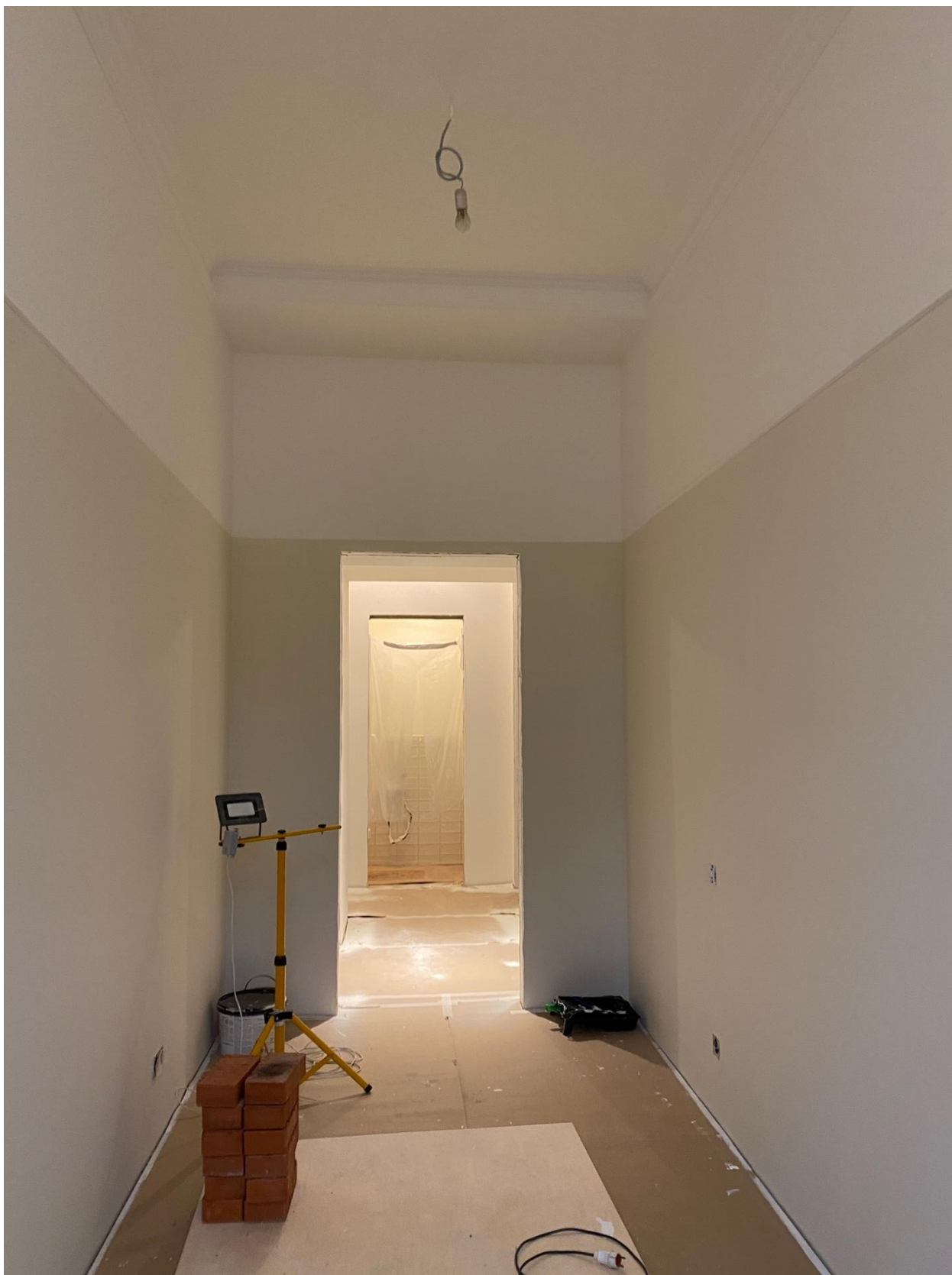
Фото 66. Вид на помещение квартиры № 45 объекта культурного наследия.
