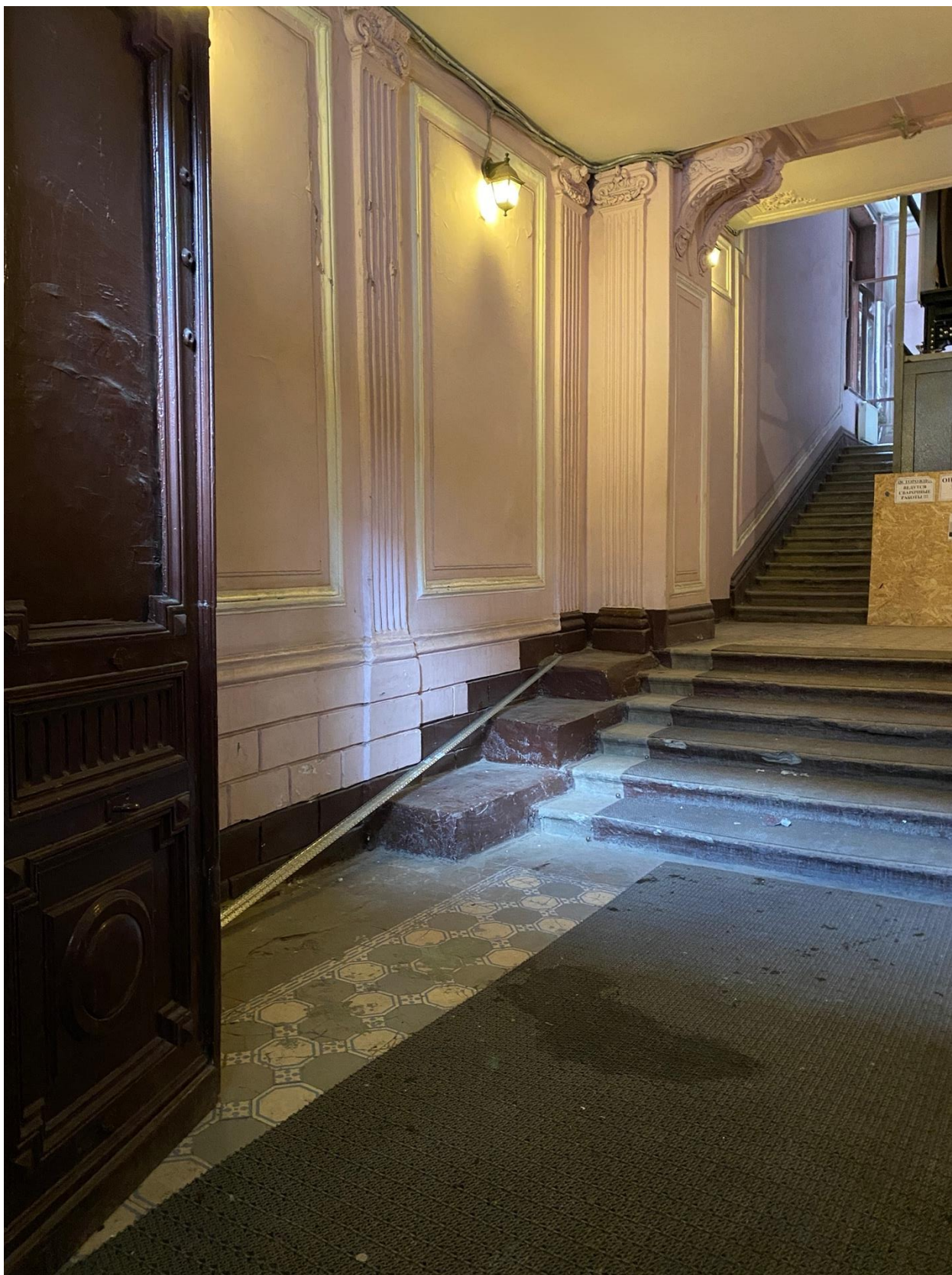
Фото 11. Интерьер парадной объекта культурного наследия.
