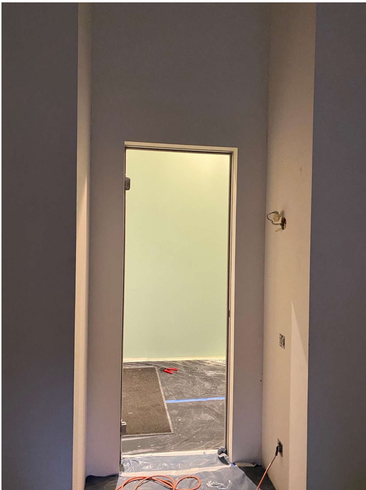
Фото 23. Вид на помещение квартиры № 45 объекта культурного наследия.
