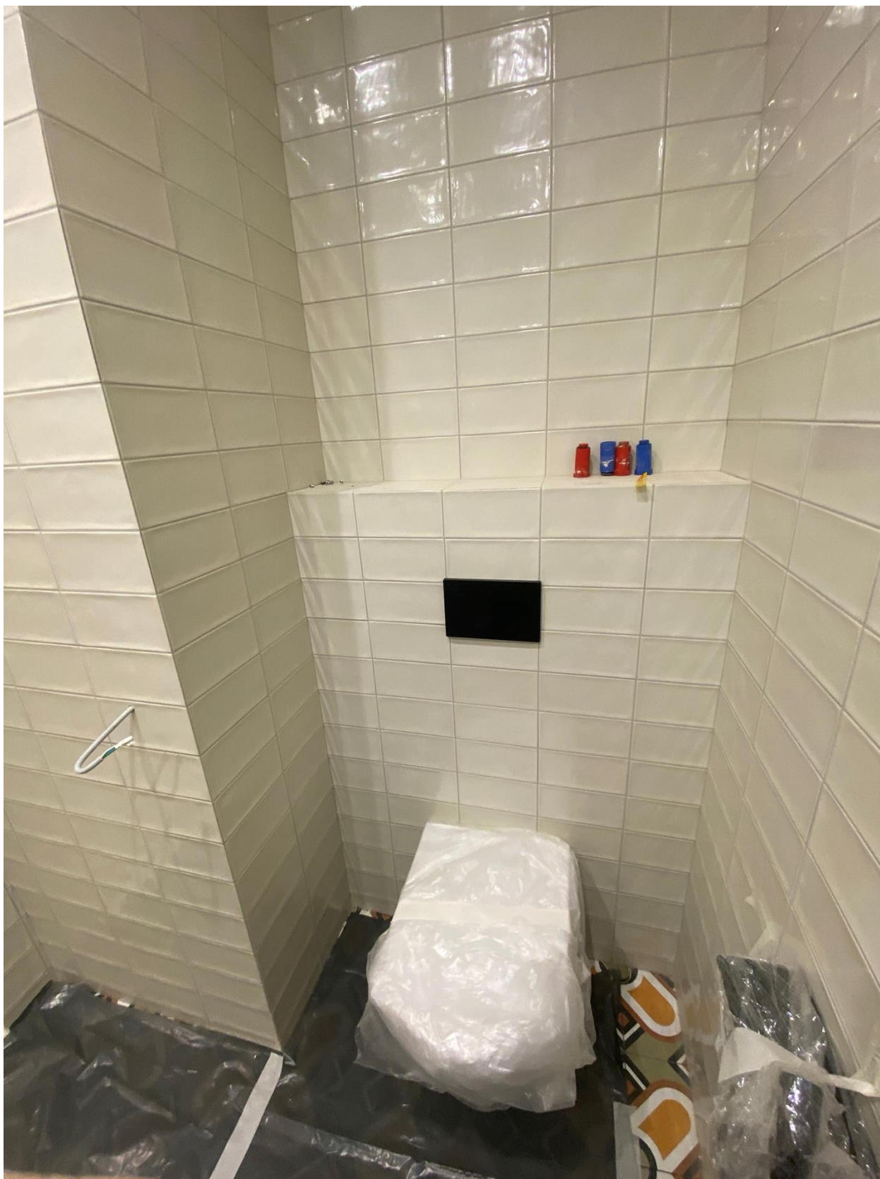
Фото 52. Вид на помещение квартиры № 45 объекта культурного наследия.
