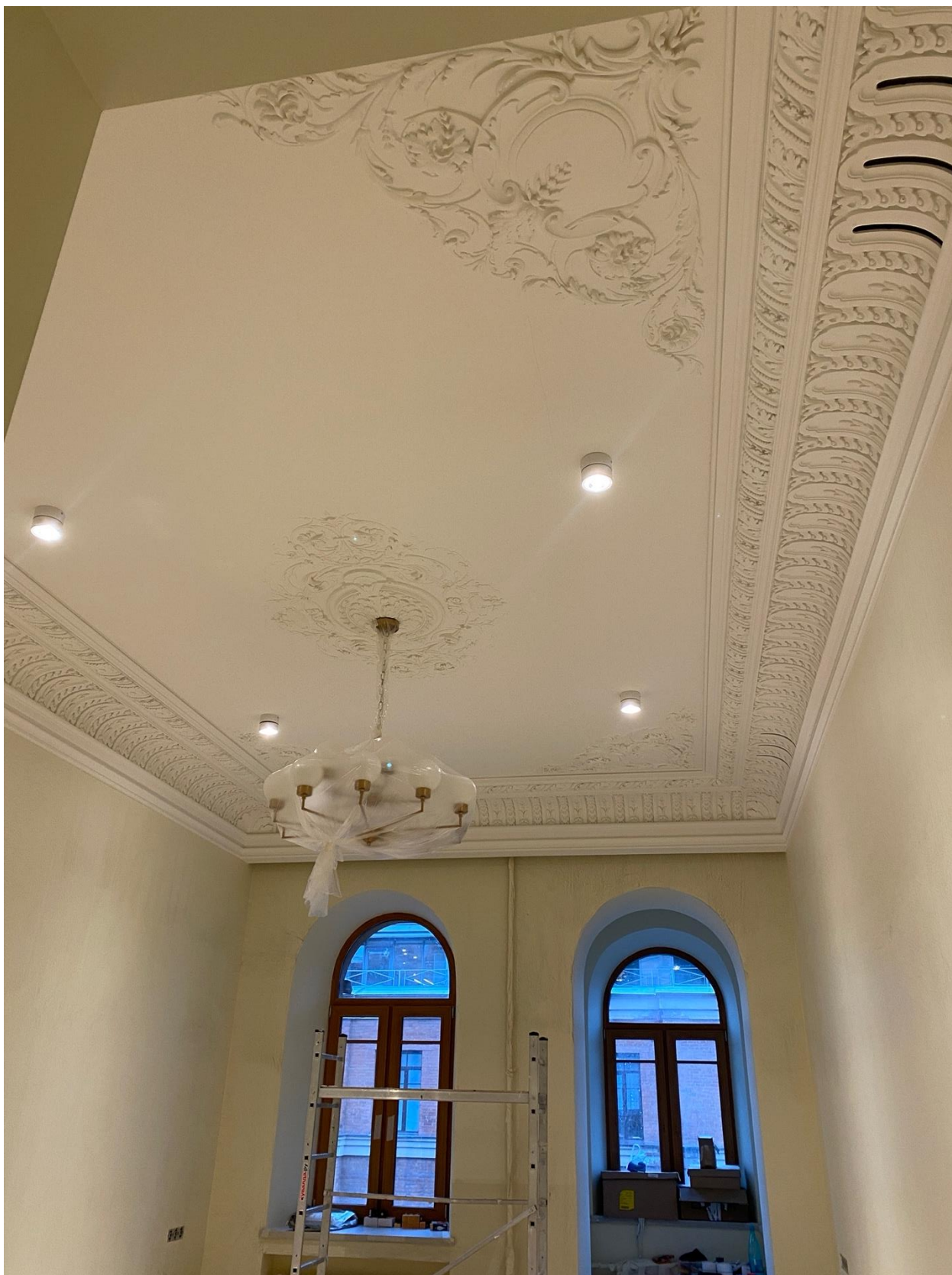
Фото 27. Общий вид потолка помещения квартиры № 45 объекта культурного наследия.
