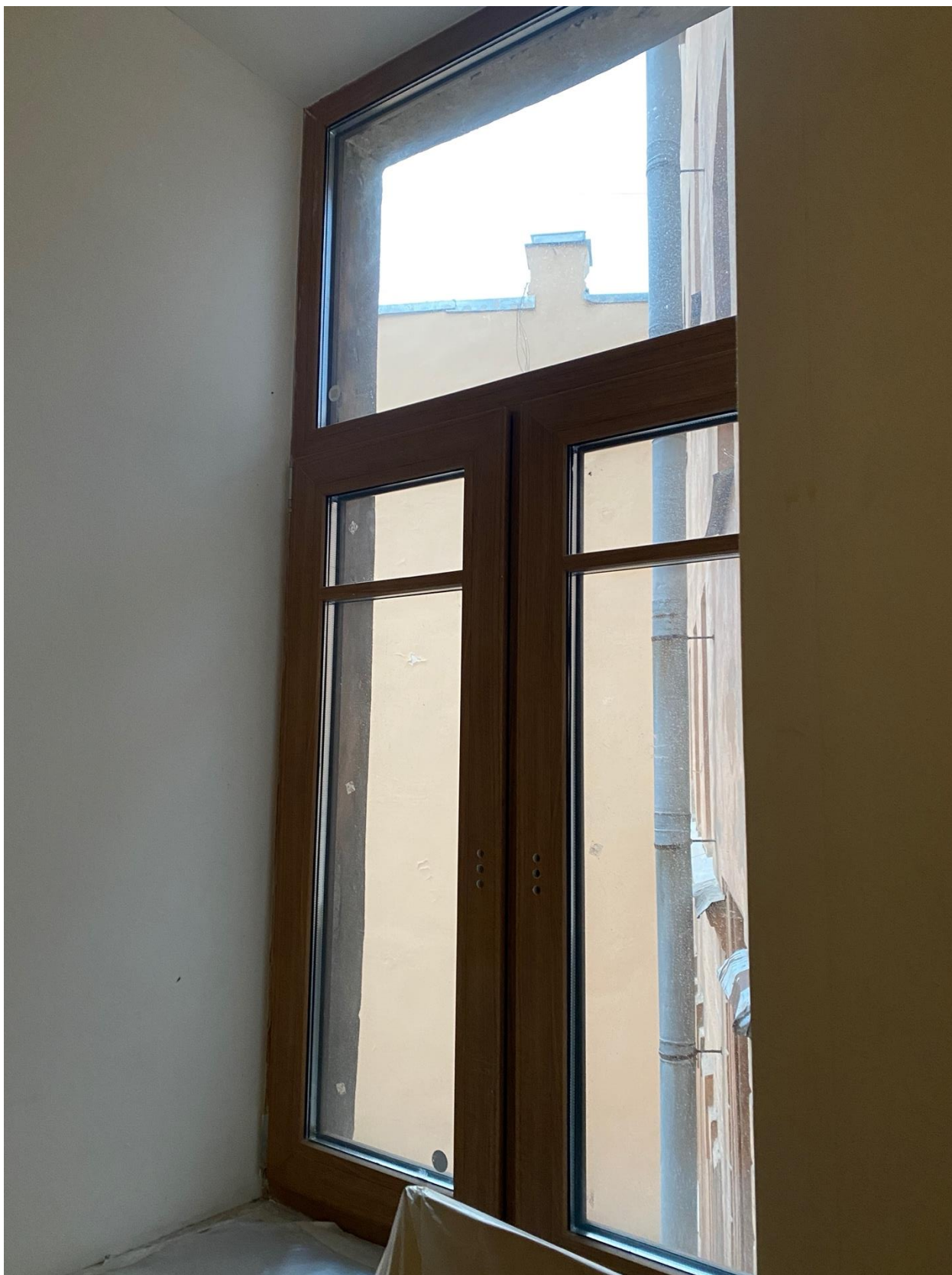
Фото 24. Вид на оконное заполнение квартиры № 45 объекта культурного наследия.
