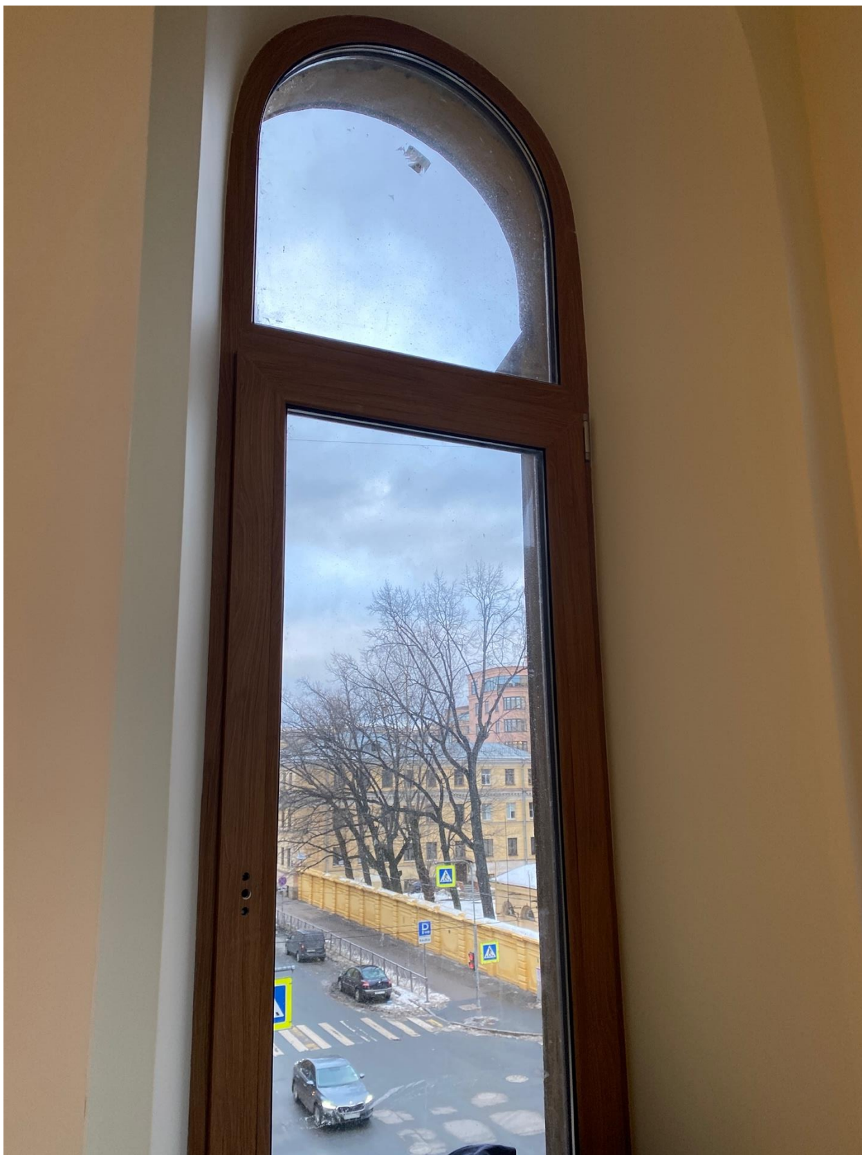
Фото 31. Вид на помещение квартиры № 45 объекта культурного наследия.
