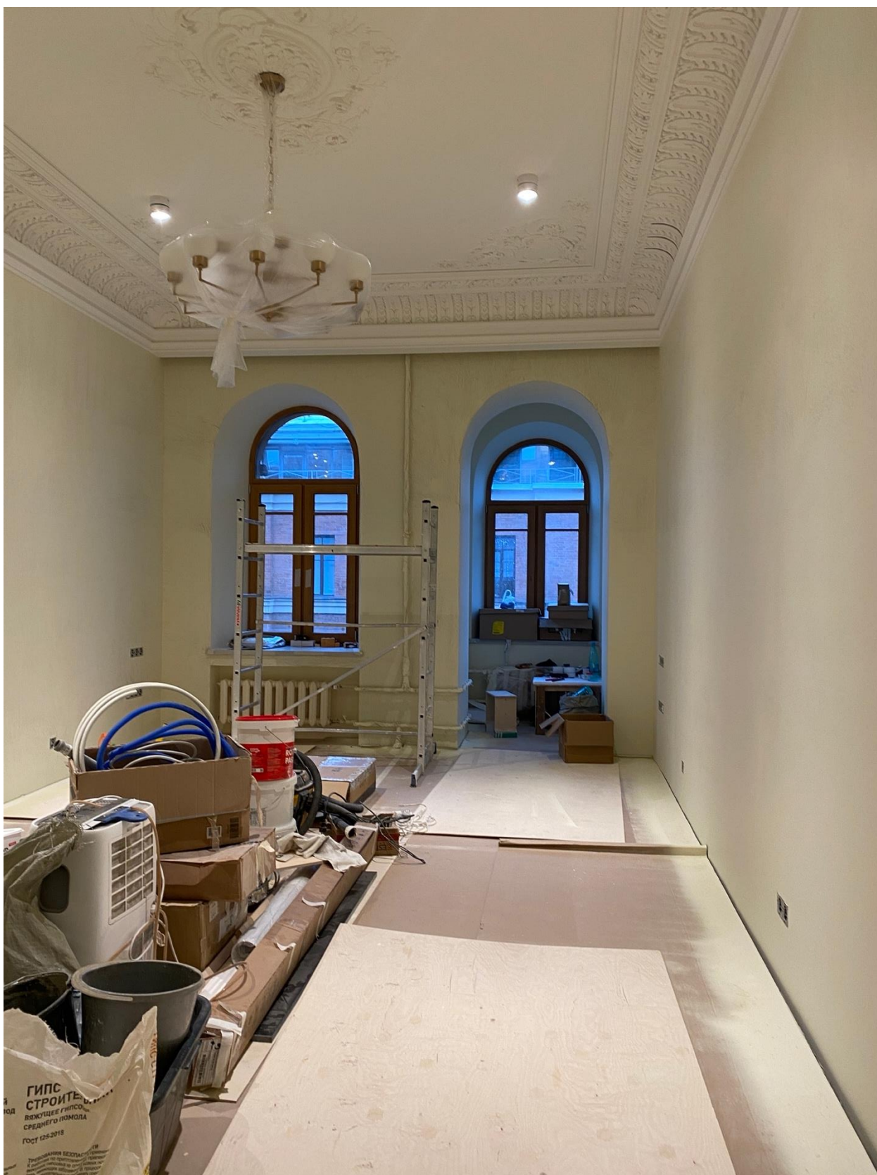
Фото 26. Вид на помещение квартиры № 45 объекта культурного наследия.
