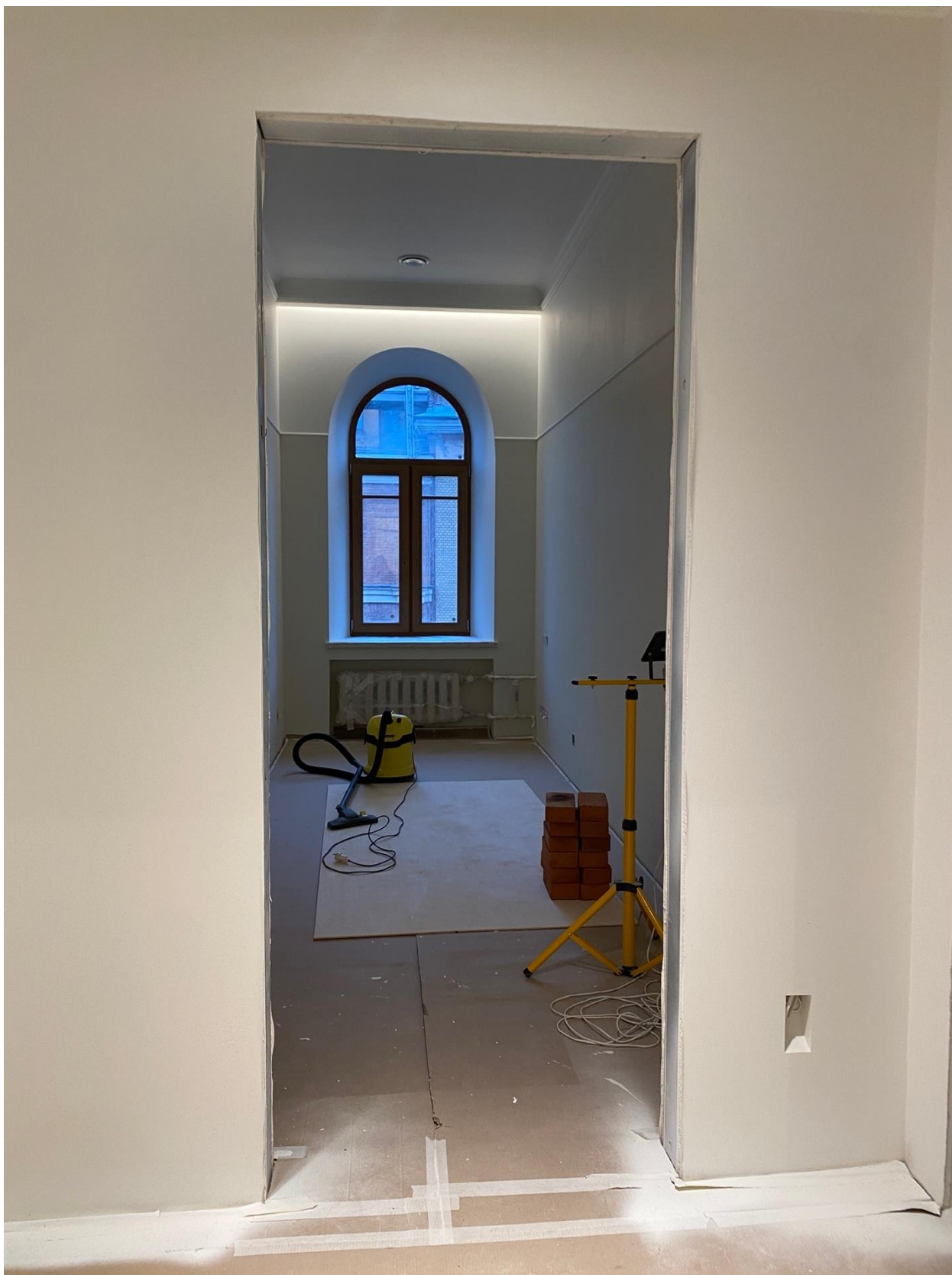
Фото 55. Вид на помещение квартиры № 45 объекта культурного наследия.
