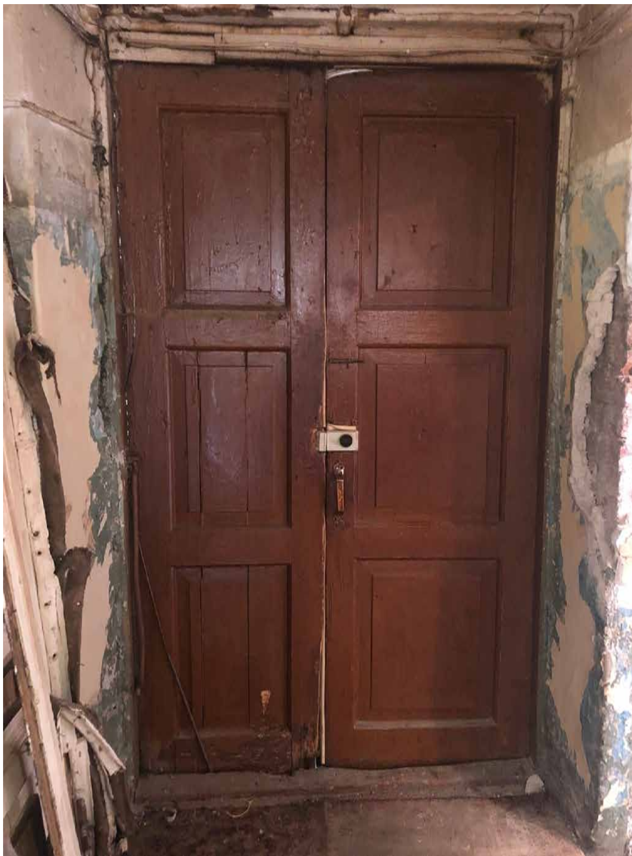
3. Вид на входную дверь в квартире;
