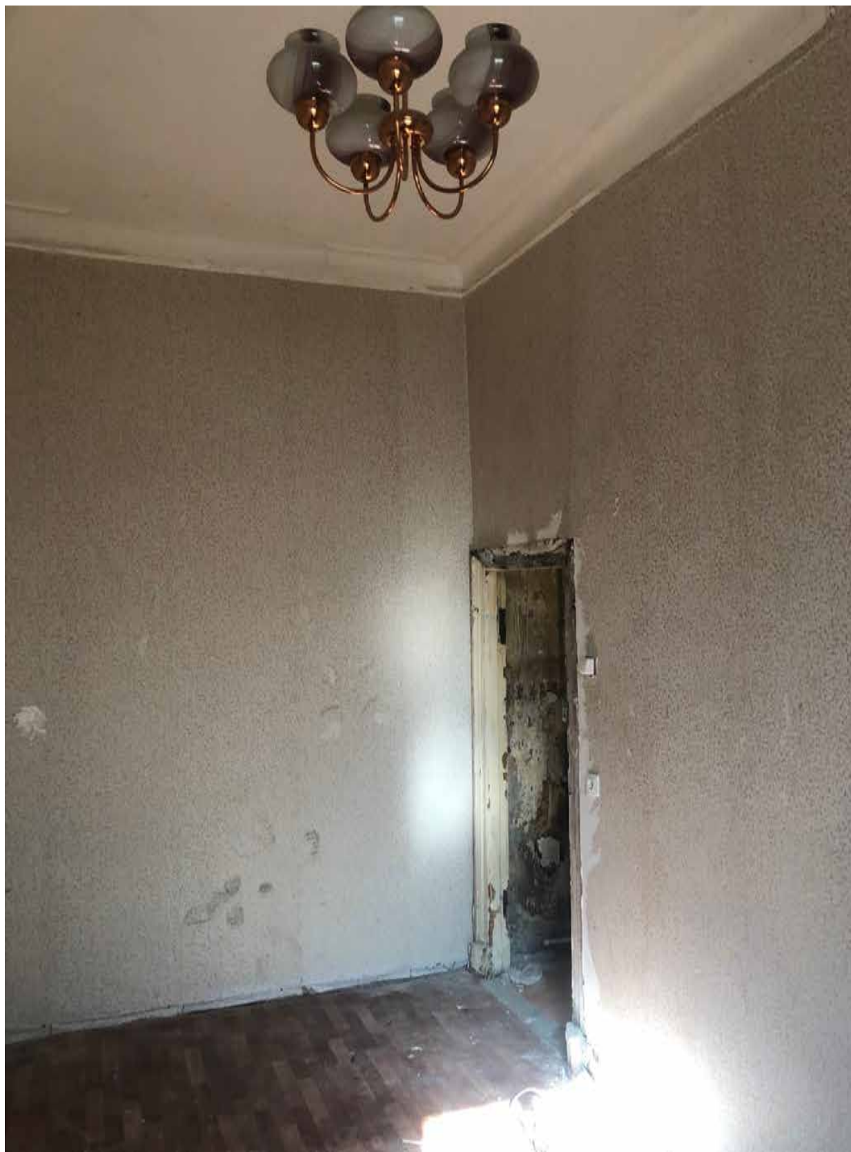
12.Фрагмент интерьера комнаты (помещение 8/12.2);
