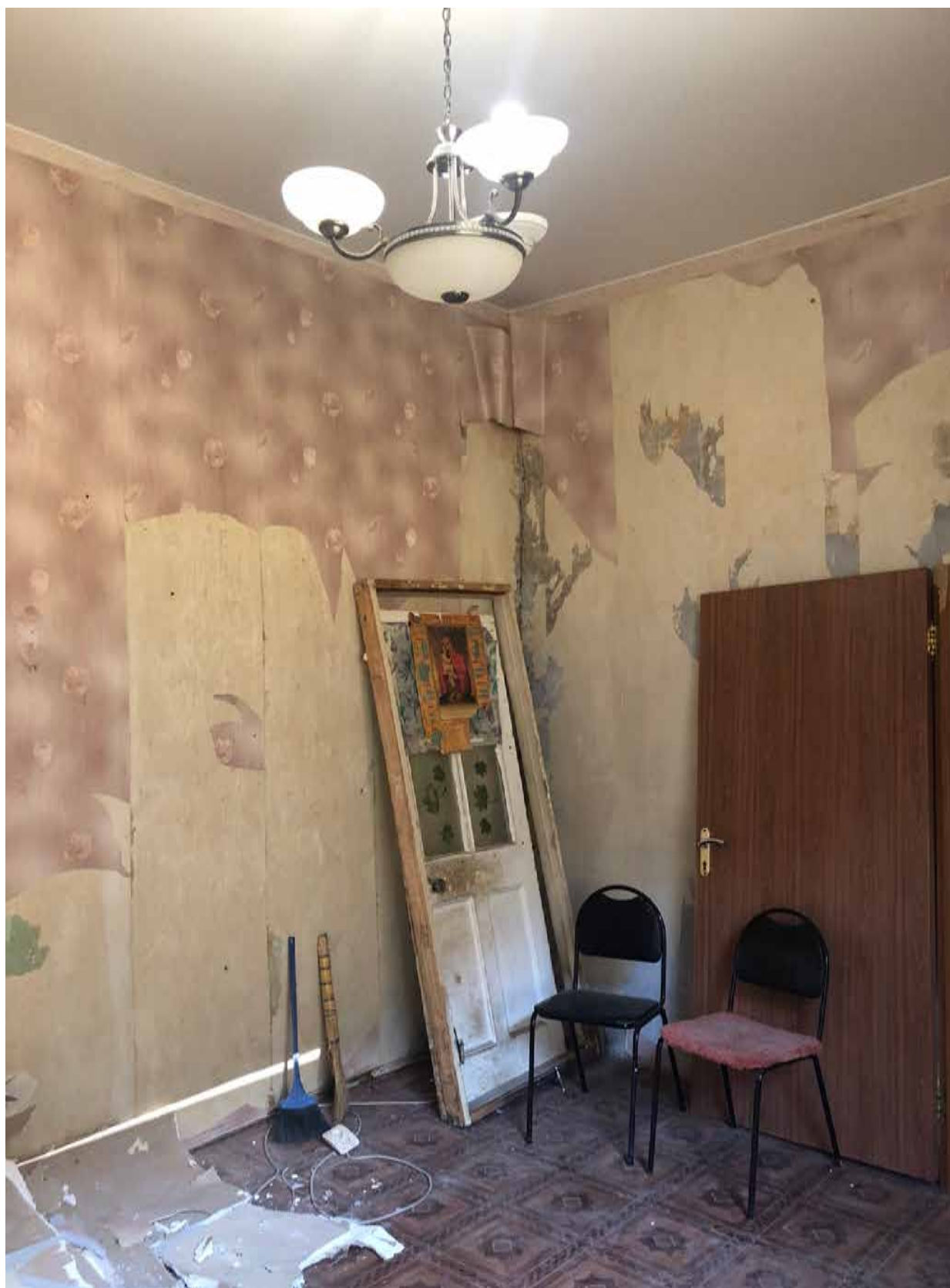
9. Фрагмент интерьера комнаты (помещение 5/17.3);
