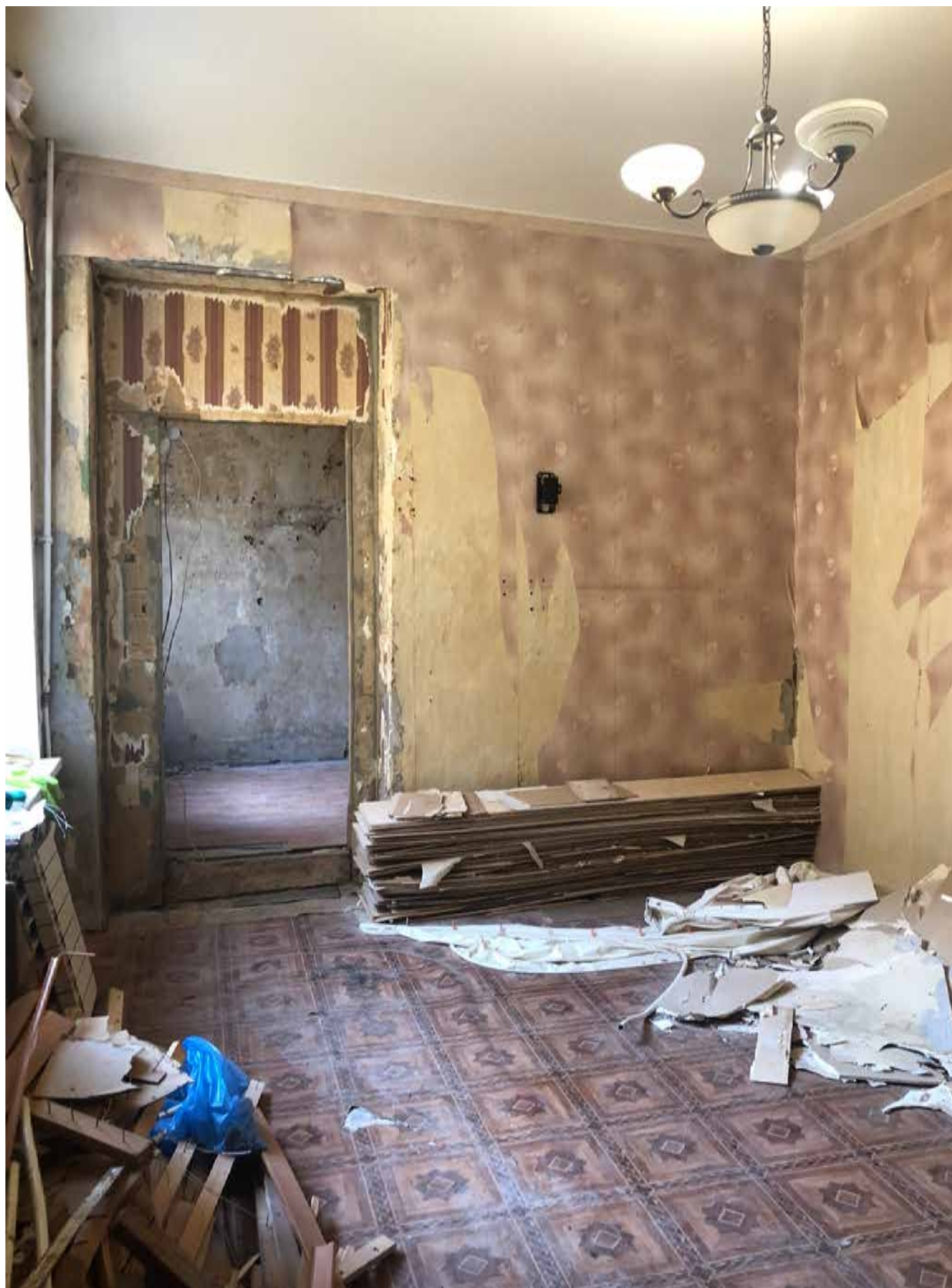
7. Фрагмент интерьера комнаты (помещение 5/17.3);
