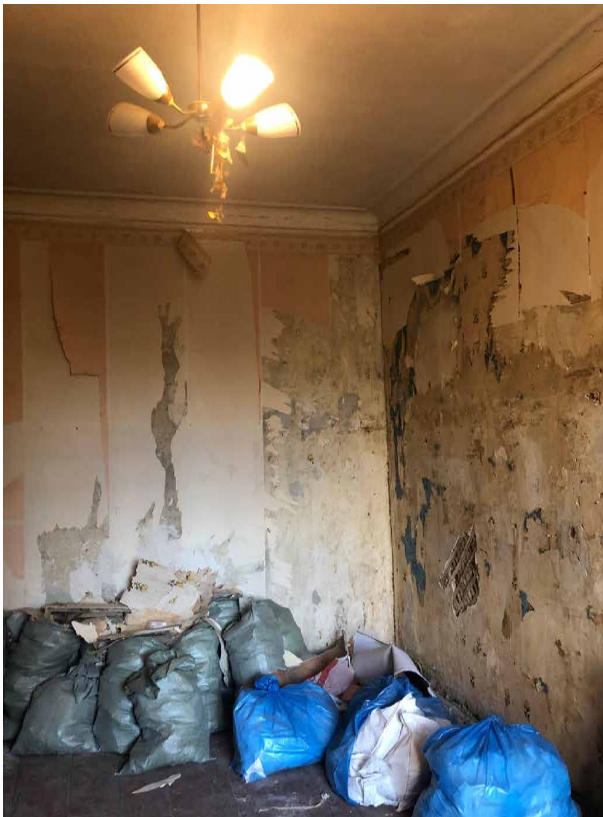
5. Фрагмент интерьера комнаты (помещение 9/19.4);
