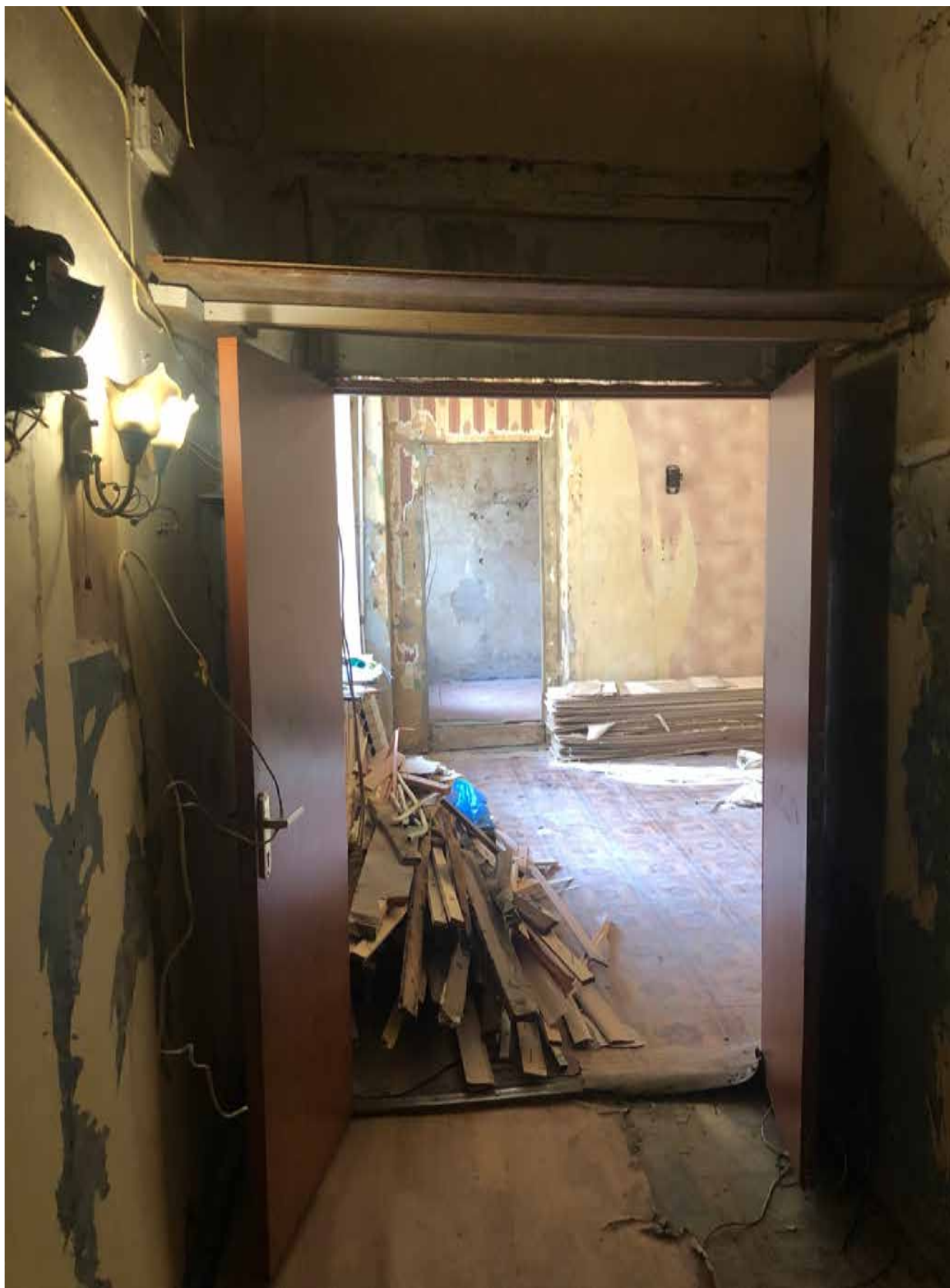
6. Фрагмент интеръера коридора (помещение 1/7.2);
