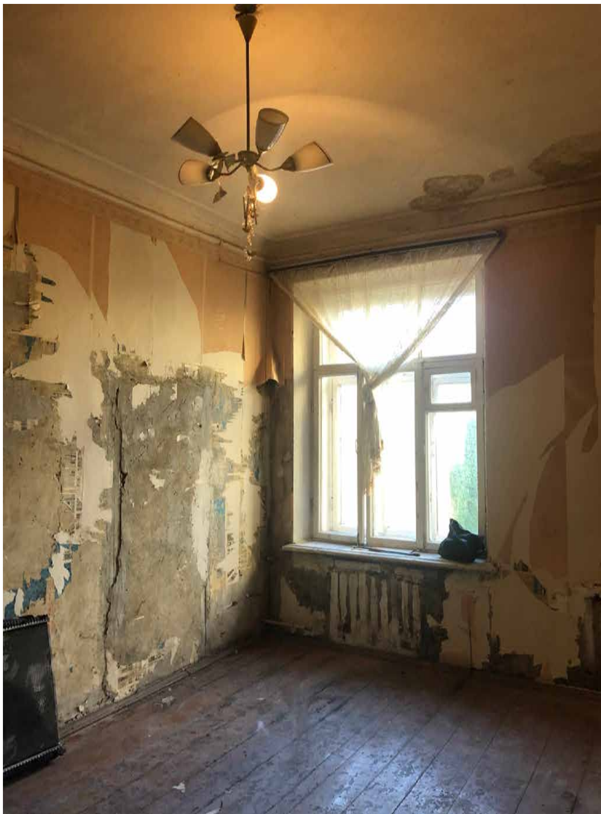
4. Фрагмент интерьера комнаты (помещение 9/19.4);
