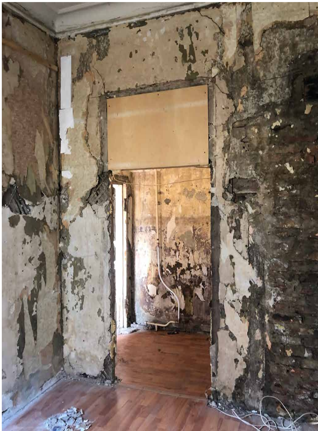
10.Фрагмент интерьера комнаты (помещение 6/10);
