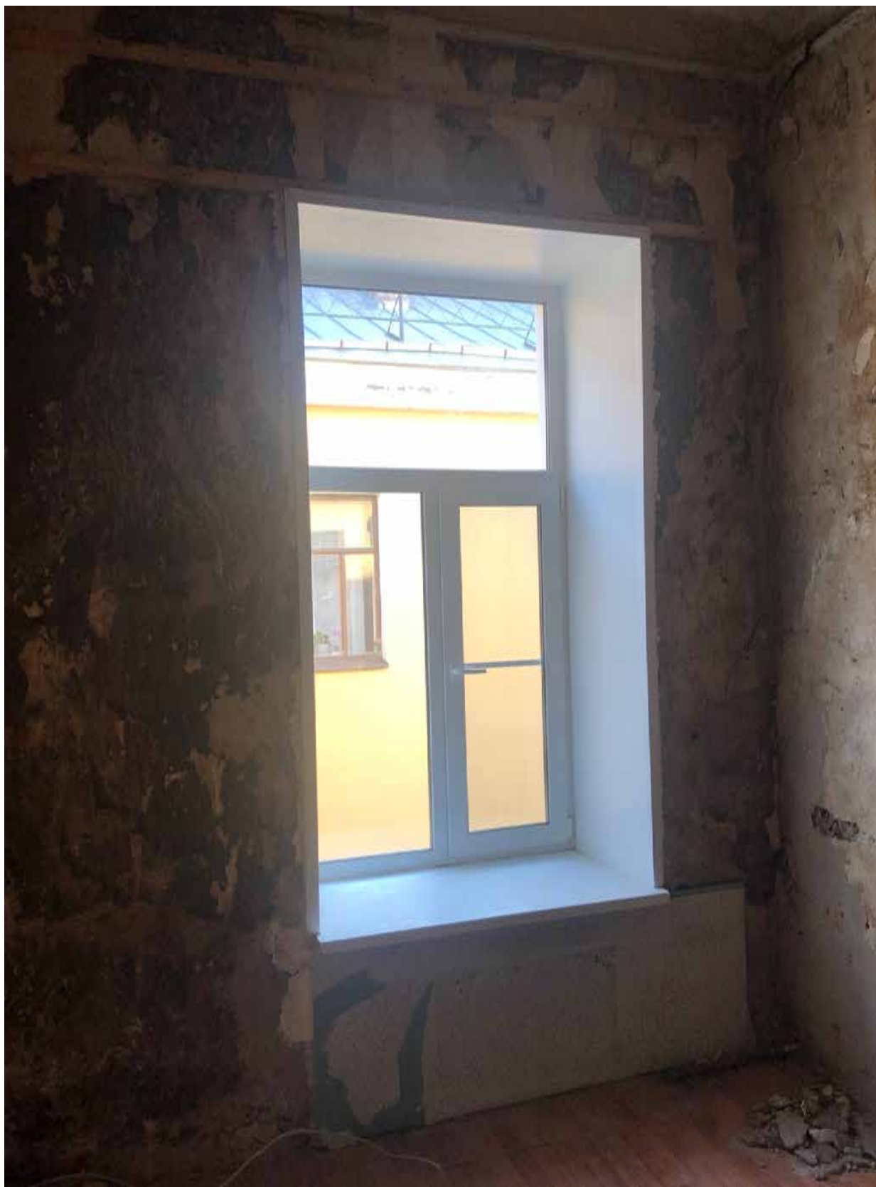
11.Фрагмент интерьера комнаты (помещение 6/10);
