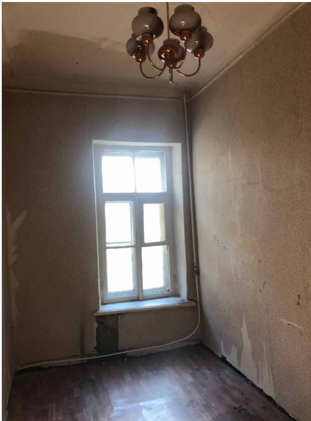
13.Фрагмент интерьера комнаты (помещение 8/12.2);
