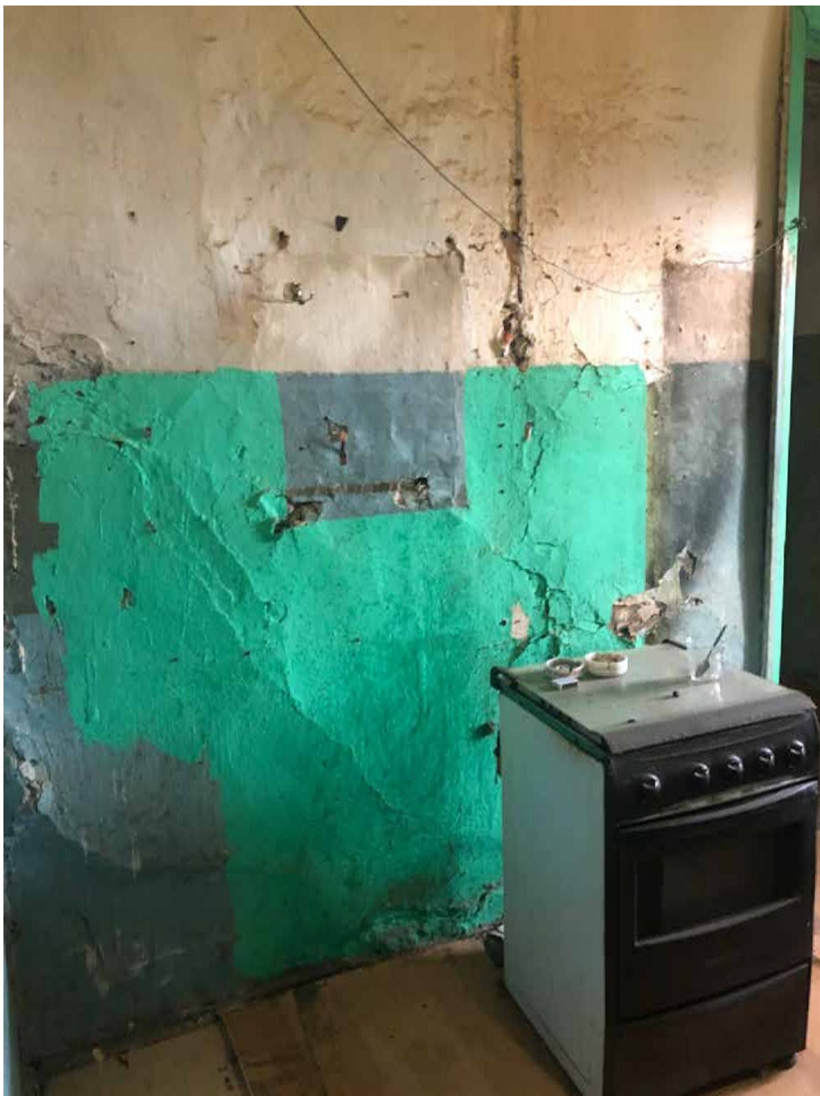
18. Фрагмент интерьера кухни (помещение 3/9.1).
