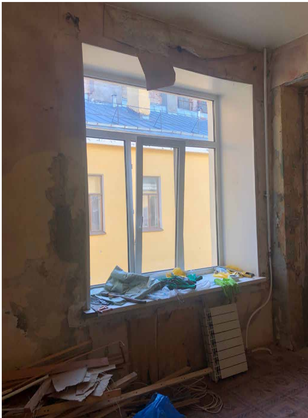
8. Фрагмент интерьера комнаты (помещение 5/17.3);
