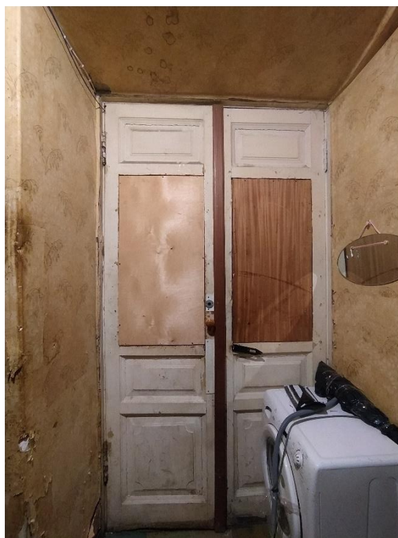
Фото 15. Вид на вход в комнату (пом. № 2).
