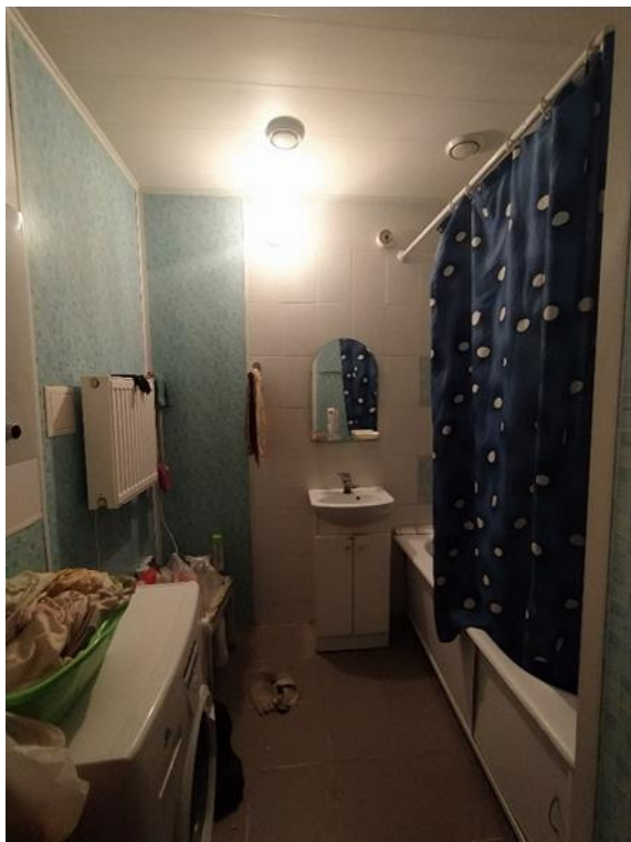
Фото 20. Общий вид ванной комнаты (пом. № 11).
