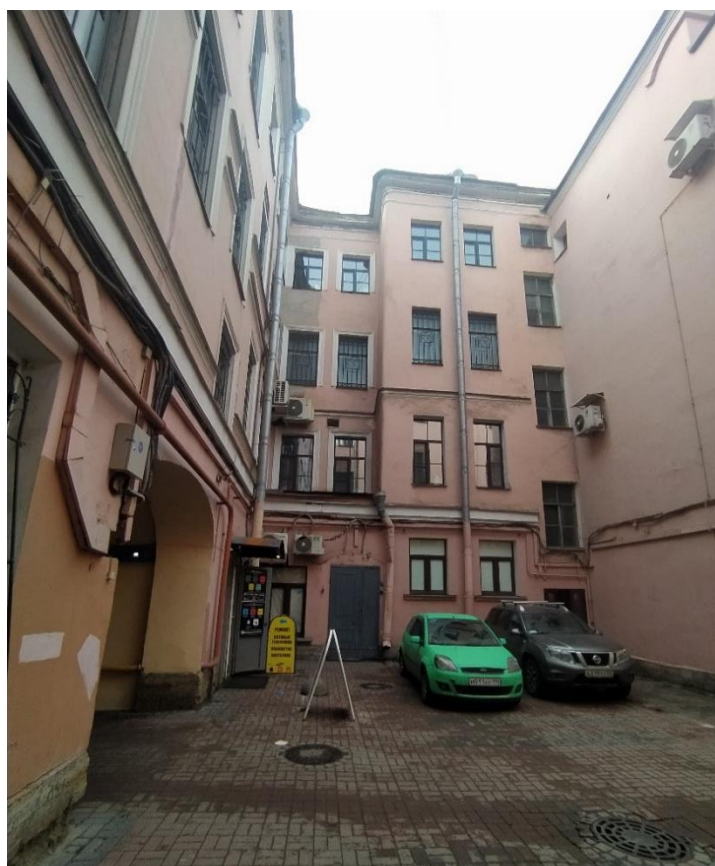
Фото 5. Вид на восточный дворовый фасад четырёхэтажного корпуса здания.
