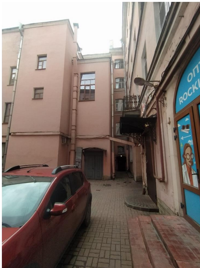
Фото 8. Боковая (западная) часть пятиэтажного дворового корпуса здания.
