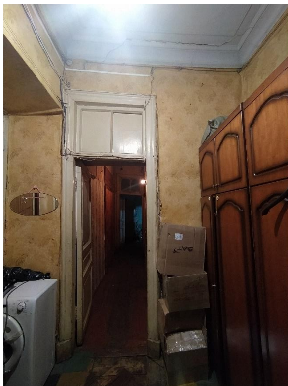
Фото 14. Вид на коридор (пом. № 1).
