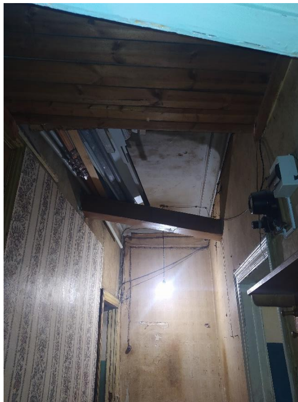
Фото 25. Вид на потолок в коридоре (пом. №7) и воздуховод, выходящий из помещения кухни (пом. № 4).
