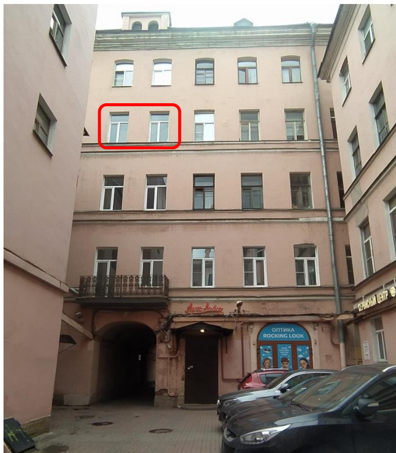
Фото 6. Южный фасад пятиэтажного дворового корпуса здания. Вид на окна квартиры №25 (на окна комнаты № 2).
