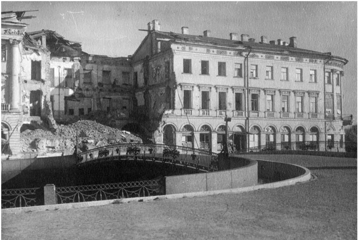
Илл.22 Разрушенный дом Адамини. 1943 г.// https://pastvu.com/
