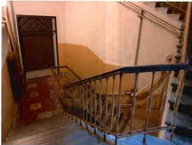
26-27. Лестничная клетка 2ЛК (17.11.2021).
