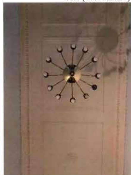
33. Промежуточная площадка 4ЛК (17.11.2021).
