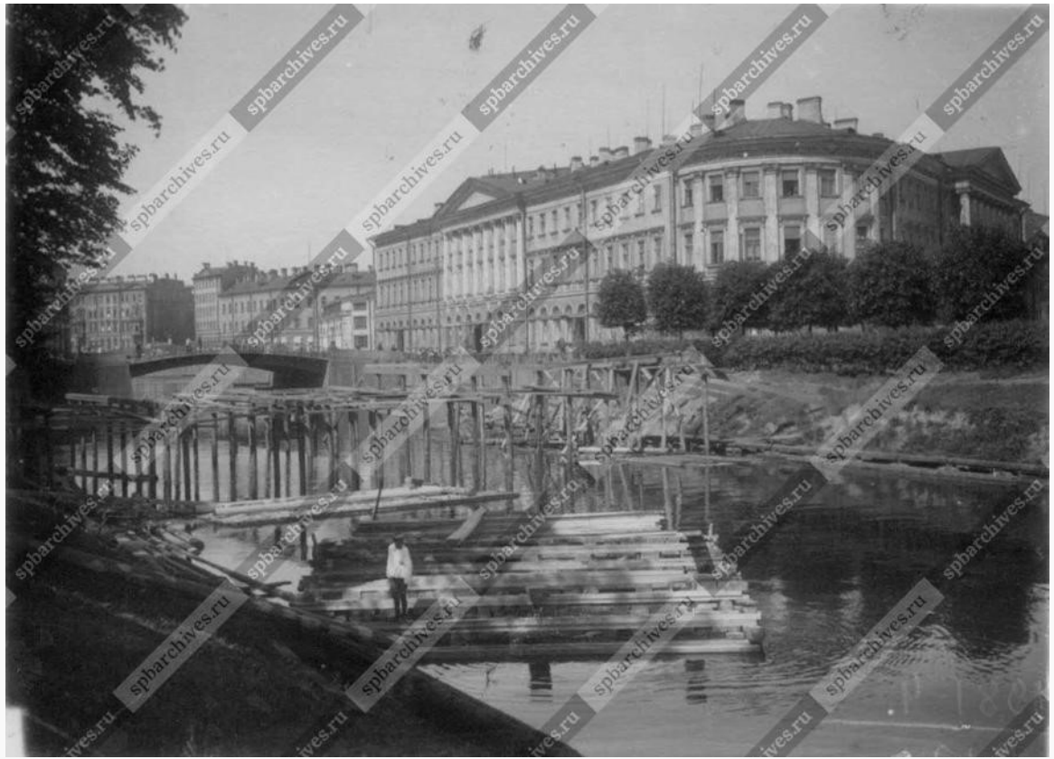
Илл. 20. Вид ремонтных работ на наб. реки Мойки. 1933г. //ЦГАКФФД СПб Вр 25087/
