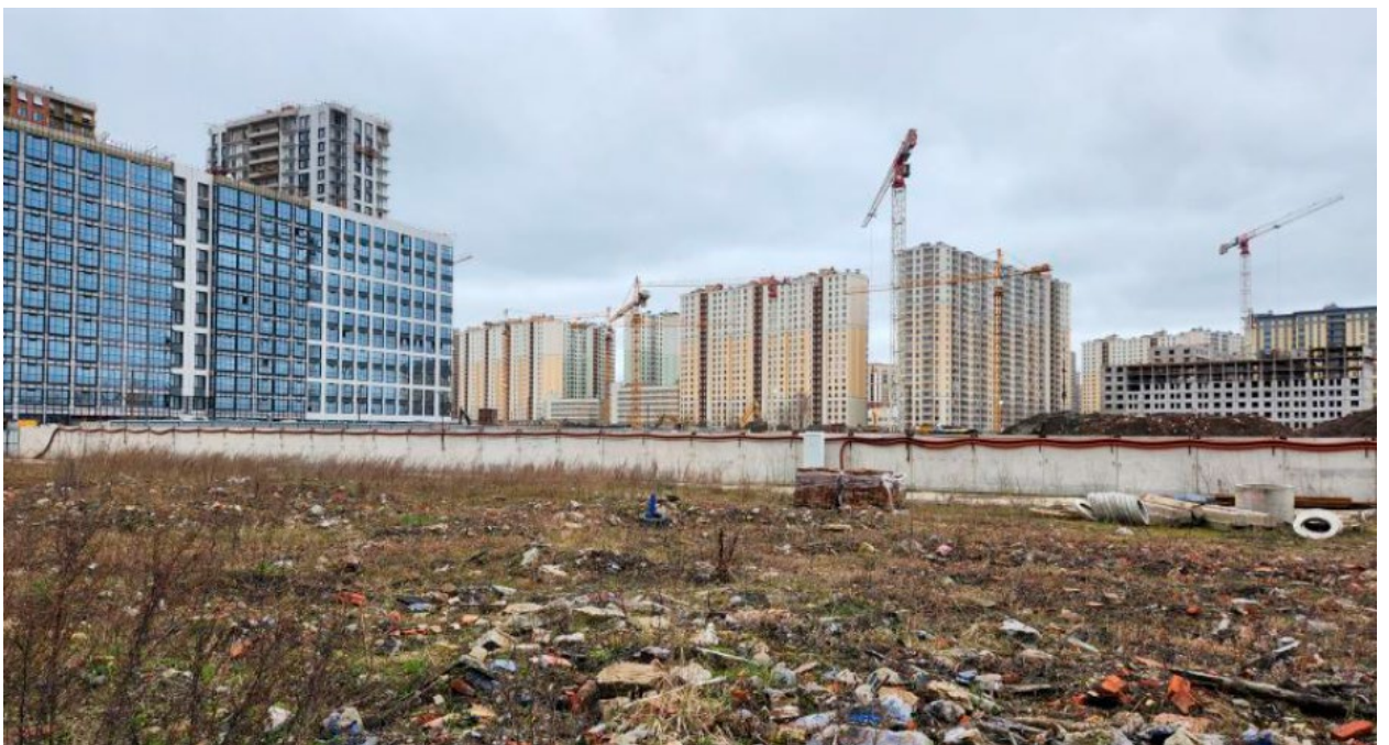
5. Вид от выявленного объекта культурного наследия «Производственное здание с дымовой трубой Киновиевского ультрамаринового завода Г.И. Вега», расположенного по адресу: г. Санкт-Петербург, Октябрьская наб., д. 38, литера АН, на зону производства работ. 22.04.2024
