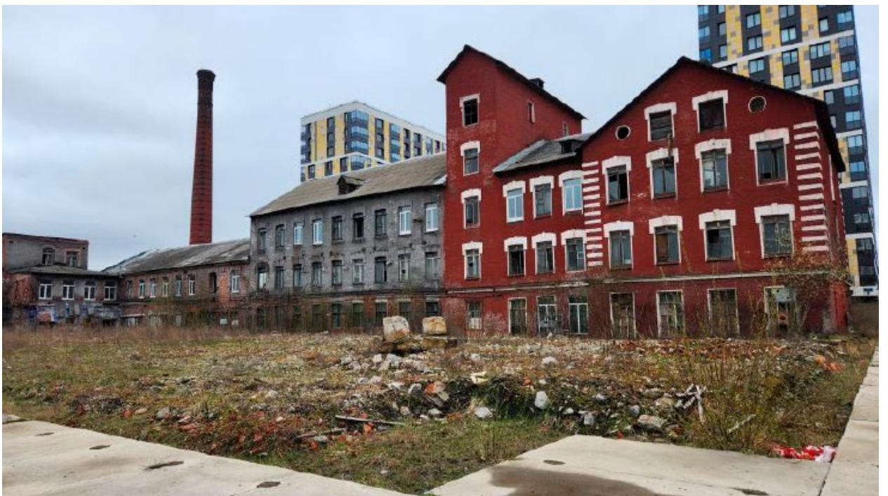
2. Вид на юго-восточный фасад выявленного объекта культурного наследия «Производственное здание с дымовой трубой Киновиевского ультрамаринового завода Г.И. Веге», расположенного по адресу: г. Санкт-Петербург, Октябрьская наб., д. 38, литера АН, от зоны производства работ. 22.04.2024
