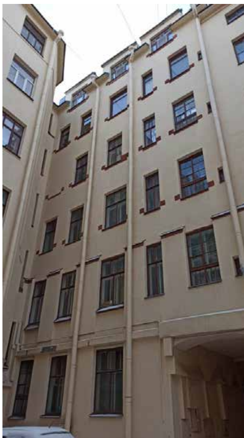
Фото 4. Фрагмент дворового фасада объекта культурного наследия регионального значения «Дом инженера А.Ф. Циммермана (лицевой дом с палисадником, ограждением палисадника и 2 флигелями)»
