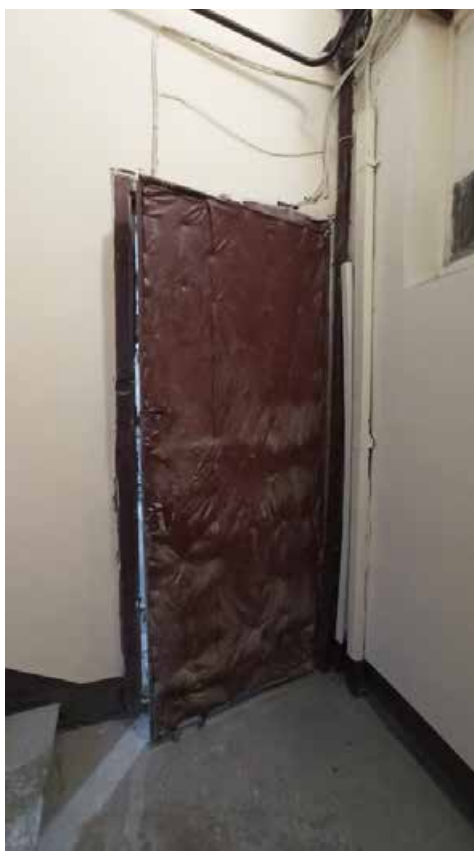
Фото 6. Интерьер квартиры № 24 объекта культурного наследия регионального значения «Дом инженера А.Ф. Циммермана (лицевой дом с палисадником, ограждением палисадника и 2 флигелями)» (второй вход)
