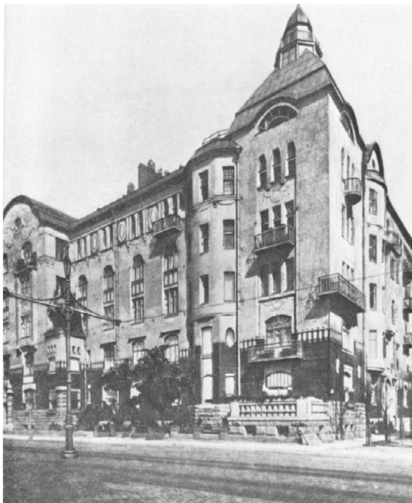
29. Жилой дом на Каменноостровском проспекте, 61. 1911 - 1915 г. г. — «PastVu» – ретро-фотографии стран и городов [Электронный ресурс]. URL: https://pastvu.com/p/134629 .
