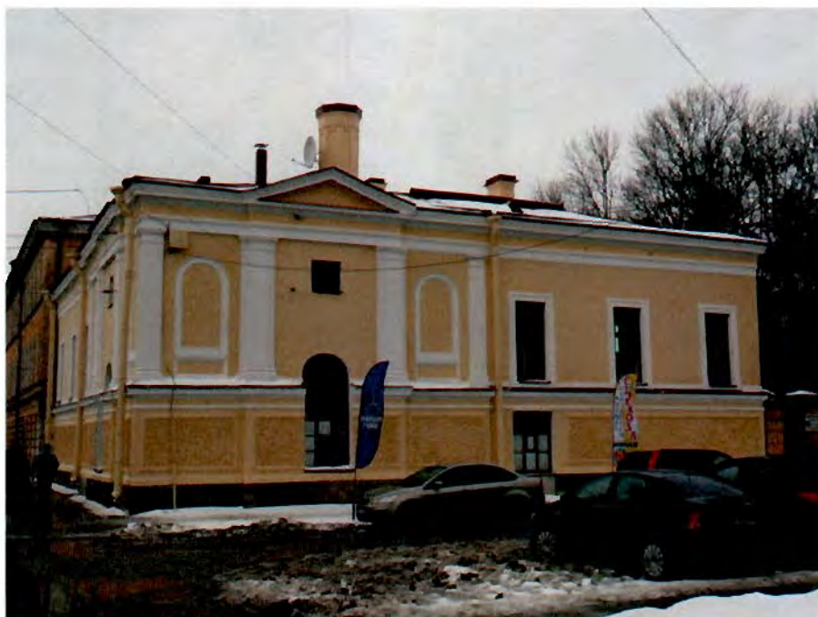
14. Восточный лицевой фасад здания.
