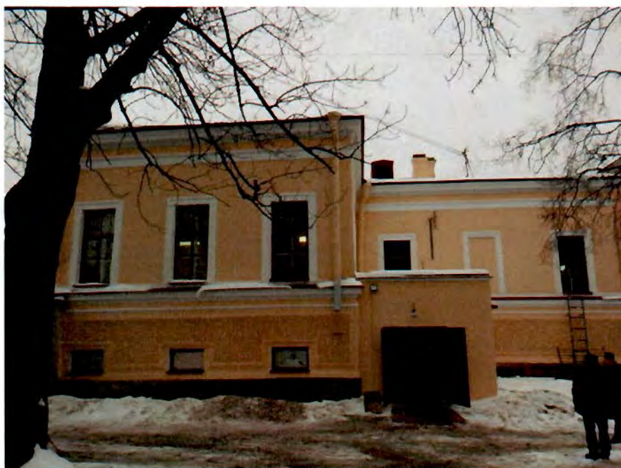
15. Северный дворовый фасад здания.
