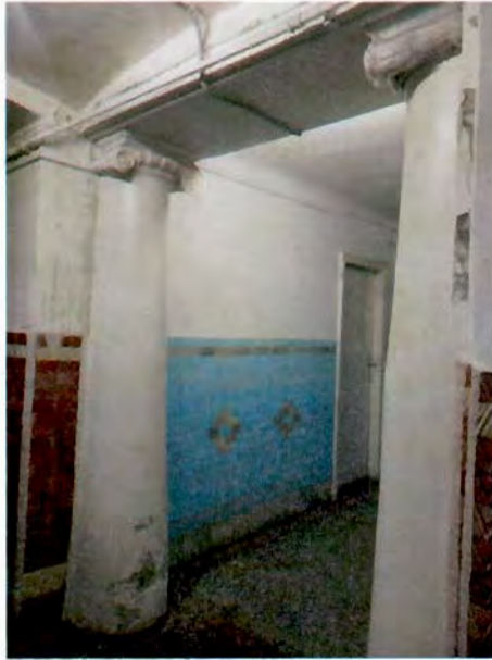
11. Фрагмент интерьера 1-го этажа здания.
