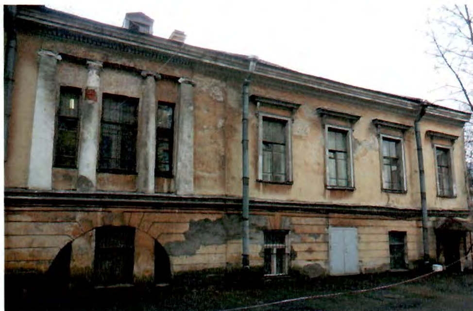
10. Фрагмент северного дворового фасада здания.
