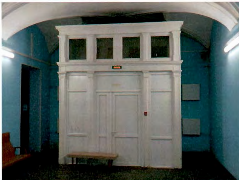
3. Тамбур парадного входа в здание.
