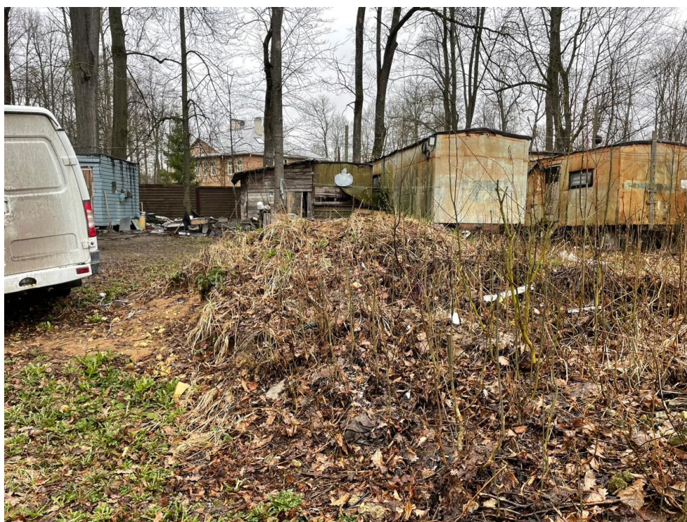
Фото 3. Объект культурного наследия федерального значения «Дача Юсуповой», входящий в состав объекта культурного наследия федерального значения «Отдельный парк», расположенный по адресу: Санкт-Петербург, г. Пушкин Павловское шоссе, 10, 12. Вид на северный участок территории дачи Юсуповой З.И.(у временного забора стоят строительные вагончики)
