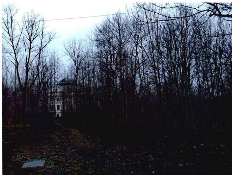
3. Центральная часть объекта культурного наследия.
