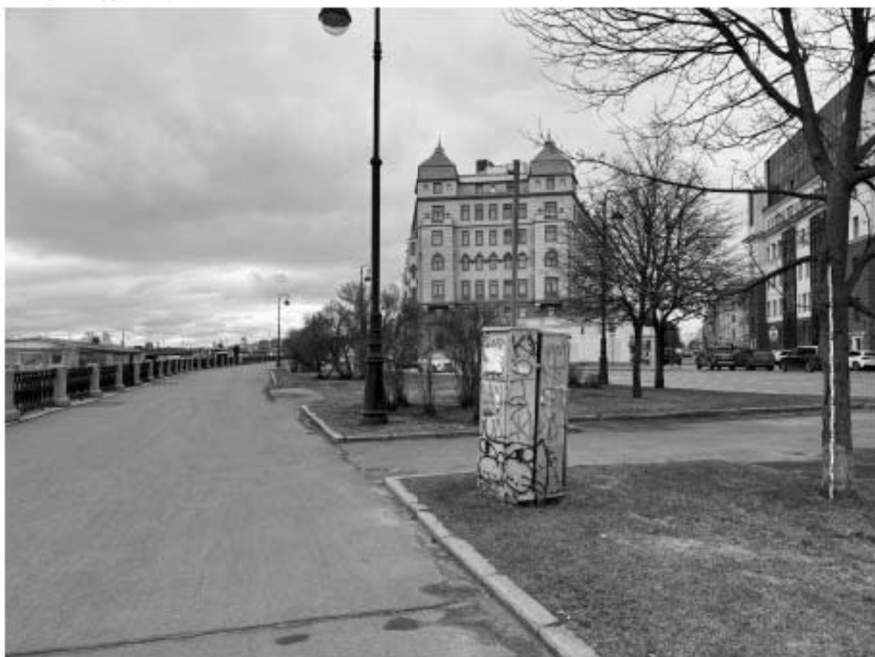
Ил. 41. Точка фотофиксации 19. Южная часть участка обследования. Наб. Макарова, 2-я и 3-я линии В.О. Общий вид с ЗСЗ.
