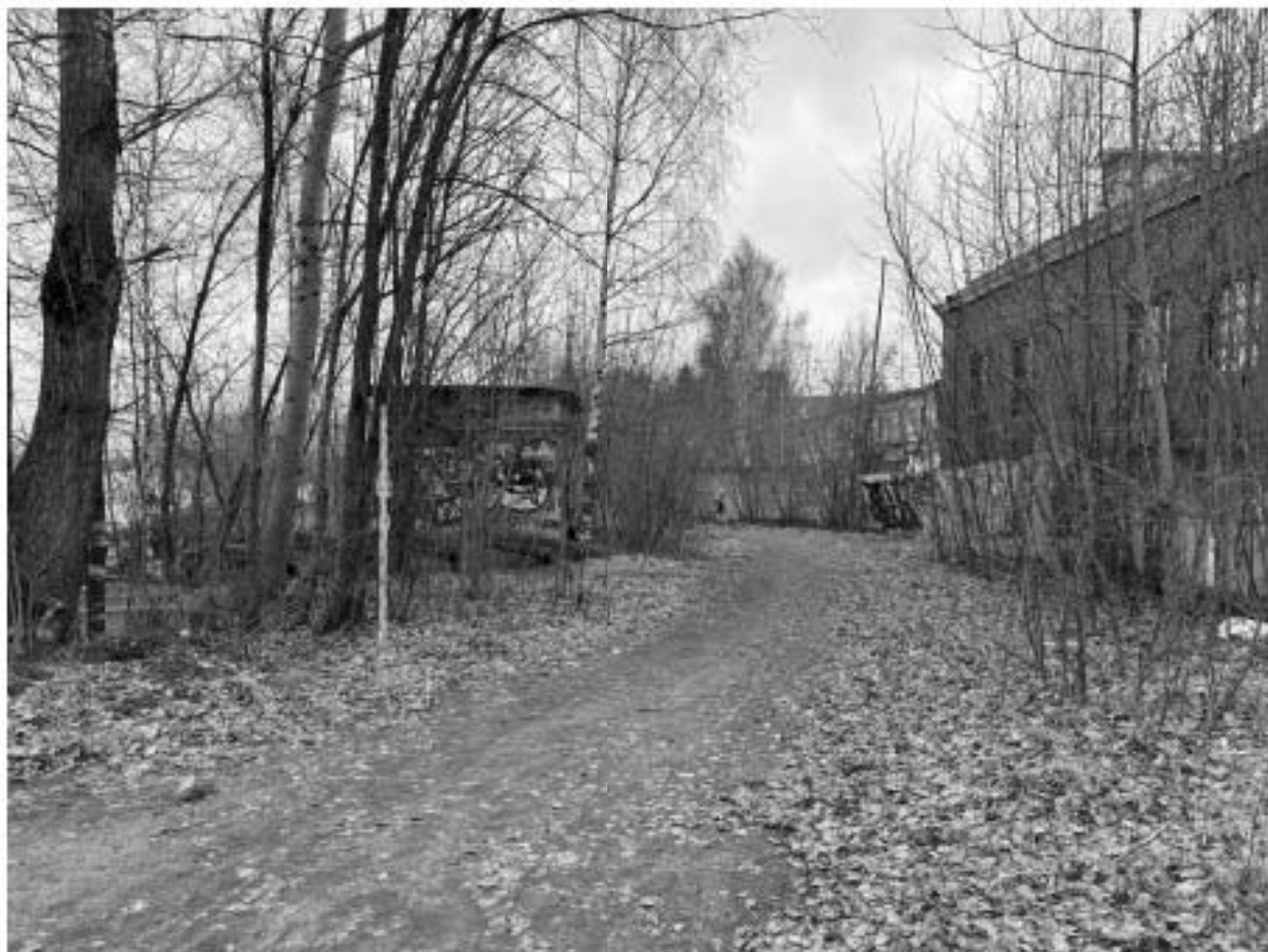
Ил. 22. Точка фотофиксации 5. Северная часть участка обследования. Общий вид с СЗ на строение водозабора, справа - застройка соседнего участка, ограниченного забором.
