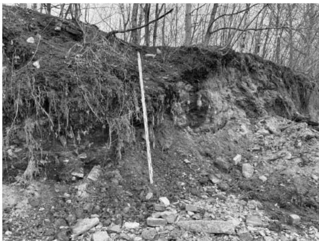
Ил. 29. Точка фотофиксации 11. Осыпи берега, состоящего из насыпного привозного грунта. Вид с В.
