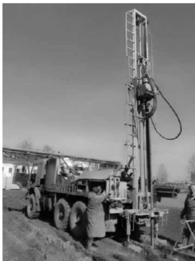
Рисунок 4.1.2 - Бурение скважин на участке изысканий (фотофиксация)
