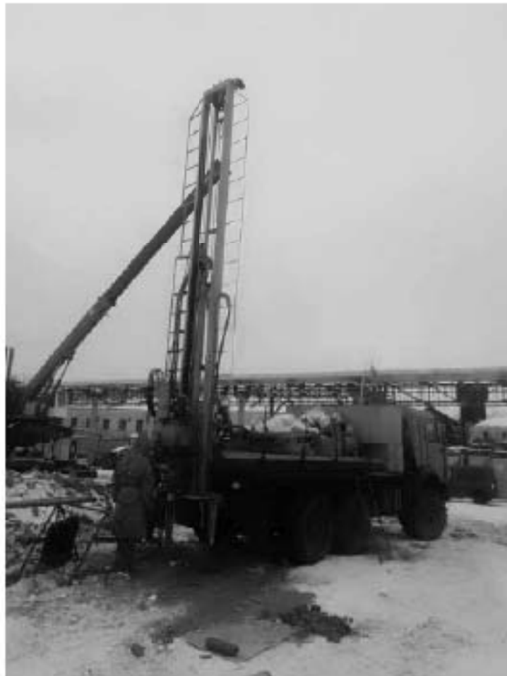
Рисунок 4.1.1 - Бурение скважин на участке изысканий (фотофиксация)
