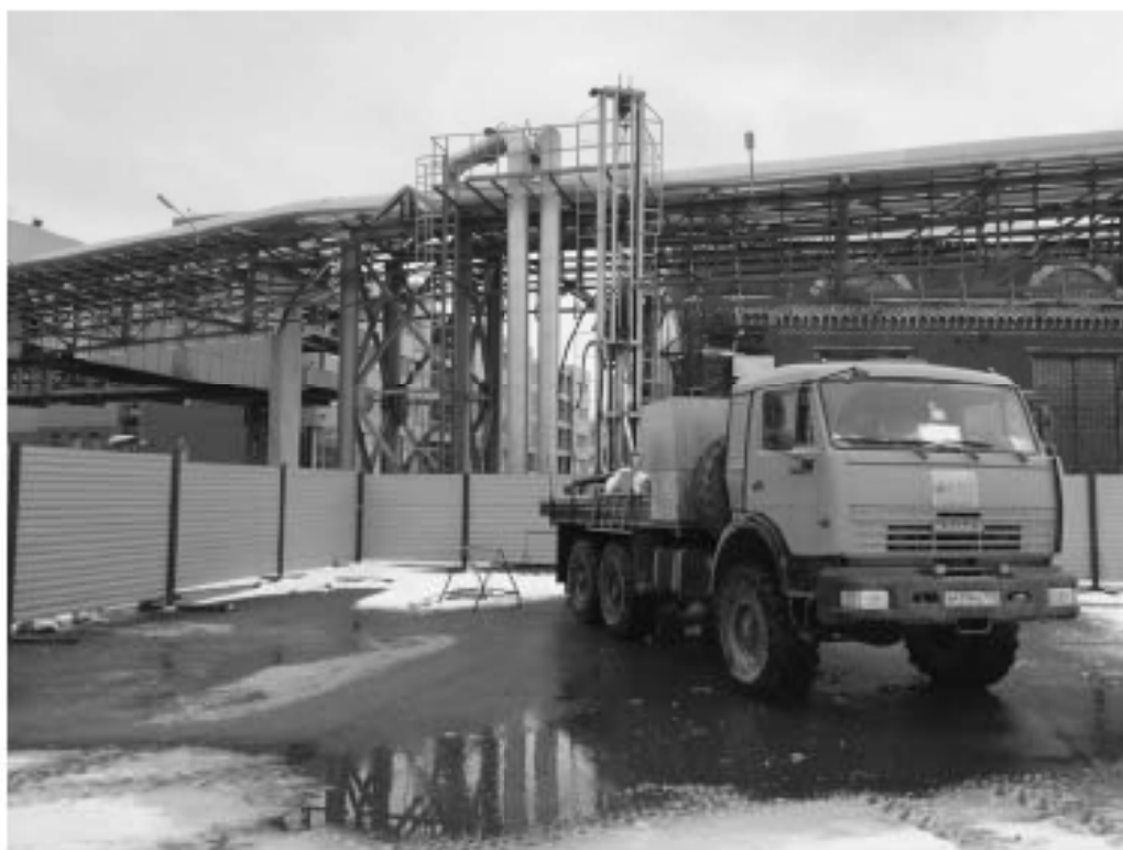
Рисунок 4.1.1 - Бурение скважин на участке изысканий (фотофиксация)
