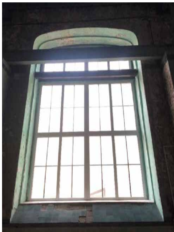
Фото 12. Окно в машинном зале.
