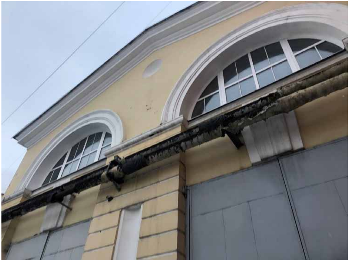
Фото 8. Вид на часть западного фасада.
