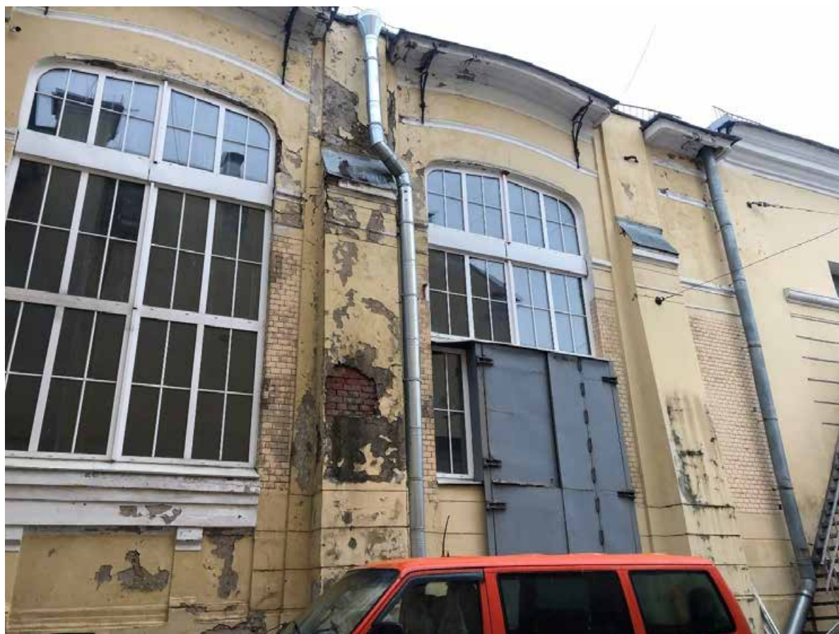
Фото 6. Вид на северный фасад.
