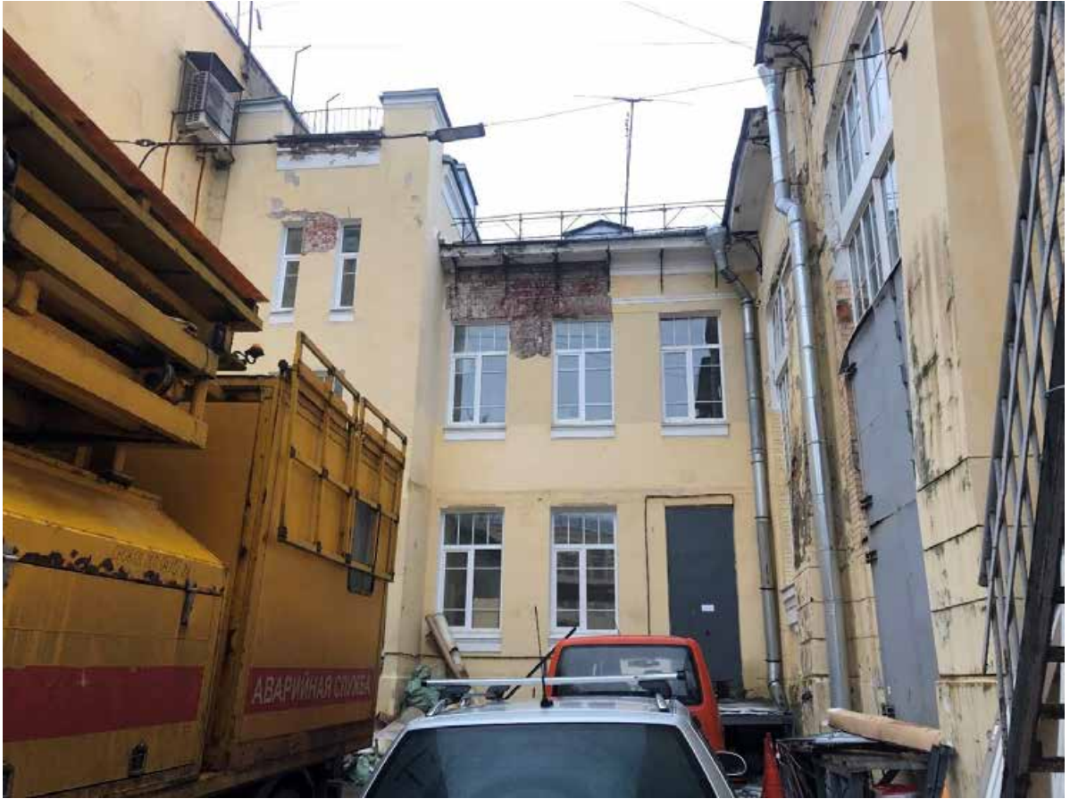
Фото 7. Вид на часть западного фасада.
