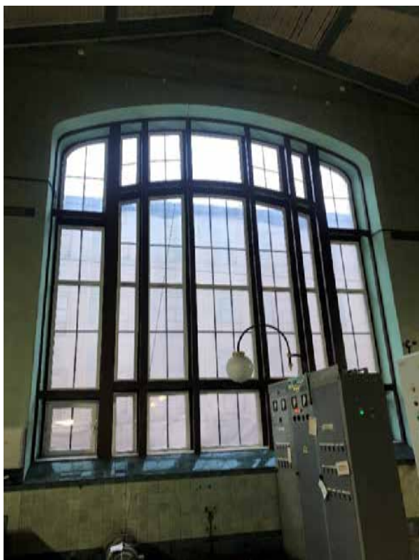
Фото 9. Витражное окно в машинном зале.
