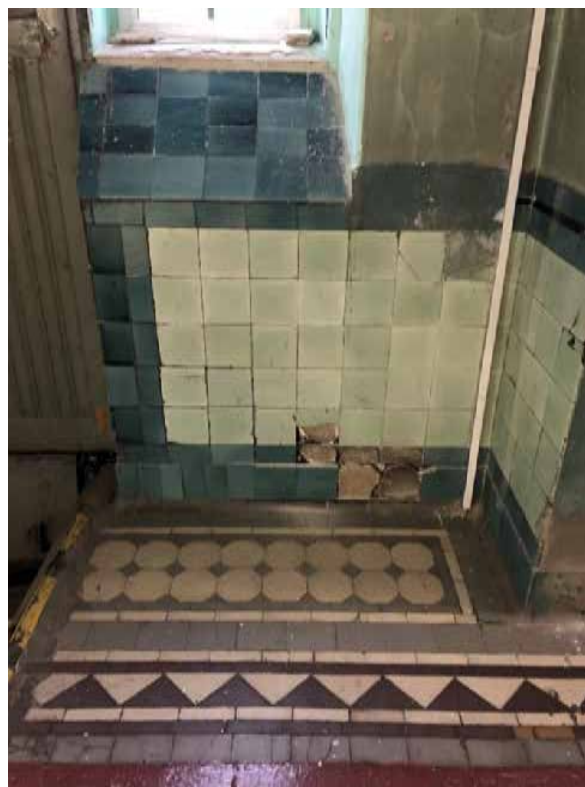
Фото 13. Часть машинного зала.
