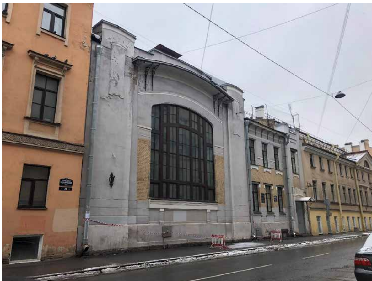
Фото 2. Вид на лицевой фасад исследуемого здания со стороны Большой Подьяческой улицы.
