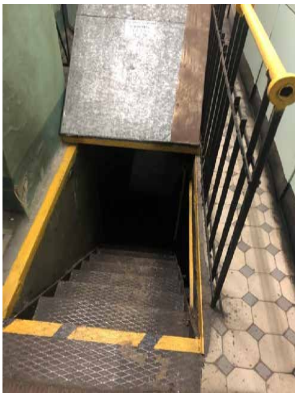
Фото 14. Вид на лестницу в подвал.
