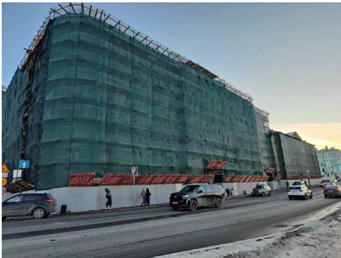
Фото 3 Лицевой фасад объекта культурного наследия федерального значения «Дом Бецкого И.И. (принца Ольденбургского П.Г.)» (по Дворцовой набережной)
