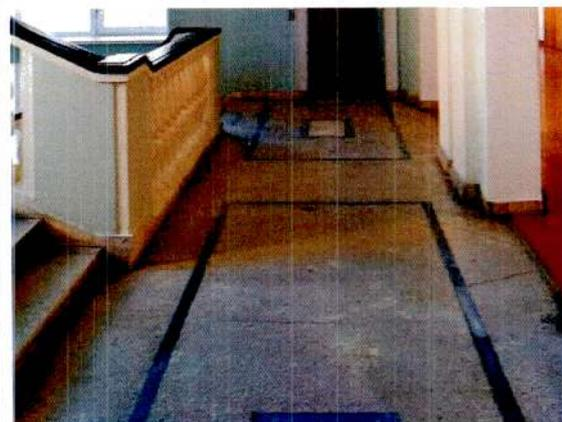
лестницы (Л-1, Л-8, Л-9, Л-10, Л-11, Л-12, Л-17, Л-22) – конструкция (по металлическим косоурам), конфигурация (трехмаршевые), материал покрытия ступеней и площадок, ограждение (материал, конфигурация, рисунок), оформление нижних поверхностей маршей и потолков перекрытий;
