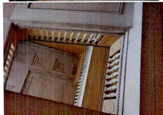
лестницы вестибюлей северного и южного корпусов – конструкция, конфигурация (один широкий лестничный марш и два боковых марша на 2-й этаж), форма ступеней, материал облицовки ступеней (мрамор);
