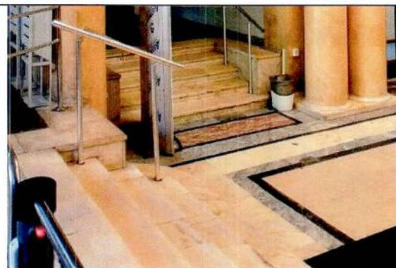
две распашные многомаршевые с промежуточными площадками лестницы южного и северного корпусов (Л-2, Л-7) – конструкция (по металлическим косоурам), балюстрада ограждения (профиль, исторический вид материала), материал покрытия ступеней (бетон с мраморной крошкой), покрытие площадок (террацо, геометрический рисунок), рисунок лепной отделки нижних поверхностей маршей и потолков перекрытий («бусь», «ионик», кессоны, розетки, филенки);
