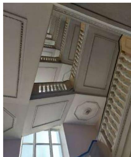
лестницы вестибюлей северного и южного корпусов – конструкция, конфигурация (один широкий лестничный марш и два боковых марша на 2-й этаж), форма ступеней, материал облицовки ступеней (мрамор);
