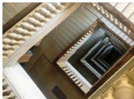
лестницы восточного корпуса, расположенные по окружности (Л-18, Л-19, Л-20, Л-21)\* - конструкция (по металлическим косоурам), конфигурация, материал покрытия ступеней (бетон с мраморной крошкой);
