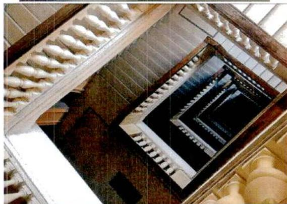
лестницы восточного корпуса, расположенные по окружности (Л-18, Л-19, Л-20, Л-21)\* - конструкция (по металлическим косоурам), конфигурация, материал и рисунок покрытия площадок, балюстрадное ограждение - материал (дерево) профиль балясин, оформление нижних поверхностей маршей и потолков перекрытий;
