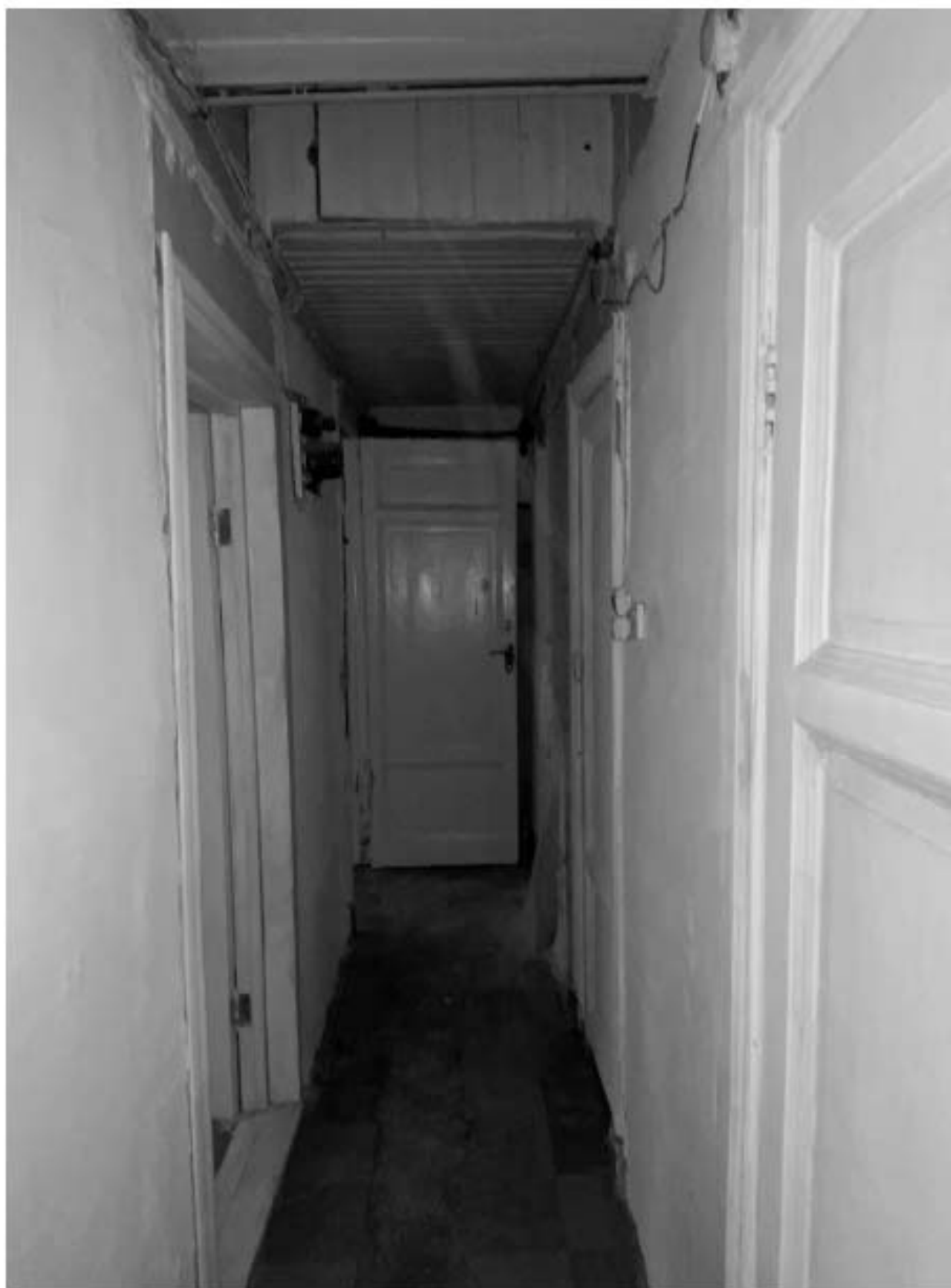
10. Фрагмент интерьера коридора (помещение 8/3.9);
