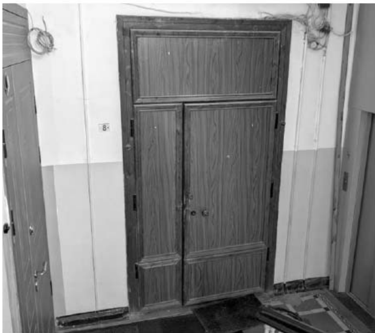
3. Вид на входную дверь в квартиру;
