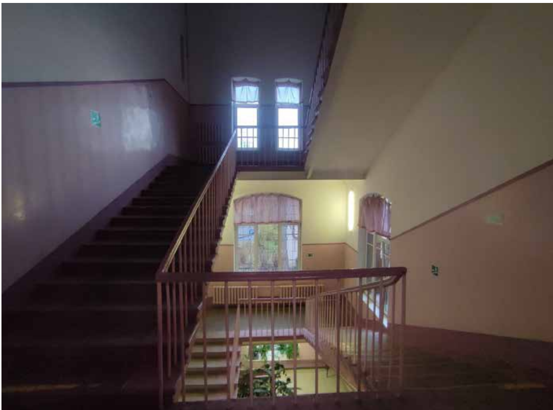
18. Объект культурного наследия регионального значения «Главный корпус Волковской богадельни», расположенный по адресу: г. Санкт-Петербург, набережная реки Волковки, дом 3, литера А. Общий вид южной парадной лестницы (пом. 5-Н (39)) в уровне 2-го этажа.
