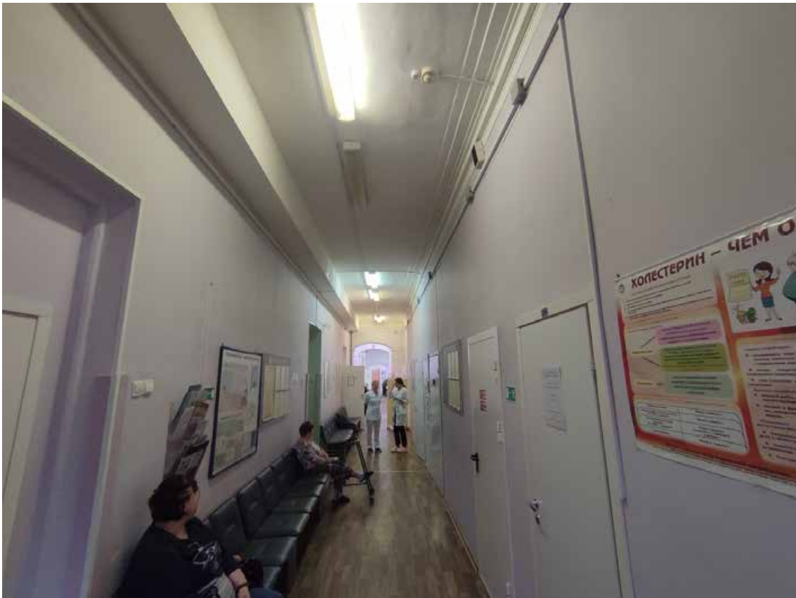
40. Объект культурного наследия регионального значения «Главный корпус Волковской богадельни», расположенный по адресу: г. Санкт-Петербург, набережная реки Волковки, дом 3, литера А. Общий вид пом. 5-Н (3) в уровне 2-го этажа.
