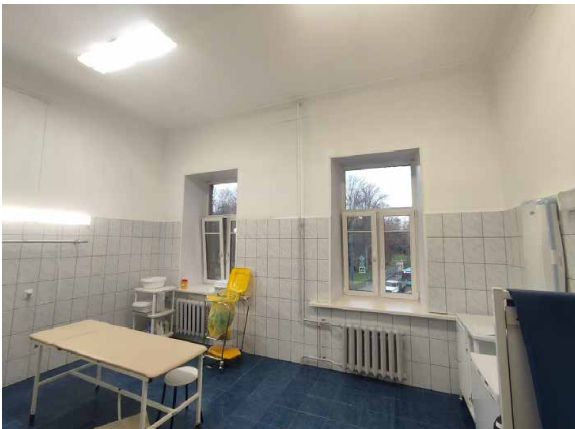
20. Объект культурного наследия регионального значения «Главный корпус Волковской богадельни», расположенный по адресу: г. Санкт-Петербург, набережная реки Волковки, дом 3, литера А. Общий вид пом. 5-Н (34) в уровне 2-го этажа.
