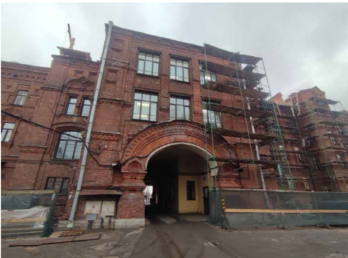
7. Объект культурного наследия регионального значения «Главный корпус Волковской богадельни», расположенный по адресу: г. Санкт-Петербург, набережная реки Волковки, дом 3, литера А. Центральная часть восточного дворового фасада.
