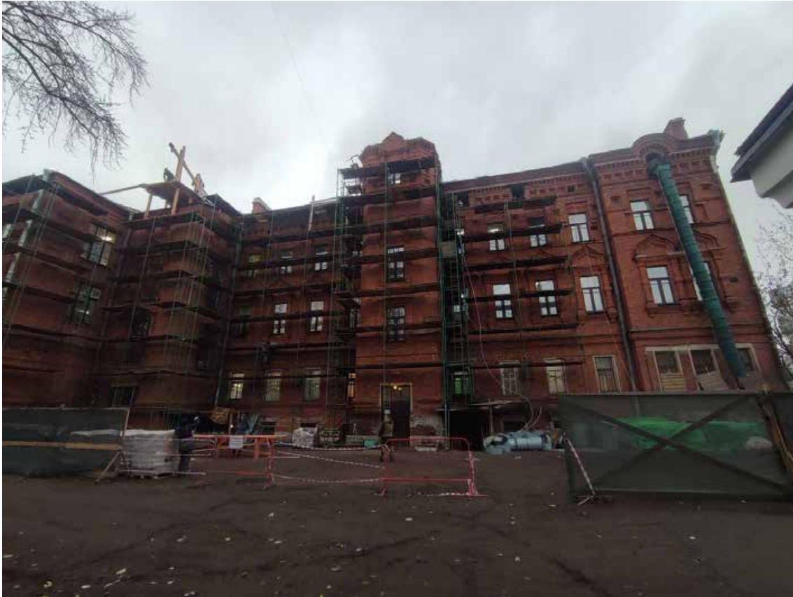
9. Объект культурного наследия регионального значения «Главный корпус Волковской богадельни», расположенный по адресу: г. Санкт-Петербург, набережная реки Волковки, дом 3, литера А. Северная часть восточного дворового фасада.
