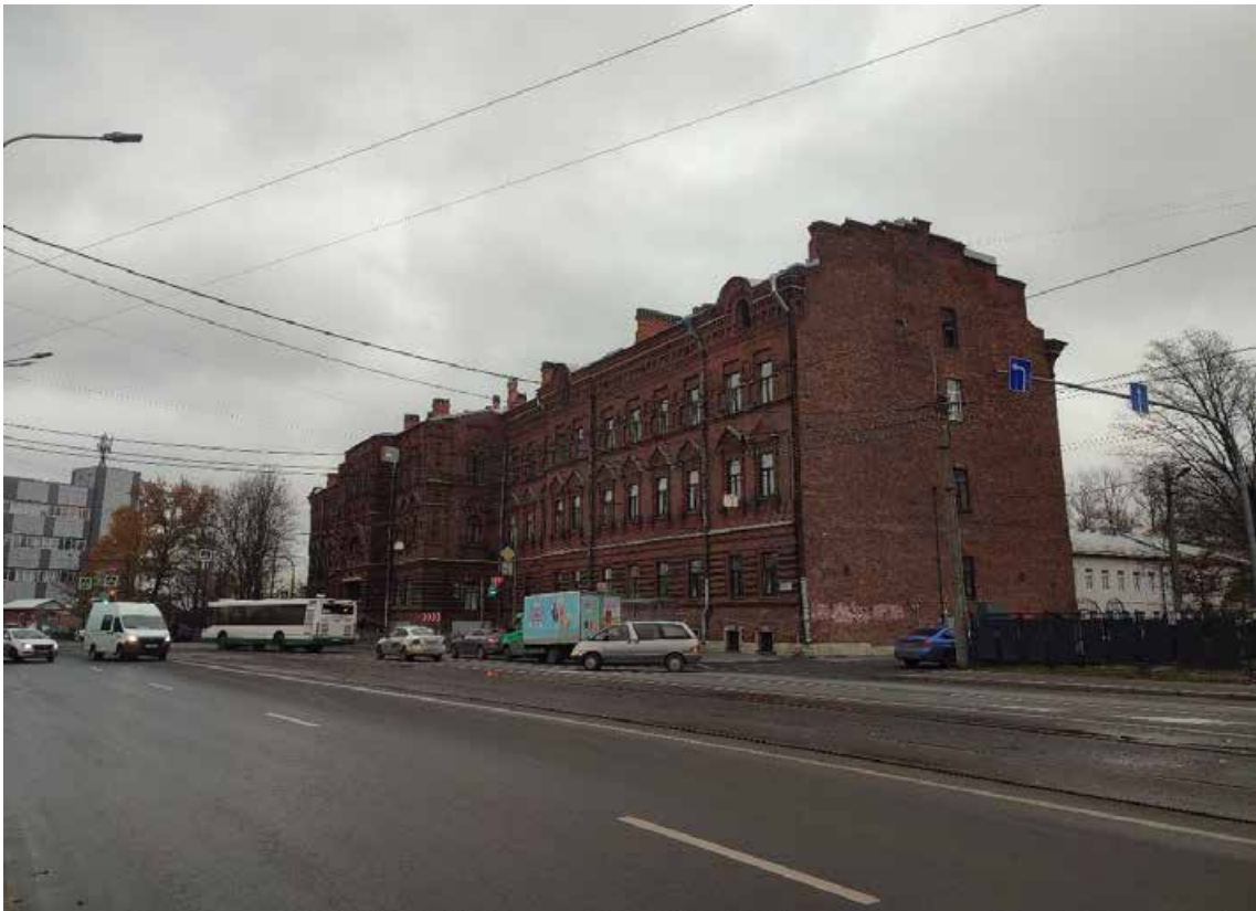
3. Объект культурного наследия регионального значения «Главный корпус Волковской богадельни», расположенный по адресу: г. Санкт-Петербург, набережная реки Волковки, дом 3, литера А. Общий вид западного лицевого и южного торцевого фасадов.
