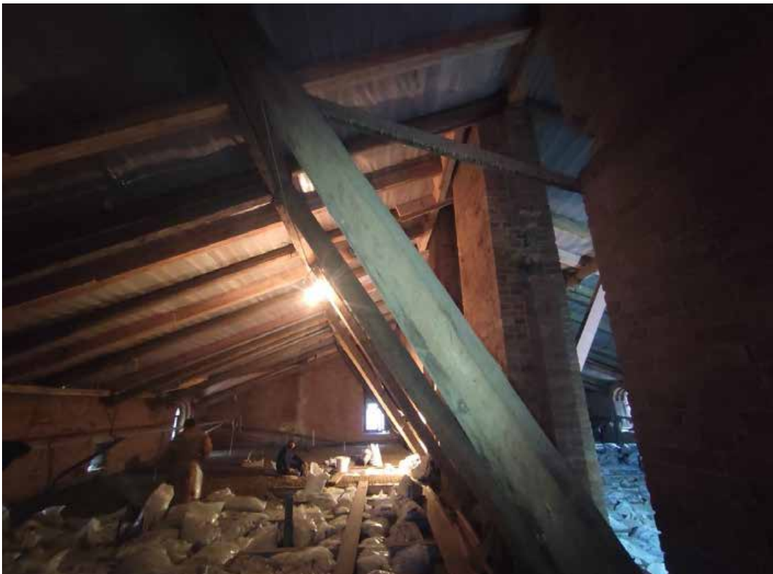
42. Объект культурного наследия регионального значения «Главный корпус Волковской богадельни», расположенный по адресу: г. Санкт-Петербург, набережная реки Волковки, дом 3, литера А. Фрагмент стропильной системы крыши в юго-восточной части здания.
