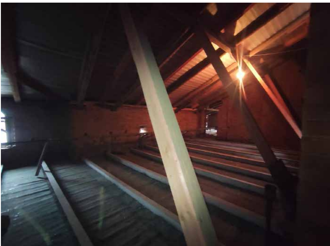
44. Объект культурного наследия регионального значения «Главный корпус Волковской богадельни», расположенный по адресу: г. Санкт-Петербург, набережная реки Волковки, дом 3, литера А. Фрагмент стропильной системы крыши в западной части здания.
