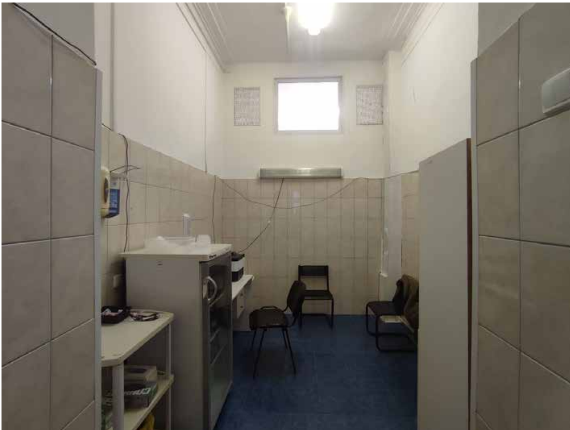
23. Объект культурного наследия регионального значения «Главный корпус Волковской богадельни», расположенный по адресу: г. Санкт-Петербург, набережная реки Волковки, дом 3, литера А. Общий вид пом. 5-Н (32) в уровне 2-го этажа.
