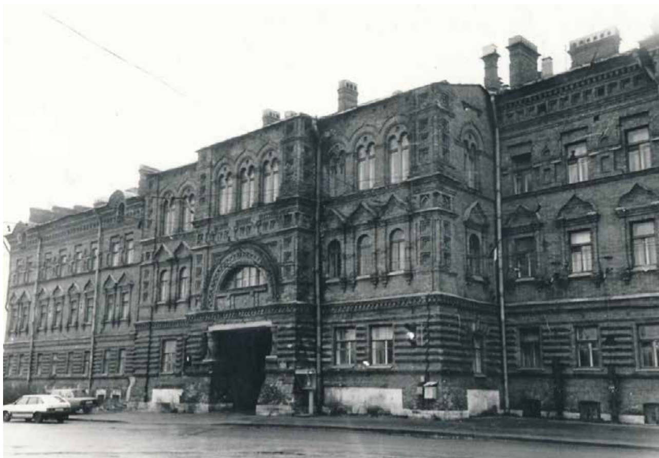
16. Лицевой фасад «Главного корпуса Волковской богадельни». Фото 1995 г. https://www.citywalls.ru/photo387664.html
