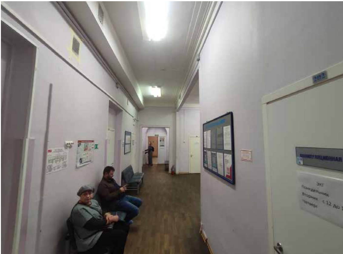
26. Объект культурного наследия регионального значения «Главный корпус Волковской богадельни», расположенный по адресу: г. Санкт-Петербург, набережная реки Волковки, дом 3, литера А. Общий вид пом. 5-Н (28) в уровне 2-го этажа.
