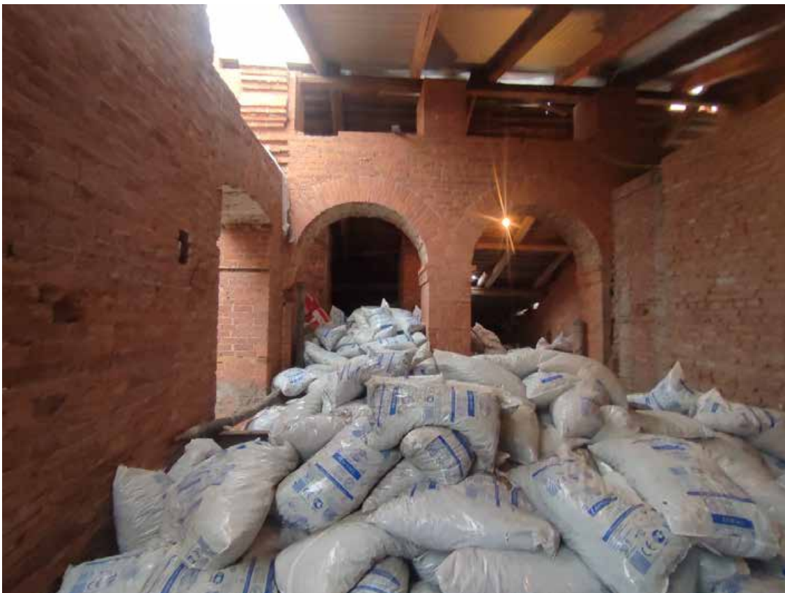
45. Объект культурного наследия регионального значения «Главный корпус Волковской богадельни», расположенный по адресу: г. Санкт-Петербург, набережная реки Волковки, дом 3, литера А. Фрагмент аркады в уровне чердака.
