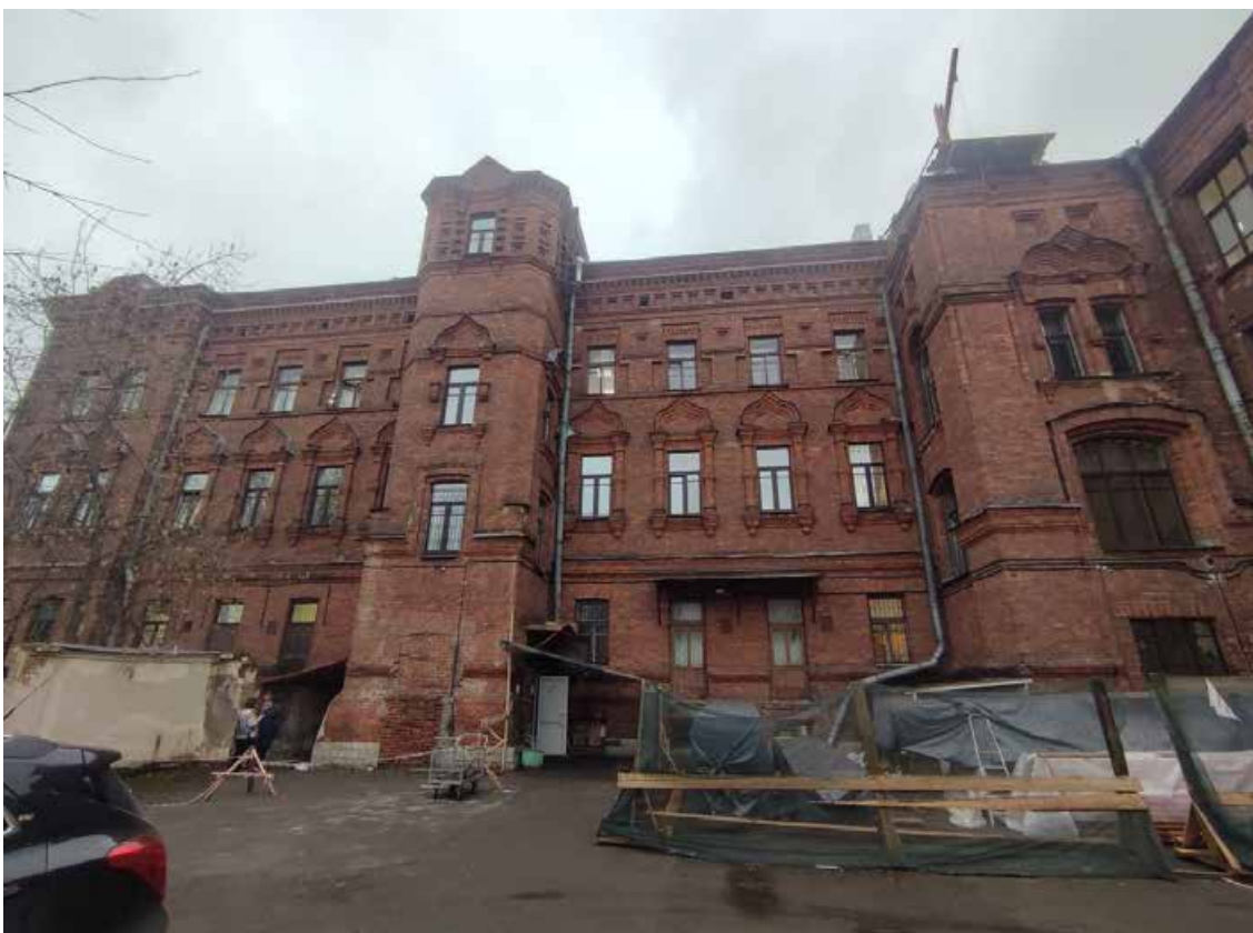
8. Объект культурного наследия регионального значения «Главный корпус Волковской богадельни», расположенный по адресу: г. Санкт-Петербург, набережная реки Волковки, дом 3, литера А. Южная часть восточного дворового фасада.
