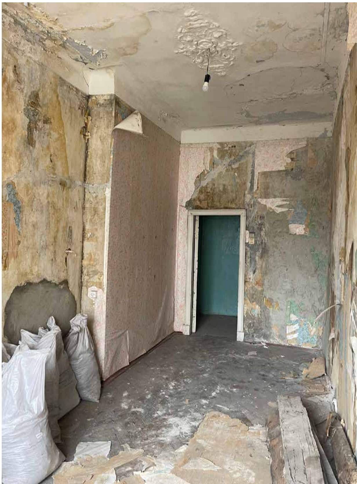
18.Фрагмент интерьера комнаты (помещение 5/15);
