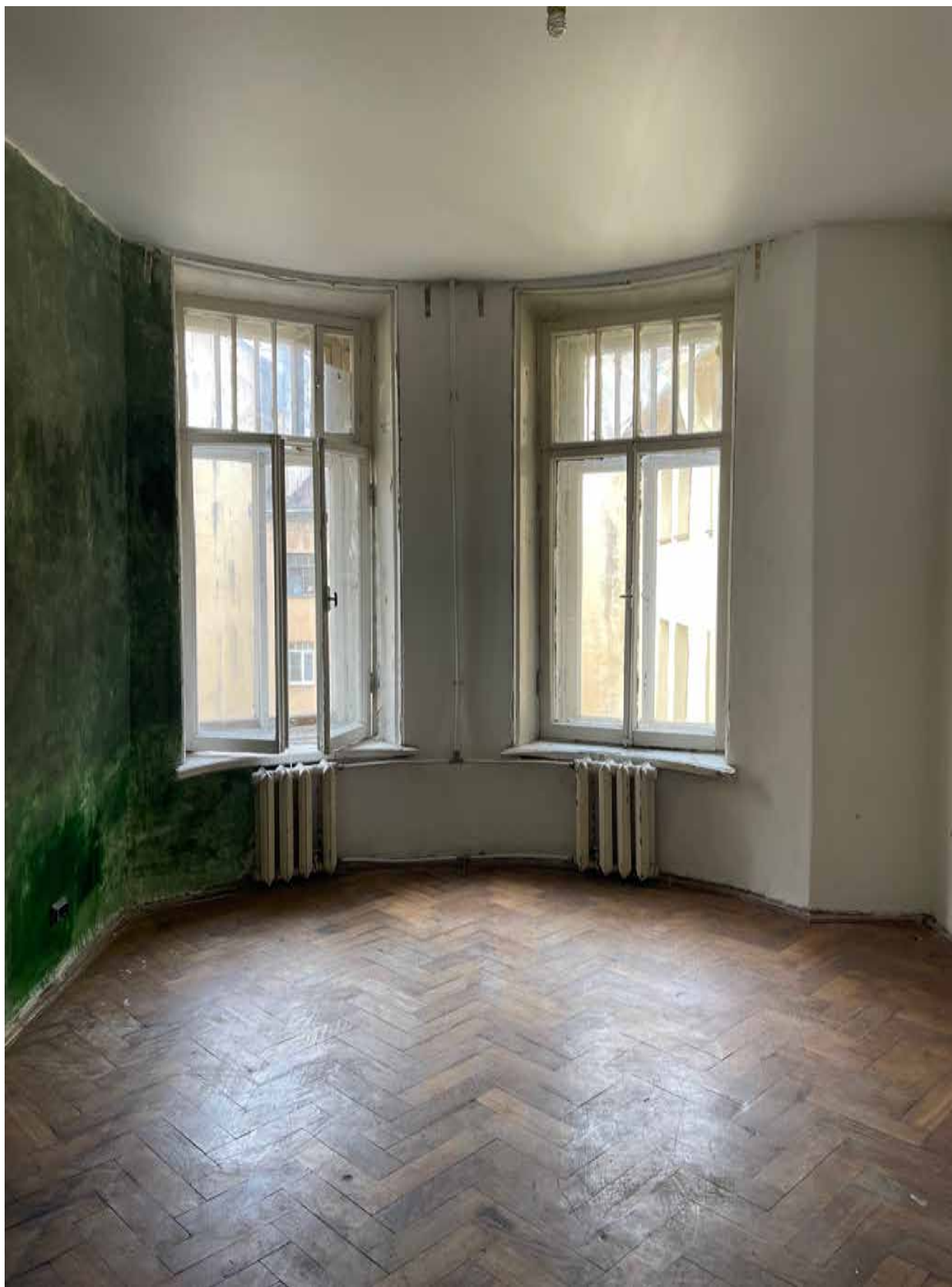
11.Фрагмент интерьера комнаты (помещение 11/19.3);
