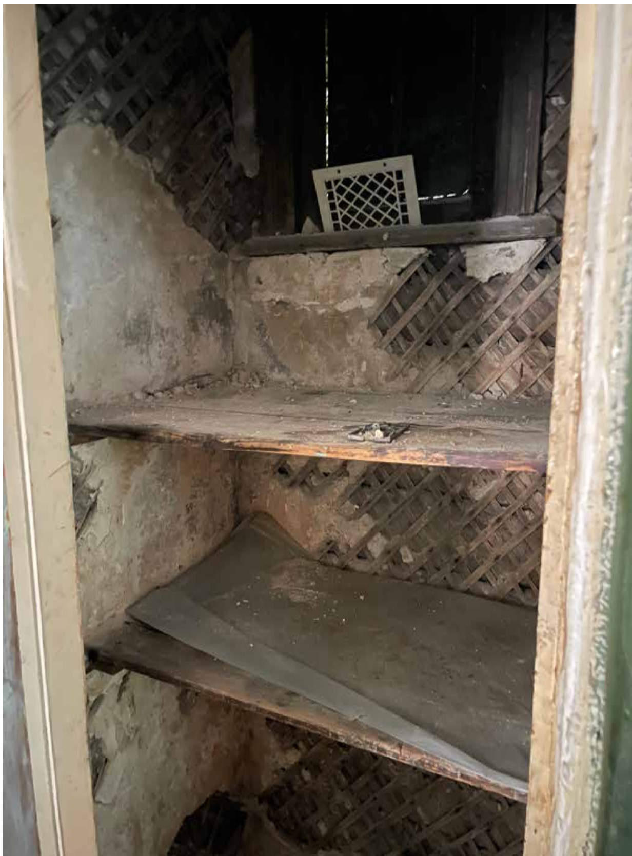
20. Вид на встроенный шкаф;
