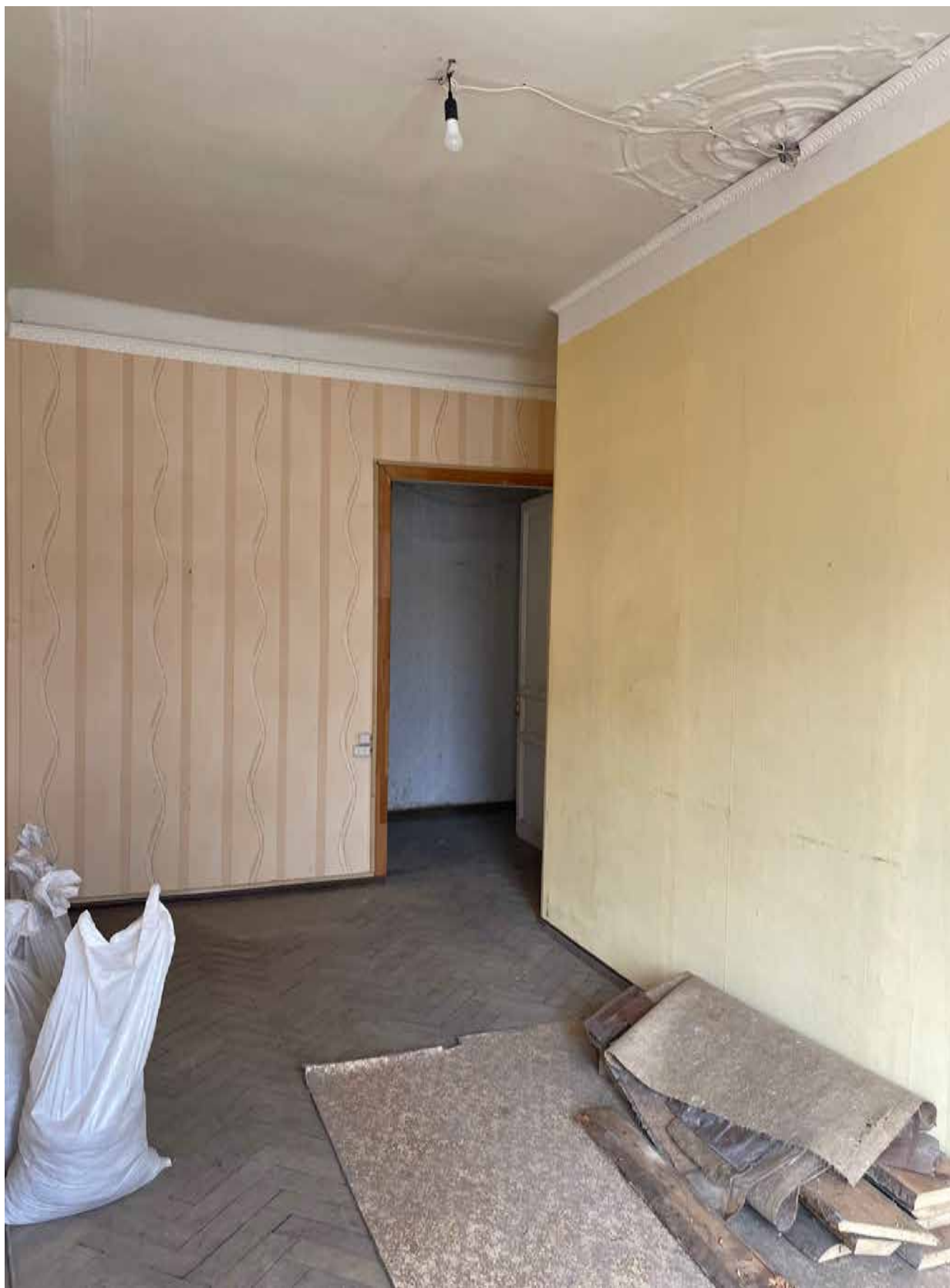
14.Фрагмент интерьера комнаты (помещение 3/32);
