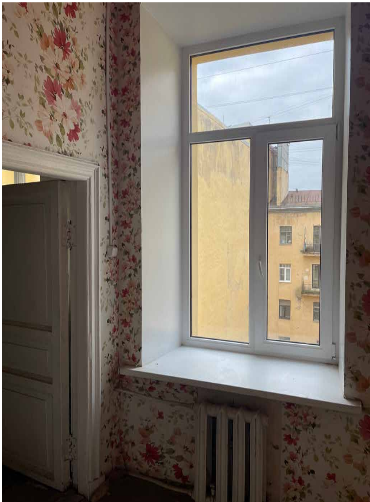
24.Фрагмент интерьера комнаты (помещение 9/6.1);
