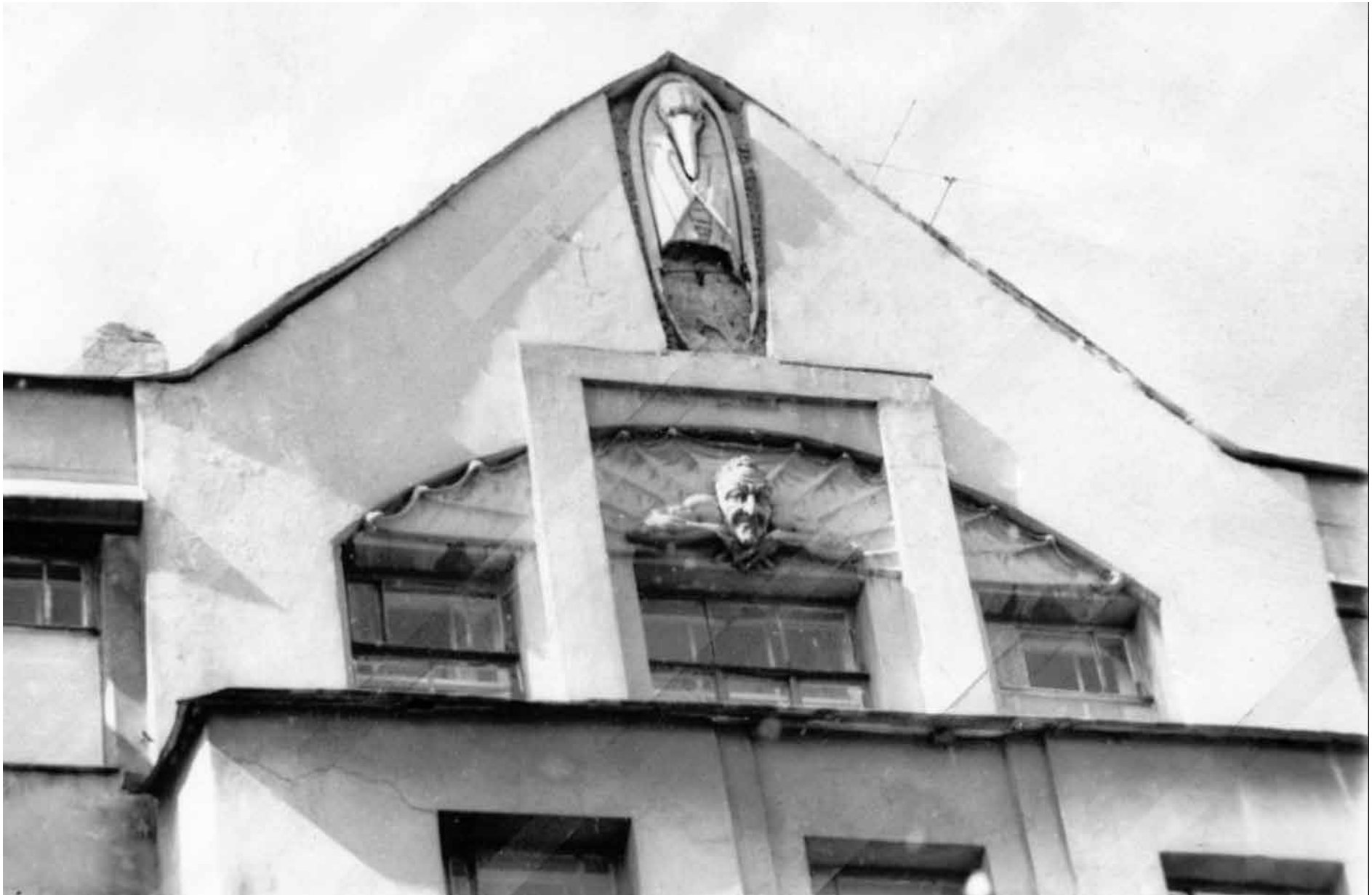
26. Вид треугольного фронтона центрального фасада, с трехчастным окном в полуциркульной части оконной рамы помещен барельеф "паук" дома № 24 по Лахтинской улице ( архитектор А.Л.Лишнеvский, 1910 -1911 гг.). Автор фото – Овчинников Кирилл Владимирович. 17 июня 1984 г. // Источник: ЦГАКФФД СПб Ар 215841.
