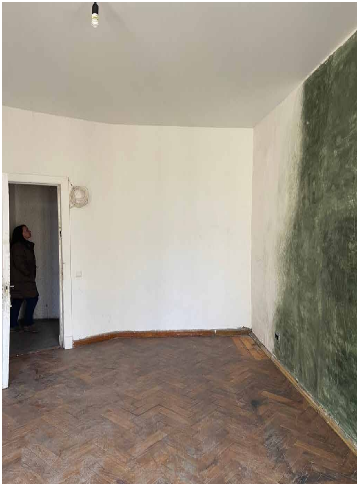
12.Фрагмент интерьера комнаты (помещение 11/19.3);
