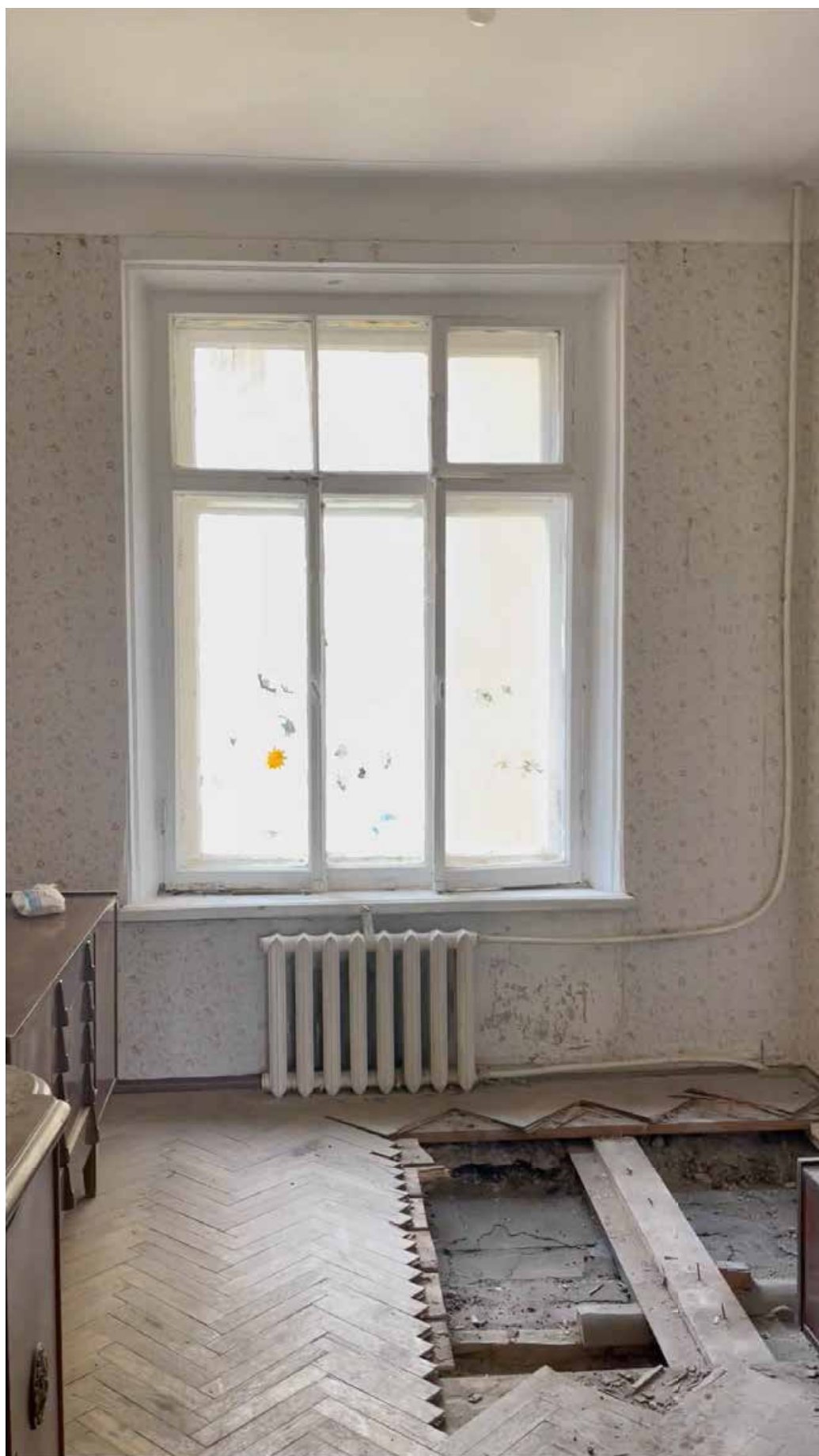
7. Фрагмент интерьера комнаты (помещение 12/14.3);
