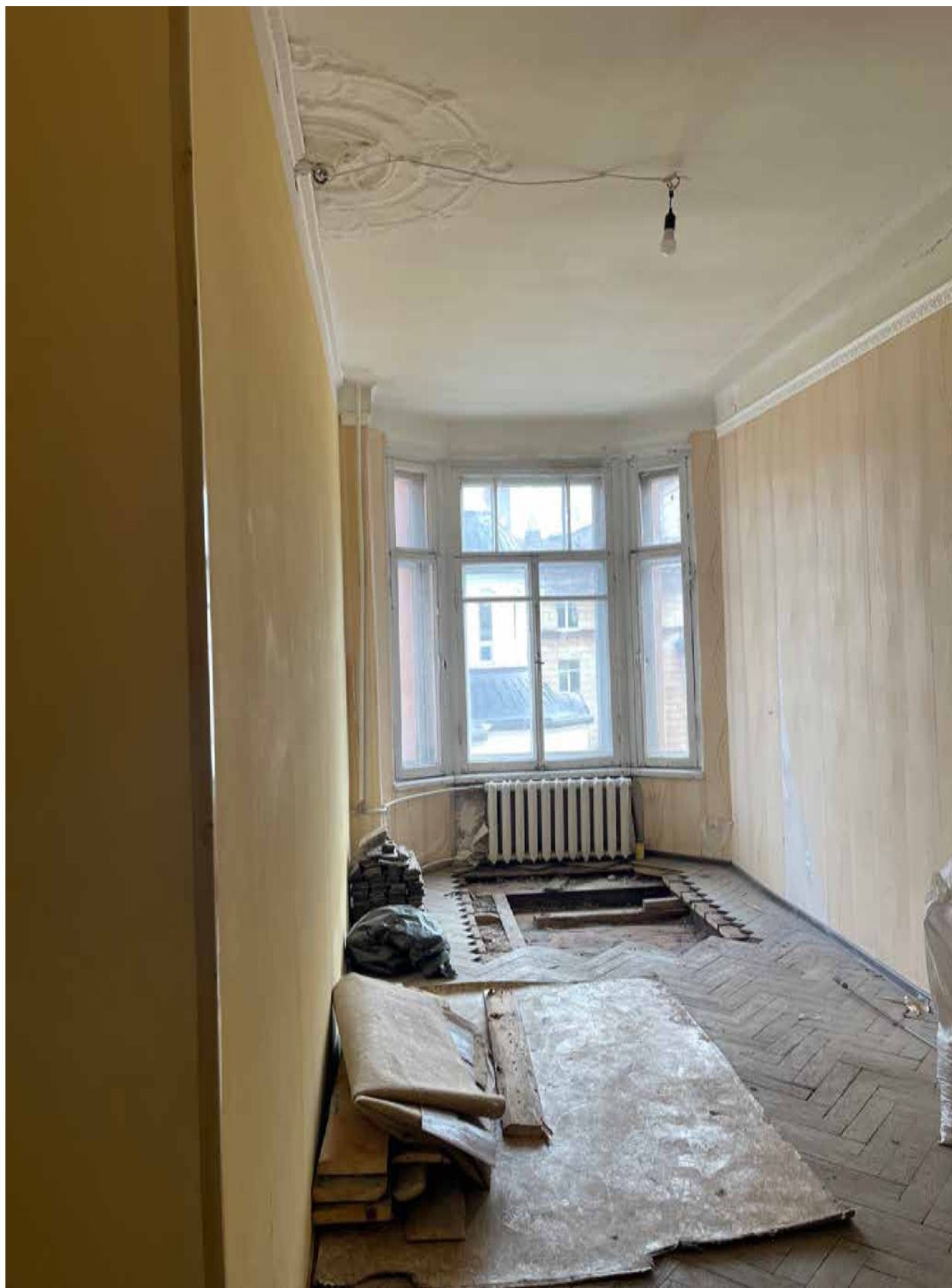
13.Фрагмент интерьера комнаты (помещение 3/32);
