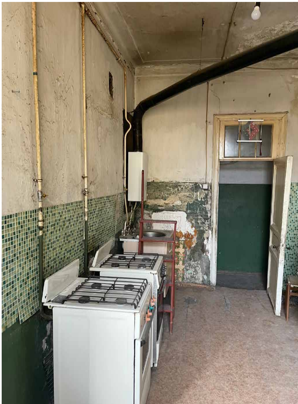
23.Фрагмент интерьера кухни (помещение 8/13.2);
