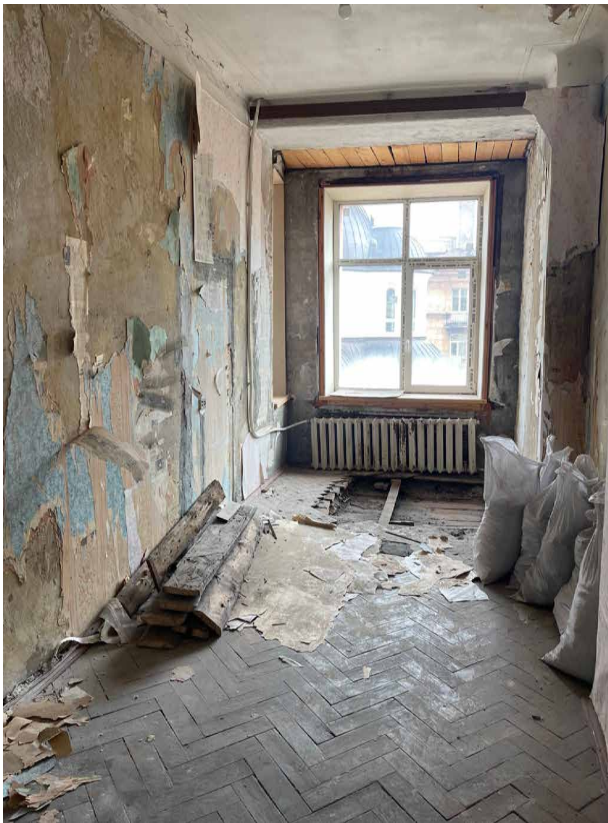
17.Фрагмент интерьера комнаты (помещение 5/15);
