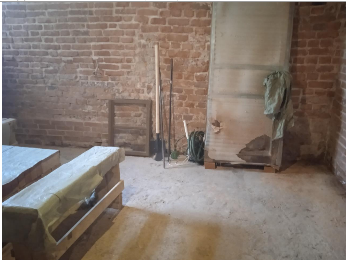
9. Дом Боткина М.П. Помещение цокольного этажа.
