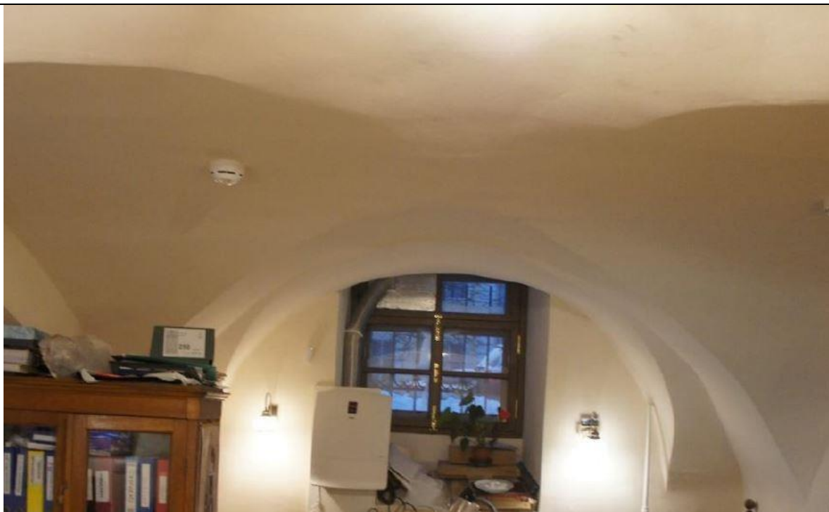
15. Дом Боткина М.П. Своды помещений цокольного этажа.
