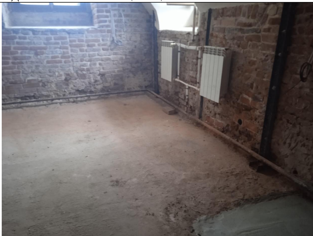
13. Дом Боткина М.П. Помещение цокольного этажа.
