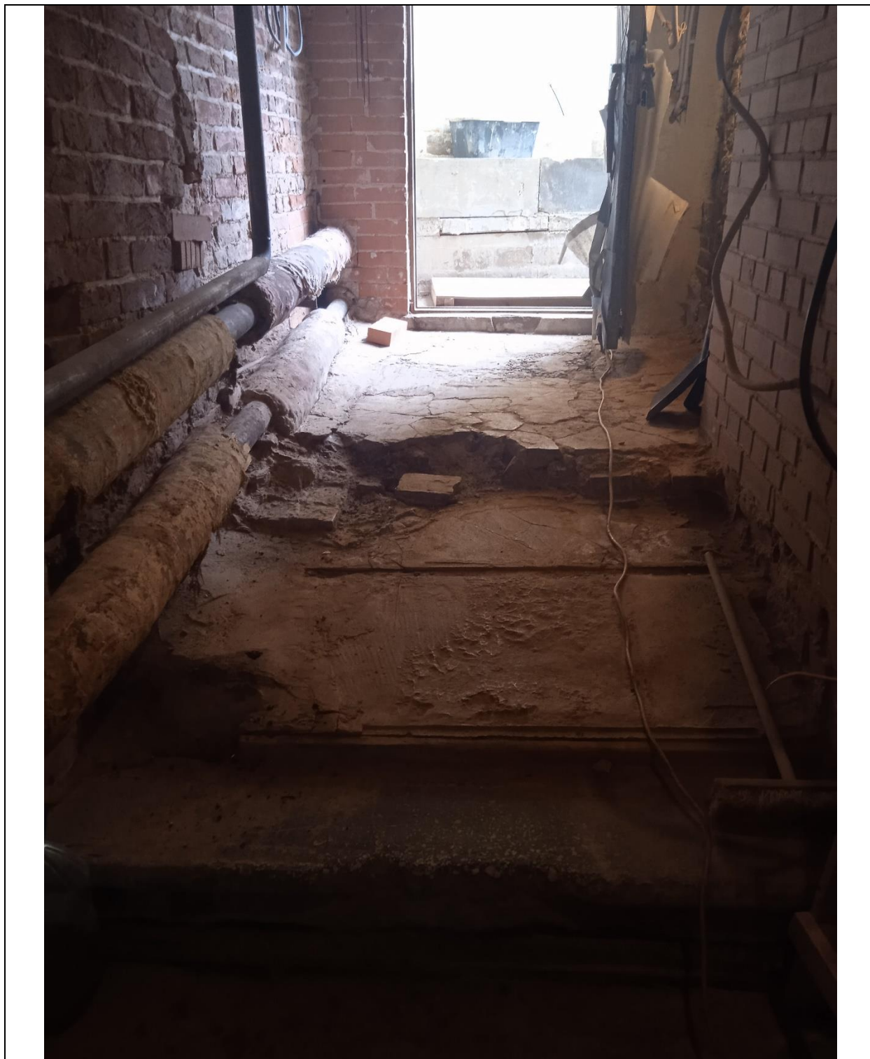
14. Дом Боткина М.П. Вид на прямой из помещений цокольного этажа.
