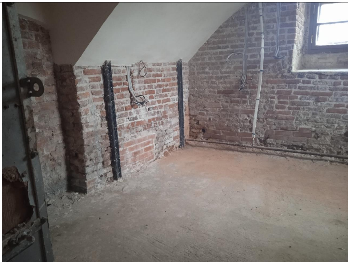
12. Дом Боткина М.П. Помещение цокольного этажа.
