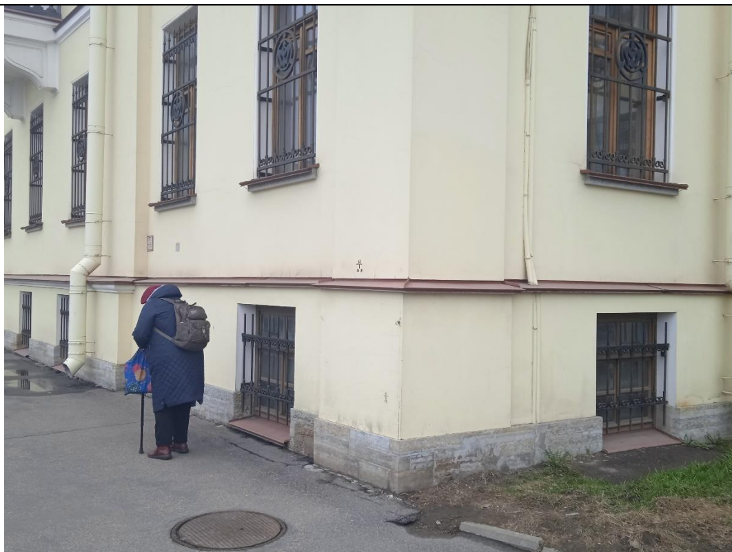
3. Дом Боткина М.П. Фрагмент фасада здания в уровне цокольного-первого этажей по наб. Лейтенанта Шмидта
