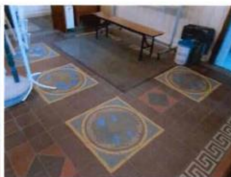
6. Покрытие пола нижнего уровня вестибюля.
