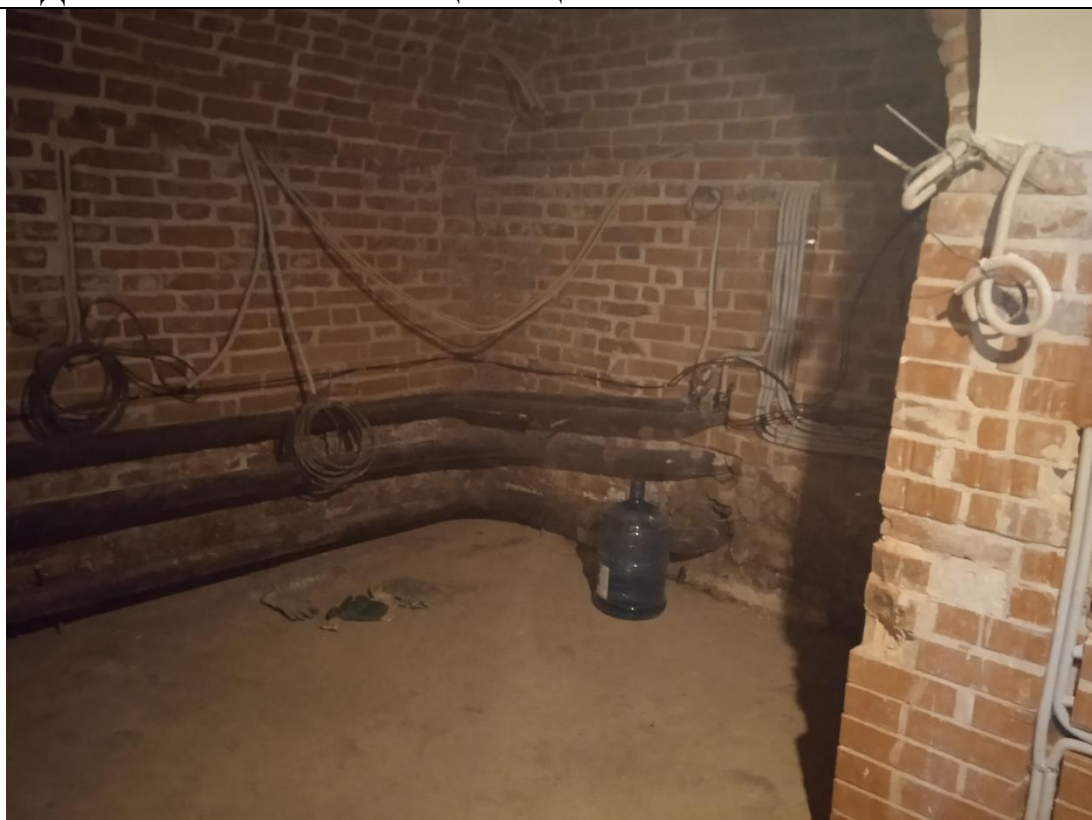
11. Дом Боткина М.П. Помещение цокольного этажа.
