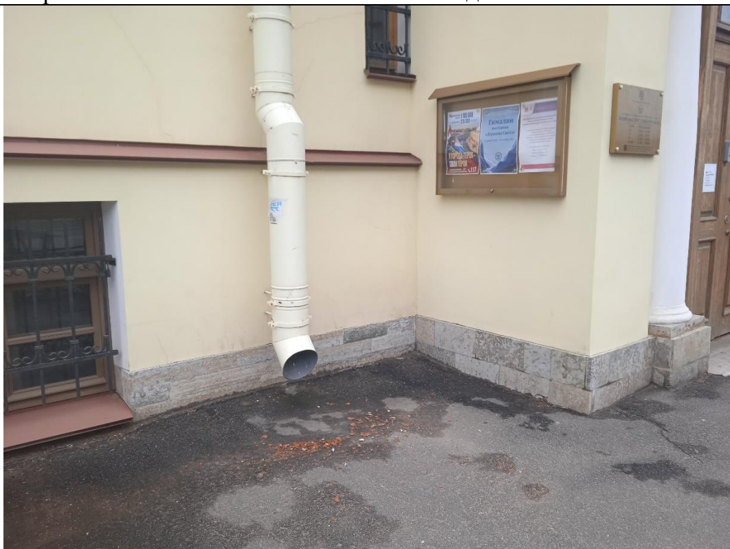
4. Дом Боткина М.П. Фрагмент фасада здания в уровне цокольного этажа по 18-ой линии В.О.
