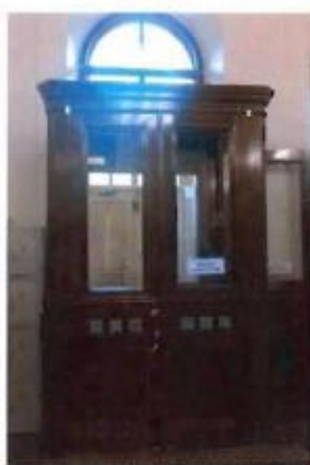
3. Тамбур главного входа.
