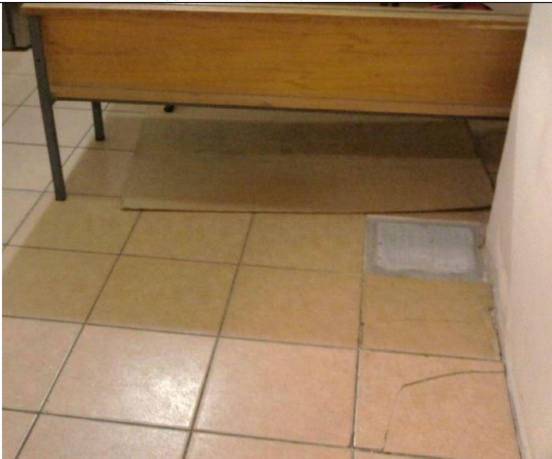
16. Дом Боткина М.П. Облицовка пола помещений цокольного этажа.
