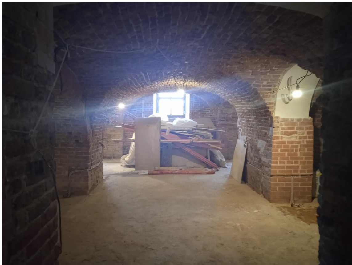
8. Дом Боткина М.П. Помещение цокольного этажа.
