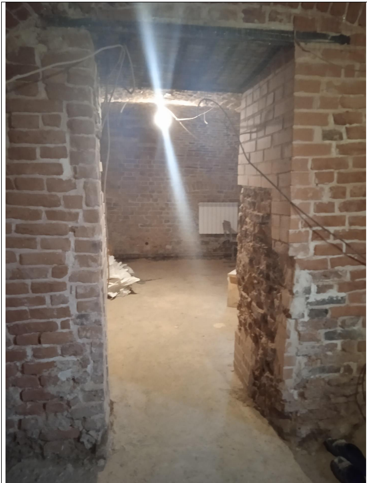
7. Дом Боткина М.П. Помещение цокольного этажа.
