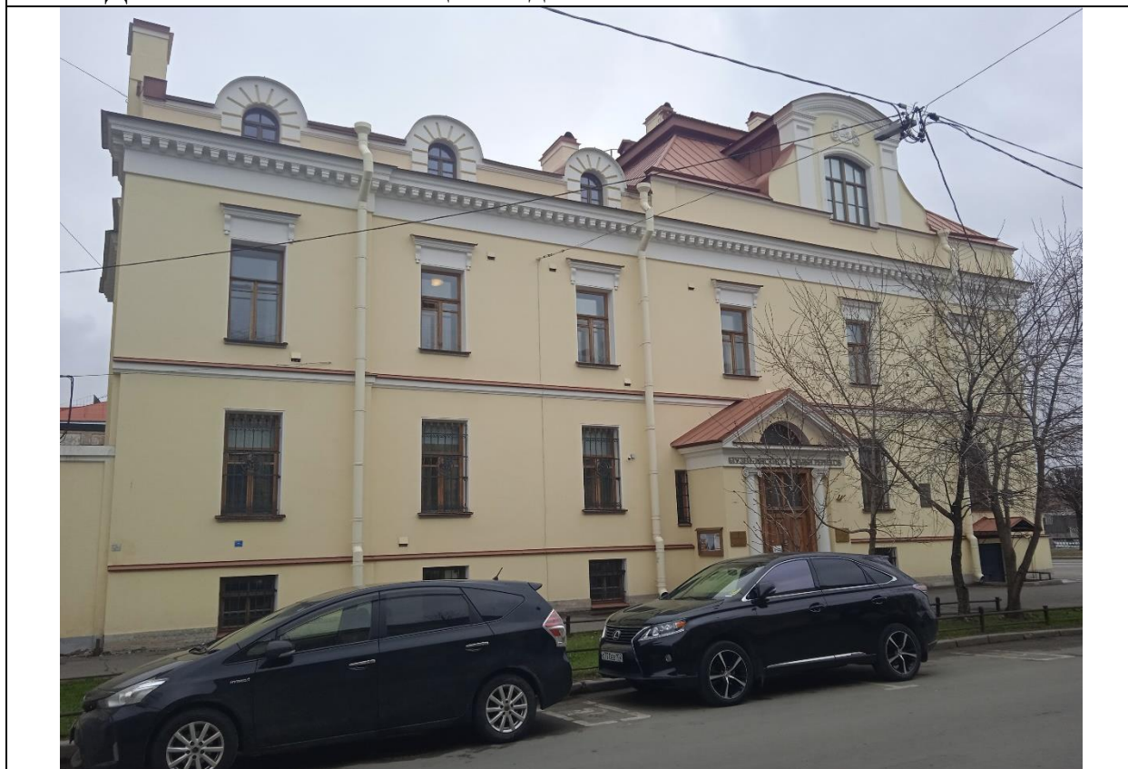
2. Дом Боткина М.П. Общий вид фасада по 18-ой линии В.О.
