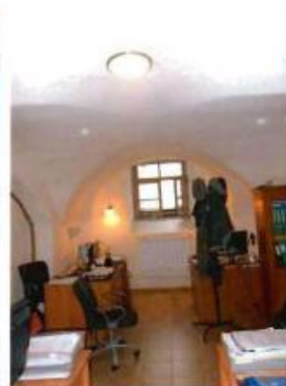
4. Свод цокольного этажа.
