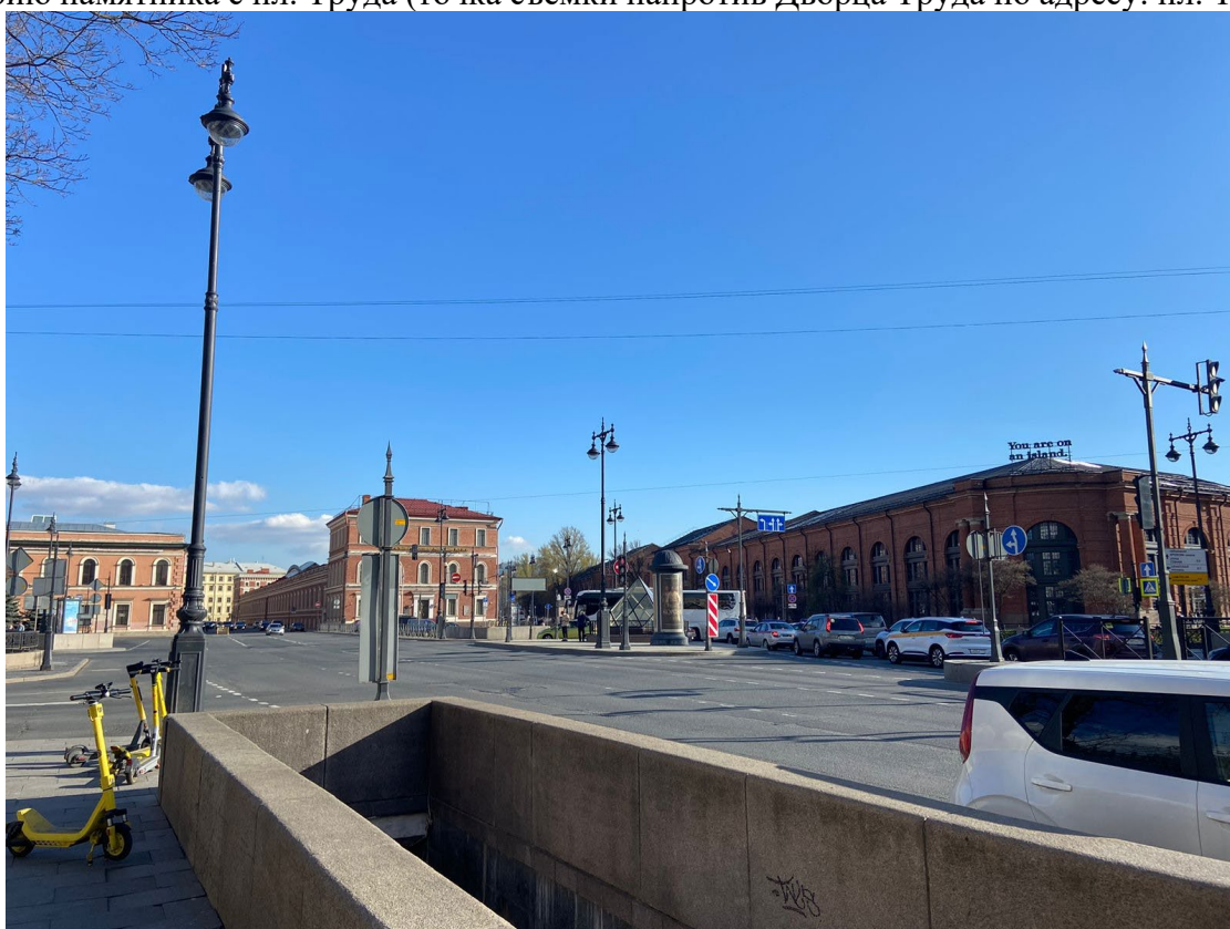
Рис. 8. Выявленный объект культурного (археологического) наследия «Фундамент Благовещенской церкви 1844-1849 гг.» по адресу: Санкт-Петербург, Адмиралтейский район, пл. Труда. Вид на территорию памятника с пл. Труда (точка съемки у проезжей части напротив Дворца Труда по адресу: пл. Труда, д.4).
