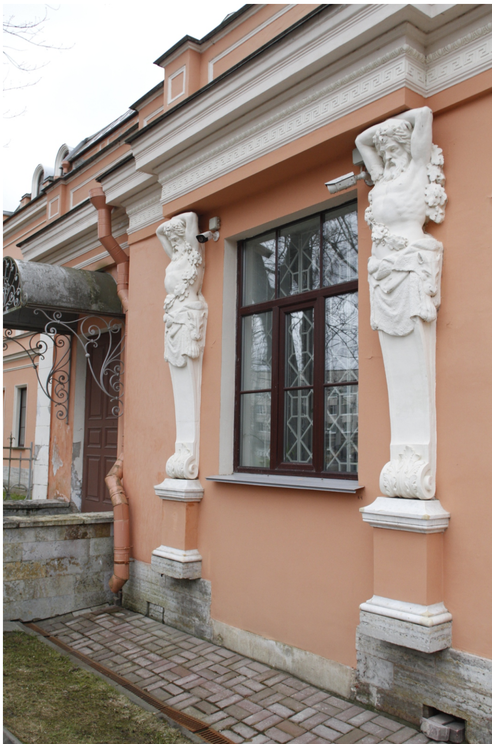
15. «Б. Особняк Гейрота» Санкт-Петербург, г. Петергоф, Никольская ул., 11, литера А. Северный фасад. Фрагмент. Фото: 24.04.2024.
