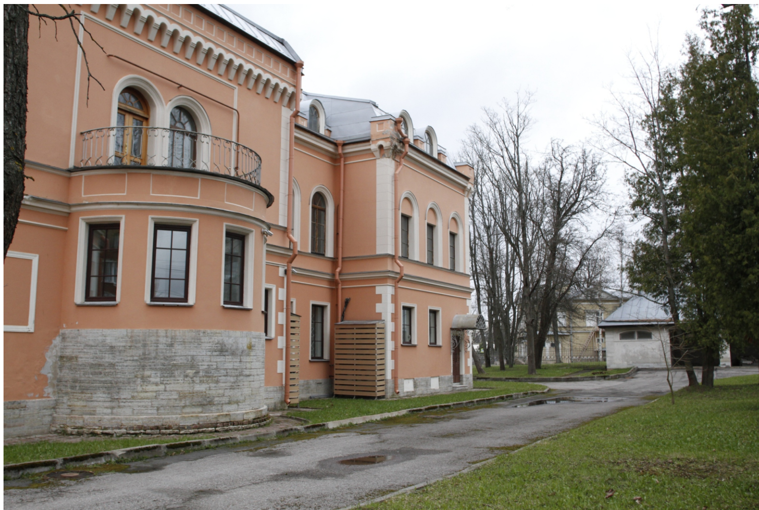
12. «Б. Особняк Гейрота» Санкт-Петербург, г. Петергоф, Никольская ул., 11, литера А. Восточный фасад. Общий вид. Фото: 24.04.2024.
