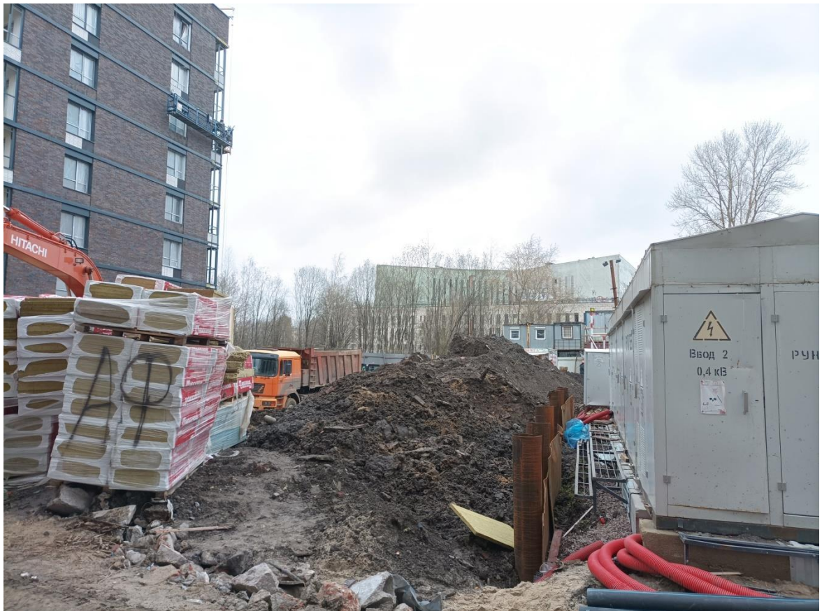
Илл. 30. Территория проектирования пр. Обуховской Обороны, 38, лит В. Направление съемки северо-запад.
