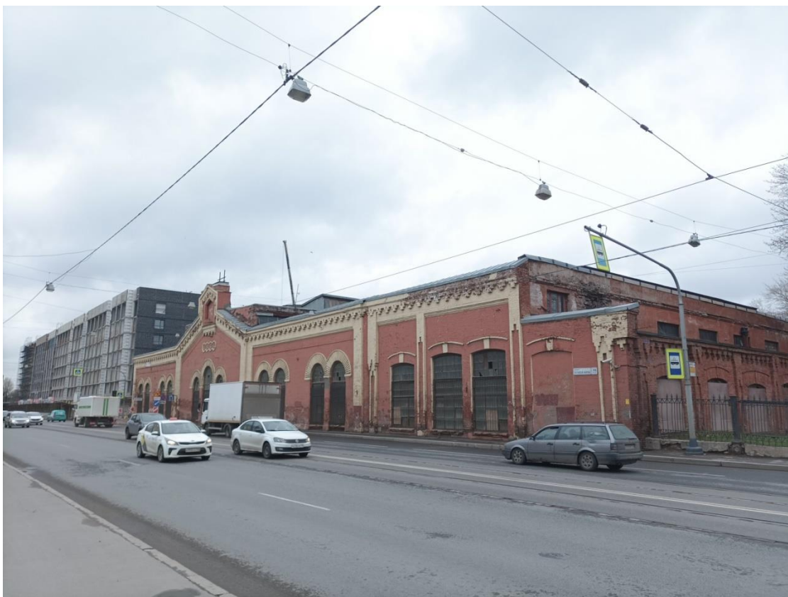
Илл. 5. Общий вид объекта культурного наследия по пр. Обуховской Обороны. Направление съемки север.
