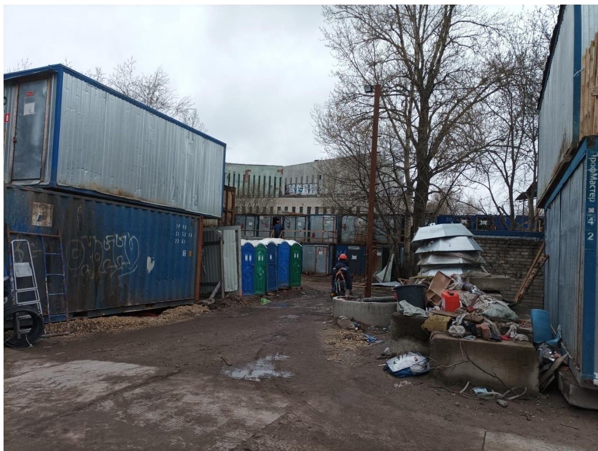
Илл. 34. Территория проектирования пр. Обуховской Обороны, 38, лит В. Направление съемки северо-запад.
