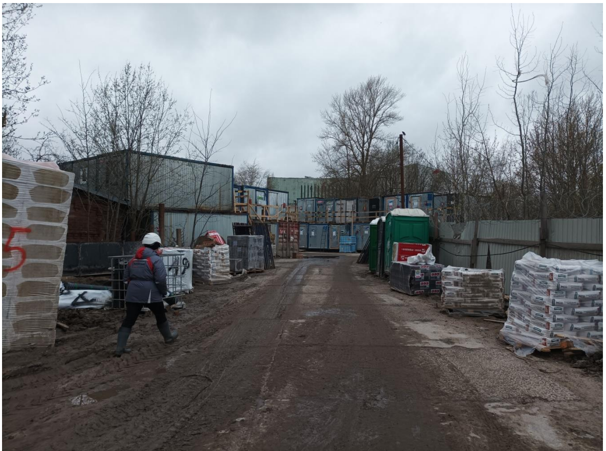
Илл. 32. Территория проектирования пр. Обуховской Обороны, 38, лит В. Направление съемки северо-запад.
