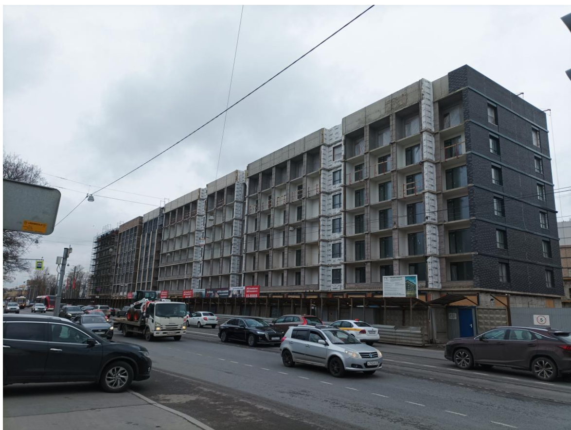
Илл. 2. Территория проектирования пр. Обуховской Обороны, 38, лит В. Направление съемки северо-запад.
