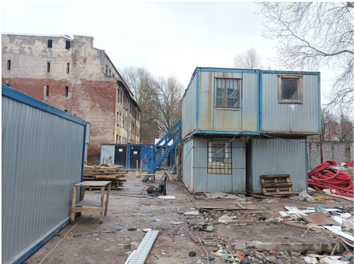
Илл. 14. Территория проектирования пр. Обуховской Обороны, 38, лит В. Направление съемки восток.
