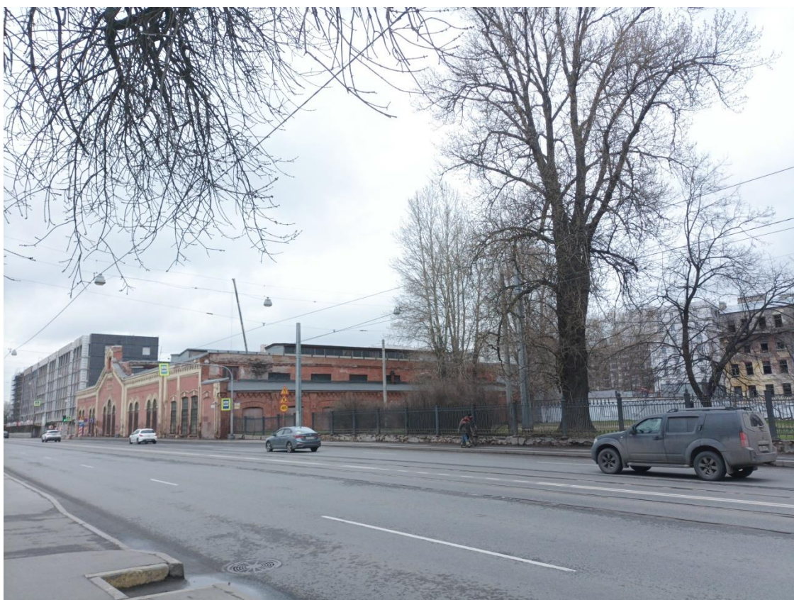
Илл. 6. Общий вид территории проектирования пр. Обуховской Обороны, 38, лит В. Направление съемки север.
