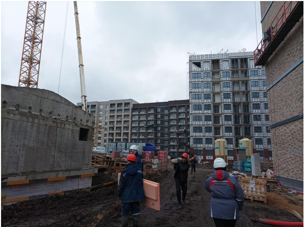
Илл. 27. Территория проектирования пр. Обуховской Обороны, 38, лит В. Направление съемки северо-запад.
