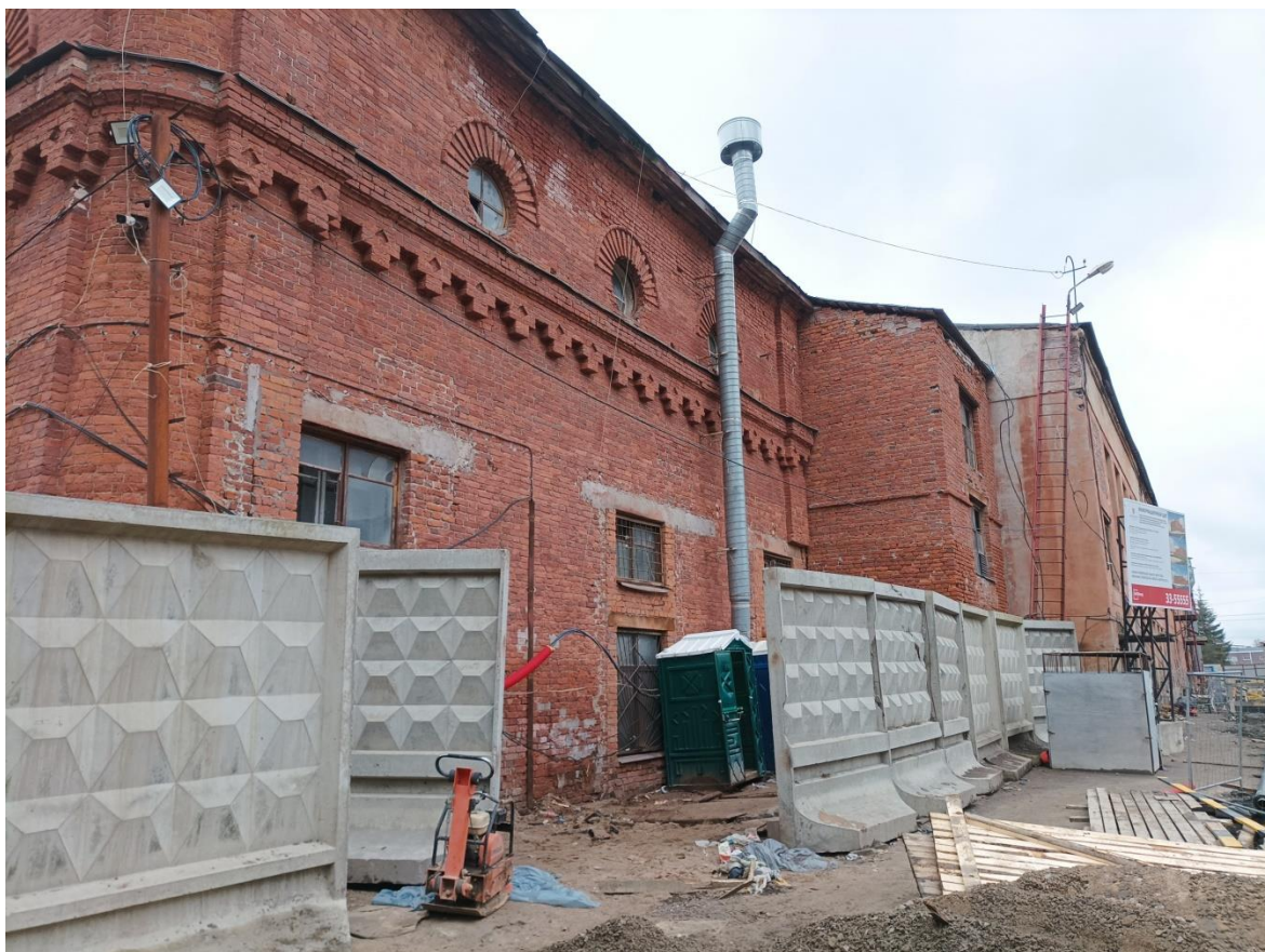
Илл. 21. Территория проектирования пр. Обуховской Обороны, 38, лит В вид на боковой фасад объекта культурного наследия. Направление съемки юго-запад.
