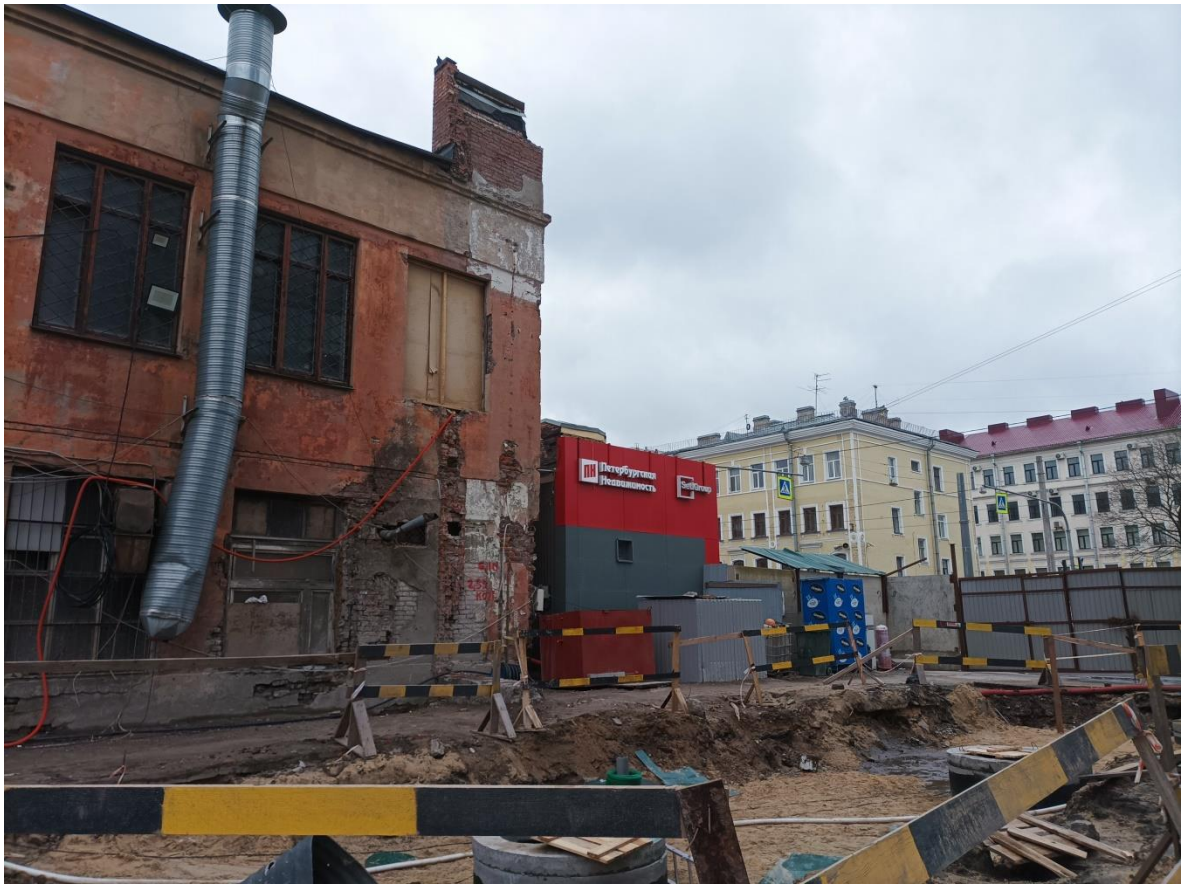
Илл. 25. Территория проектирования пр. Обуховской Обороны, 38, лит В вид на боковой фасад объекта культурного наследия. Направление съемки юг.
