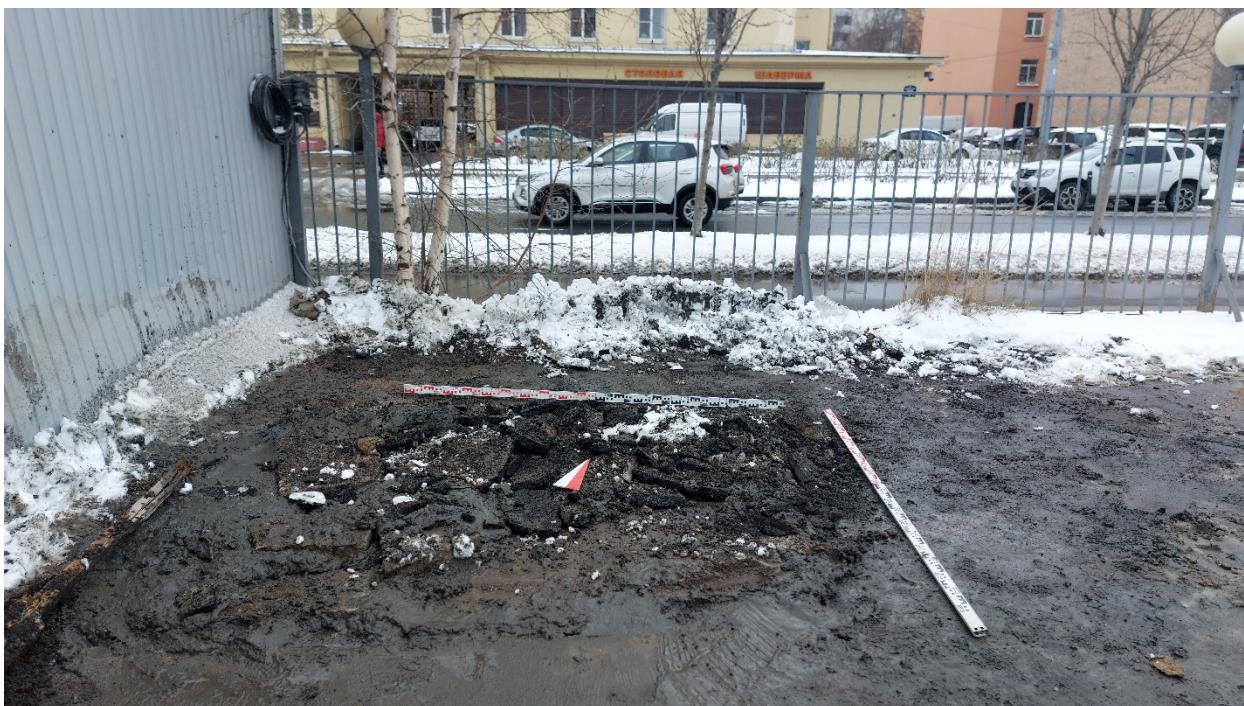
Рис. 29. Санкт-Петербург-2024. Земельный участок с кадастровым номером 78:07:0003204:1459. Шурф 1. Рекультивация. Вид с ЮЮВ
