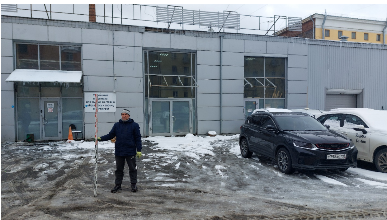
Рис. 20. Санкт-Петербург-2024. Земельный участок с кадастровым номером 78:07:0003204:1459. Точка фотофиксации 4. Вид на Ю
