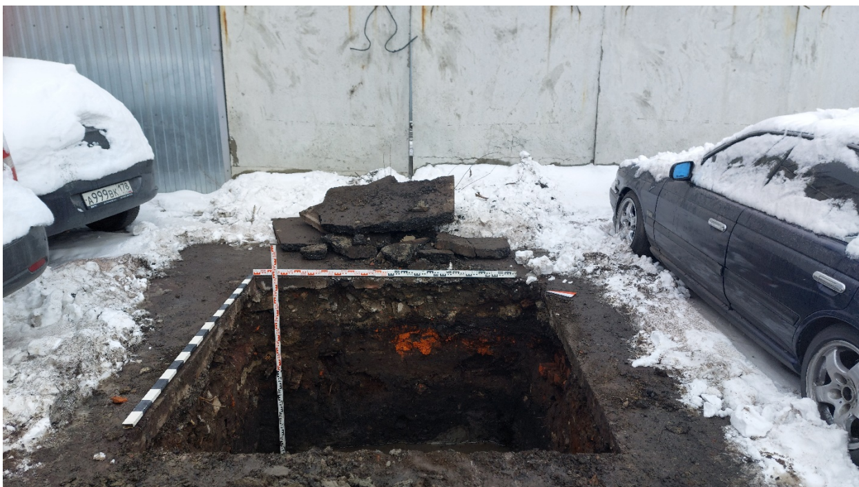
Рис. 31. Санкт-Петербург-2024. Земельный участок с кадастровым номером 78:07:0003204:1459. Шурф 2. Общий вид шурфа. Вид с ЮЗЗ
