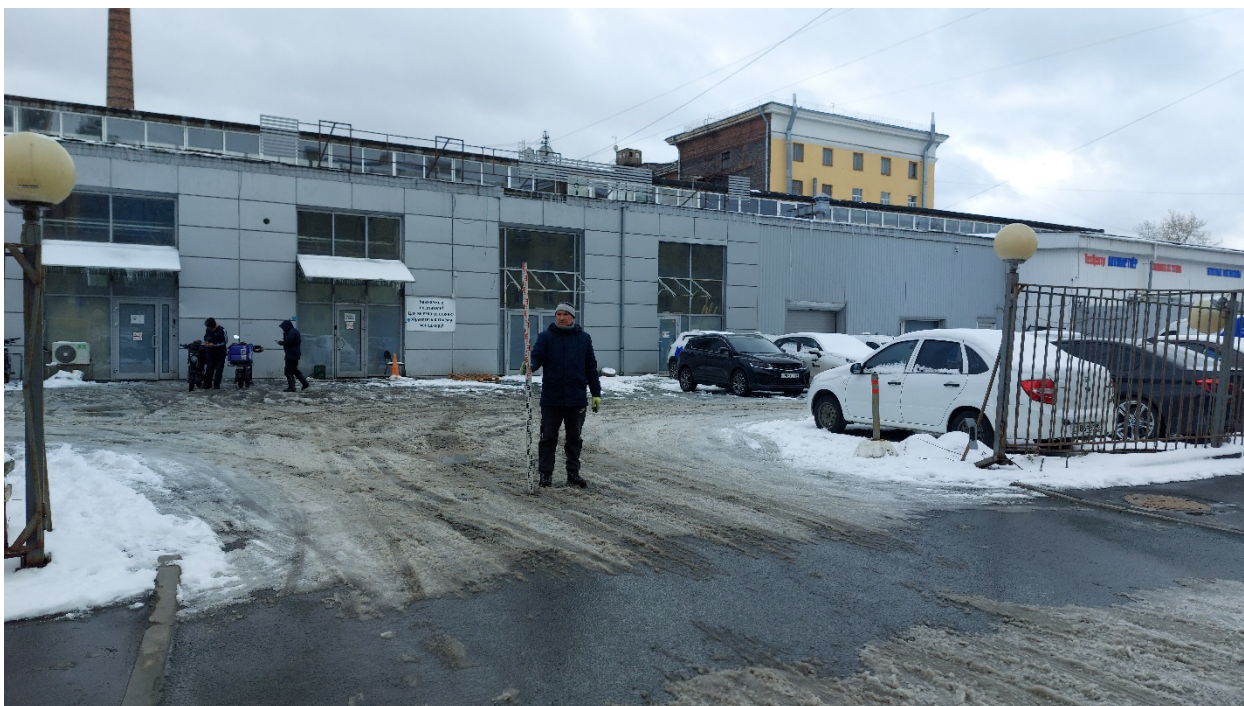
Рис. 21. Санкт-Петербург-2024. Земельный участок с кадастровым номером 78:07:0003204:1459. Точка фотофиксации 5. Вид на Ю
