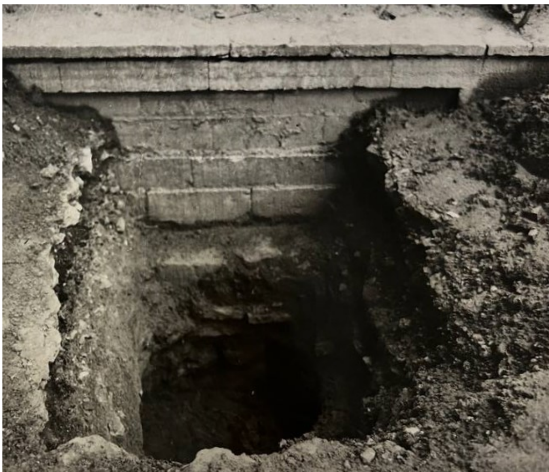
Илл. 58. Шурф у фундамента ограды.
