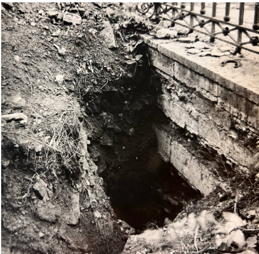
Илл. 17. Фундамент и цоколь ограды. Фото 1960-х гг.
