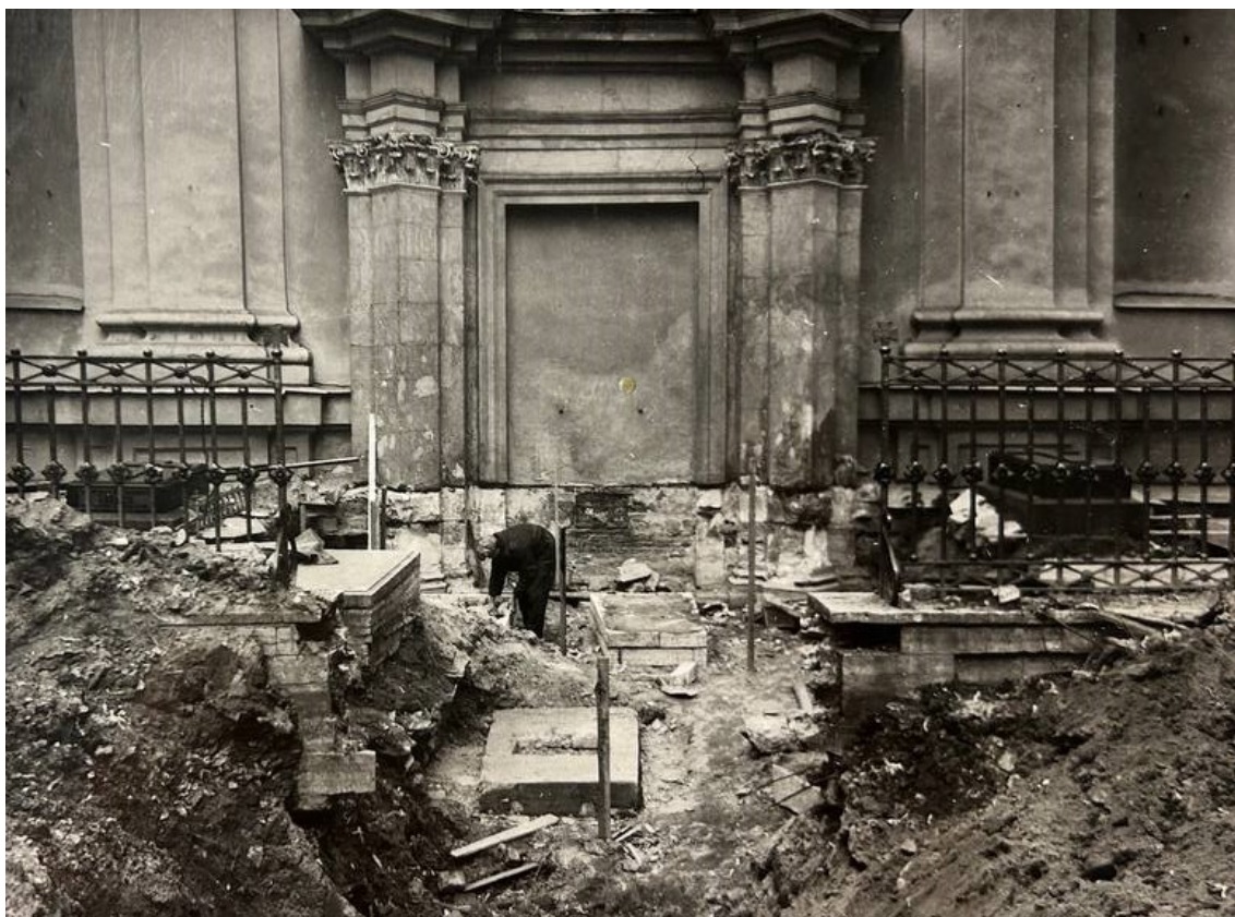
Илл. 67. Процесс реставрационных работ. Удаление насыпного грунта до исторической отметки. 1979 г.
