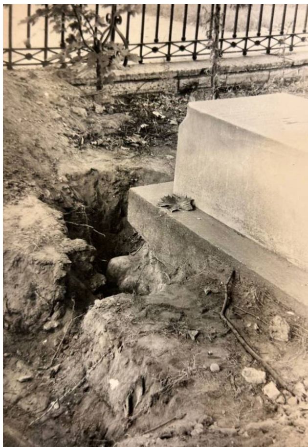
Илл. 31. Надгробие Сукина. Вскрытое основание под цокольной плитой. 1965 г.
