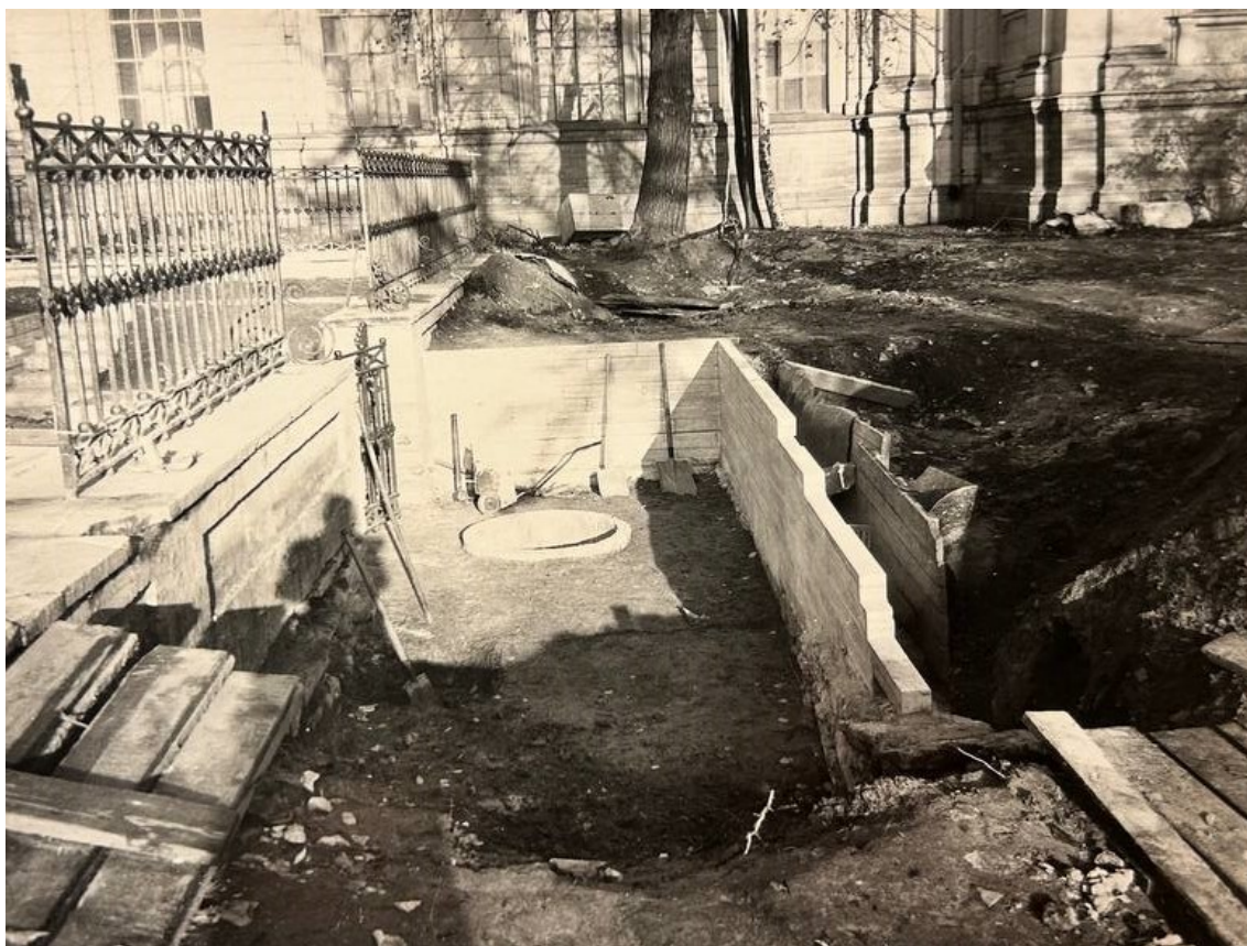
Илл. 71. Процесс реставрационных работ. 1980 г.
