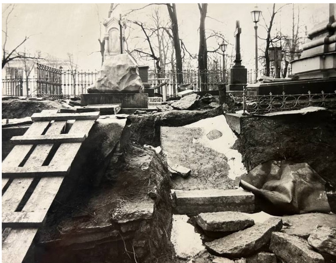
Илл. 64. Процесс реставрационных работ. Удален насыпной грунт. 1979 г.
