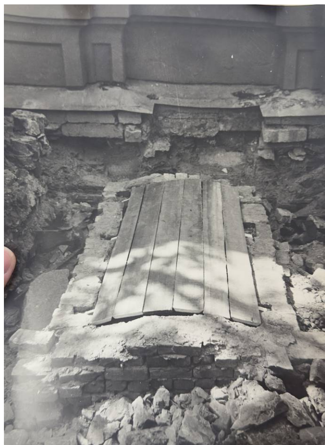
Илл. 48. Снятие свода над склепом Данилова. ЦГАНТД № 55267/2. 1969 г.
