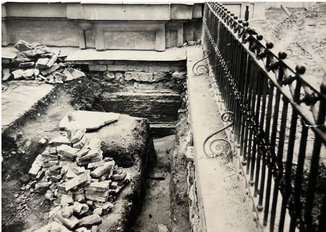
Илл. 65. Процесс реставрационных работ. Шурф. 1979 г.
