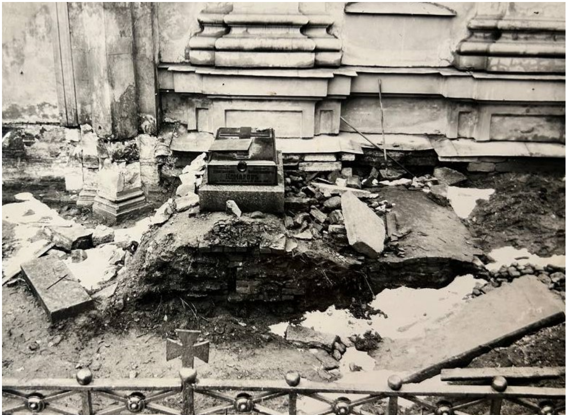
Илл. 61. Насыпной грунт с участка захоронения 18-го века. Базы пилона восточной части собора.
