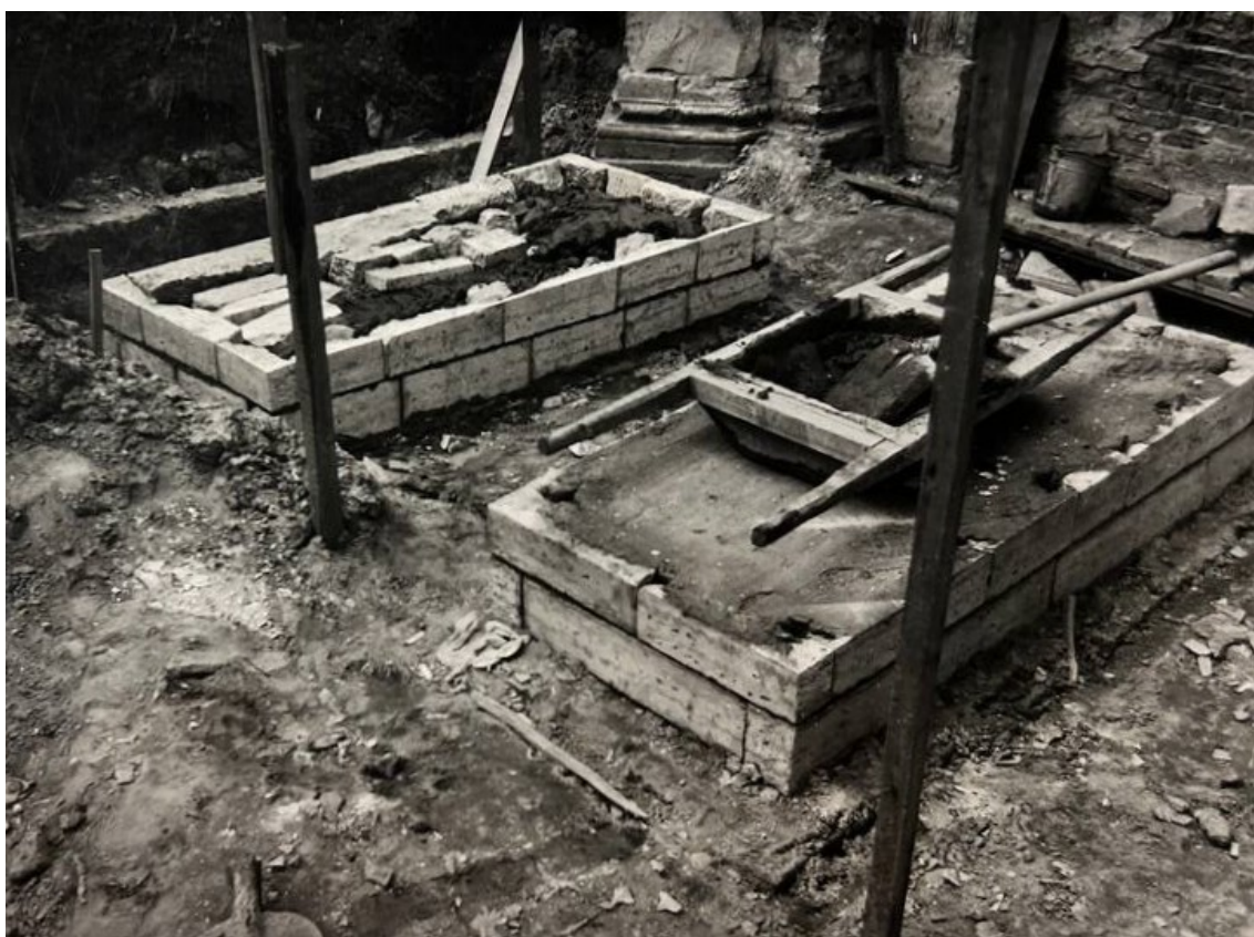
Илл. 68. Процесс реставрационных работ. Новые цоколи надгробий. 1980 г.
