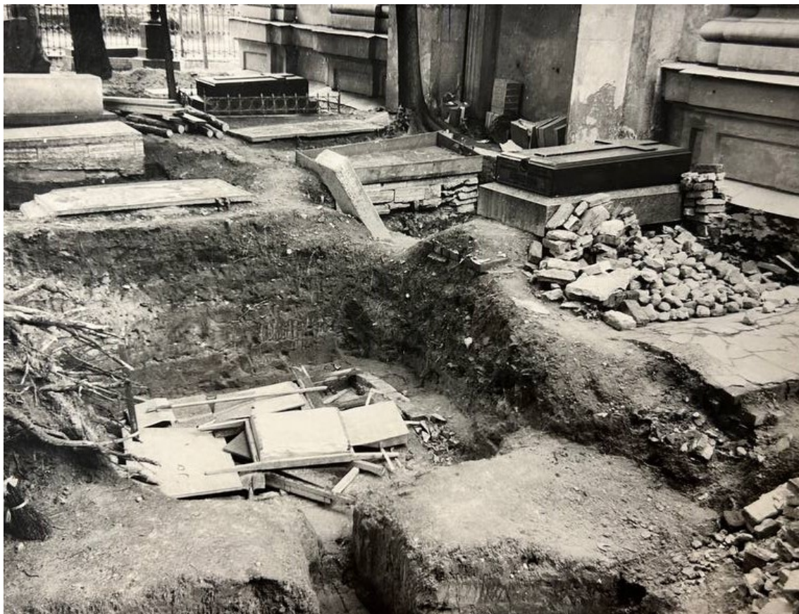
Илл. 63. Процесс реставрационных работ. 1979 г.
