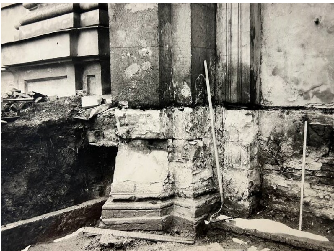
Илл. 66. Процесс реставрационных работ. Нижняя часть пилона. 1979 г.
