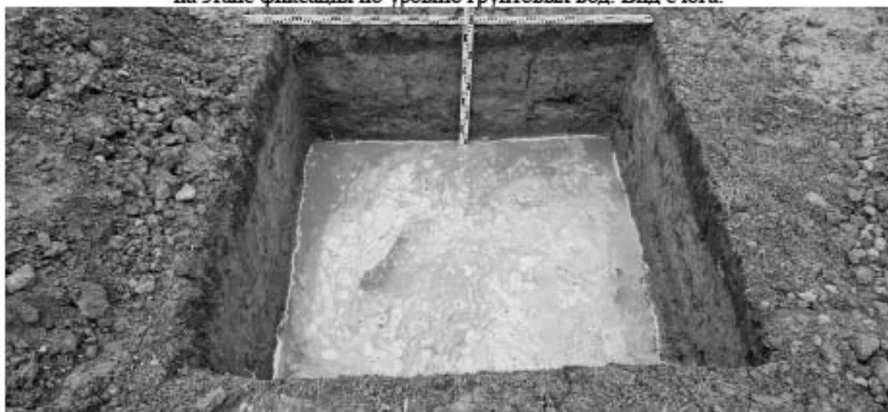
Рис.22. Санкт-Петербург, Красносельский р-н. ул. Десантников. Шурф №1. Фиксация по уровню грунтовых вод. Вид с юга.
