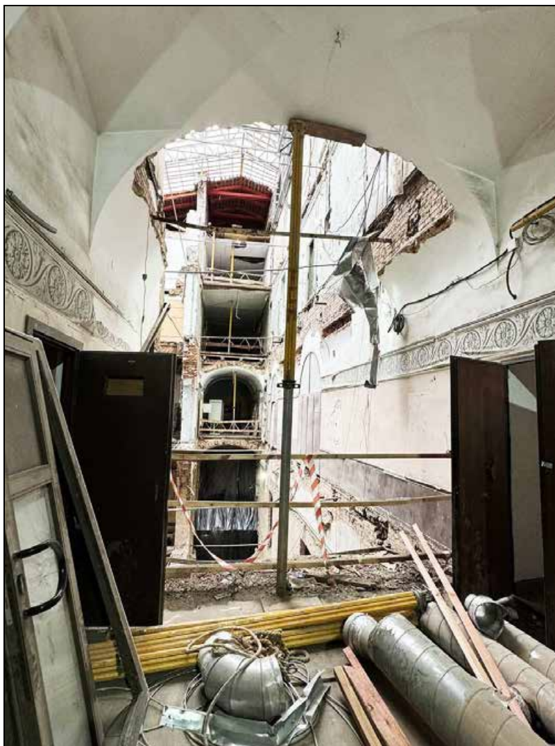
36. Объект культурного наследия регионального значения «Здание Коммерческого училища (с оградой)». 3-й этаж. Вид в сторону центрального коридора.
