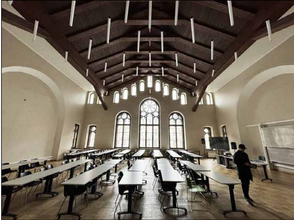
31. Объект культурного наследия регионального значения «Здание Коммерческого училища (с оградой)». 2-й этаж. Помещение 2-го этажа. Конференц-зал. Вид от входной двери в сторону окон.
