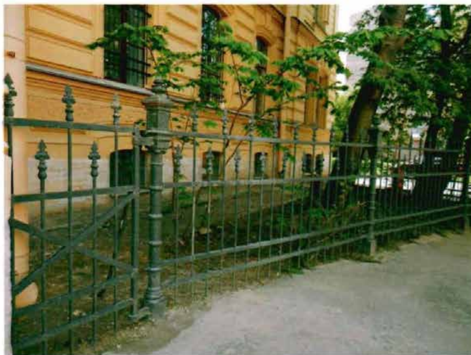
15. Северо-западная часть ограды
