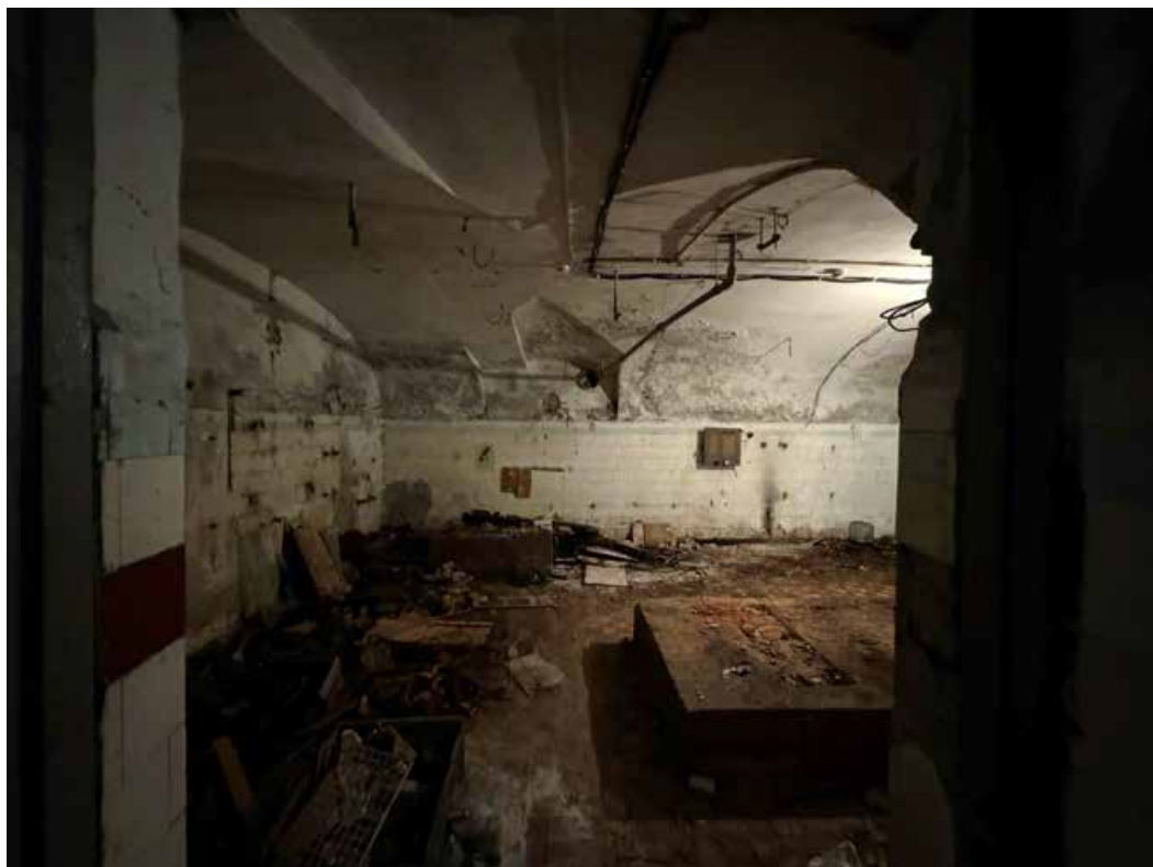
9. Объект культурного наследия регионального значения «Здание Коммерческого училища (с оградой)». Подвальное помещение. Общий вид.
