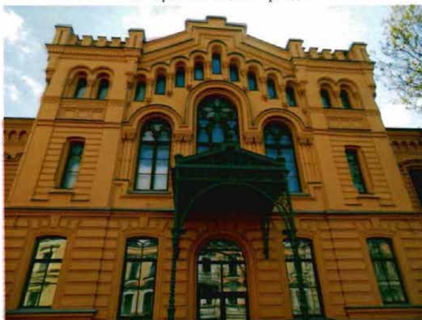
1. Фрагмент лицевого фасада
