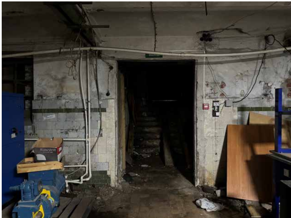
6. Объект культурного наследия регионального значения «Здание Коммерческого училища (с оградой)». Подвальное помещение. Вид в сторону дверного проёма.
