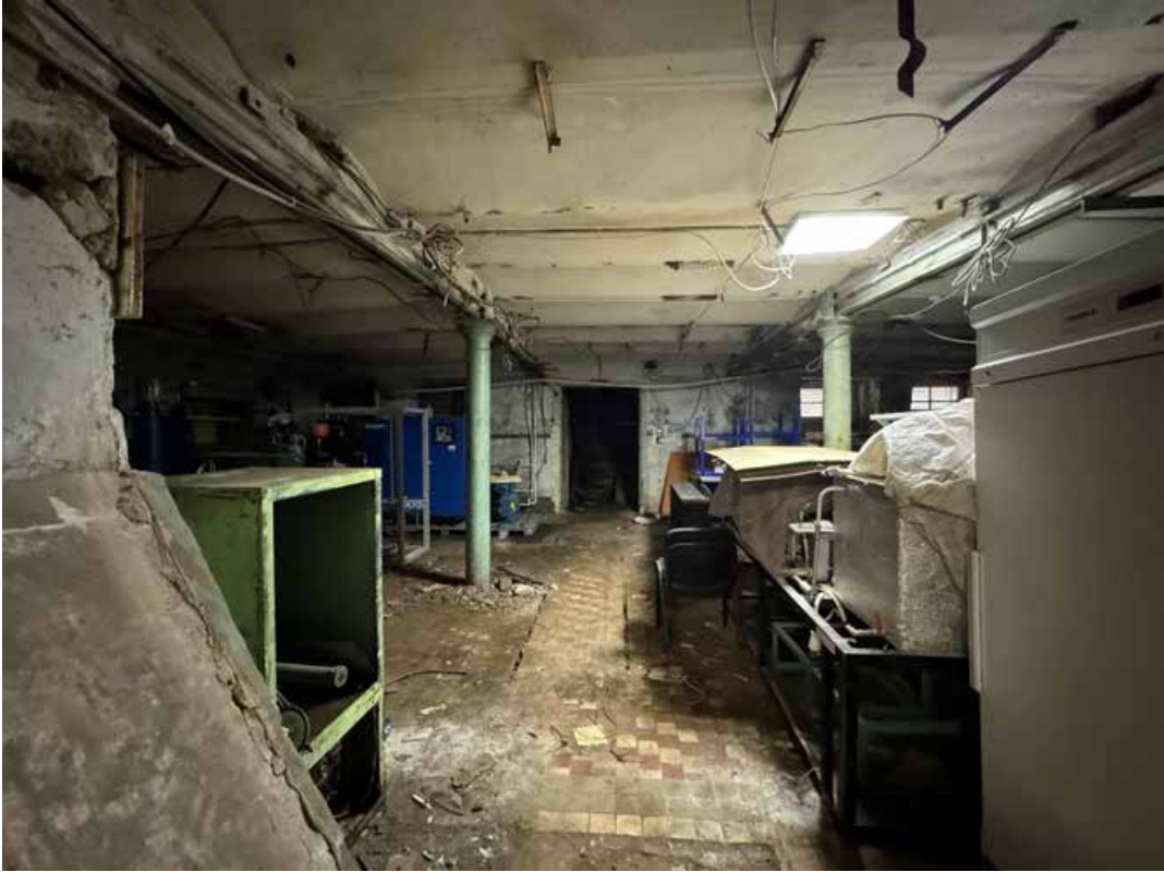
8. Объект культурного наследия регионального значения «Здание Коммерческого училища (с оградой)». Вид в сторону двери. Подвальное помещение.
