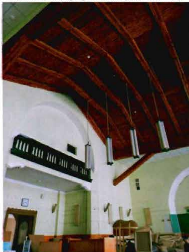
10. Актный зал (перекрытие, балкон на консолях)
