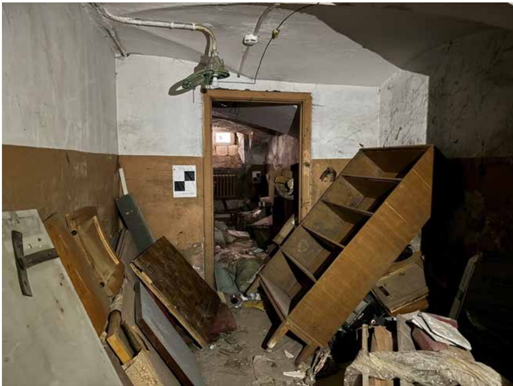
13. Объект культурного наследия регионального значения «Здание Коммерческого училища (с оградой)». Подвальное помещение. Вид в сторону дверного проёма.
