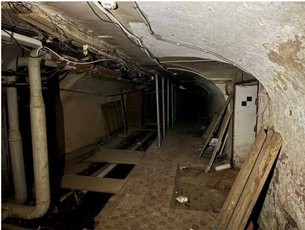
10. Объект культурного наследия регионального значения «Здание Коммерческого училища (с оградой)». Подвальное помещение. Вид в сторону оконных проёмов.
