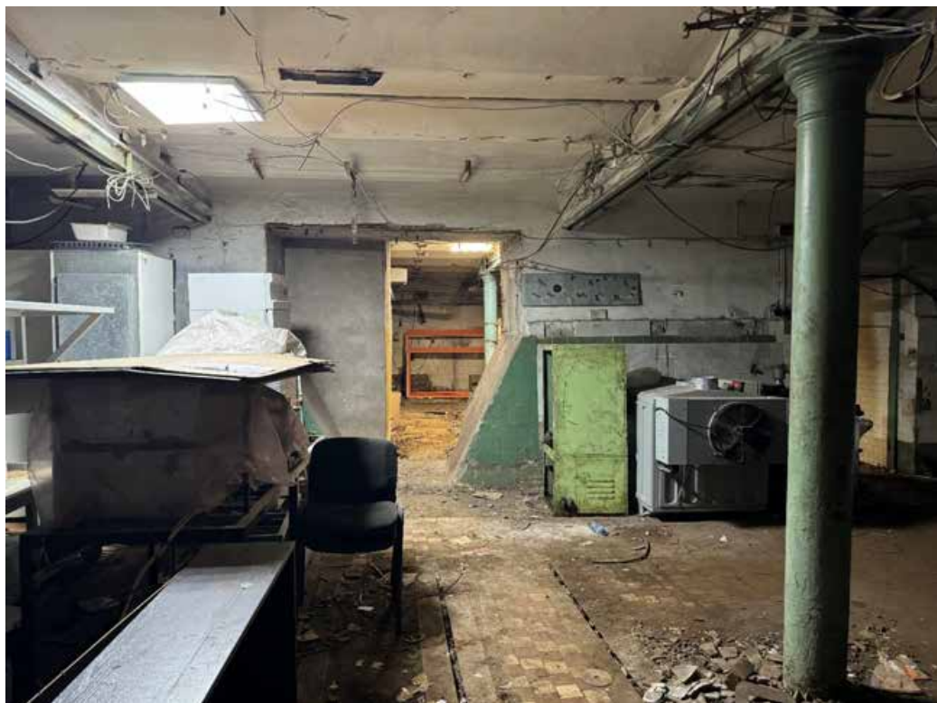
7. Объект культурного наследия регионального значения «Здание Коммерческого училища (с оградой)». Вид в сторону дверного проёма. Подвальное помещение. Общий вид.
