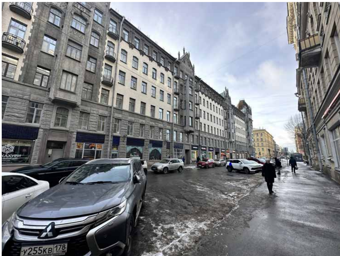
1. Общий вид на главный фасад здания
