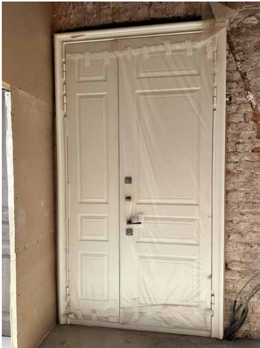
5. Вид на входную дверь в квартире;
