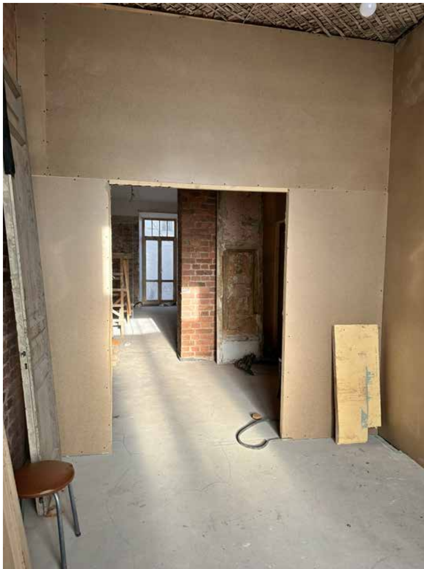
7. Фрагмент интерьера комнаты (помещение №12);
