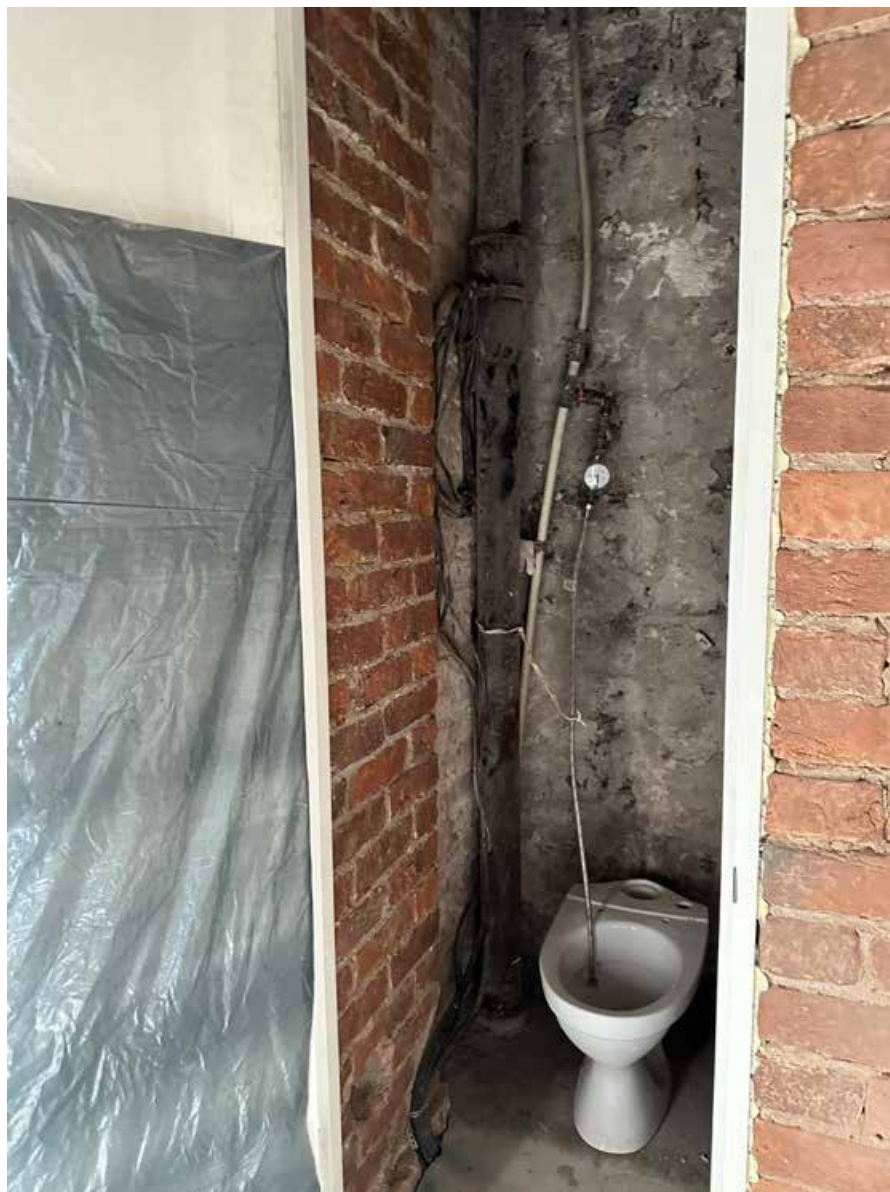
19. Фрагмент интерьера санузла помещение №7;
