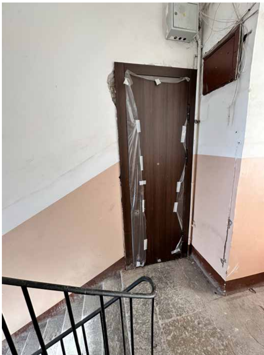
18. Входная дверь в квартиру;
