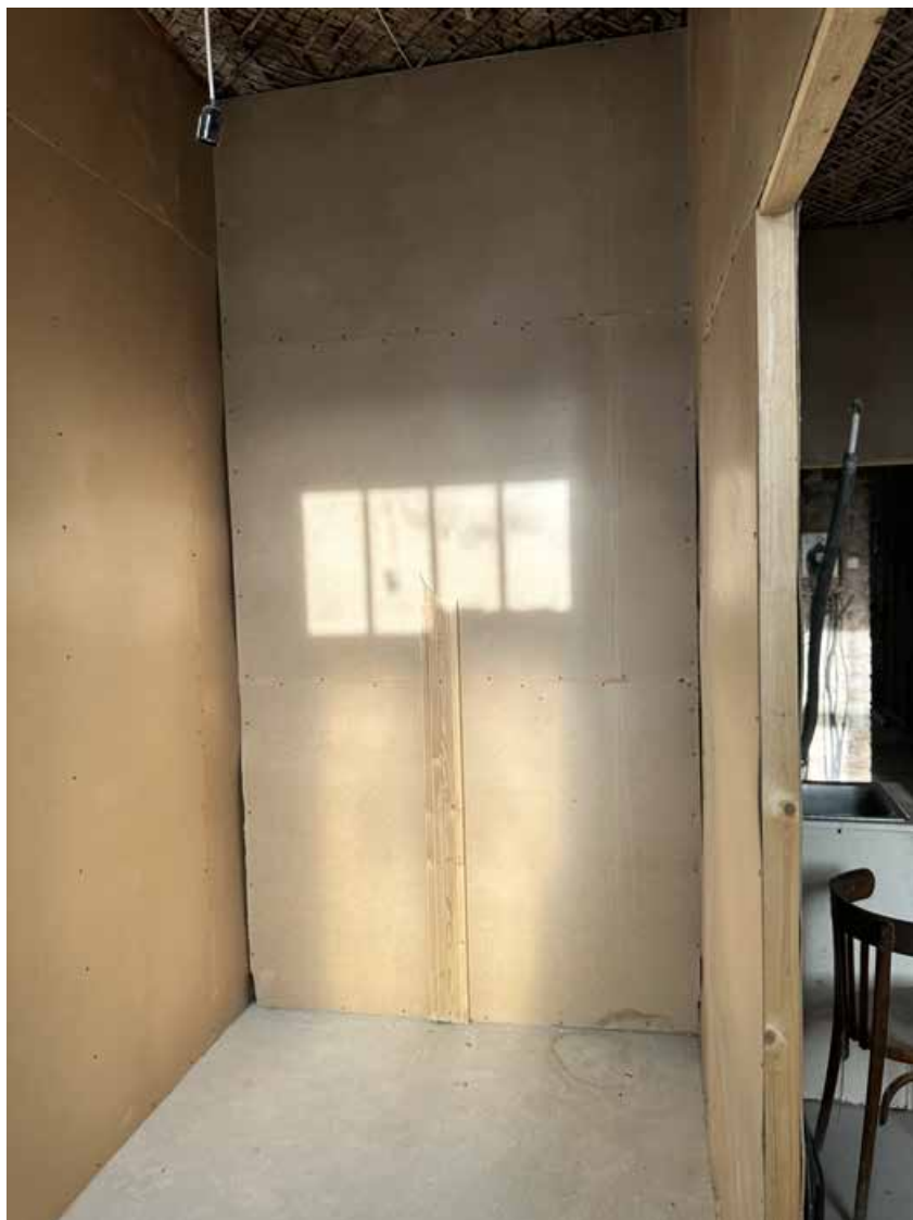
16. Фрагмент интерьера комнаты помещение №11;
