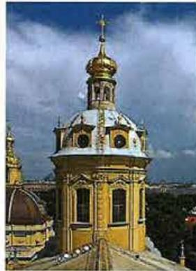
крыша – клепаная металлическая обрешетка; материал окрытия (листовое железо); исторический колер окраски внешней поверхности крыши;
