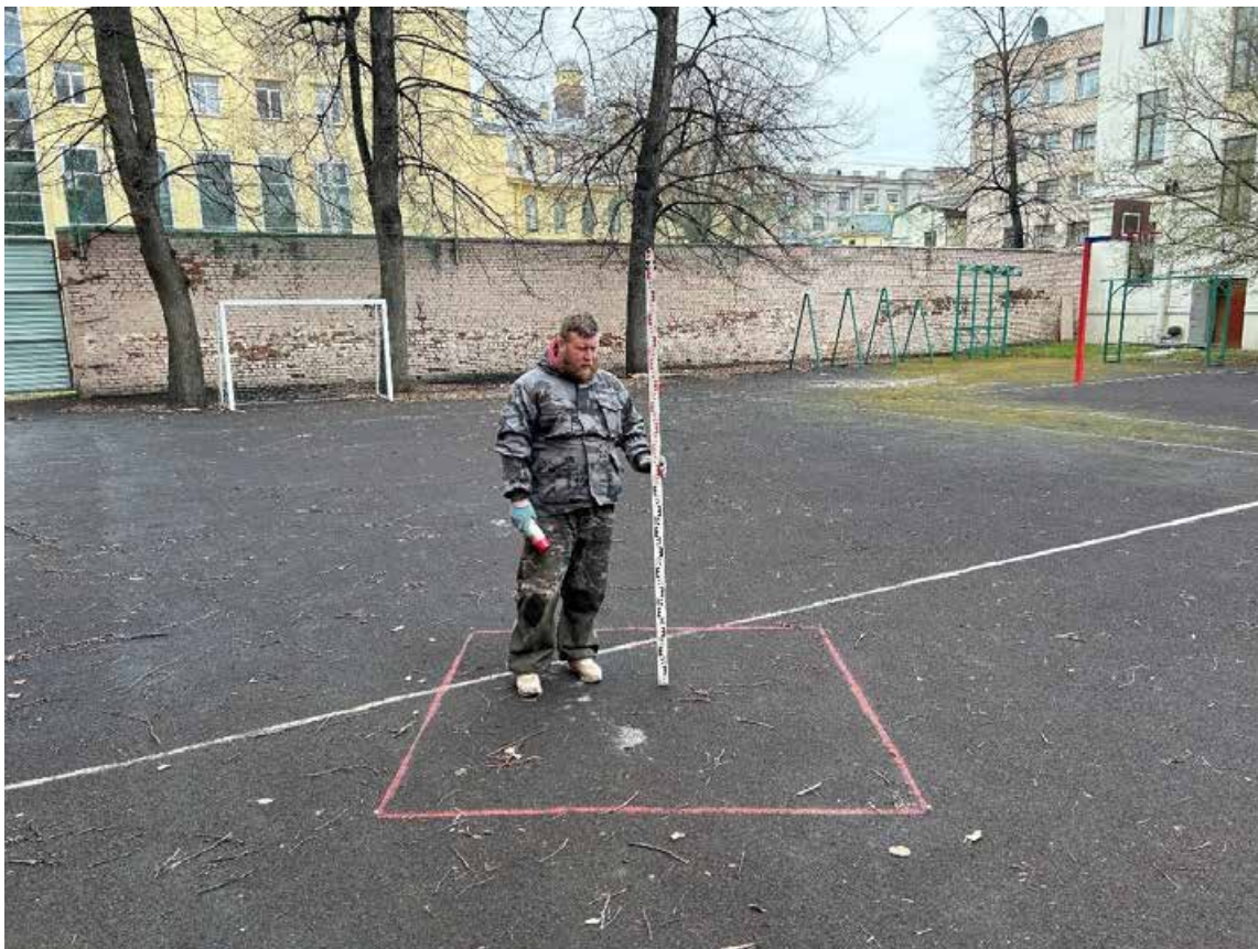
Ил. 28. Санкт-Петербург, Петроградский р-н ул. Мира, д. 18, литера А. Шурф 1. Вид до начала работ с юга. Для масштаба использована рейка длиной 2 м.
