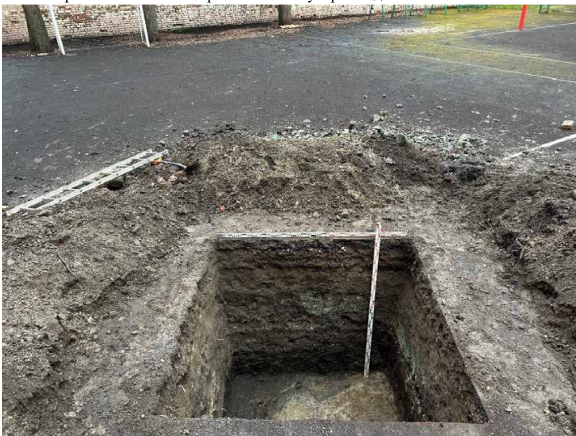
Ил. 31. Санкт-Петербург, Петроградский р-н ул. Мира, д. 18, литера А. Шурф 1. Общий вид шурфа на уровне материка. Вид с юга.
