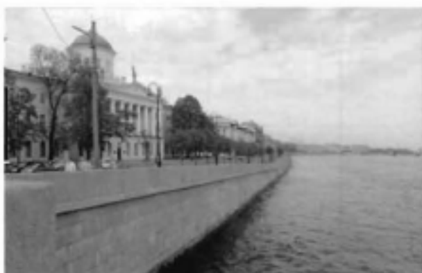
1. Вид стенки набережной от Биржевого моста
