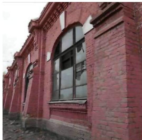
детали, выполненные в кирпиче: рельеф-датировка на торцевых фасадах “1897-1898”, филенки, поребрики, ступенчатые карнизы, стилизованные машикули;
