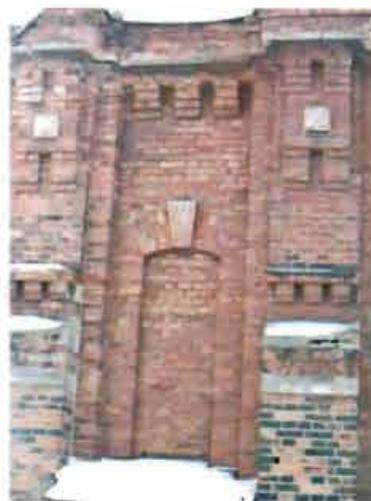
фрагменты и детали, выполненные с использованием бетона - замковые камни, полочки, круглые и квадратные медальоны; профилированные карнизы торцевых фасадов;
