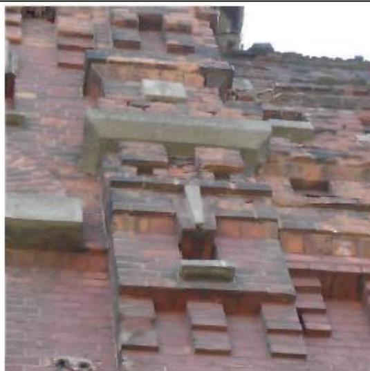
детали, выполненные с использованием бетона – замковые камни, полочки, круглые и квадратные медальоны, профилированные карнизы торцевых фасадов;
