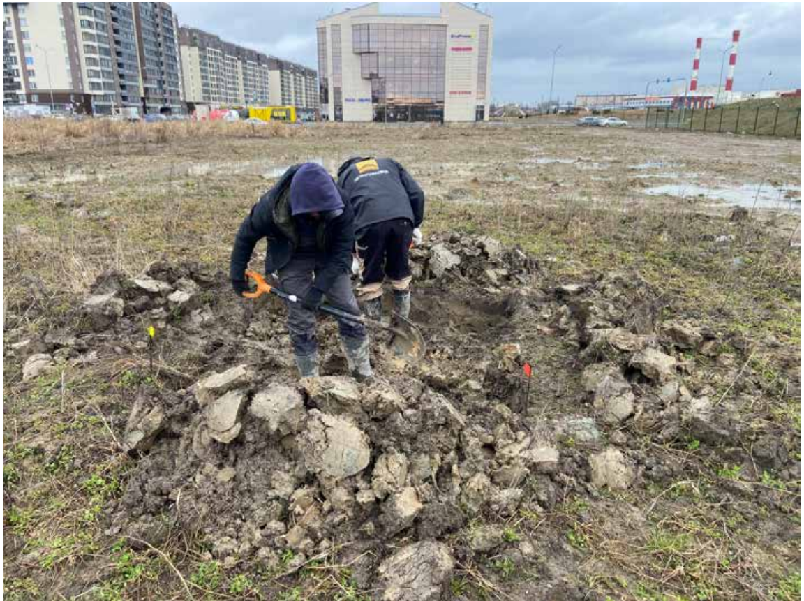
Рис. 29. Санкт-Петербург, кадастровый номер ЗУ: 78:40:0008501:10820. Шурф 1. Процесс работ. Вид с юга.
