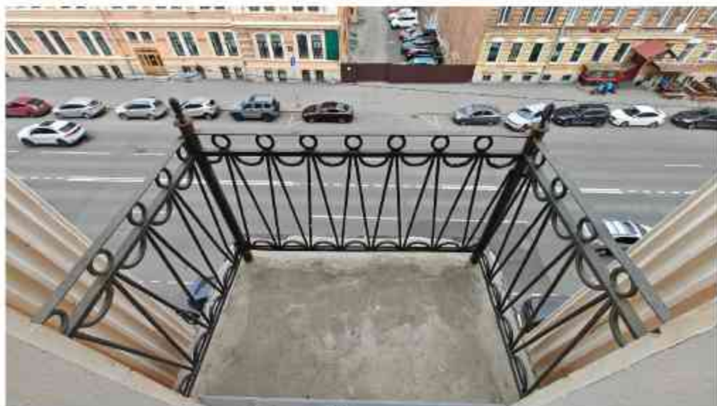
8. Вид на балконное ограждение
