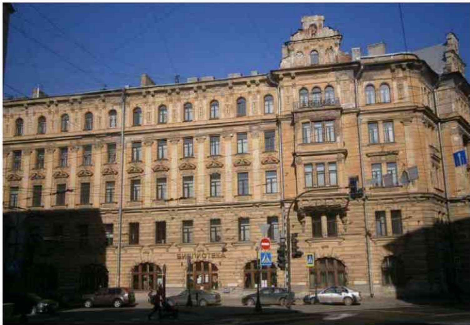
57.2-ая Советская ул., 27. Фрагмент лицевого фасада по пр. Бакунина. Фото 2011. // Источник: http://www.citywalls.ru/house25774.html (дата обращения: 15.04.2024).
