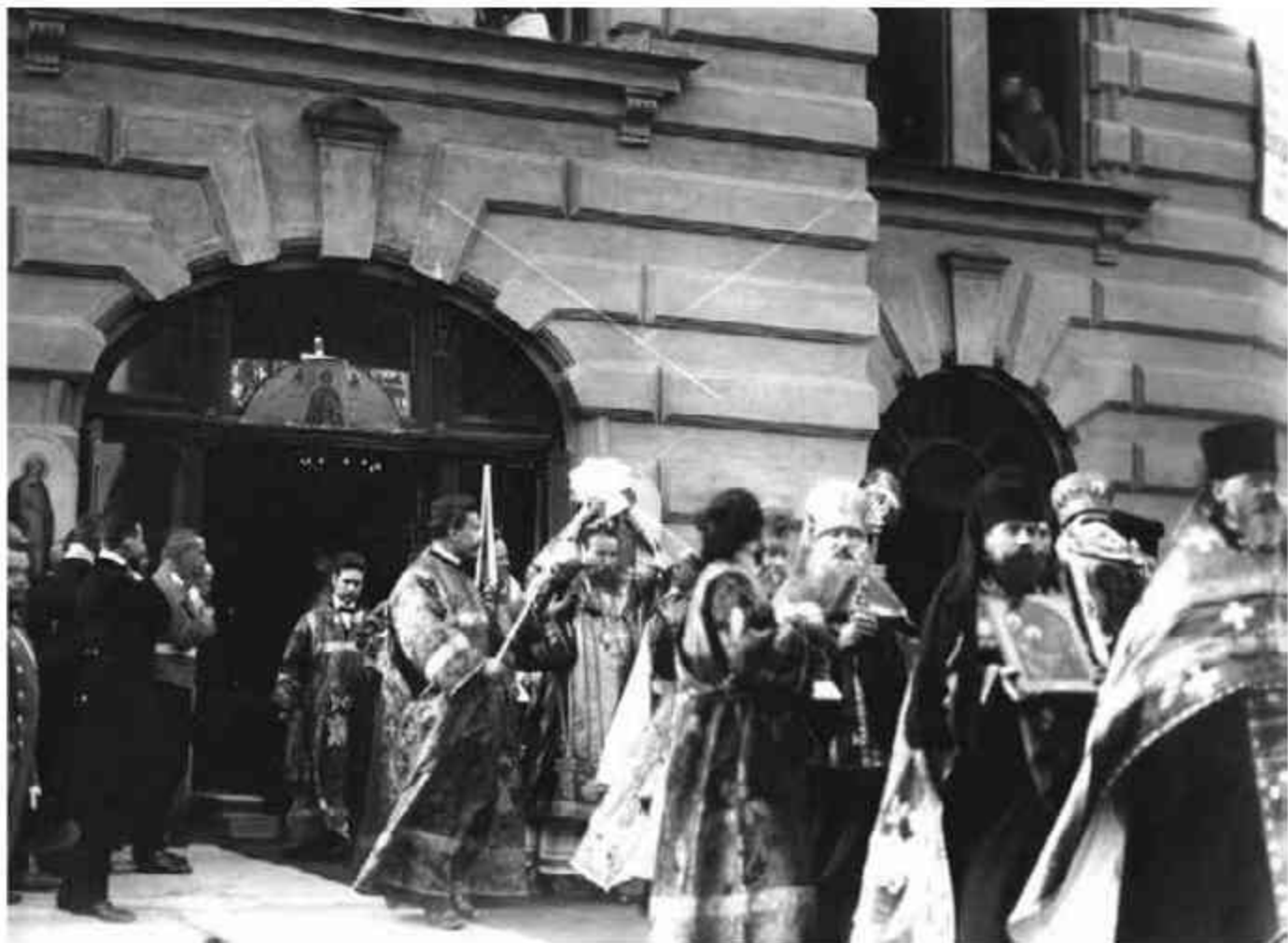
47. Закладка Николо-Александровского («Барградского») храма на перекрестке пр. Бакунина и 2-й Советской ул. Фрагмент восточного фасада дома И.В. Галунова, 1913 г. // Источник: ЦГАКФФД СПб Гр 23043.
