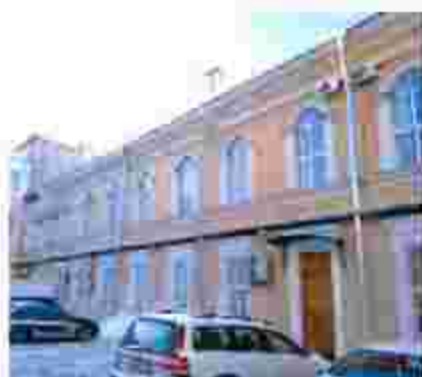
5. Вид на дворовой фасада по ул. Труда.
