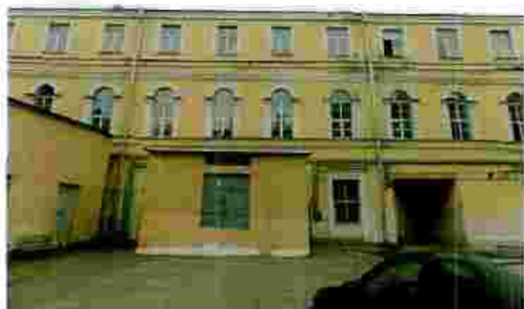
2. Южный фасад. Воротной проезд между дворами.
