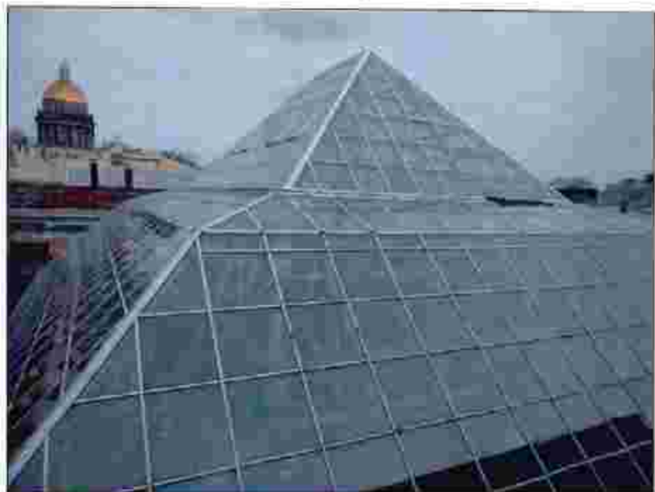
7. Конструкция светового фонаря над операционным залом.
