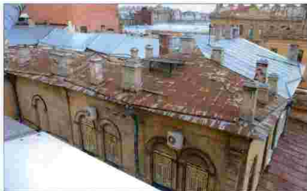
19. Объект культурного наследия. Вид с юго-востока на кровлю дворовых флигелей.
