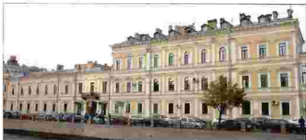
1. Объект культурного наследия. Общий вид с юго-востока.
