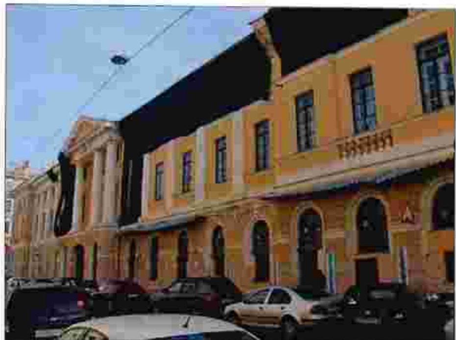
3. Северный лицевой фасад. Вид с запада.
