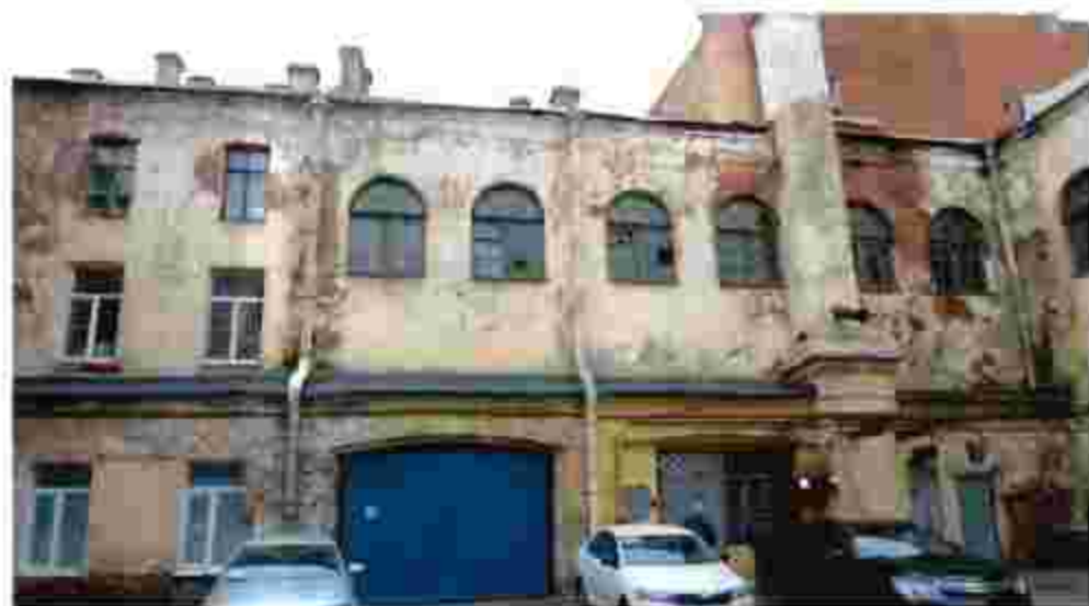
9. Юго-западный двор. Вид с севера.
