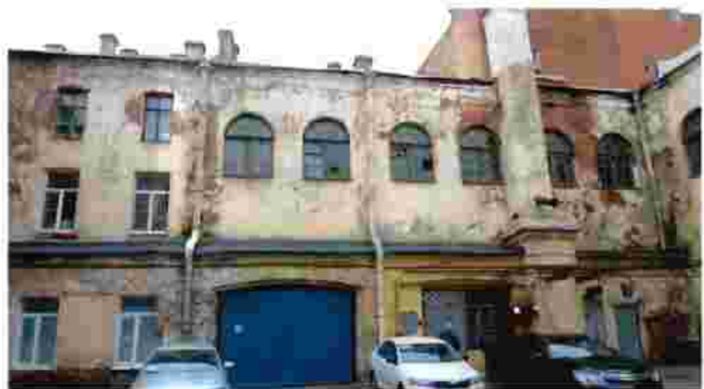
9. Юго-западный двор. Вид с севера.
