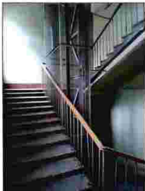
14. Лестница в западном корпусе по ул. Якубинца.
