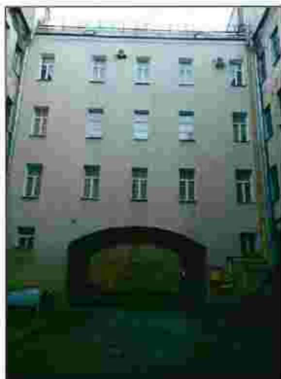
5. Поперечный двороний корпус. Вид с северо-запада.
