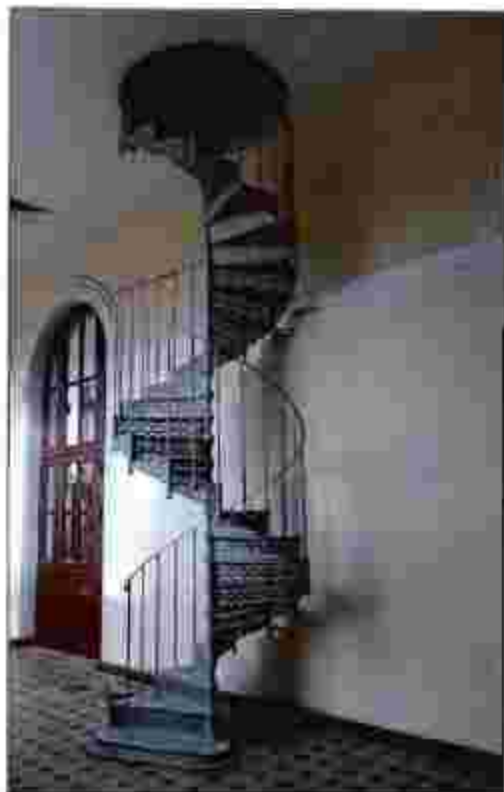
11. Металлическая винтовая лестница в восточной части операционного зала.
