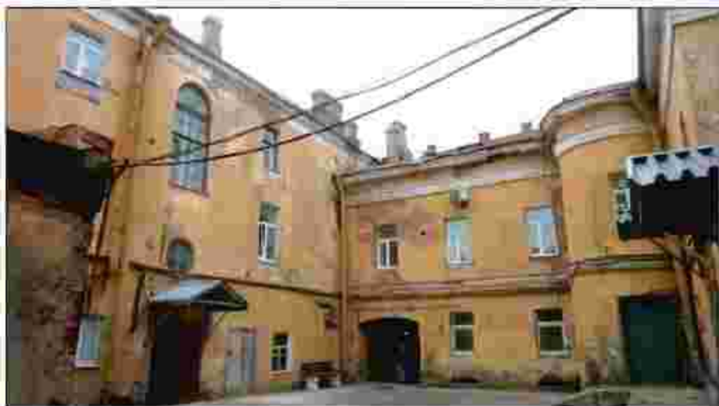
15. Фасады объекта культурного наследия, выходящие на северо-восточную дворовую территорию
