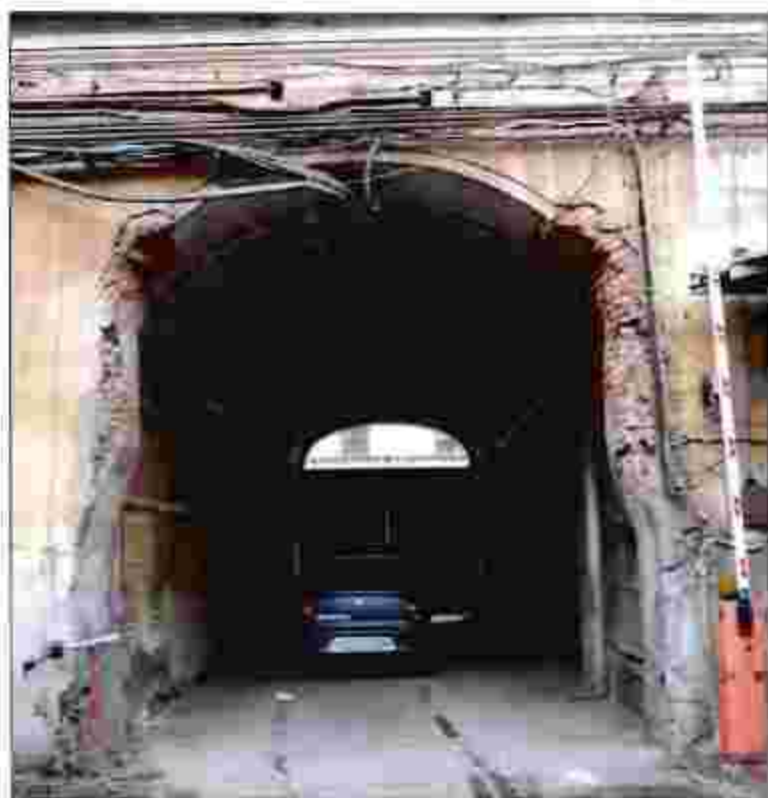
6. Проездная арка со стороны ул. Якубовича. Вид с юга.
