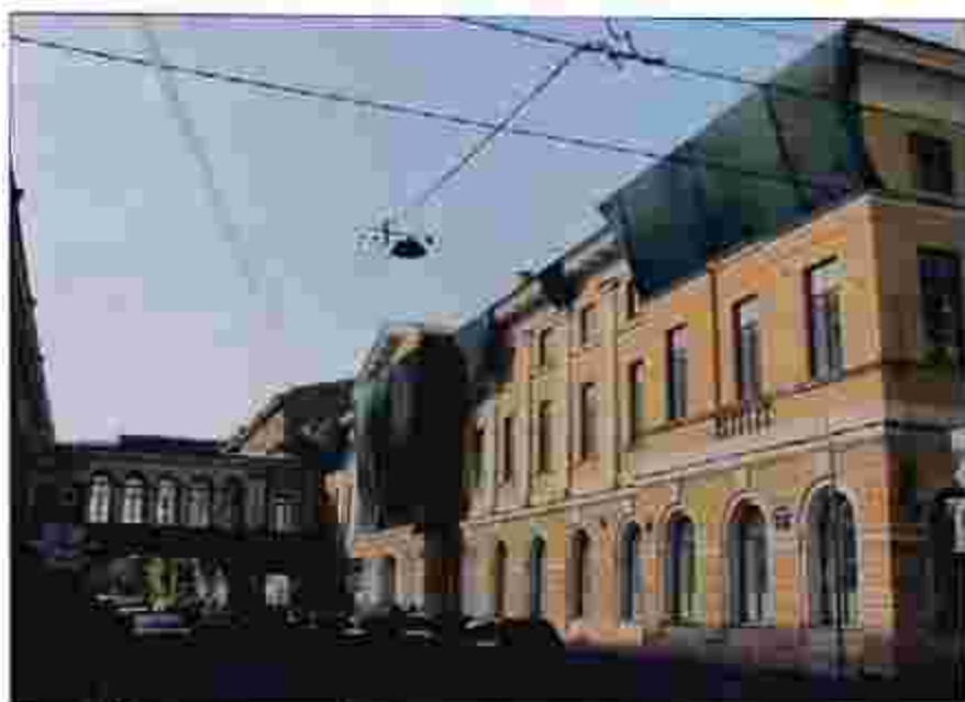
1. Южный лицевой фасад с переходной галереей. Вид с двора.
