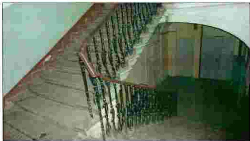
12. Лестница (5 ЛК). Корпус по ул. Якубовича.
