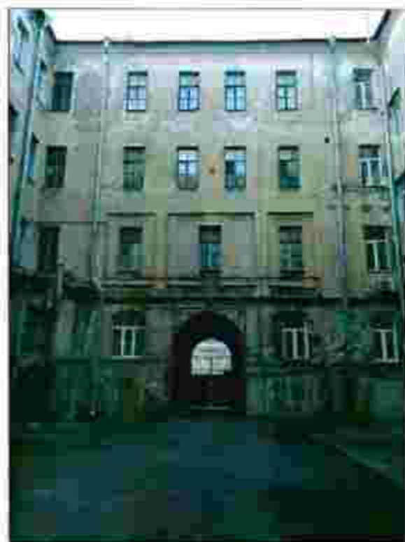
6. Северный двороний фасад корпуса по ул. Якубовича.
