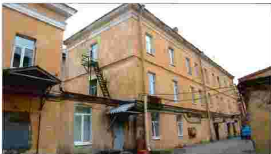
16. Объект культурного наследия. Дворовые фасады корпусов по Почтамтской ул. Вид с юго-запада.
