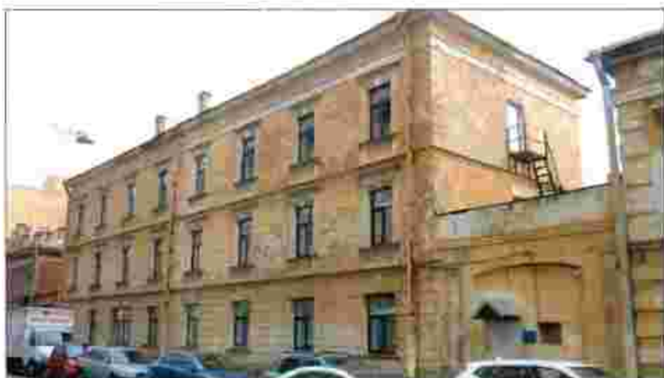
17. Объект культурного наследия. Лицевой фасад трехэтажного корпуса по Почтамтской ул. Вид с запада.
