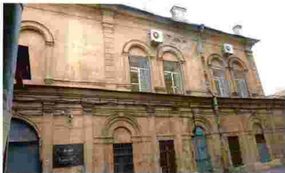
6. Объект культурного наследия. Северный фасад дворового корпуса.
