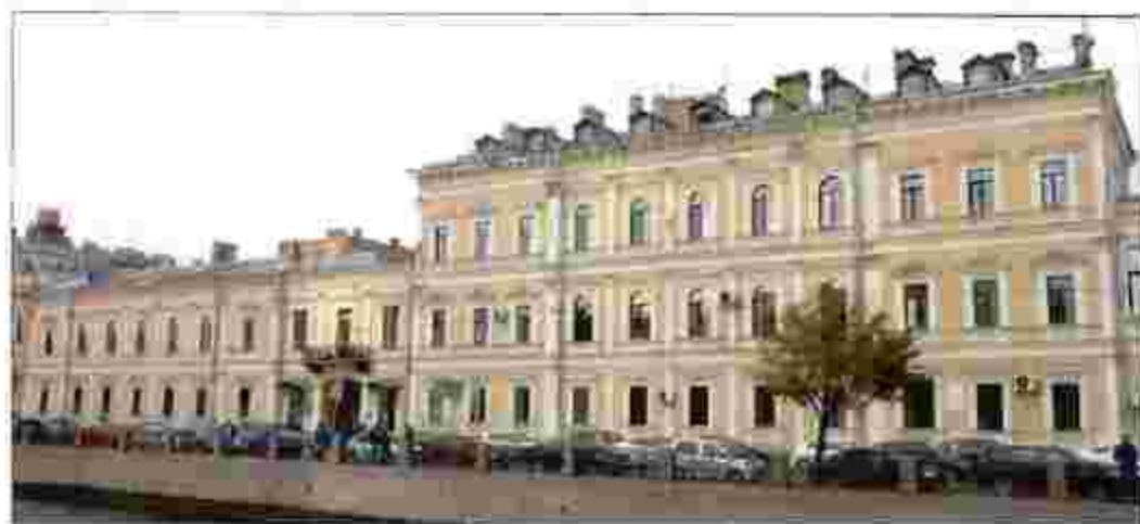
1. Объект культурного наследия. Общий вид с юго-востока.
