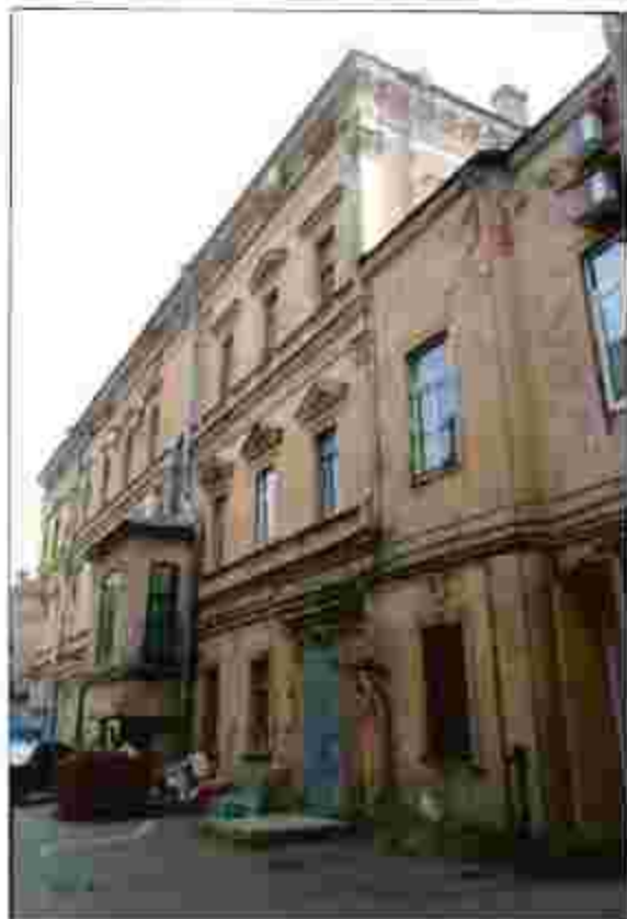
4. Объект культурного наследия. Дворовый фасад корпуса по ул. Большой Морской. Юго-восточный двор. Вид с запада.
