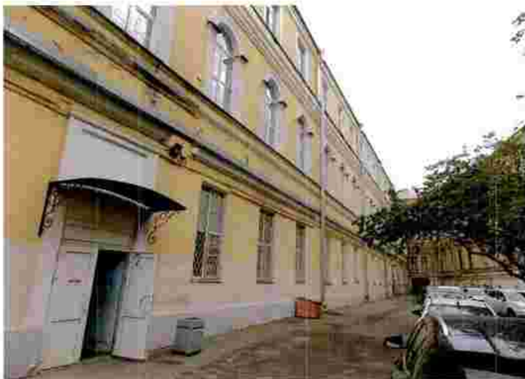
1. Общий вид на объект культурного наследия (фасад с юго-восточной стороны).
