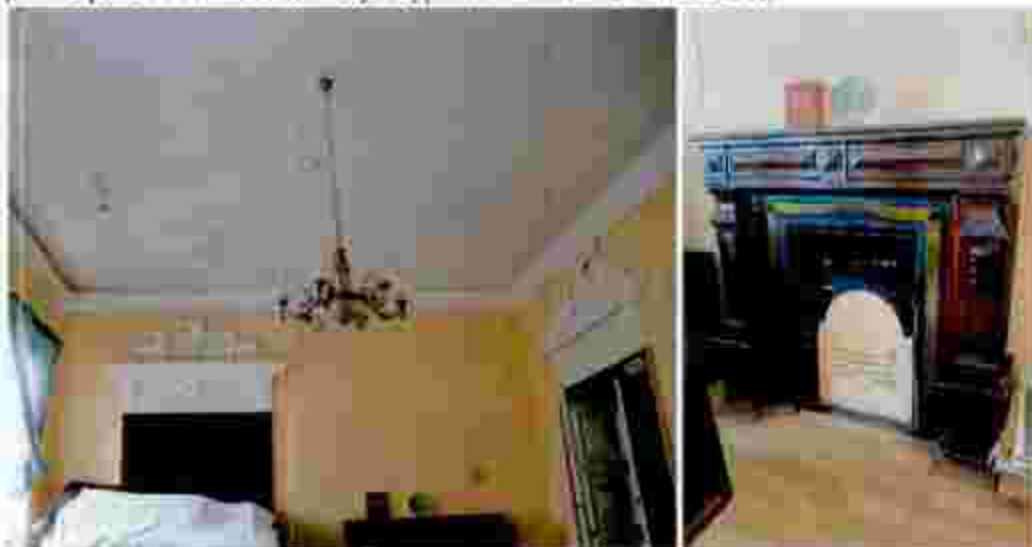
20,21. Интерьер помещения «Охотничий зал (пом. № 349, площадью 44,7 кв.м.)» - 3-Н (рис.19) в уровне третьего этажа объекта культурного наследия. (02.02.2024 г.)
