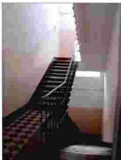
12. Лестница в каждом корпусе по ул. Потаповской.
