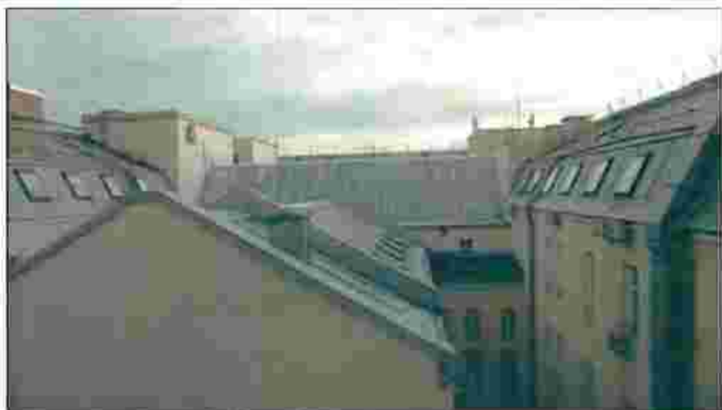
7. Кровля. Вид с северо-запада.
