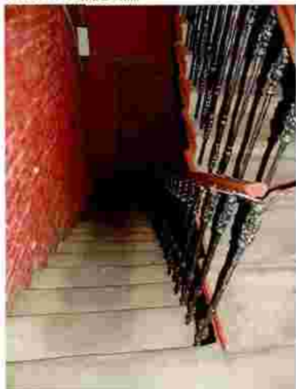
19. Лестница, расположенная в северной части корпуса по Большой Морской
