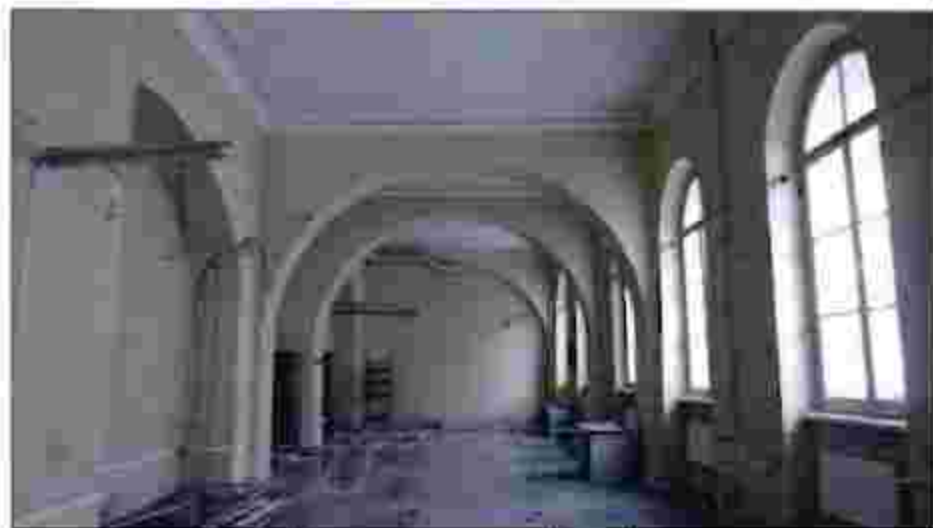
10. Перекрытие на арках. Первый этаж.
