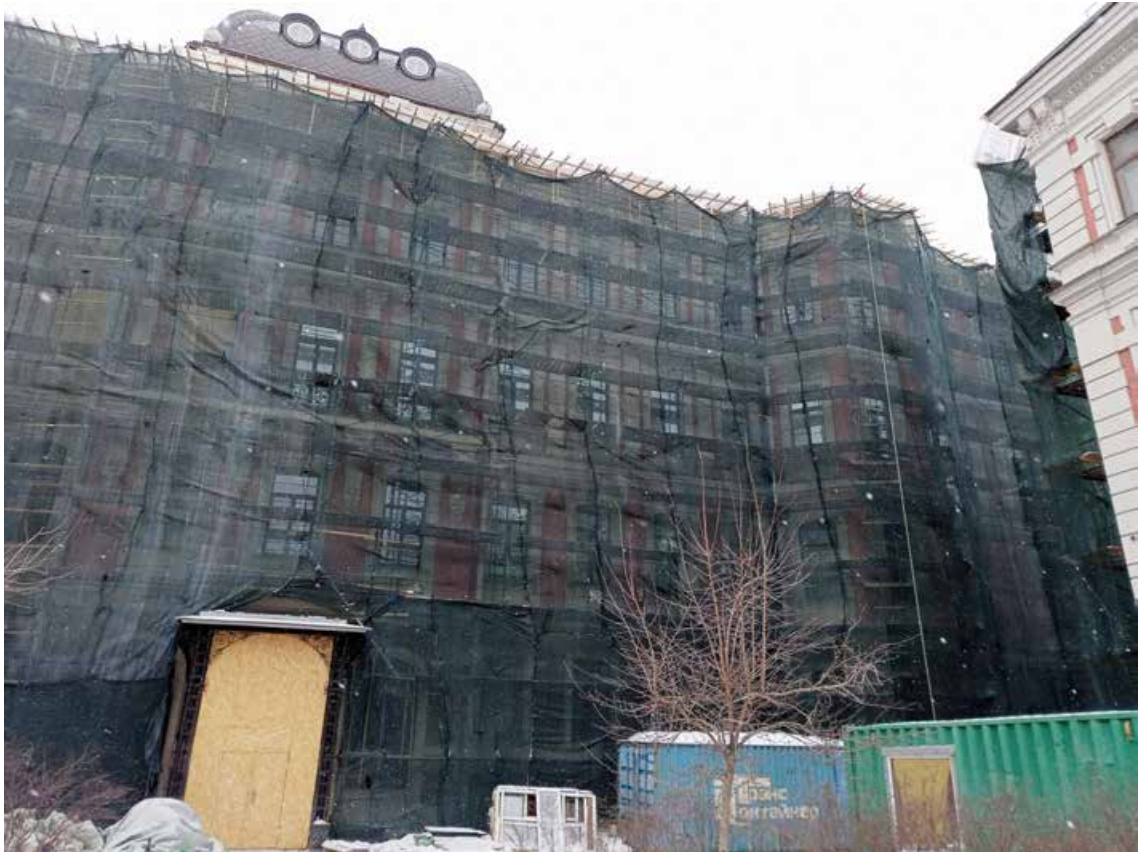
Фото 3. Фрагмент лицевого фасада здания по ул. Моховая. Правая часть.
