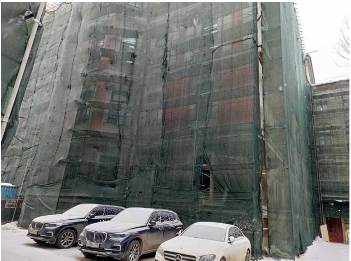
Фото 4. Фрагмент лицевого фасада здания по ул. Моховая. Правая часть.
