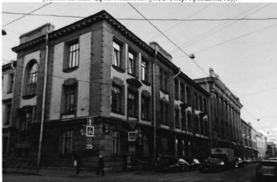
Фото 1. Южный фасад и часть западного фасада.
