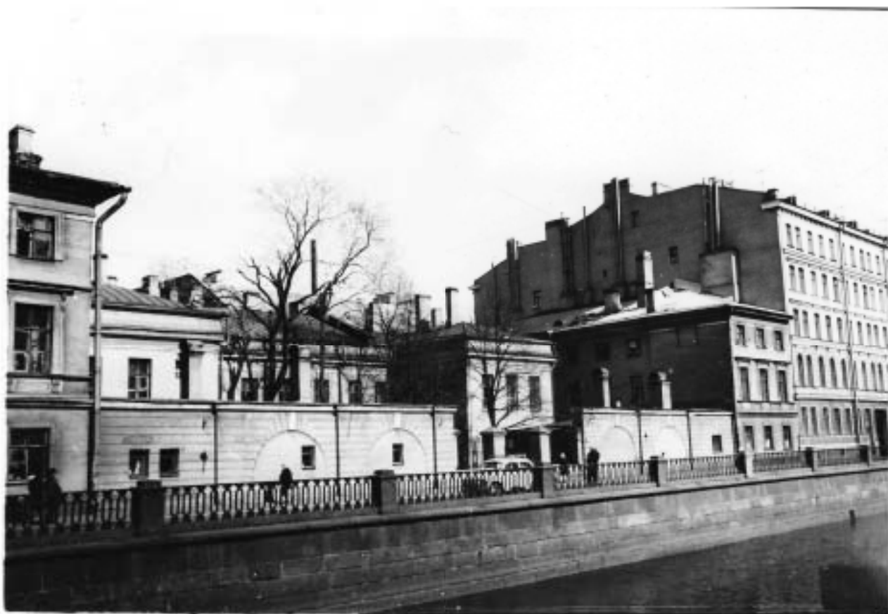
41. Вид правого берега канала Грибоедова по линии домов № 49-51-53. В центре здания бывшей Пробирной палаты и Пробирного училища (1875-1876 гг., архитектор Г.Б.Прагг, не сохранилось). Дата съемки: апрель 1970 г. // Источник: ЦГАКФФД СПб. Фотодокумент Ар 225558.
