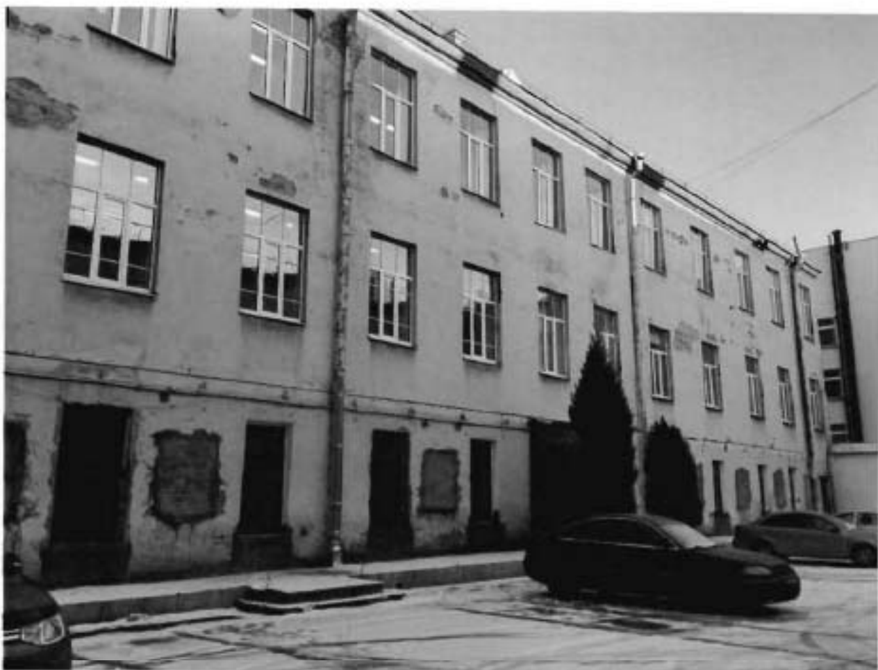
Фото 11. Дворовый фасад (северный).
