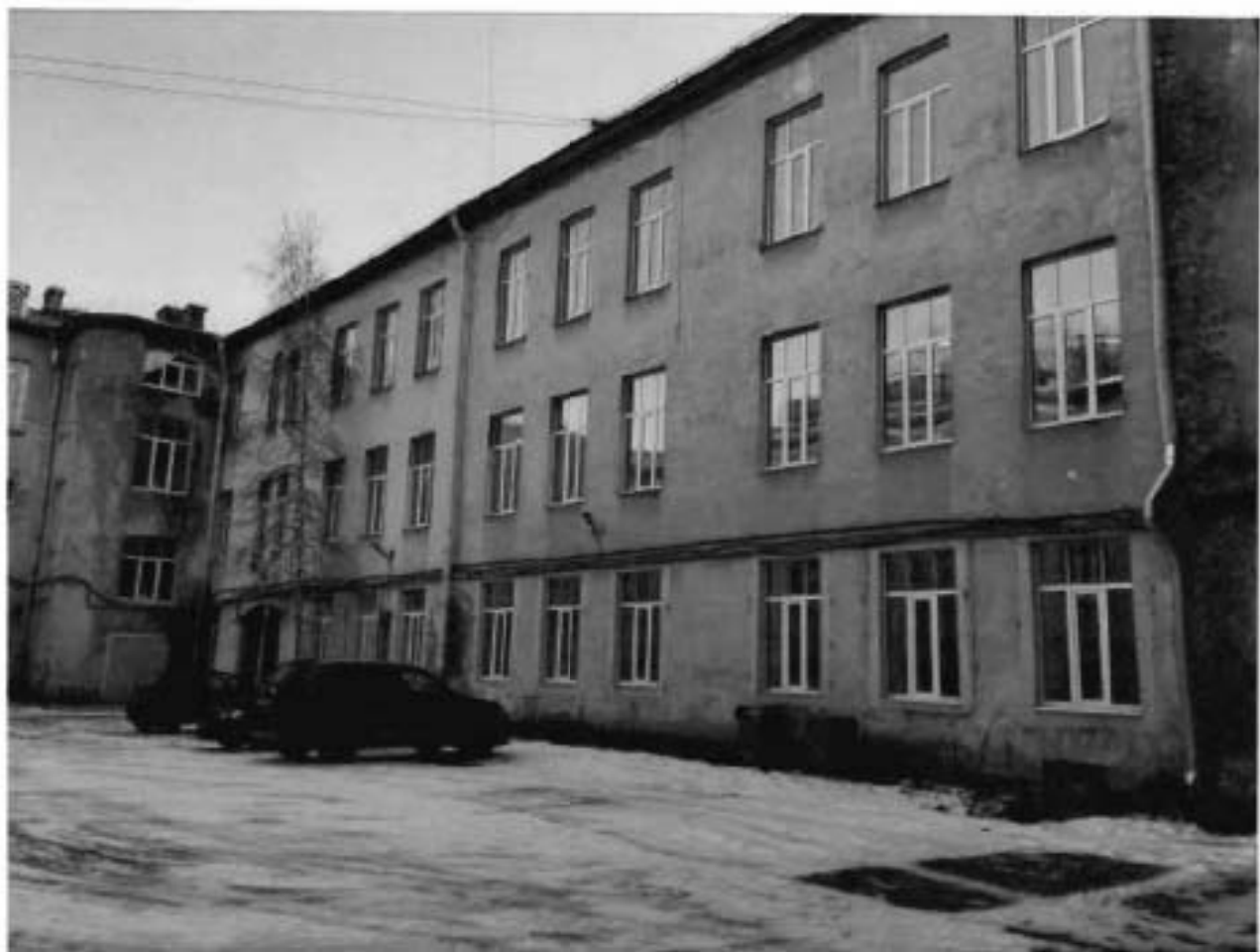
Фото 9. Дворовый фасад (южный).
