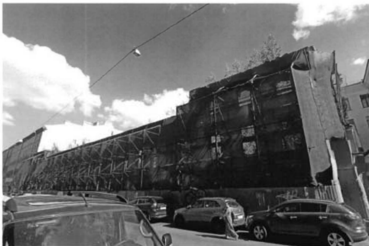
1. Вид на объект культурного наследия с северо-западной стороны.
