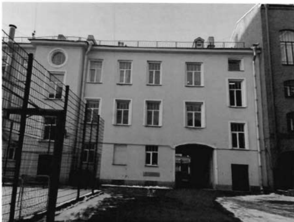
Фото 7. Дворовый фасад (западный).
