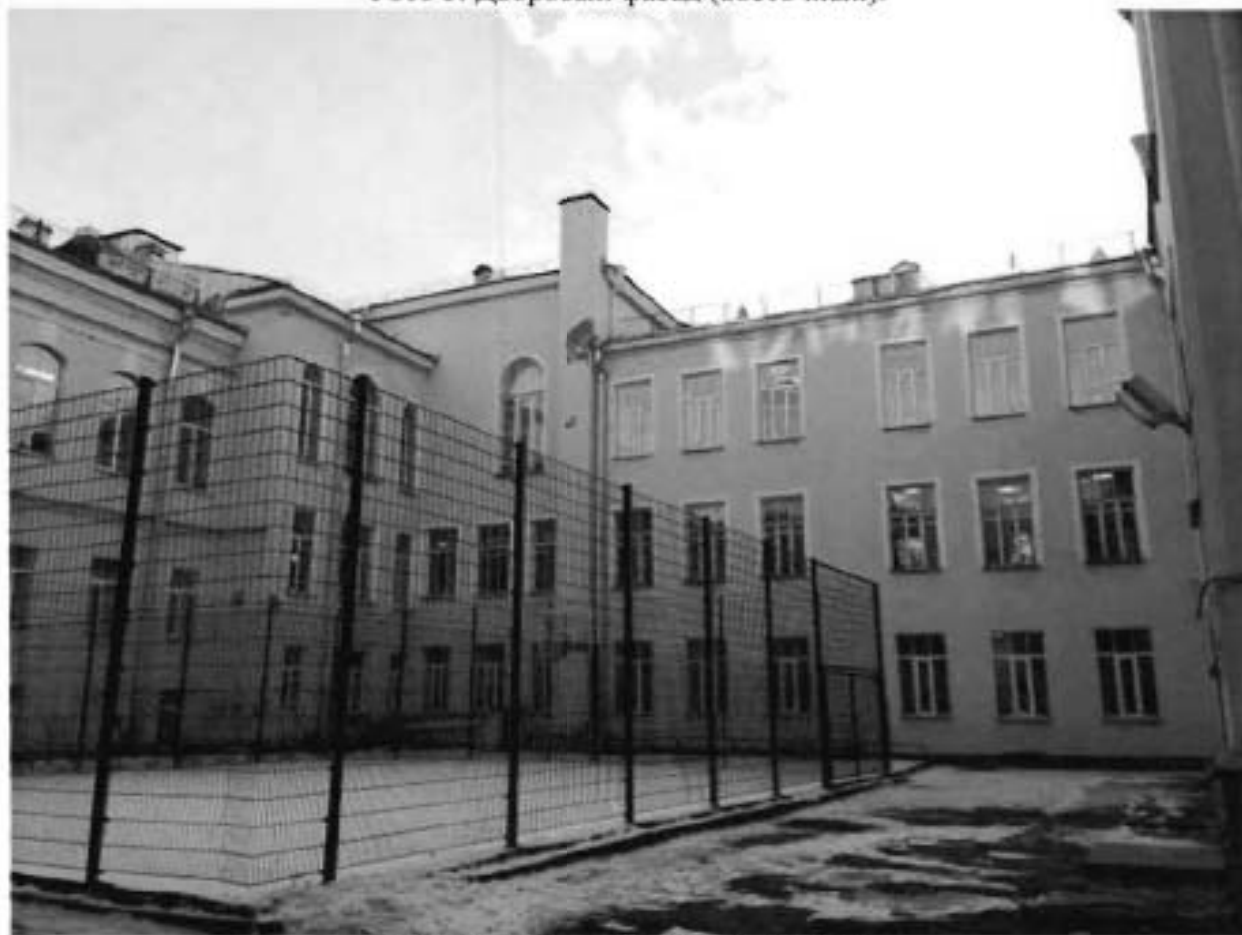
Фото 6. Дворовый фасад (южный).
