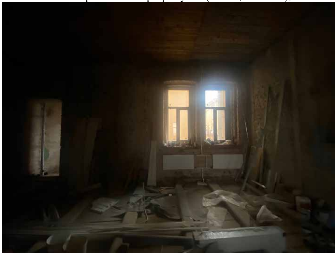
18.Фрагмент интерьера комнаты (помещение 7/25.8);
