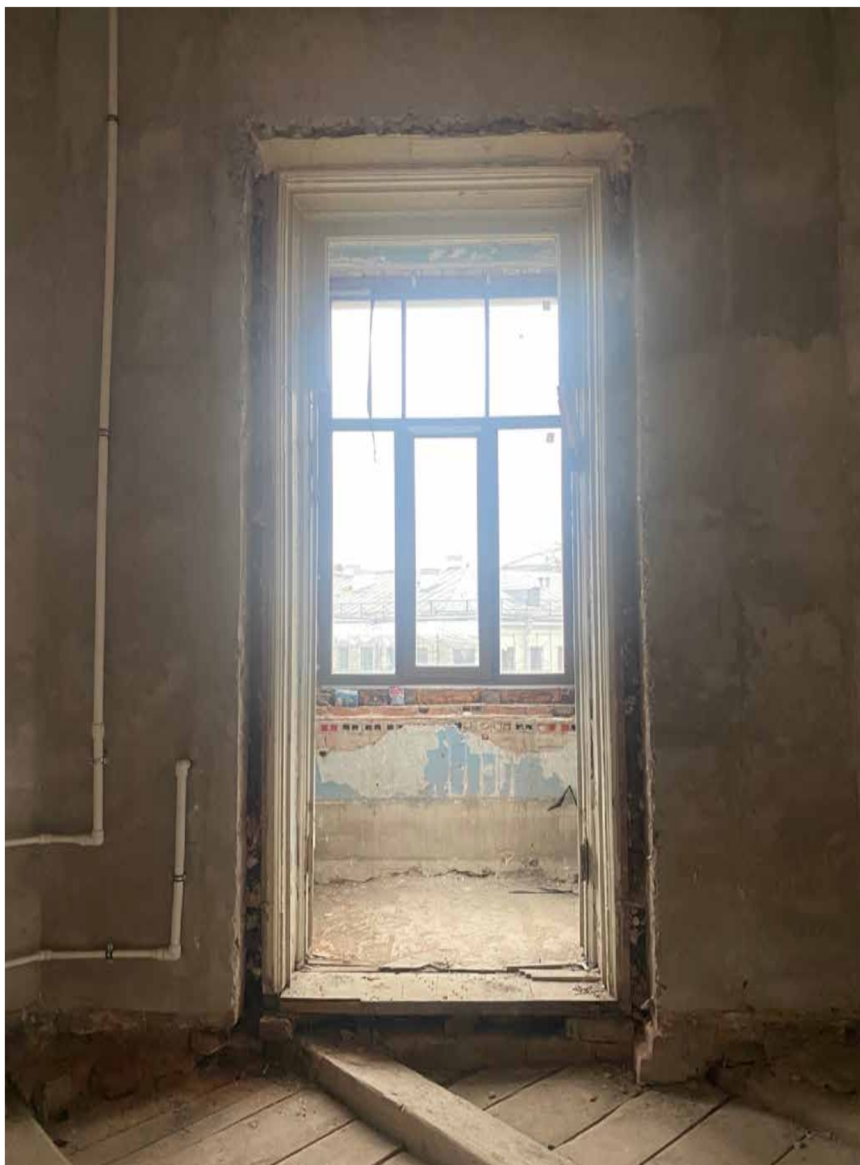
9. Фрагмент интерьера комнаты (помещение 3/16.7; 21/11.1; 22; 4/20);
