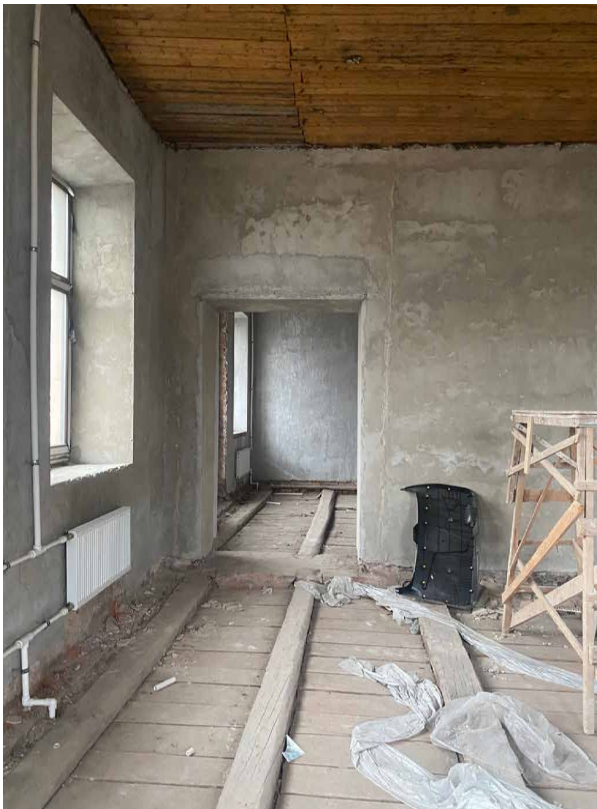
11. Фрагмент интерьера комнаты (помещение 3/16.7; 21/11.1; 22; 4/20);
