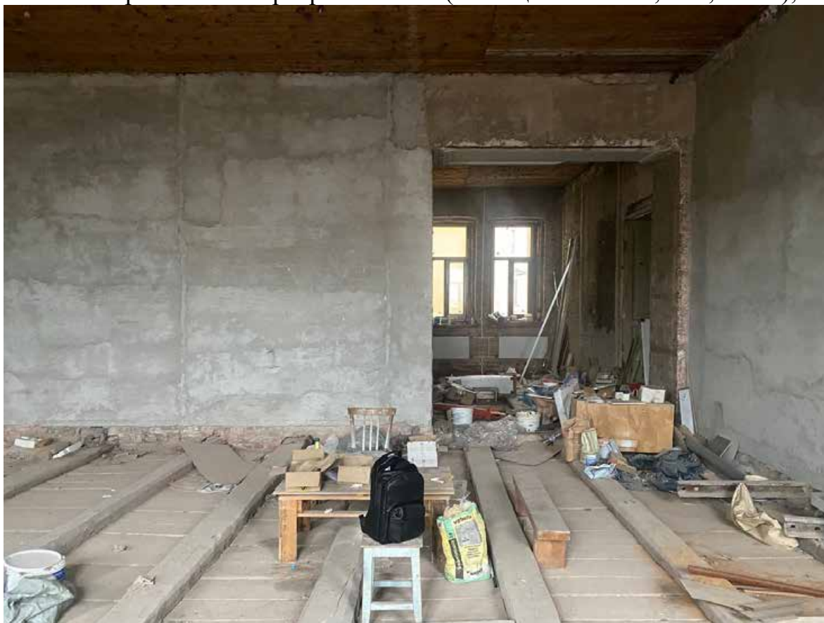
7. Фрагмент интерьера комнаты (помещение 14/8.5;1/18;2/43.4);
