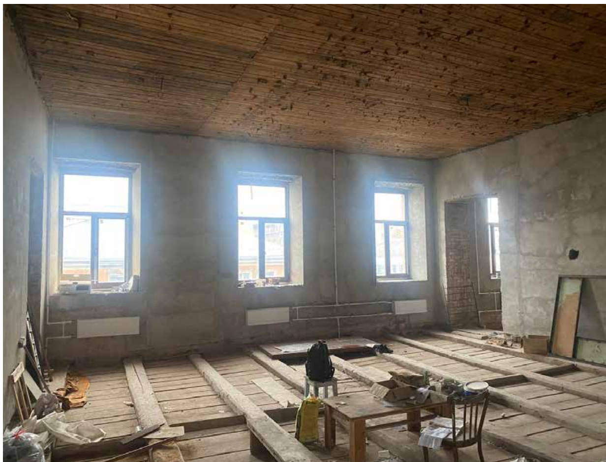
6. Фрагмент интерьера комнаты (помещение 14/8.5;1/18;2/43.4);
