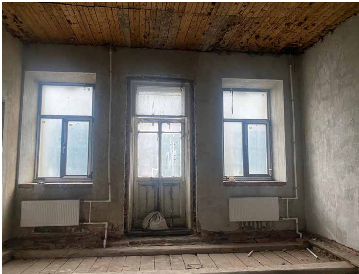
14. Фрагмент интерьера комнаты (помещение 5/24.8; 6/14.9; 10/7.2);
