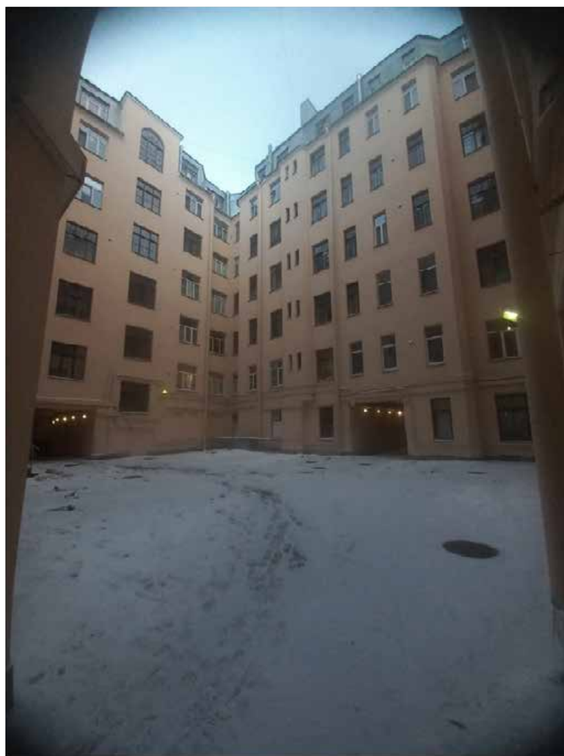
Фото 5. Здание по адресу: улица Некрасова, дом 58, литера А. Второй внутренний двор.
