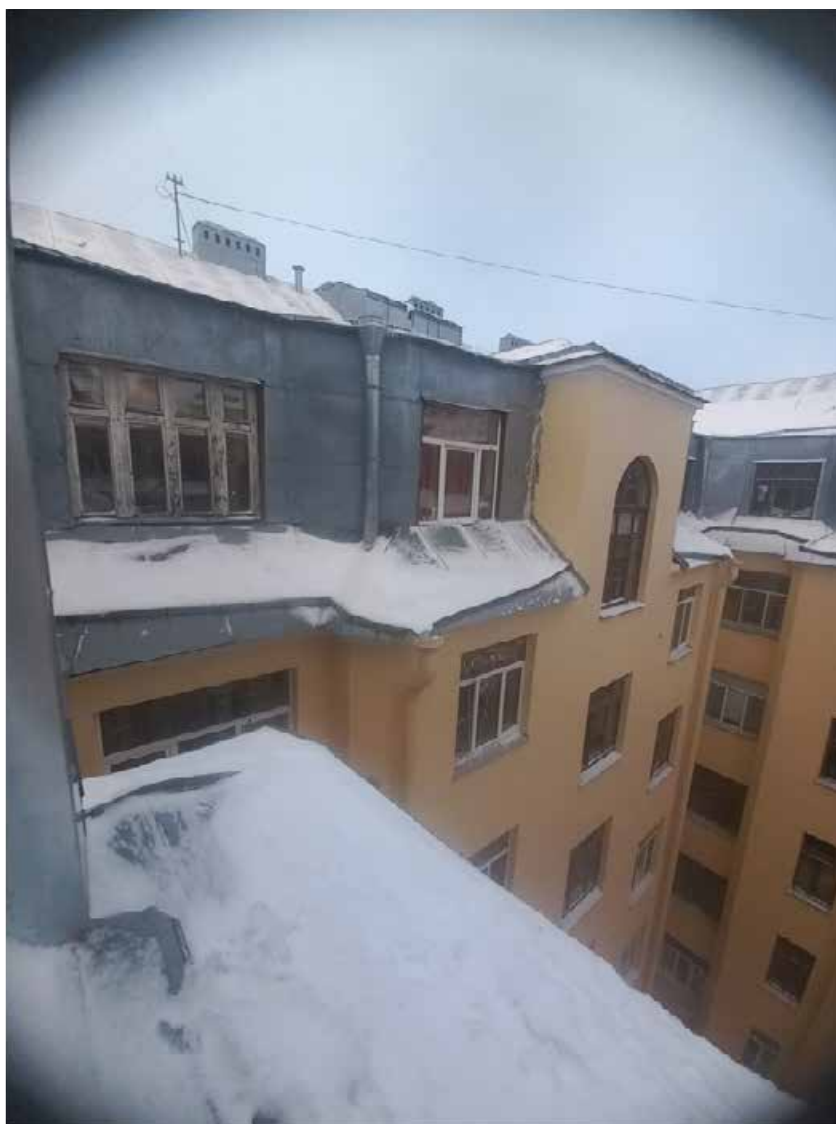
Фото 26. Мансарда. Оконные заполнения рассматриваемых помещений.
