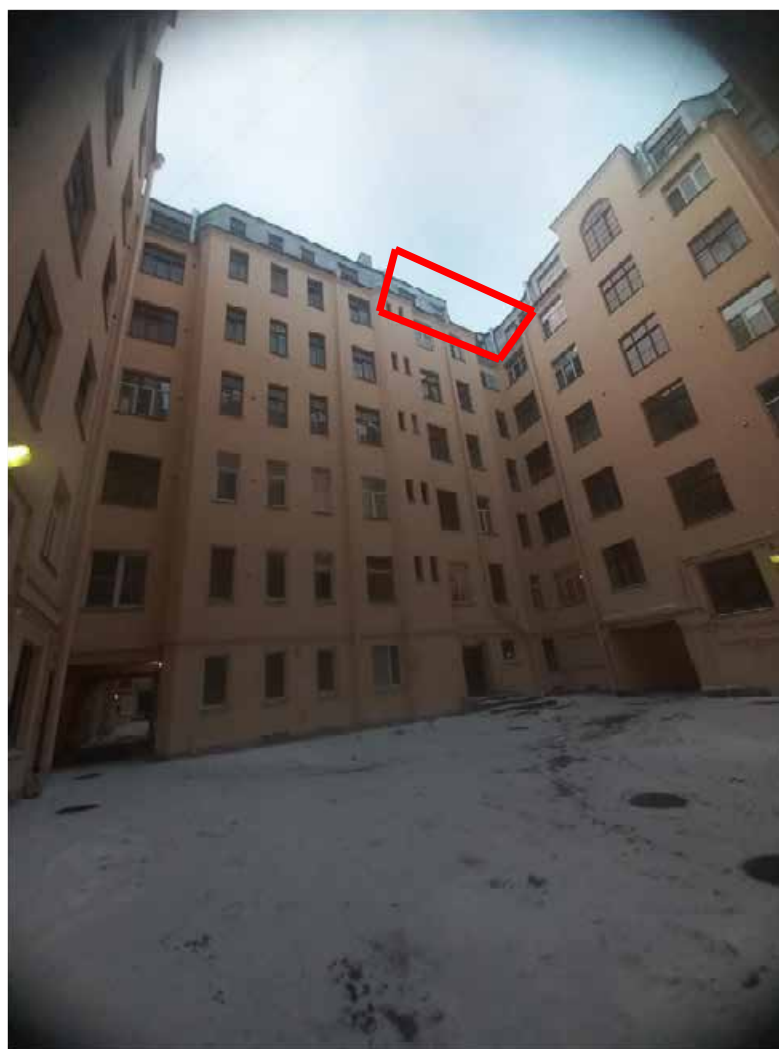
Фото 6. Здание по адресу: улица Некрасова, дом 58, литера А. Второй внутренний двор.
