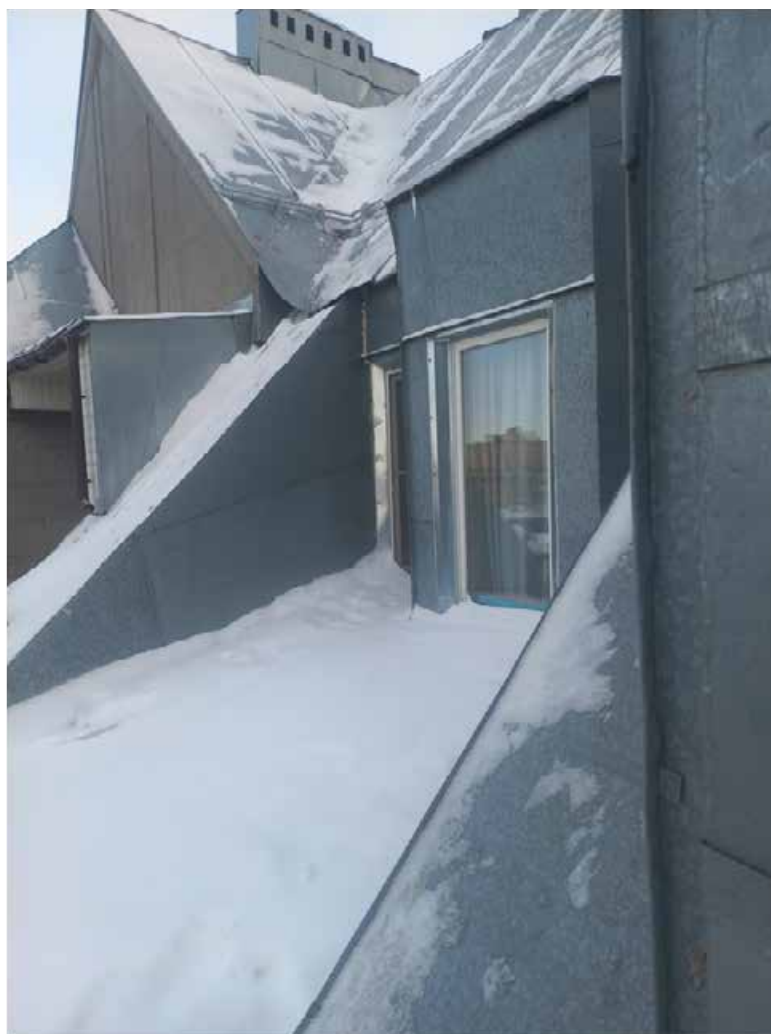
Фото 18. Мансарда. Вид с балкона.
