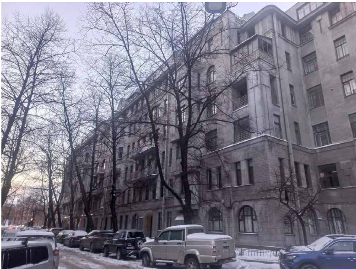
Фото 2. Здание по адресу: улица Некрасова, дом 58, литера А. Западный фасад.
