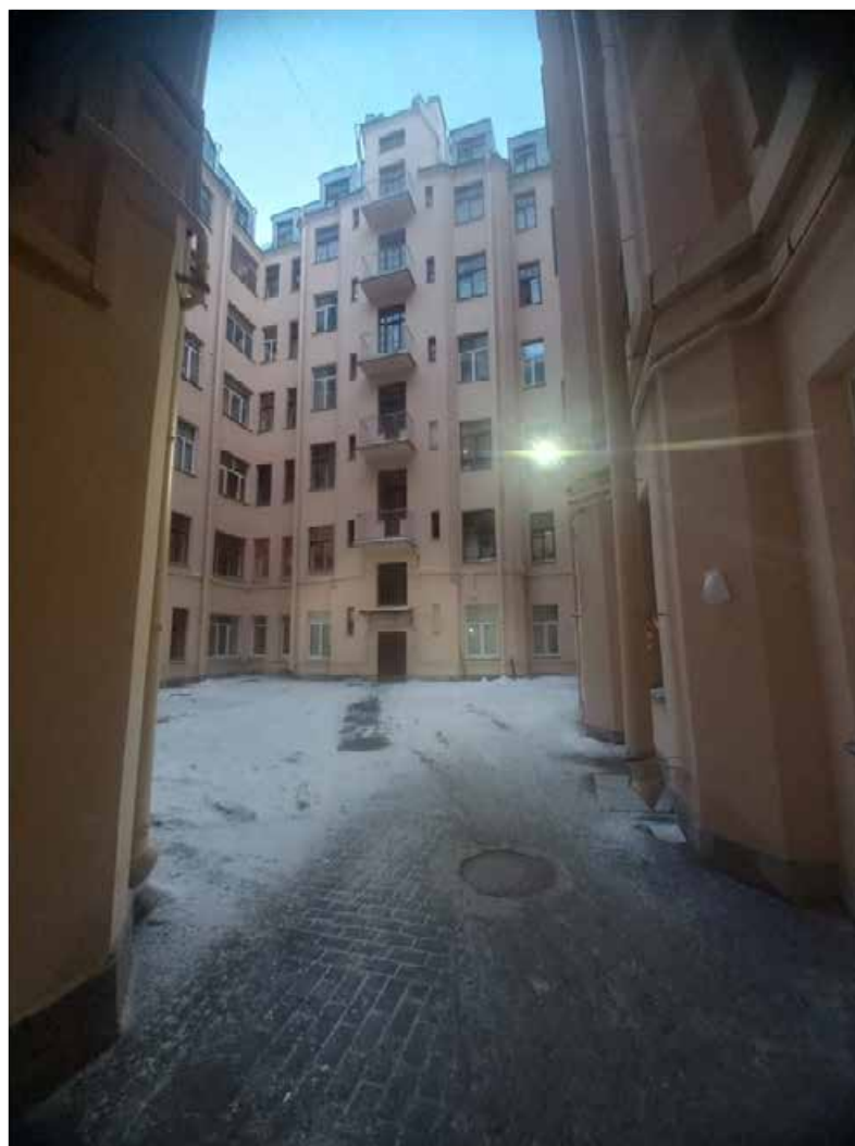
Фото 7. Здание по адресу: улица Некрасова, дом 58, литера А. Третий внутренний двор.
