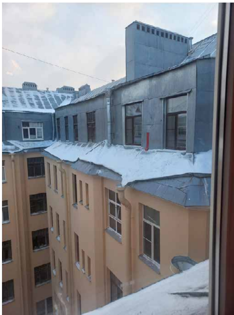
Фото 30. Мансарда. Оконные заполнения рассматриваемых помещений.
