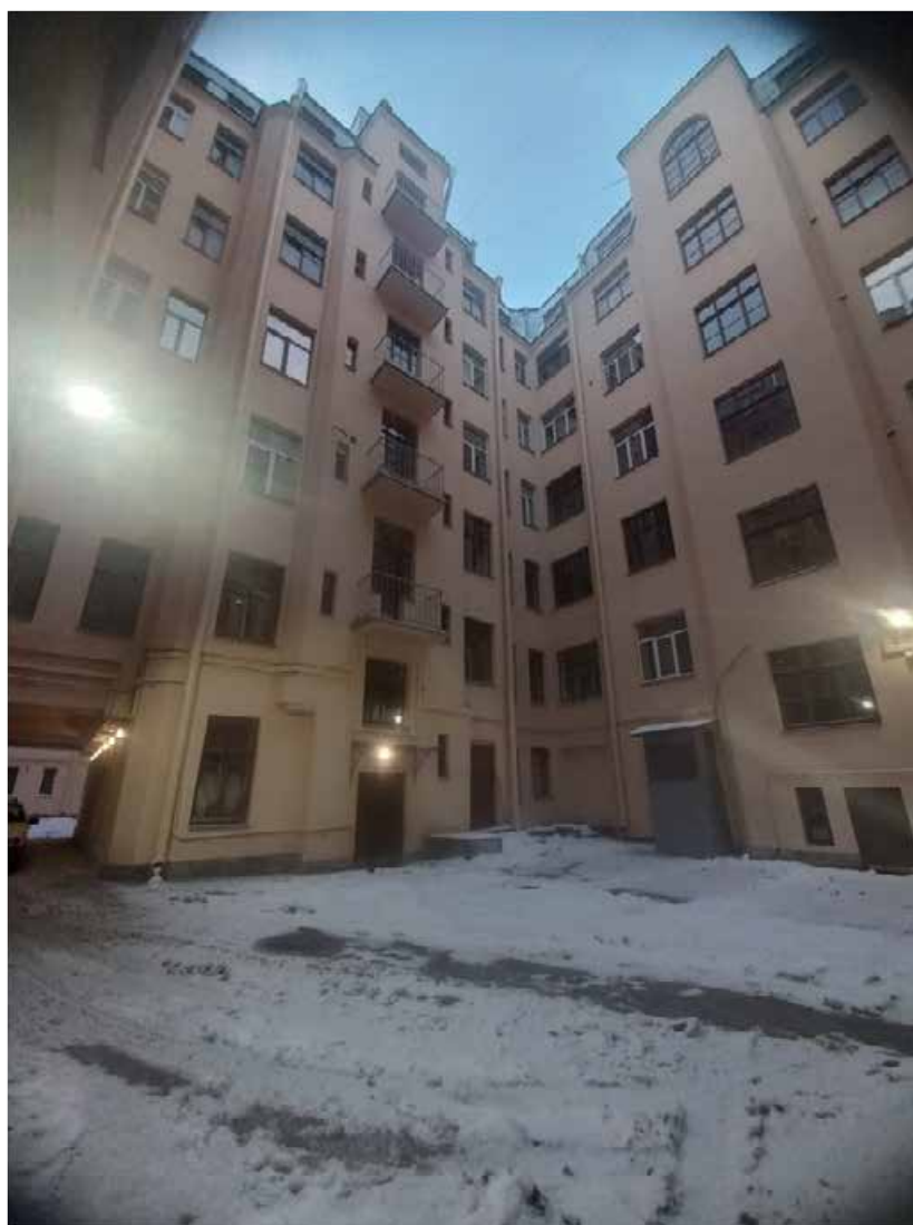
Фото 8. Здание по адресу: улица Некрасова, дом 58, литера А. Третий внутренний двор.
