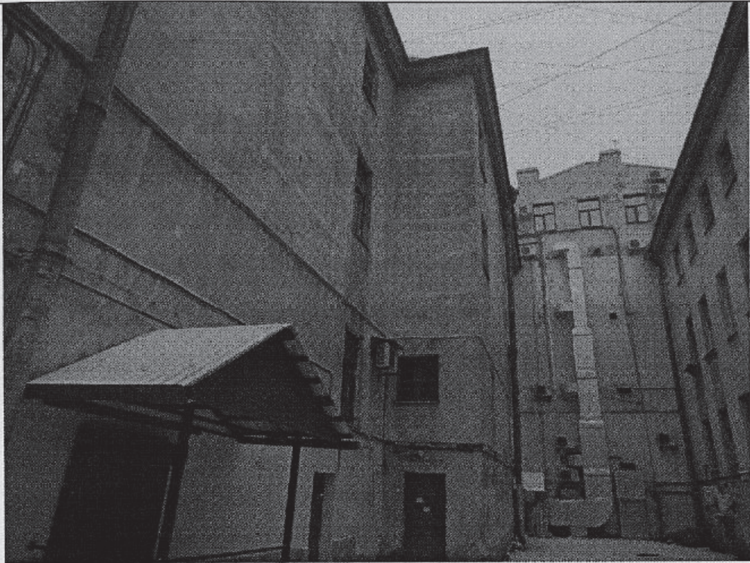
Южный и северный дворовые фасады. Общий вид. 15.11.2012 г.
