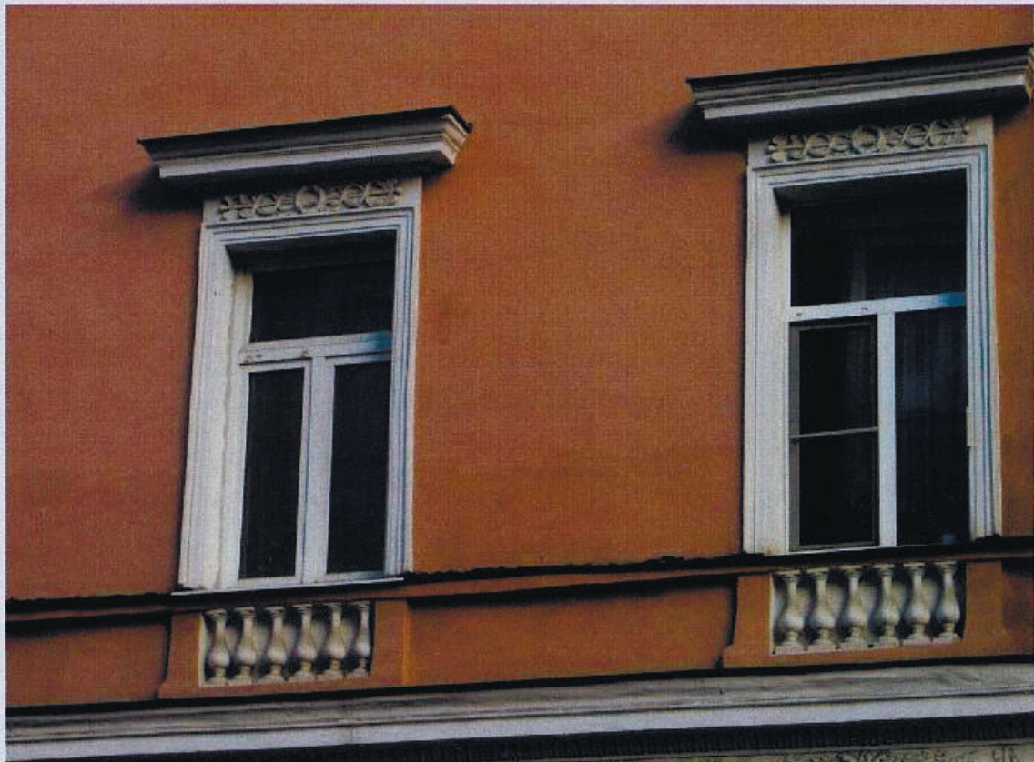
Оформление оконных проемов 2-го этажа. 15.11.2012 г.
