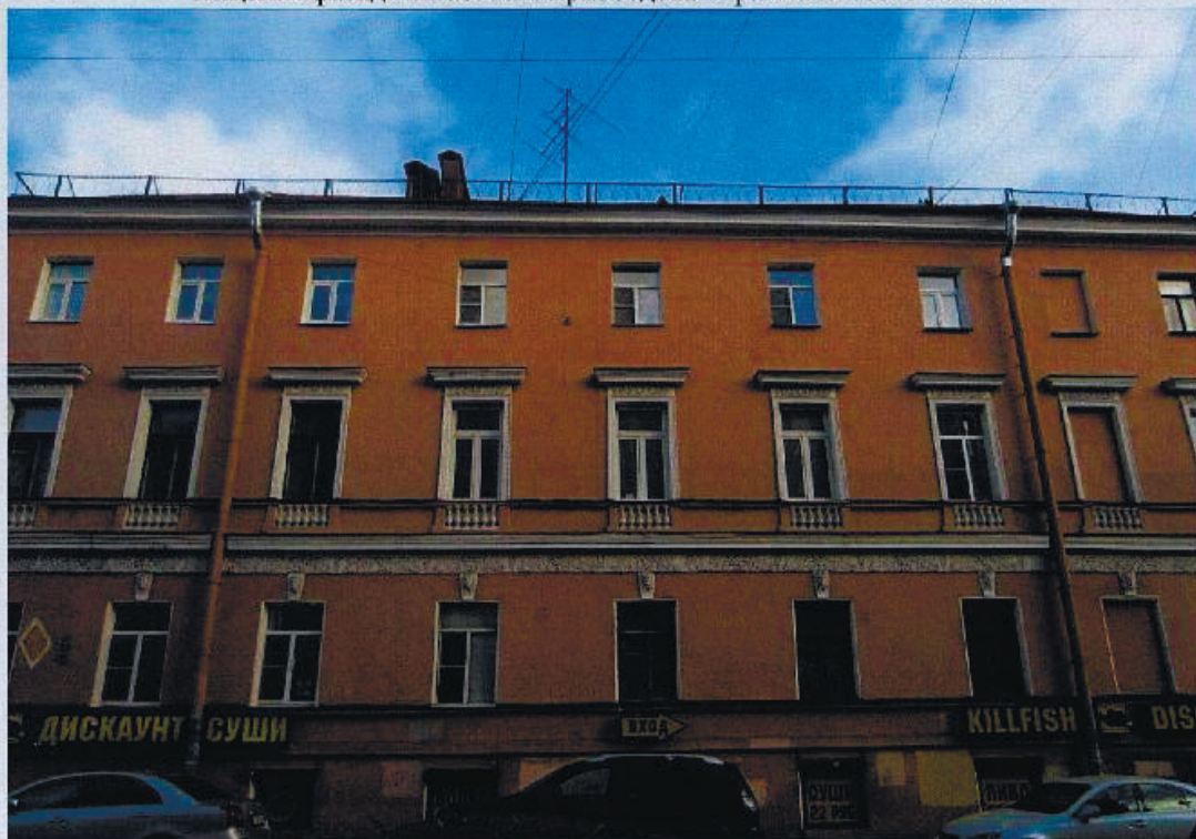
Лицевой фасад по Кокушкину пер. Общий вид. 15.11.2012 г.
