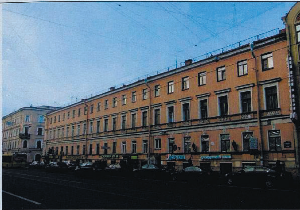
Лицевой фасад по Садовой ул. Общий вид. 15.11.2012 г.
