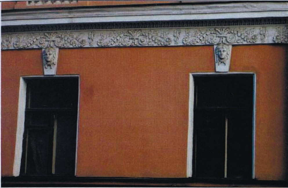
Оформление оконных проемов 1-го этажа. 15.11.2012 г.
